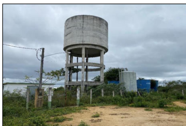
Figura 16 – Estação de Tratamento de Água – RED300 m3, Padrão de entrada de energia
