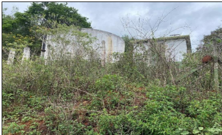
Figura 15 – EEAB 2 – Adutora de água bruta
