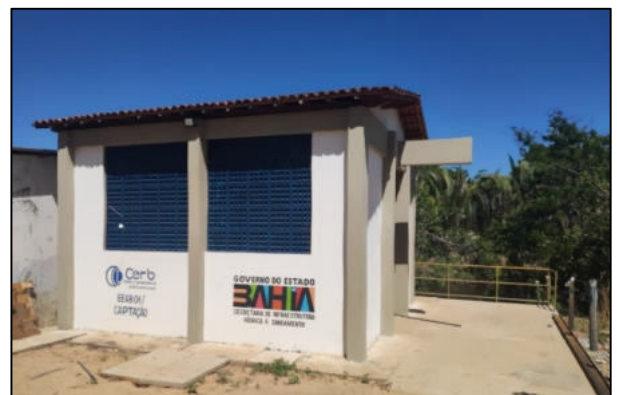
Figura 4 - Captação Flutuante e EEAB1
