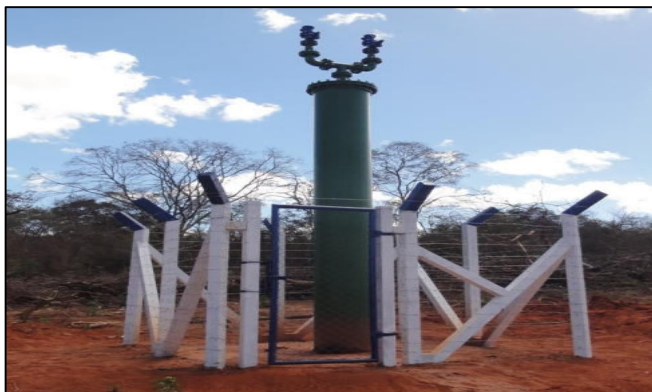
Figura 5 - Adutora De Água Bruta – Trecho EEAB 1 (Captação) / EEAB 2 - TUS
