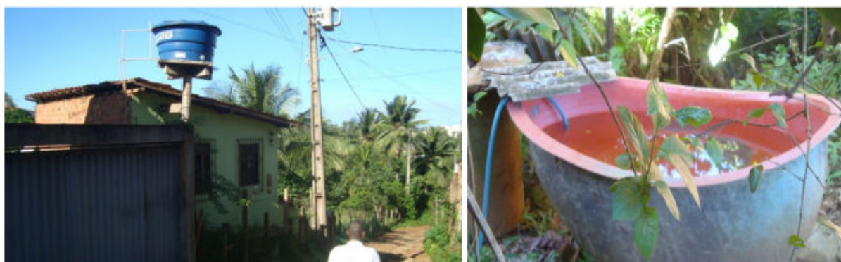
Figura 6.9 - Reservatórios com Tampa e Armazenamento de Água em Orelhão Telefônico – Comunidade Alto do Girassol
