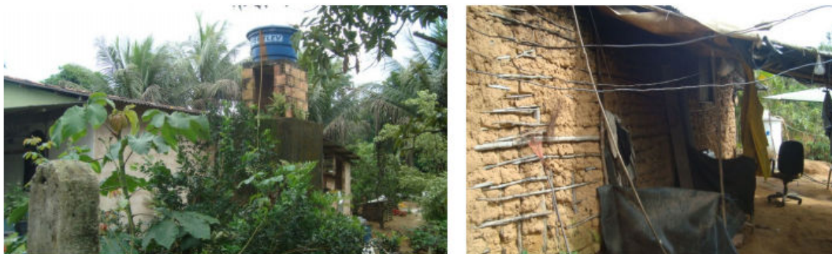
Figura 6.16 - Sanitário na Área Externa do Domicílio e Casa Existente – Carobeira “Buracão”
