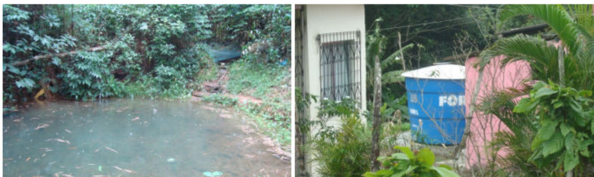
Figura 6.11 - Minadouro e Reservatório – Localidade Pedreira Aratu
