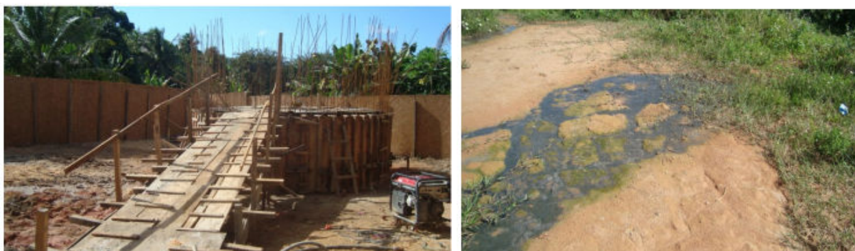
Figura 6.14 - Estação Elevatória de Esgoto (EE-1, em instalação, Jardim Campo Verde e Esgoto a Céu Aberto em Jardim Campo Verde
