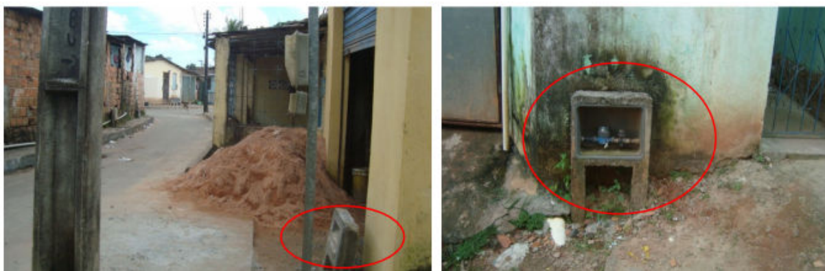
Figura 6.6 - Localidade de Cepel – Hidrômetros
