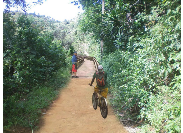
Figura 7.4 - Acesso via elevada
