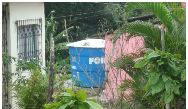
Figura 4.35 - Reservatório de 2.000 L, localizado na casa de seu Mário, Comunidade Pedreira Aratu
