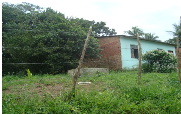
Figura 4.45 - Base do Reservatório de 2.000 L – Comunidade de Barragem
