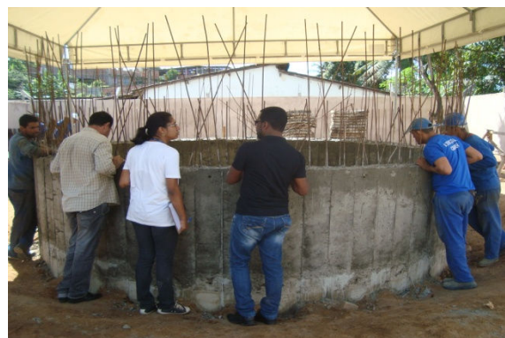
Figura 4.56 - Estação Elevatória de Esgoto (EE-2), em Instalação, Jardim Campo Verde
