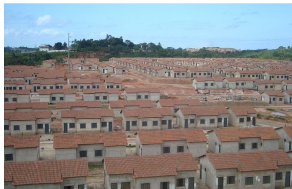
Figura 4.11 - Unidades Habitacionais do Programa Minha Casa Minha Vida (Empreendimento em Fase de Instalação) - Loteamento Ceasa
