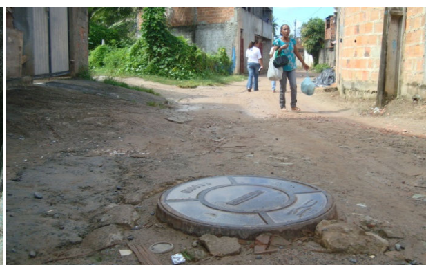
Figura 4.70 - Poço de Visita (PV), Loteamento Vila Santana
