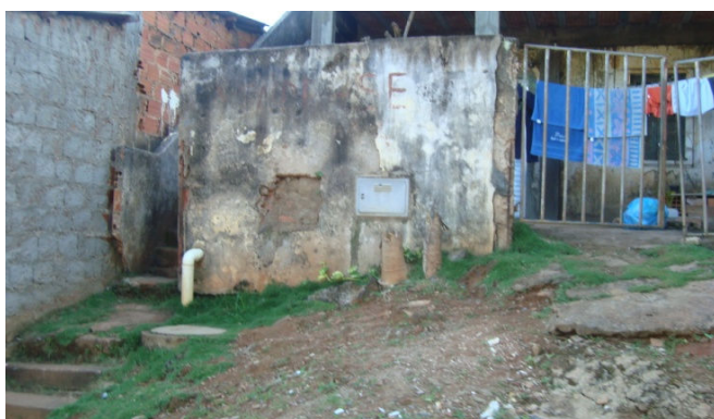
Figura 4.18 - Instalação de Hidrômetros em Algumas Casas
