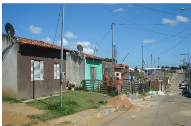
Figura 4.7 - CH Jardim Campo Verde, Presença de Hidrômetros, Habitações sem Reservatórios de Água
