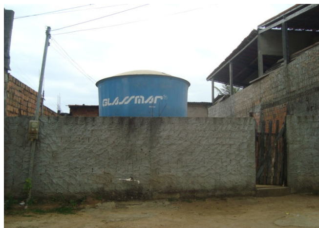
Figura 4.21 - Reservatório de 10.000 L, instalado pela Comunidade
