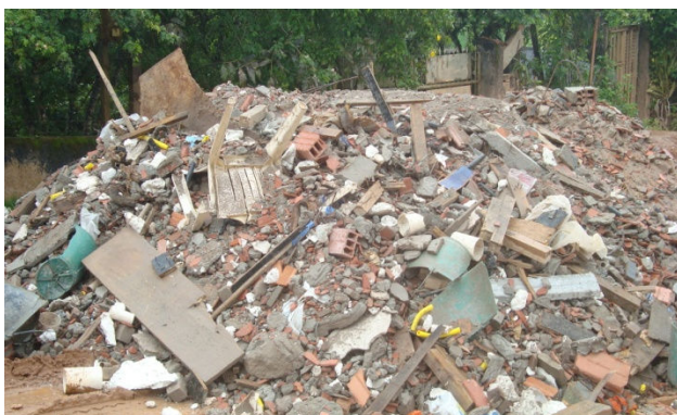
Figura 4.94 - Ponto de Entulho – Estrada que dá Acesso a Localidade de Biribeira
