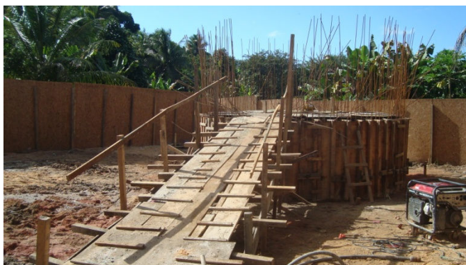
Figura 4.49 - Estação Elevatória de Esgoto (EE-1), em Instalação, Jardim Campo Verde
