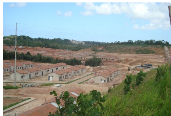
Figura 4.66 - Unidades Habitacionais em Construção, Loteamento Ceasa (Demanda por Rede de Esgoto)
