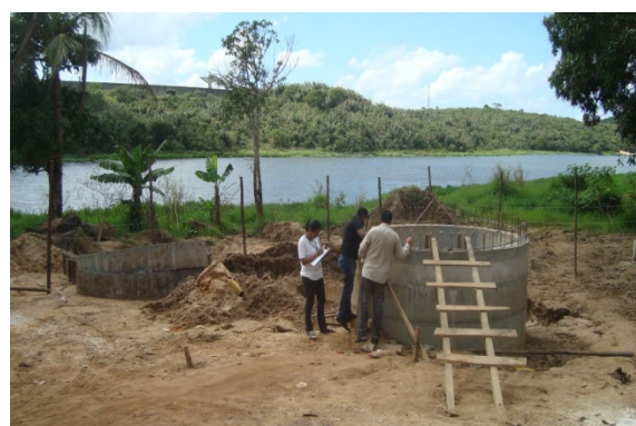
Figura 4.58 - Estação Elevatória de Esgoto (EE-4), em Instalação, Nova Esperança, às Margens da Represa Ipitanga 3
