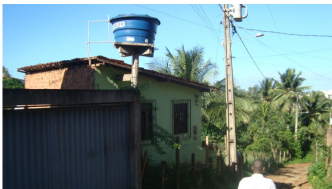
Figura 4.16 - Reservatório com Tampa, Comunidade Alto do Girassol
