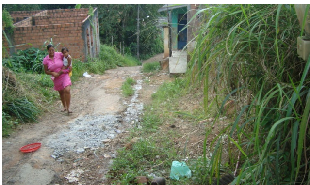
Figura 4.61 - Esgoto a Céu Aberto – Nova Esperança
