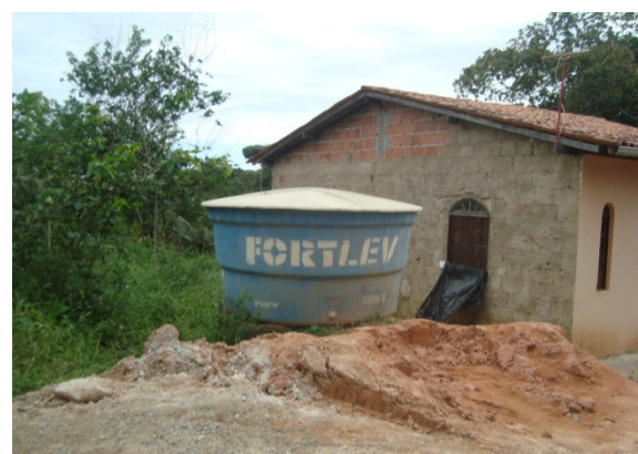
Figura 4.39 - Reservatório de 2.000 L (RAD 2), Comunidade Pedreira Carangi
