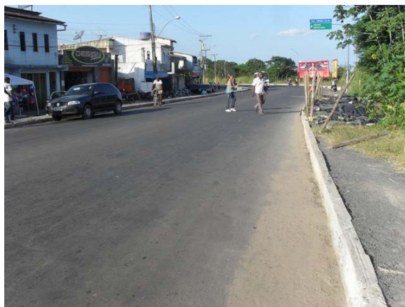
Foto 14: Rua Simões Filho, próximo a rotatória do Pioneiro – grande erosão com cerca de 30 m de profundidade – causada pelo antigo ponto de lançamento de drenagem.
