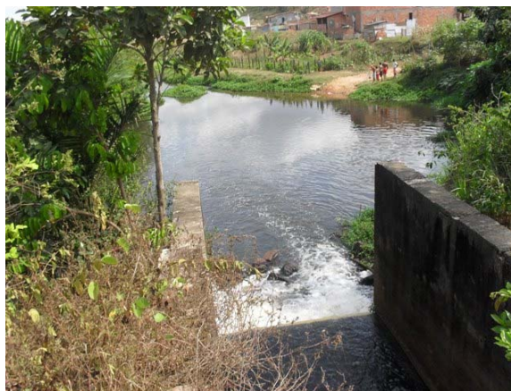
Foto 10: Barragem – captação de água da Petrobrás – leva água a montante.
