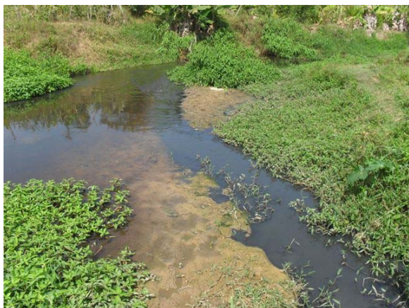
Foto 9: Ponto de lançamento de drenagem e esgoto – caixa de passagem e Canal sem revestimento e aberto até o Rio Catu – alto nível de comprometimento.
