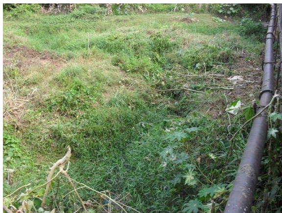
Foto 12: Ponto de lançamento de drenagem e esgoto – chegada de tubo de concreto DN 1000 mm – vista da ponte da Rua Antonio Balbino – muito mato, lançamento é feito no Rio Catu.
