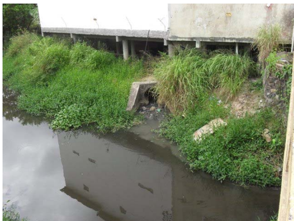
Foto 5: Ponto de lançamento de drenagem e esgoto no Rio Catu – vista a montante da ponte – tubo de concreto DN 600 mm.
