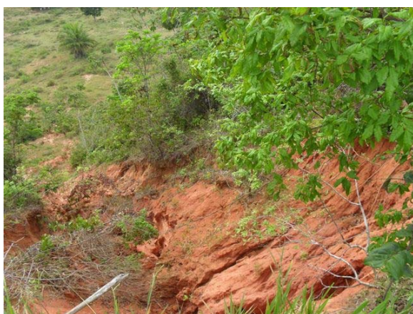
Foto 21: Loteamento Eco água Grande – ruas projetadas a beira do barranco – erosão na encosta – rede com tudo de concreto DN 400 mm e na saída grande abismo.
