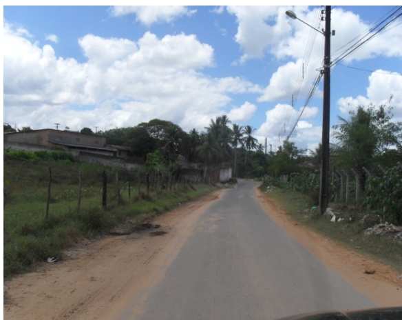
Foto 11: Travessa Djalma de Moraes. Área crítica por conta da ocorrência de alagamento. Área crítica 1.
