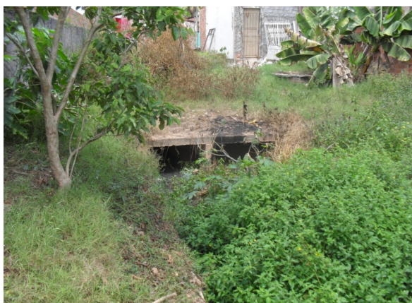
Foto 9: Final do canal de macrodrenagem que se inicia na rua "A". Toda contribuição da bacia transportada por esta estrutura é lançada na lagoa da Cavada.
