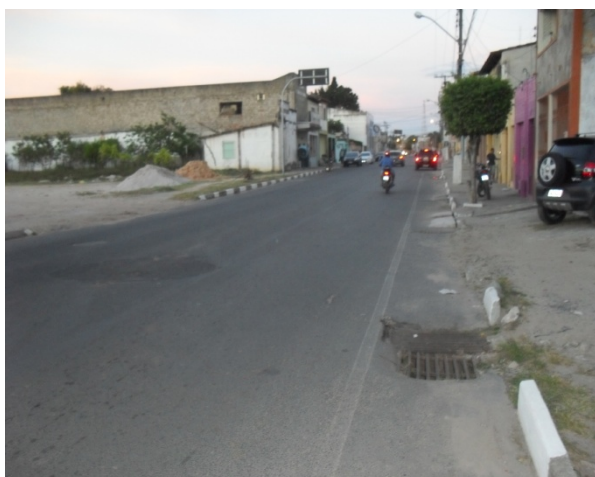
Foto 31: Rua 15 de Novembro. Local onde se inicia a obra de macrodrenagem em andamento.
