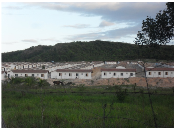
Foto 41: Bairro Mangalô. Detalhe do conjunto habitacional ainda em execução. Movimento de terra e tamanho da área desmatada oferece risco de agravar os efeitos sobre a área crítica.
