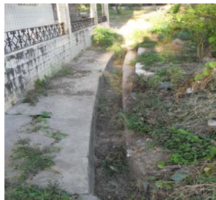
Foto 28: Rua do Avião. Detalhe do dispositivo de entrada responsável pela drenagem local e canaliza as águas até o bueiro.
