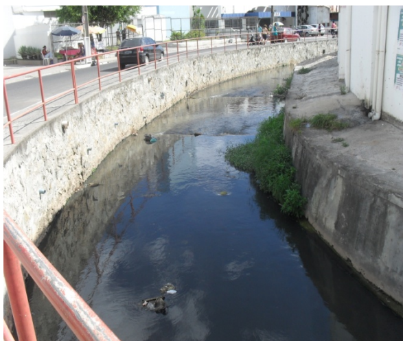
Foto 17: Trecho canalizado do rio Catu com revestimento lateral parte em alvenaria de pedra e parte em concreto. A prefeitura realizou uma obra de alargamento da seção do canal para melhorar as condições hidráulicas de escoamento, mas ainda assim ocorre problema de alagamento a montante do local da obra.
