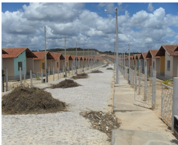
Foto 3: Bairro Belo Campo. Intenso processo de ocupação sobre a bacia de contribuição sobre um dos riachos tem agravado os problemas de alagamento no bairro Alagoinhas IV.
