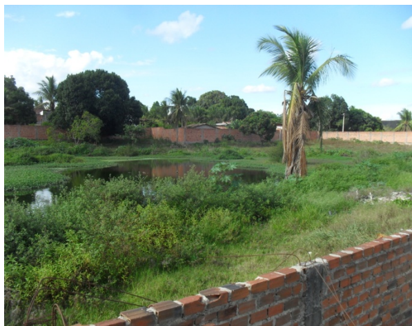
Foto 22: Loteamento duas Irmãs. Moradores locais constroem suas habitações e muros dos seus terrenos no caminho natural do escoamento das águas do riacho. Ocupação desordenada e irregular provocou o surgimento de uma lagoa no fundo das casas do loteamento.
