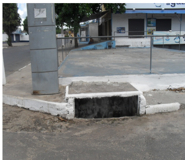
Foto 14: Rua Dantas Bião. Detalhe de um dos dispositivos de coleta superficial águas pluviais.
