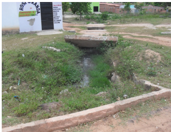
Foto 6: Rua "A". Início do canal aberto de macrodrenagem de seção retangular de 3m X 2,5m revestido em alvenaria de pedra.
