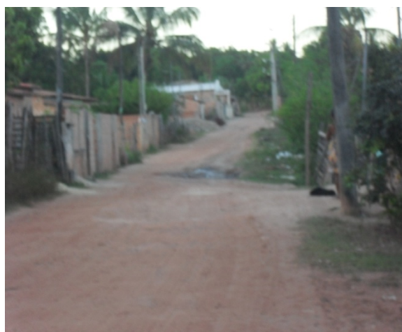
Foto 40: Bairro Mangalô. Área crítica por conta da ocorrência de alagamento. Área crítica 10. Detalhe de uma rua por onde escoar uma parte significativa do volume de contribuição superficial que converge para área crítica.
