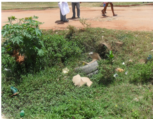
Foto 5: Rua "A". Bueiro de travessia que dá início ao canal de macrodrenagem. Lixo acumulado obstrui o bueiro e provoca o transbordamento no período chuvoso.
