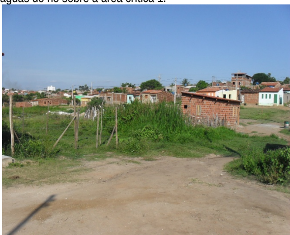
Foto 27: Bairro Quintas do Sul, Asa Norte. Pessoas constroem residências em locais inadequados e criam obstáculos ao escoamento natural das águas pluviais.
