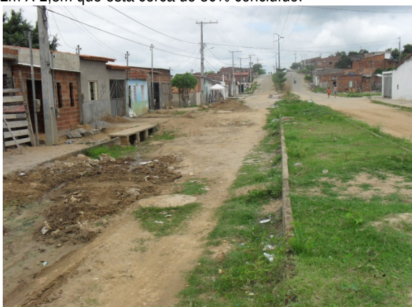
Foto 5: Bairro Américo Nogueira. Avenida por onde passa a galeria enterrada de macrodrenagem de seção retangular.
