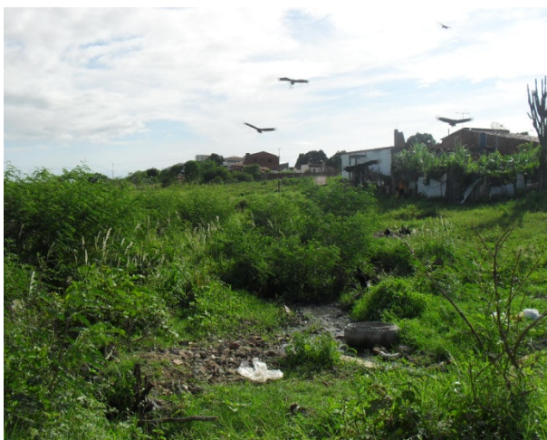
Foto 9: Canal de macrodrenagem da Clerolândia. Presença de lixo, animais e vegetação ao longo do caminho natural do canal que também transporta esgoto.
