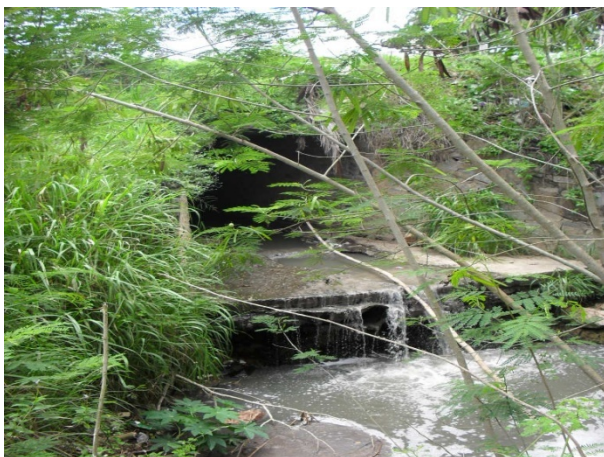
Foto 13: Rótula dos Orixás. Local onde desembocam os canais que transportam esgoto dos bairros Clodoaldo Costa, Otávio Camões e Primavera.
