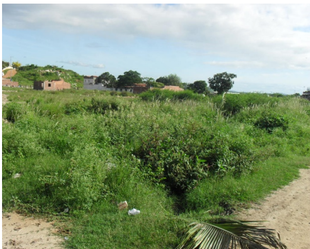
Foto 7: Região próxima a Vila Riachão. Início do canal de macrodrenagem da Clerolândia. Canal sem revestimento.
