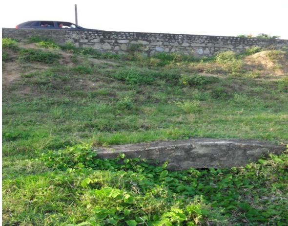
Foto 25: Avenida que separa o bairro São Francisco e o rio Catolé. Detalhe do dispositivo que facilita a influência das águas do rio sobre a área crítica 1.
