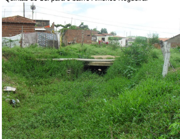
Foto 6: Bairro Américo Nogueira. Trecho aberto do canal de macrodrenagem ainda não finalizado.
