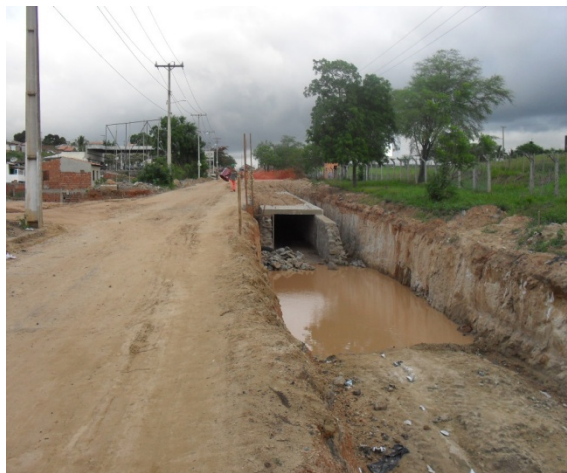
Foto 2: Avenida Júlio José Rodrigues. Detalhe da galeria retangular de macrodrenagem de seção média de 2,25m x 1,8m em execução.
