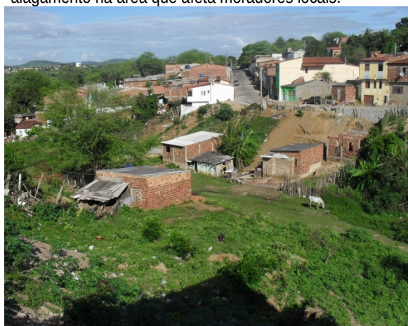
Foto 12: Bairro Clodoaldo Costa. Imagem do vale por onde ocorre o escoamento natural das águas.
