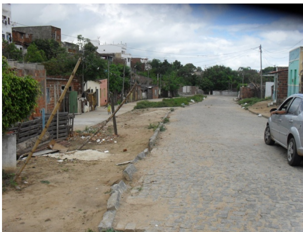
Foto 17: Canal de macrodrenagem dos bairros Otávio Camões e Primavera. Trecho canalizado em alvenaria retangular cobertas com placas de concreto. Pessoas aproveitaram-se das placas que cobrem o canal para uso comum e particular.
