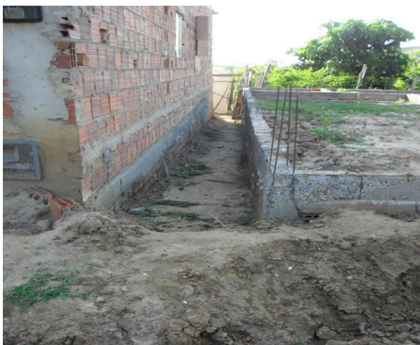
Foto 29: Bairro Quintas do Sul, Asa Sul. Local por onde ocorre o escoamento natural das águas superficiais já está sendo ocupado de maneira irregular. Área com risco potencial de sofrer problemas de drenagem.
