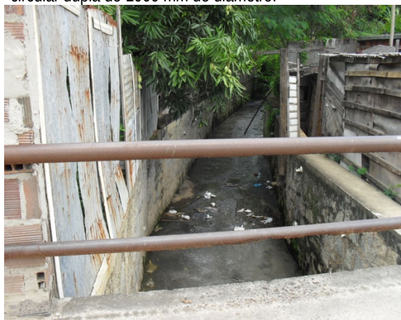
Foto 18: Canal de macrodrenagem dos bairros Otávio Camões e Primavera. Trecho a céu aberto com seção retangular revestido em alvenaria de pedra.
