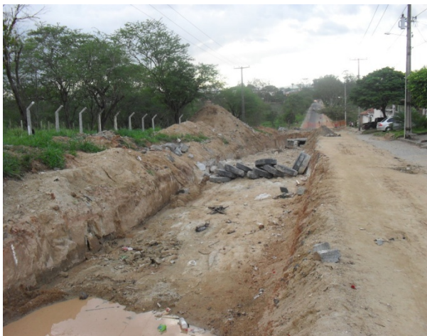
Foto 1: Avenida Júlio José Rodrigues. Obra de duplicação da via e macrodrenagem em execução.
