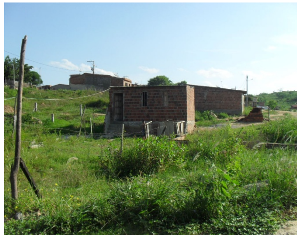
Foto 26: Bairro Quintas do Sul, Asa Norte. Área crítica por conta da ocorrência de alagamento. Área crítica 3.
