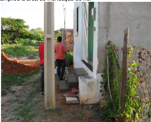
Foto 23: Bairro São Francisco. Moradores locais constroem suas casas acima do nível do chão na área mais baixa para evitar a invasão das águas pluviais em seus domicílios
