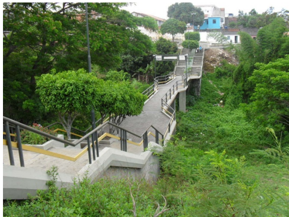
Foto 16: Vista da passarela construída com recurso junto a CONDER. Trecho do canal de macrodrenagem dos bairros Otávio Camões e Primavera canalizado. Galeria circular dupla de 1000 mm de diâmetro.
