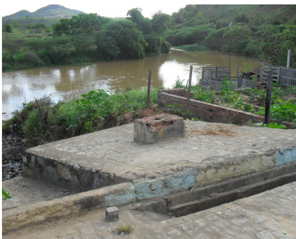
Foto 21: Rua da Piaba. Pessoas constroem suas habitações quase na margem do rio Catolé. Processo de assoreamento ampliou a área de inundação do rio.
