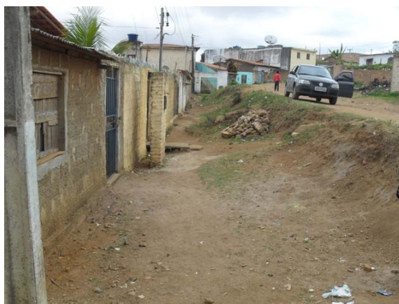
Foto 48: Área Crítica 5 – Alagamento – Bairro Nossa Senhora Aparecida – Rua São Sebastião – Casas abaixo do nível da rua.
