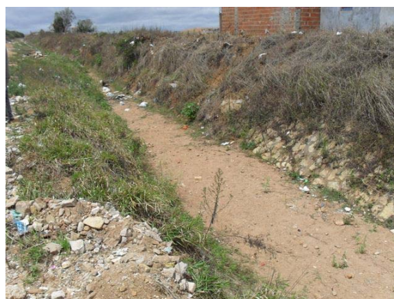
Foto 6: Canal 3 - Início do canal aberto revestido em alvenaria de pedra que contorna a serra.
