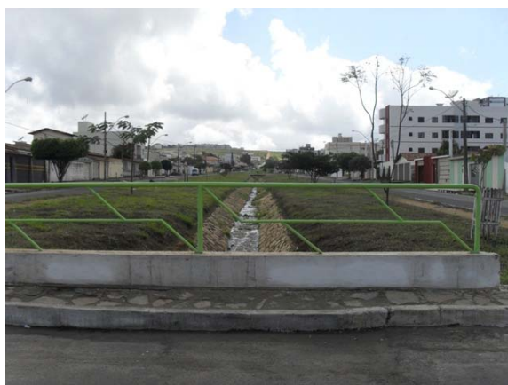
Foto 22: Canal 5 - Continuação do canal aberto revestido em alvenaria de pedra na Rua Olívia Flores.
