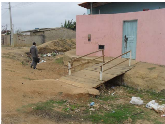
Foto 43: Área Crítica 2– Erosão - Bairro Enriqueta Pratis – Rua T - Ausência de pavimentação e de sistema de drenagem.
