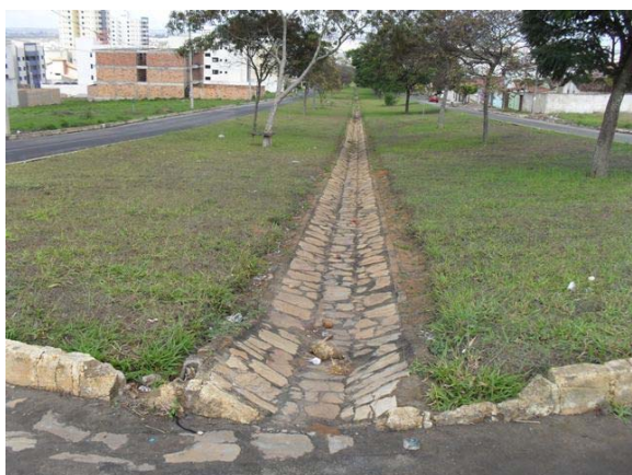
Foto 21: Canal 5 - Início do canal aberto revestido em alvenaria de pedra na Avenida Brasil.
