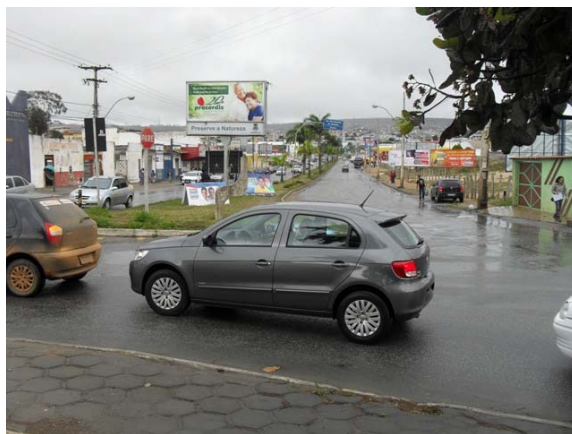
Foto 50: Área Crítica 6 – Alagamento – Bairro Jurema – Rua Bartolomeu de Gusmão – Baixa declividade longitudinal e deficiência no sistema de microdrenagem.
