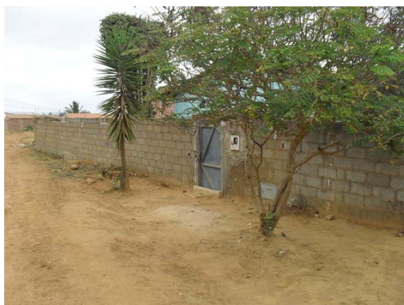
Foto 42: Área Crítica 1 – Enxurrada - Bairro Sobradinho – Ausência de pavimentação e de sistema de drenagem.
