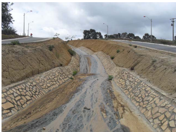
Foto 7: Canal 3 - Final do canal aberto revestido em alvenaria de pedra que contorna a serra.
