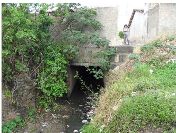
Foto 29: Canal 7 – Final do trecho coberto revestido em concreto e início do trecho aberto revestido em alvenaria de pedra.
