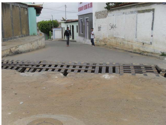
Foto 3: Canal 2 - Estrutura de coletora de grandes dimensões correspondendo ao início da galeria circular enterrada na Rua 9 no Bairro Santa Cruz.
