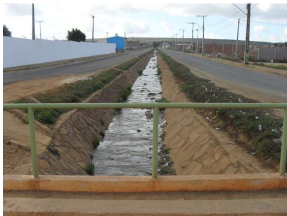
Foto 38: Canal 16 - Continuação do canal aberto revestido em alvenaria de pedra na Vila Serrana IV.
