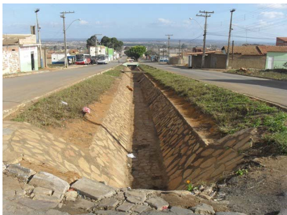
Foto 37: Canal 16 - Início do canal aberto revestido em alvenaria de pedra na Vila Serrana IV.
