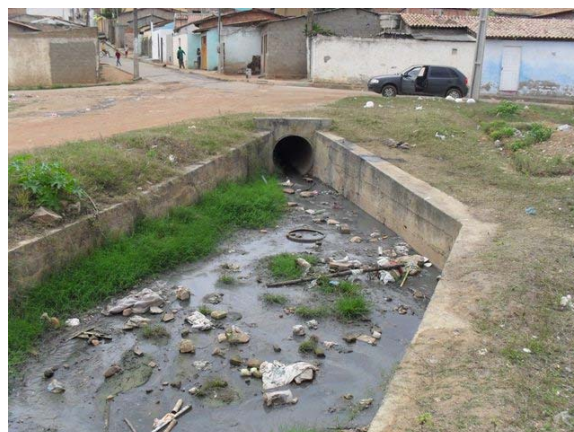
Foto 4: Canal 2 - Final da galeria circular enterrada na Rua 9 no Bairro Santa Cruz e início do trecho em canal aberto revestido em concreto.
