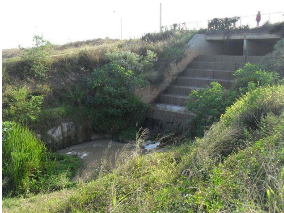
Foto 41: Canal 16 – Final do trecho aberto revestido em concreto com deságüe na Lagoa da Bateia.
