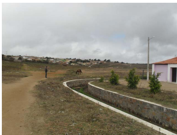
Foto 4: Rio São José – riacho revestido – Loteamento Santa Cecília.
