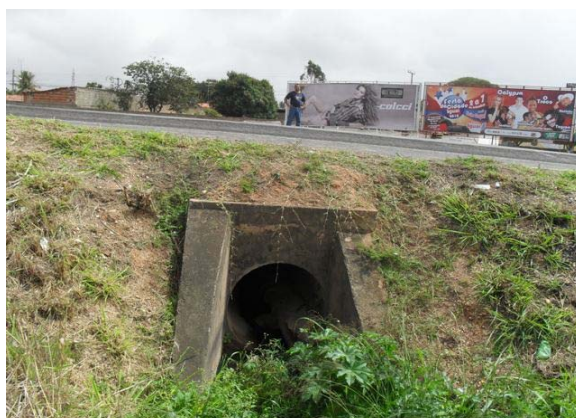
Foto 6: Bueiro sob a BR-116.
