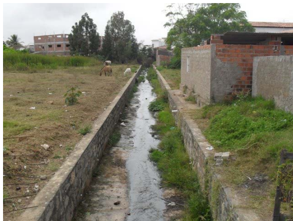
Foto 2: Rio São José – riacho revestido – Loteamento Santa Cecília.
