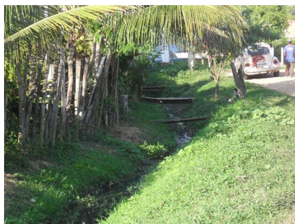
Foto 18: Canal do Conjunto ACM – sem trecho revestido – conduz águas pluviais e esgotos secundários.
