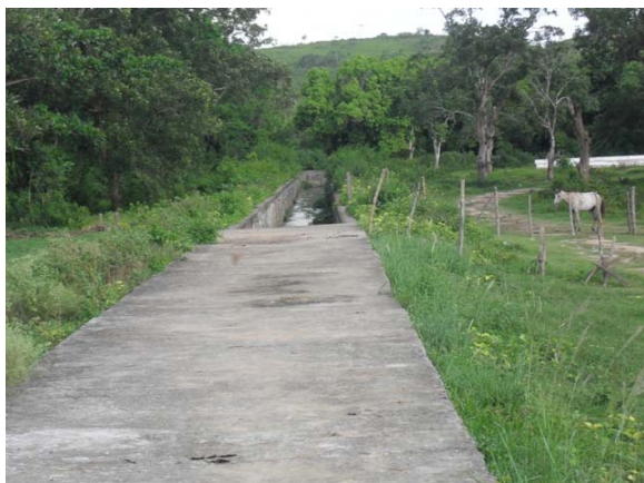
Foto 7: Canal revestido e fechado – conduz águas pluviais e esgotos – próximo ao Ginásio de Esportes.
