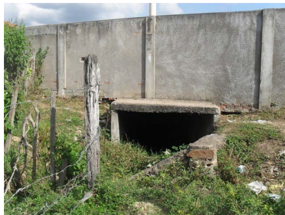
Foto 2: Canal revestido – conduz água pluvial e esgoto – proximidade do Ginásio de Esportes.
