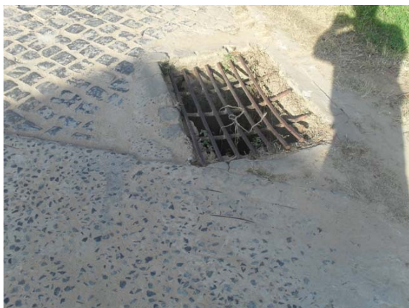
Foto 19: Elemento de microdrenagem – caixa coletora.
