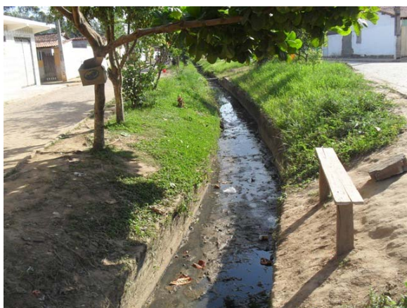
Foto 15: Canal do Conjunto ACM – trecho revestido – conduz águas pluviais e esgotos secundários.
