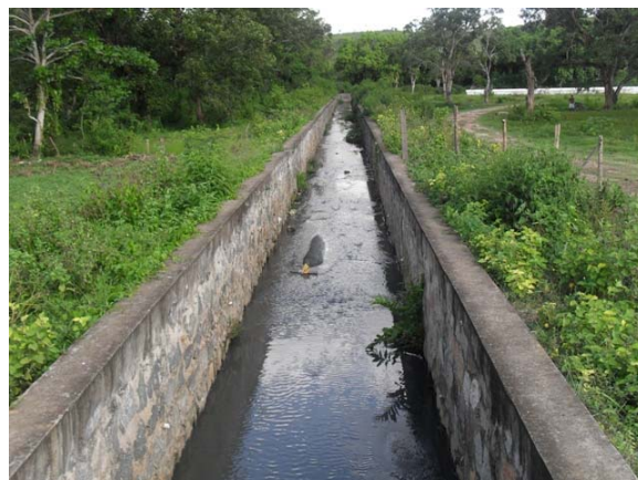
Foto 8: Trecho do Canal revestido e aberto conduzindo águas pluviais e esgotos.
