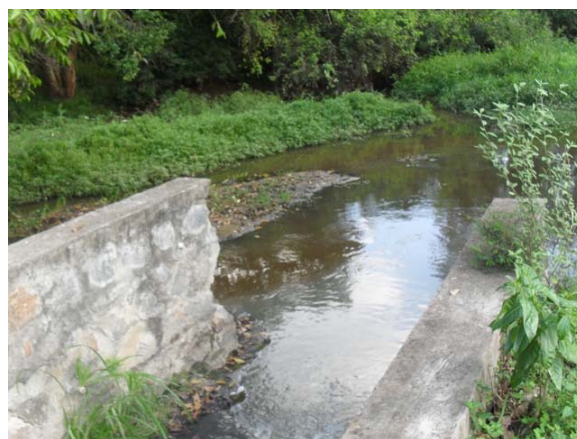
Foto 10: Trecho final do Canal revestido e aberto conduzindo águas pluviais e esgotos – lançamento no Rio Água Branca.
