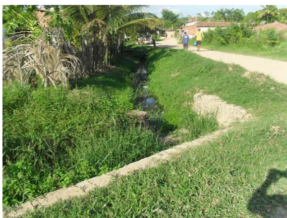
Foto 17: Canal do Conjunto ACM – trecho sem revestido – conduz águas pluviais e esgotos secundários.
