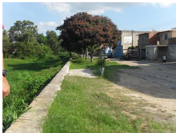
Foto 14: Rio Água Branca com a sua margem protegida.
