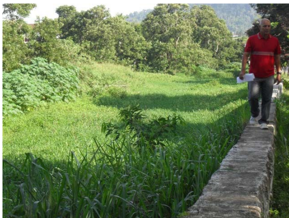
Foto 13: Rio Água Branca com a sua margem protegida.
