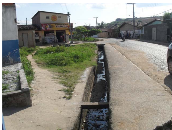
Foto 16: Canal do Conjunto ACM – trecho revestido – conduz águas pluviais e esgotos secundários.
