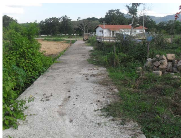
Foto 6: Canal revestido e fechado – conduz águas pluviais e esgotos – próximo ao Ginásio de Esportes.
