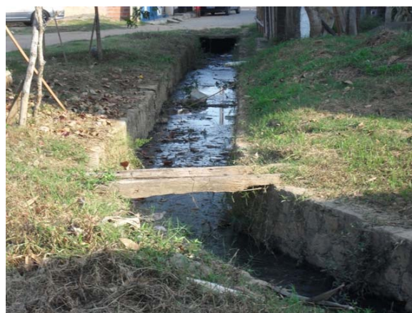
Foto 22: Canal revestido próximo ao Hospital – conduz água pluvial e esgotos secundários.
