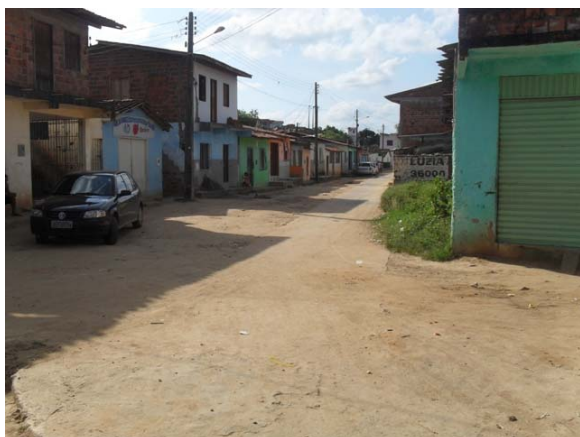
Foto 3: Área Crítica 3 – Av. Getúlio Vargas e adjacências – área de alagamento.
