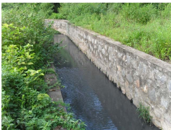
Foto 9: Trecho do Canal revestido e aberto conduzindo águas pluviais e esgotos.
