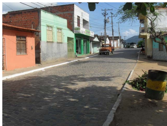
Foto 4: Área Crítica 3 – Av. Getúlio Vargas e adjacências – área de alagamento.
