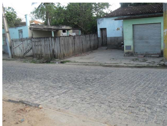
Foto 24: Área Crítica 2 – Próximo ao Hospital – área de alagamento.
