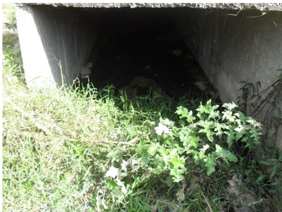
Foto 1: Canal revestido – conduz água pluvial e esgoto – proximidade do Ginásio de Esportes.
