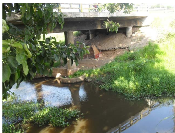
Foto 12: Ponte sobre o Rio Água Branca.
