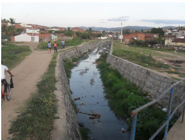
Foto 7: Canal secundário do Rio Jequezinho.
