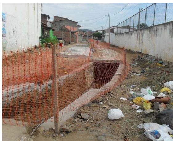
Foto 4: Canal de macrodrenagem sendo coberto.
