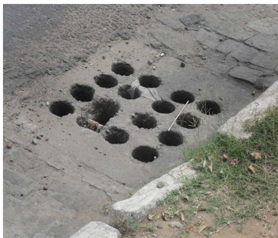
Foto 2: Dispositivo de microdrenagem localizado na Rua Pedro Sessenta – Área Crítica 1.
