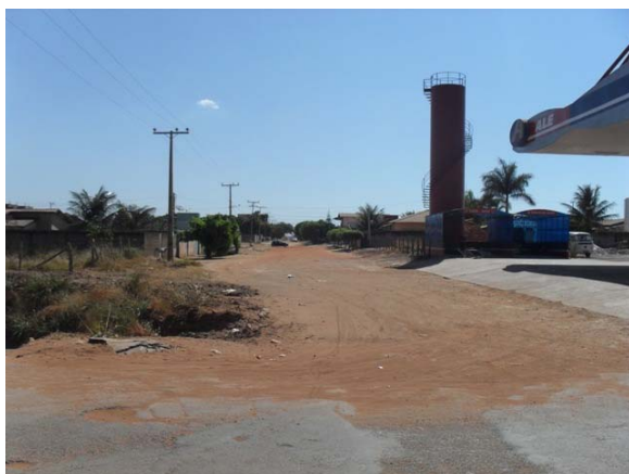
Foto 7: Área Crítica 3 – área de alagamento entre a Rua Senhor do Bonfim e a Rua Paraíba.
