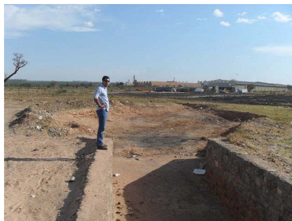
Foto 16: Rua Jacobina – final do Canal Santana do trecho em alvenaria de pedra.
