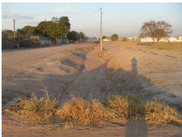
Foto 17: Início do Canal Mimoso.
