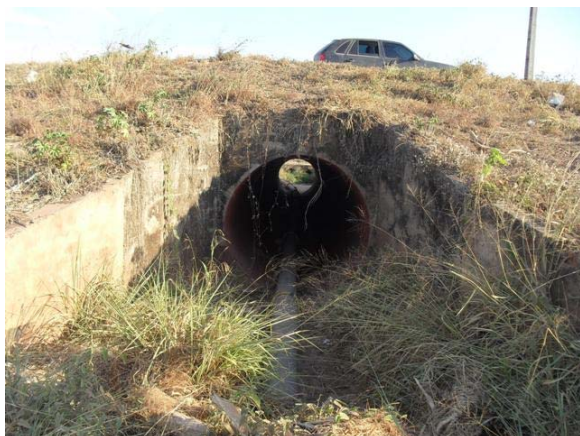
Foto 13: Av. Caminho das Árvores – Canal e bueiro sob a BA-020.
