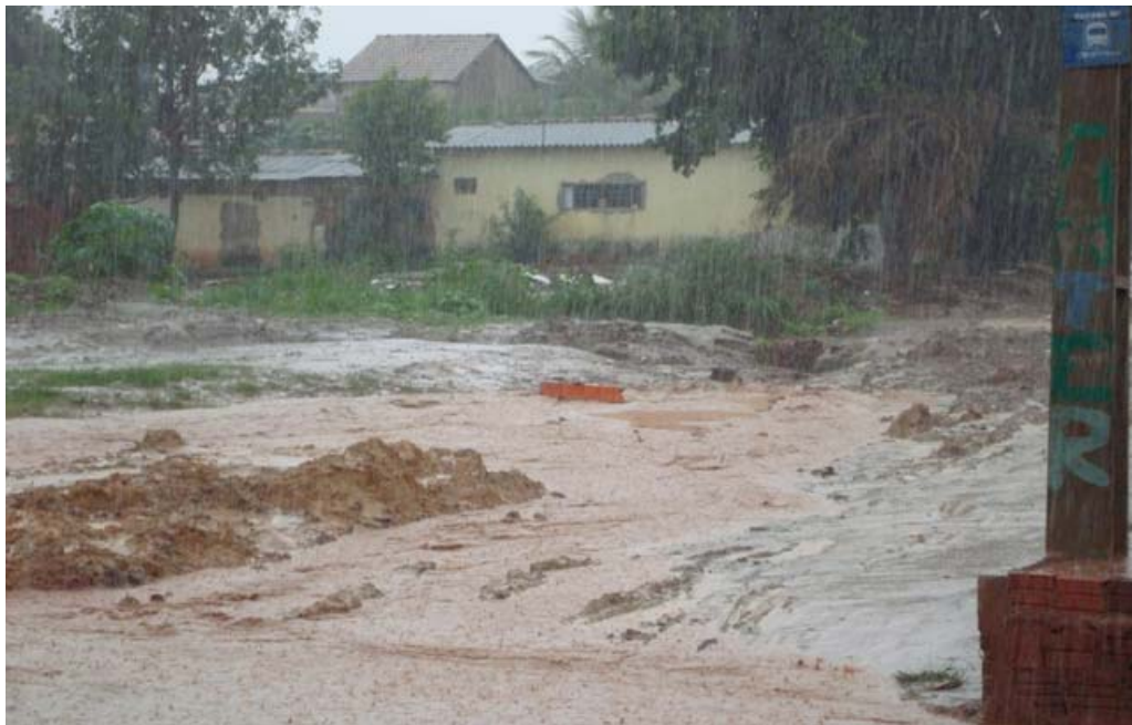
Figura 4.2 – Problemas relativos à drenagem pluvial em Luís Eduardo Magalhães
