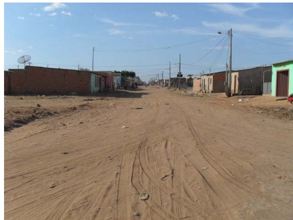
Foto 2: Área Crítica 1 – área de enxurrada entre a Rua Itabuna e a Rua Seabra.
