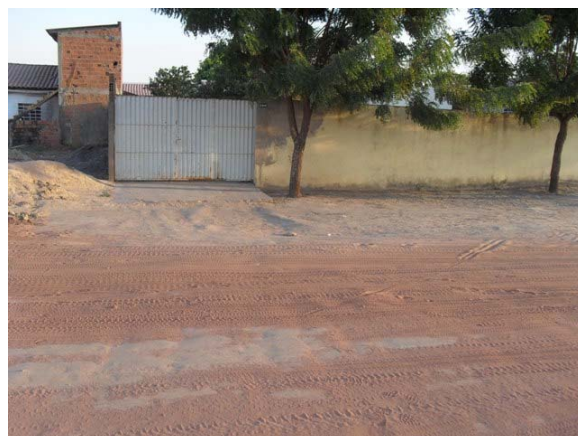
Foto 4: Área crítica 2 – área de alagamento entra e Rua Paraíba e a Rua Manoel Novaes.
