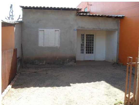
Foto 10: Área Crítica 4 – área de alagamento entre a Rua Piauí e a Rua São Francisco.
