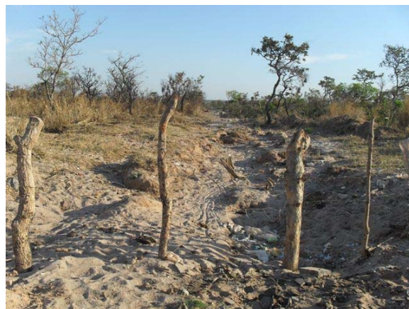
Foto 14: Av. Caminho das Árvores – Final do Canal em leito natural.
