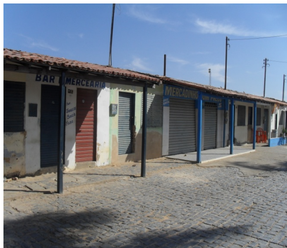
Foto 2: Área Crítica 1 - comerciantes da feirinha construíram pequenos batentes na porta de seus estabelecimentos com a finalidade de conter a invasão das águas pluviais.
