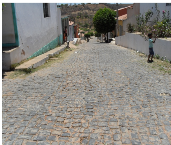
Foto 14: Área Crítica 4 - visão de outro ângulo da Rua Costa e Silva.
