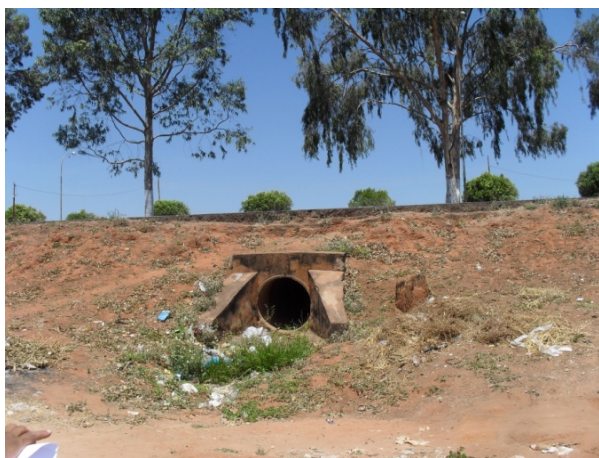
Foto 11: Saída da galeria de drenagem que se origina na Rua Joaquim Bernardes e cruza a Rua Rui Barbosa. Tubulação de concreto de 1200 mm de diâmetro.
