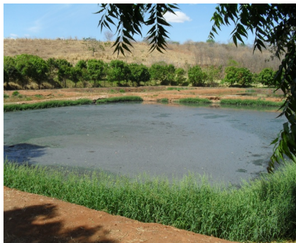
Foto 2: Sistema de lagoas de estabilização para o tratamento do efluente. ETE dispõe de 4 lagoas.
