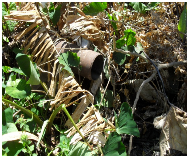
Foto 1: Ponto de lançamento de esgoto no terreno próximo ao brejo. Tubulação de ferro fundido de 200 mm de diâmetro.
