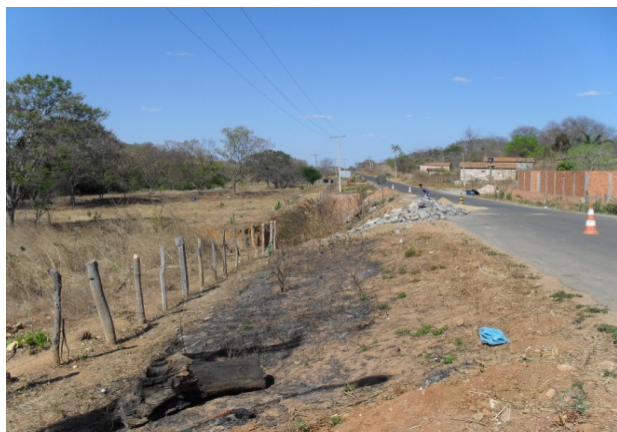
Foto 5: Obra para facilitar o escoamento das águas pluviais na pista para Santana.
