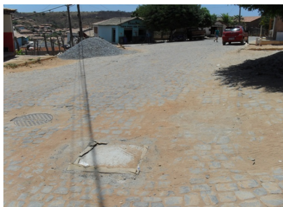
Foto 10: Área Crítica 2 - vista da parte de cima da Rua Nozinho Araújo.
