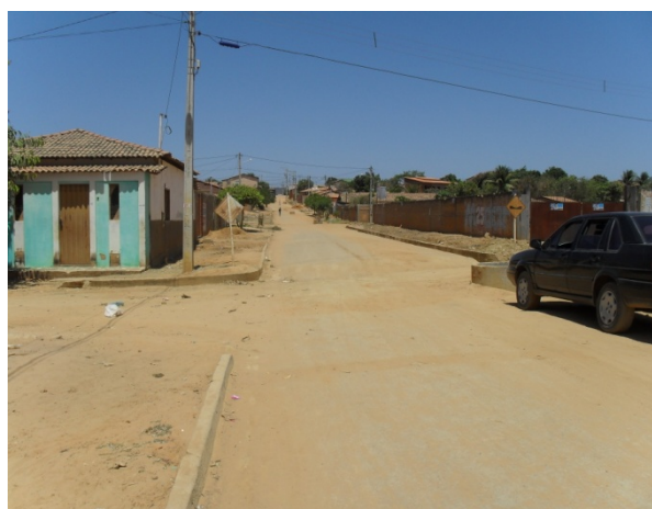
Foto 8: Vista da Avenida Lessa. Declividade transversal da pista contribui para a convergência das águas pluviais e escoamento das mesmas na Rua Gilead Nogueira.
