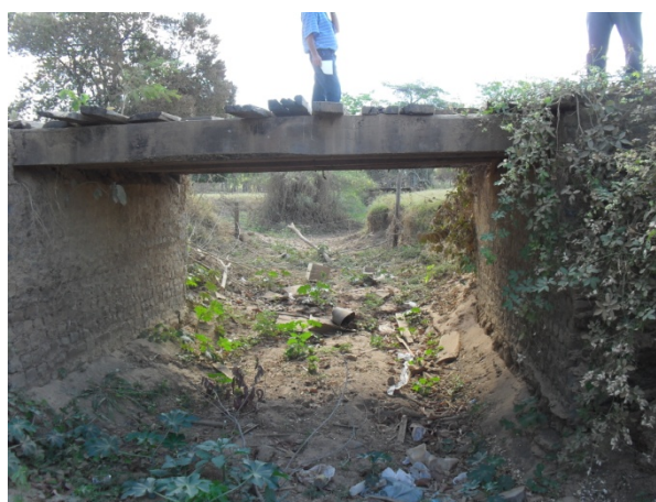
Foto 14: Área Crítica 6 - travessia na Rua Alto da Vitória de um riacho intermitente que contribui para o Riacho Santana.
