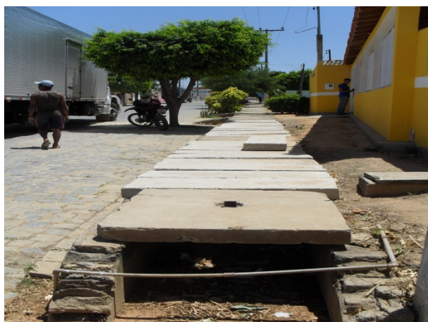
Foto 3: Início da drenagem existente ao final da Rua Lessa. Canaleta coberta. Seção retangular média de 0,8m x 0,6m.
