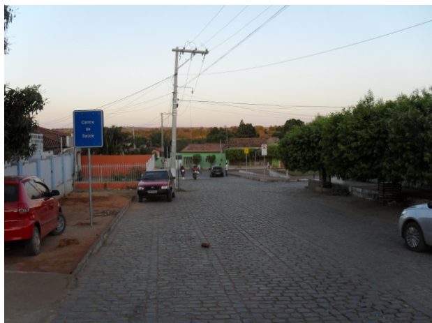
Foto 9: Área Crítica 4 - vista de outro ângulo da Rua Atílio Lopes.
