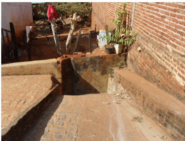
Foto 3: Início do dispositivo de macrodrenagem. Rua Joaquim de Carvalho.
