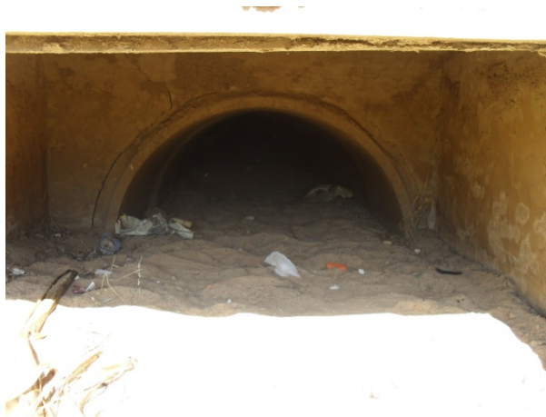
Foto 20: Final do 2º trecho do Canal de macrodrenagem em leito natural e início do 3º trecho novamente em galeria circular de concreto, agora com diâmetro de 1200 mm.
