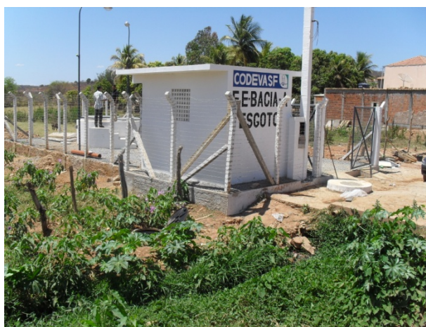
Foto 3: Estação Elevatória de esgoto principal do novo SES implantado via CODEVASF.
