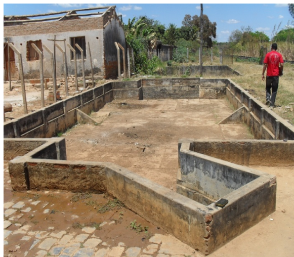
Foto 6: Visão geral das unidades existentes da estação de tratamento de esgoto abandonada.
