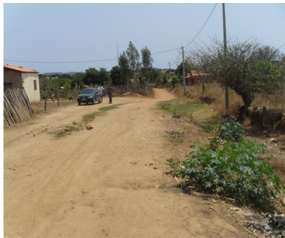
Foto 2: Área Crítica 3 - vista de outro ângulo da área afetada pelos efeitos da chuva na Rua 31 de Março.
