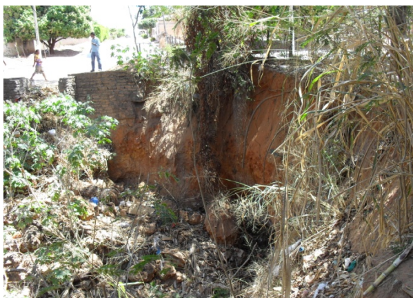
Foto 7: Final da Rua José Domingos Ferreira. Outro local que possibilita a visualização da erosão que se alastra desde a Rua Getúlio Vargas.
