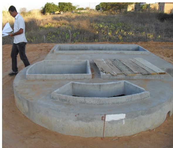
Foto 10: Final da Avenida Colômbia. Poço de sucção da estação elevatória de esgoto do novo sistema de esgotamento sanitário construído.
