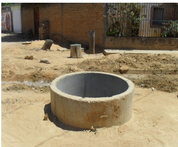
Foto 3: Poço de visita construído pela empresa contratada para executar a obra do sistema de esgotamento sanitário.
