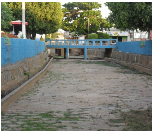
Foto 18: Riacho das Lajes. Trecho canalizado na região central da cidade. Seção retangular 8m X 1,8m.
