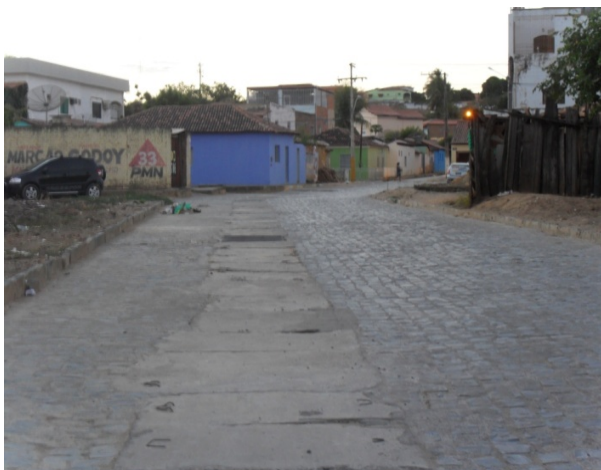
Foto 15: Rua D. Pedro II. Início da galeria enterrada de microdrenagem de seção retangular.
