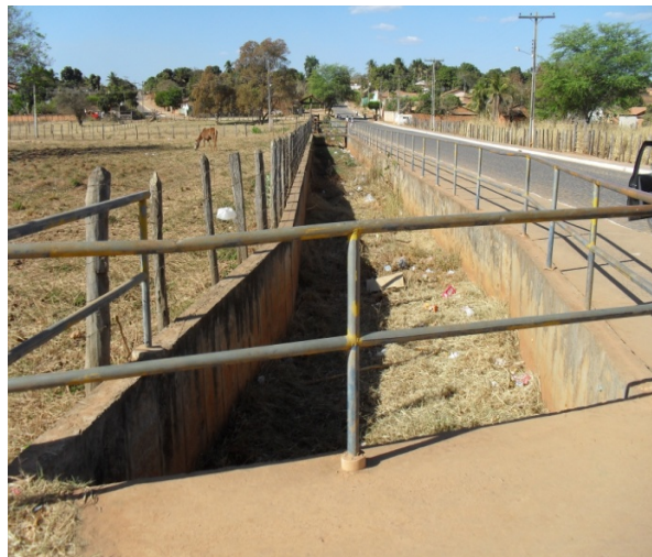
Foto 20: Avenida Plácido Cardoso. Trecho final do Canal de macrodrenagem. Seção retangular média de 3m X 1,10m.
