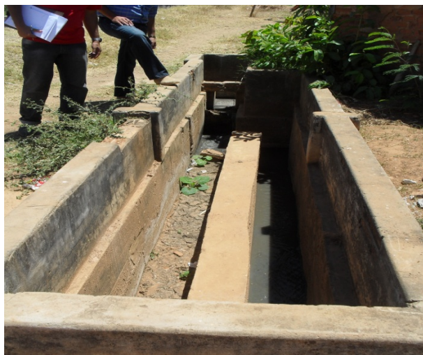
Foto 5: Dispositivo similar a uma caixa de areia. Local de entrada de esgoto da estação de tratamento abandonada.
