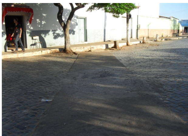
Foto 11: As águas pluviais coletadas juntamente com os esgotos secundários pelas canaletas são lançadas em uma galeria de macrodrenagem enterrada de seção retangular de 1,2m x 1m.
