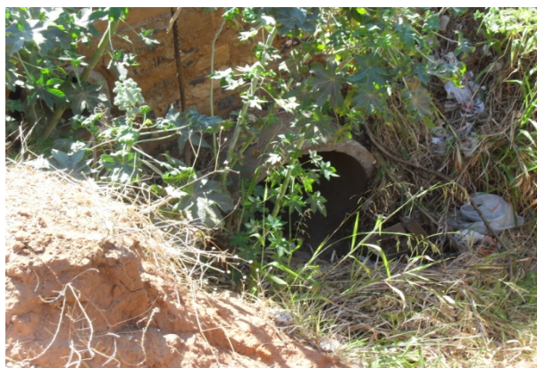
Foto 18: Final do 1º trecho do Canal de macrodrenagem em galeria circular de concreto de 1000 mm de diâmetro.
