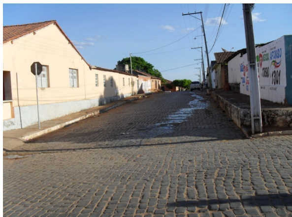
Foto 6: Esgoto secundário a céu aberto. Rua Ruy Barbosa.
