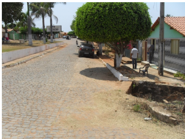
Foto 5: Área Crítica 1 - Rua 2 de Julho. Área crítica por conta de enxurrada.
