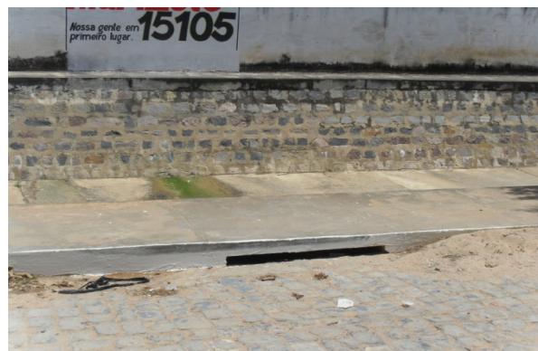
Foto 12: Dispositivo de coleta superficial tipicamente encontrado nas proximidades do Riacho Vermelho.
