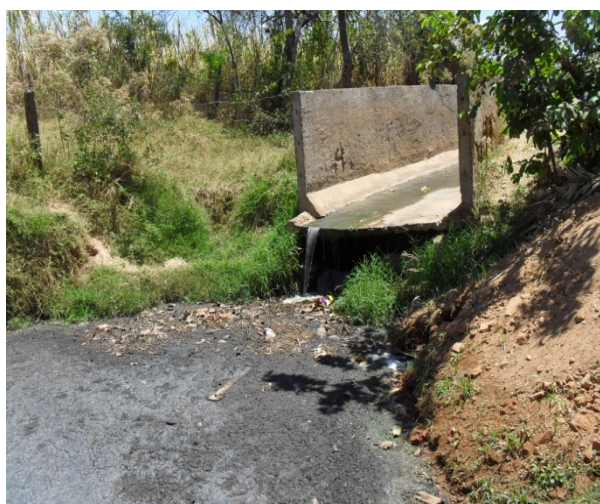
Foto 3: Ponto de lançamento de águas pluviais e esgotos sanitários no Riacho de Santana do Canal que se inicia na Rua Amazonas (trecho enterrado) e tem seu trecho final aberto.
