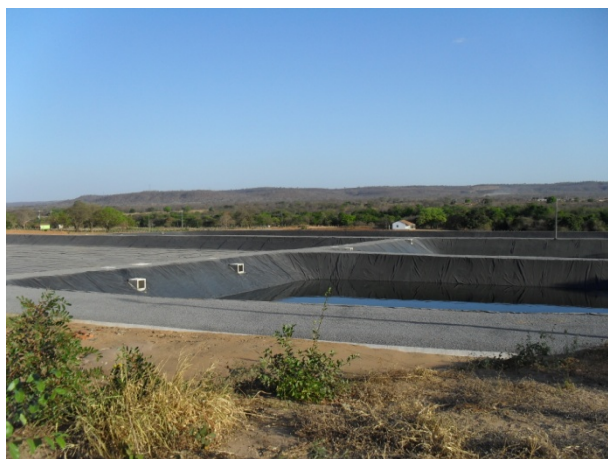
Foto 5: Estação de tratamento de esgoto do novo sistema de esgotamento sanitário em fase de implantação.
