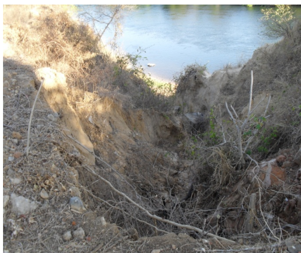
Foto 14: Bairro Sambaíba. Processo erosivo de grande proporção a margem do rio.
