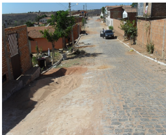
Foto 22: Área Crítica 8 - vista de outro do ângulo da Rua Joaquim O. Fagundes.
