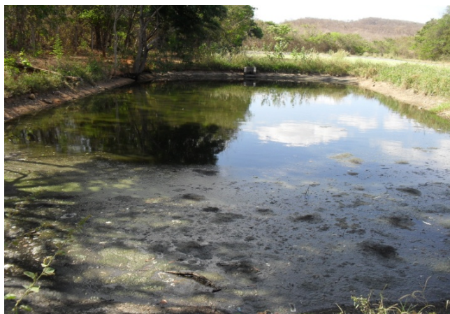
Foto 5: Lagoa de estabilização com espuma e gordura na superfície. Retrato da falta de manutenção.
