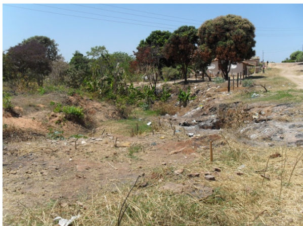
Foto 9: Início da Rua Monsenhor Montalvão. Área afetada pelo processo erosivo das águas pluviais.
