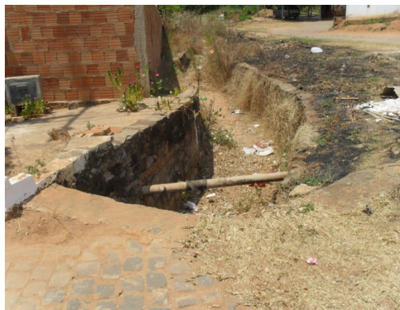
Foto 6: Trecho de Canal de macrodrenagem em alvenaria de pedra na Rua 2 de Julho. Seção retangular de 1,5m x 1m.
