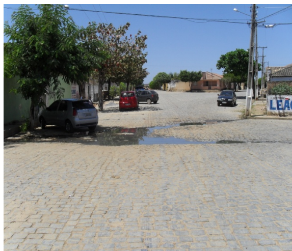
Foto 2: Área Crítica 1 - vista de outro ângulo da Rua Lessa. Região em frente ao Colégio Valdir Araújo Castro.
