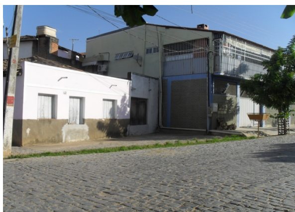
Foto 10: Área Crítica 4 - vista de outro ângulo do cruzamento da Rua Capitão Odorico Marques com a Rua Cornélio Lafuente. Moradores locais constroem barreiras físicas para conter as águas pluviais.
