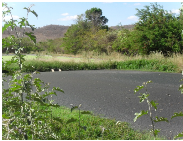
Foto 6: Lagoa de estabilização com talude completamente tomado pela vegetação e superfície completamente tomada pela espuma e gordura.
