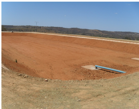
Foto 10: Entrada pelo fundo dos esgotos sanitários na lagoa facultativa.
