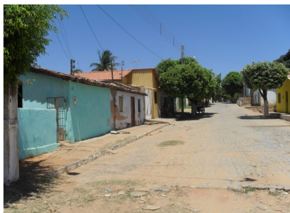
Foto 4: Área crítica 2 - visão da parte da frente da Rua Sinfrônio S. de Souza.
