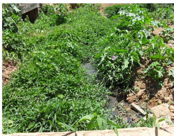
Foto 4: Ponto final de lançamento da galeria mista de macrodrenagem no Riacho Alagoinha. Tubulação de concreto com diâmetro de 1000 mm.
