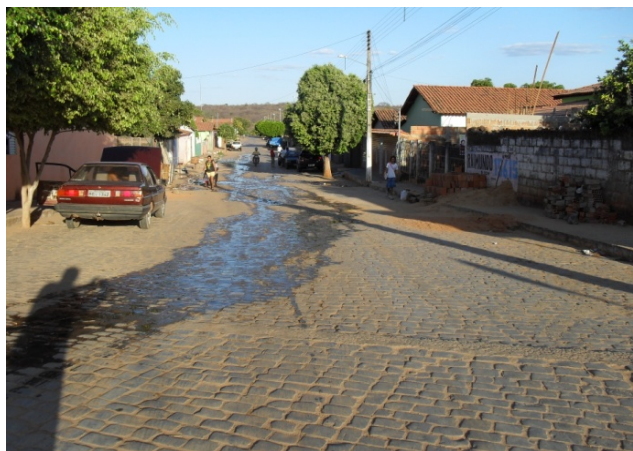
Foto 5: Esgoto secundário a céu aberto. Rua 7 de Setembro
