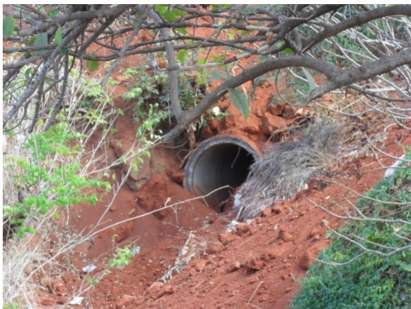
Foto 5: Saída da rede de macrodrenagem em tubulação de concreto de 1000 mm de diâmetro localizada na Rua João Vitor. Lançamento em terreno natural.
