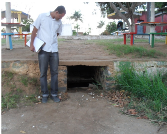
Foto 16: Ponto de lançamento da galeria de microdrenagem de seção retangular 1m X 1m.
