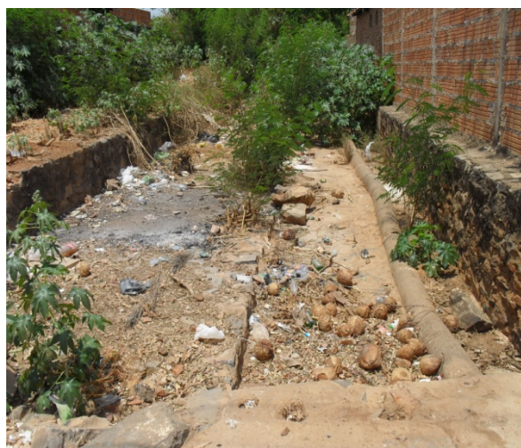
Foto 8: Trecho de canal revestido em alvenaria de pedra de seção retangular de 4m X 1m. Boa parte das águas pluviais que chega à Praça Castro Alves escoam por este canal até alcançar o Riacho de Tabocas.
