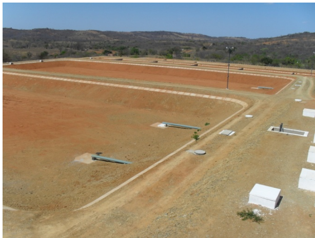
Foto 13: Visão das Lagoas facultativas e de maturação da Estação de Tratamento de Esgoto do novo SES implantado via CODEVASF.
