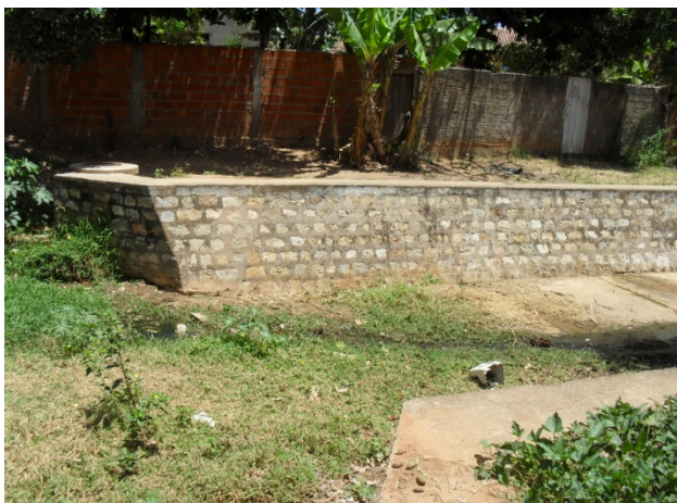
Foto 9: Início do trecho canalizado do Riacho Vermelho. Extensão aproximada de 2000 metros.
