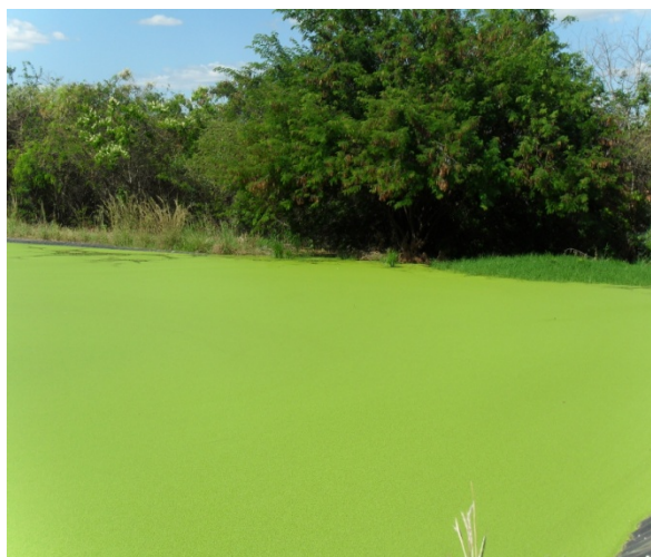
Foto 8: Lado da lagoa de estabilização com ameaça de colapso no talude. Efluente da lagoa a ponto de transbordar no terreno natural ao lado da lagoa.
