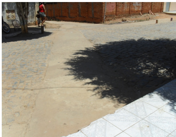
Foto 2: Galeria enterrada de seção retangular que transporta esgotos sanitários e águas pluviais. Seção 1m x 1m.
