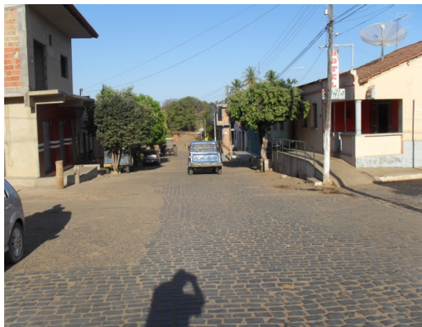
Foto 1: Área Crítica 2 - cruzamento da Rua Simões Filho com a Rua Ruy Barbosa. Área crítica por conta de erosão.
