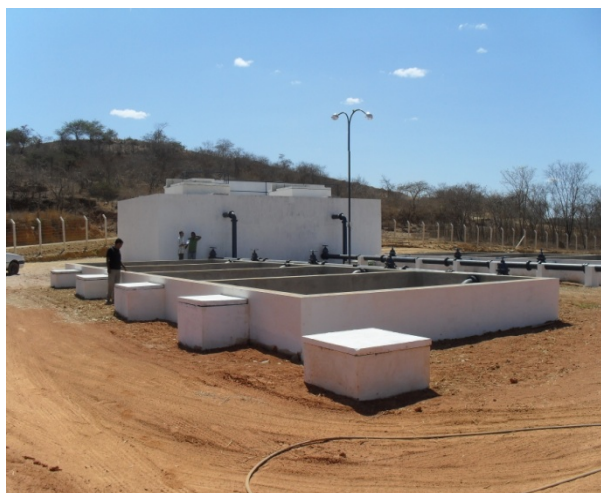
Foto 8: Leitões de secagem para posterior tratamento do lodo gerado nos DAFA's
