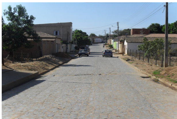
Foto 13: Área Crítica 6 - Rua 1º de Janeiro. Área crítica devido à ocorrência de alagamento.
