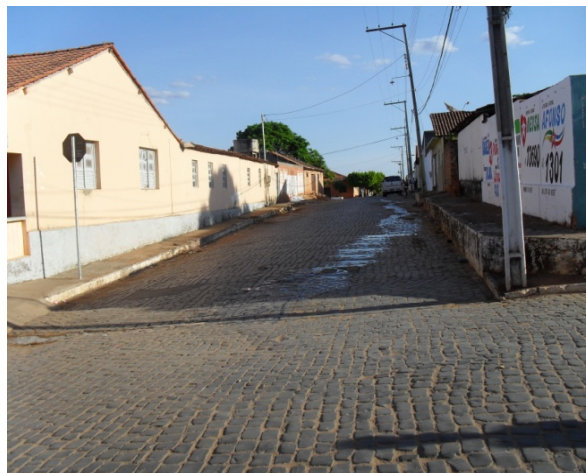
Foto 2: Área Crítica 2 - vista da Rua Ruy Barbosa
