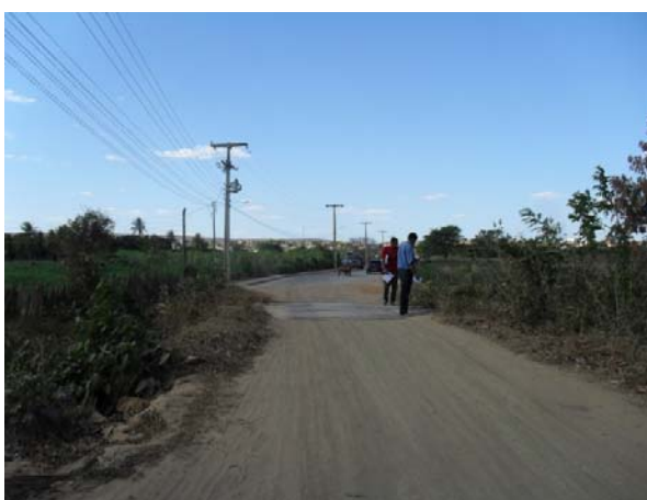
Foto 13: Área Crítica 6 - Rua Alto da Vitória. Trecho sujeito a inundação causada pelo Riacho Santana.
