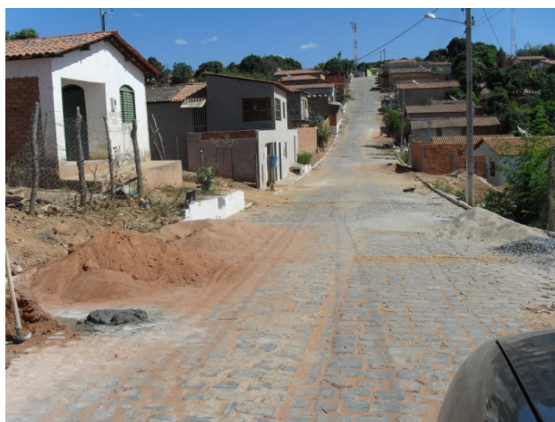
Foto 21: Área Crítica 8 - Rua Joaquim O. Fagundes. Área crítica por conta de erosão.
