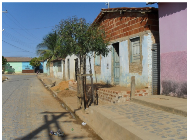
Foto 11: Área Crítica 5 - Rua 3 de Agosto e região próxima. Área crítica por conta de alagamento.
