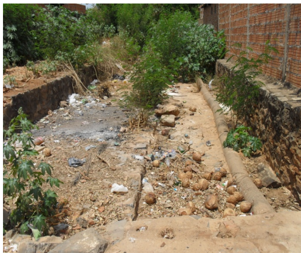
Foto 1: Rede de esgoto em tubulação de concreto passando dentro do canal de macrodrenagem
