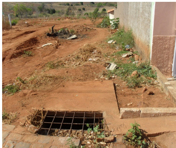
Foto 2: Final da canaleta enterrada e início do trecho de tubulação de concreto de diâmetro de 600 mm que conduz a água da Rua Joaquim de Carvalho e outras ruas até o riacho.
