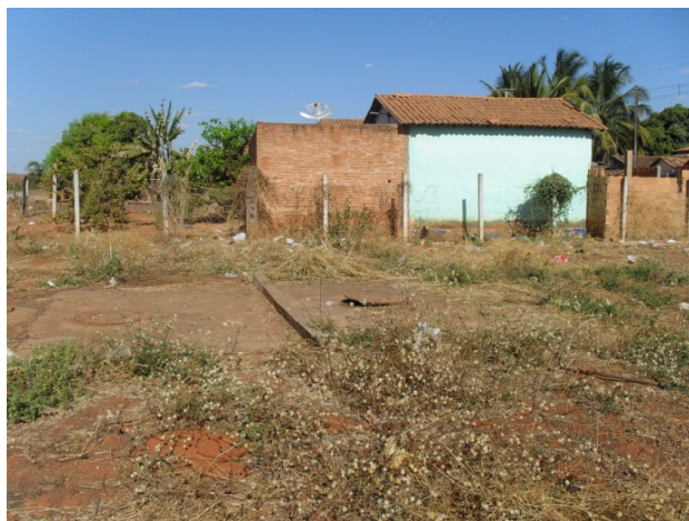
Foto 1: Fossa comunitária que recebe os esgotos das casas populares localizada ao lado do campo de pouso.
