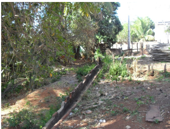
Foto 9: Trecho aberto da canaleta que deságua no Córrego Santo Antônio.
