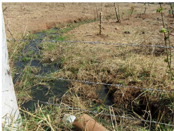
Foto 4: Ponto de descarte do efluente tratado na ETE. Efluente com qualidade ruim sendo lançado no terreno vizinho a estação.
