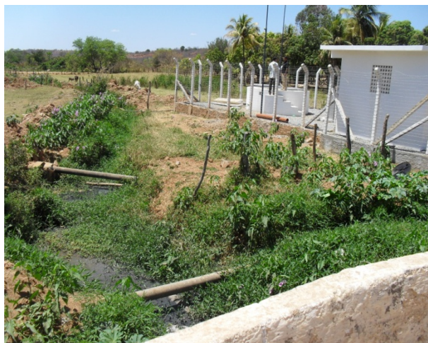
Foto 1: Lançamento pontuais de esgotos sanitários coletados pela rede separadora no Riacho Alagoinha e inclui sistema misto.
