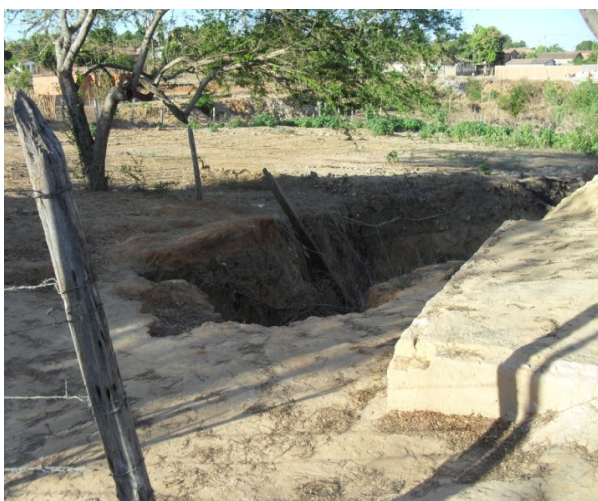
Foto 13: Bairro Sambaíba. Processo erosivo muito marcante na região.
