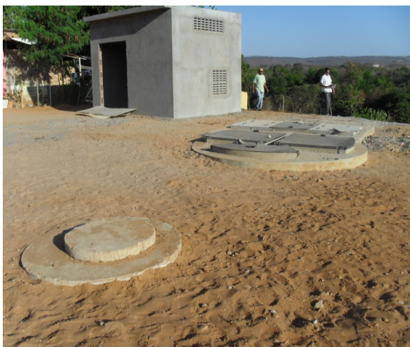
Foto 9: Estação elevatória de esgoto do novo sistema de esgotamento sanitário em fase de implantação localizada próximo da Rua Pedro Coelho. As bombas ainda não foram instaladas.
