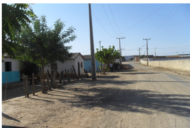
Foto 9: Área Crítica 4 - Rua Paulo Rabelo Nunes. Área crítica por conta da ocorrência de alagamento.
