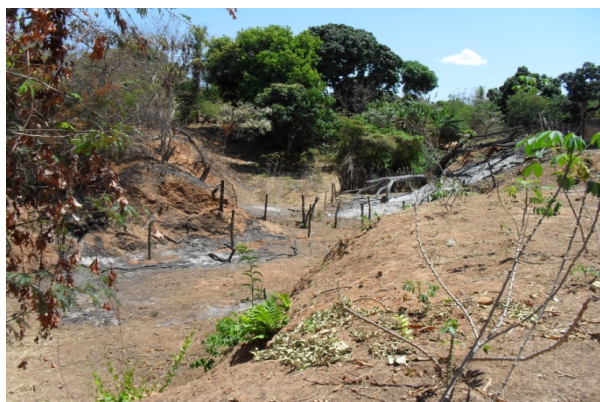
Foto 5: Erosão natural no fundo de lotes
