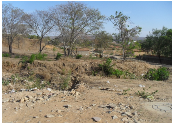
Foto 8: Vista de outro ângulo da erosão. A prefeitura pretende construir uma praça no local
