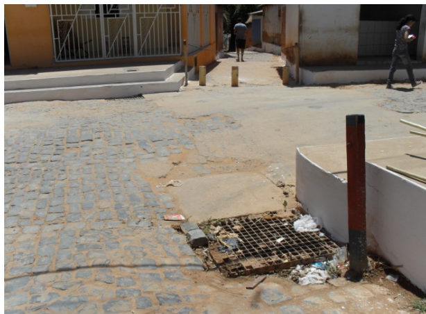
Foto 3: Início do canal misto de macrodrenagem. Trecho com seção retangular de 2,5m X 1,5m.
