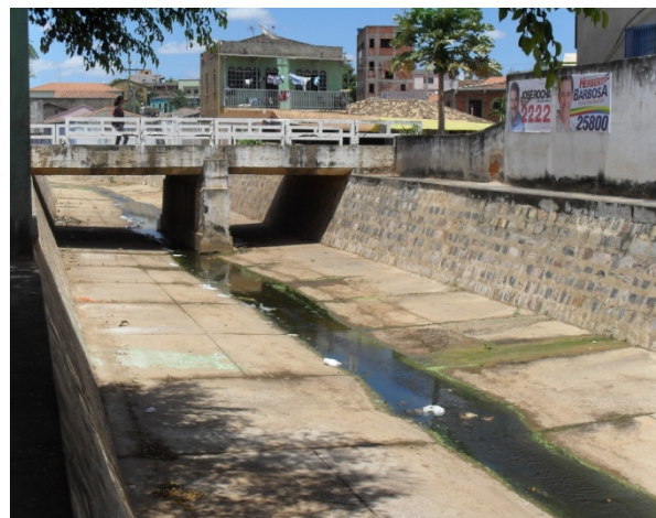
Foto 10: Trecho canalizado do Riacho Vermelho. Revestimento de alvenaria de pedra. Seção trapezoidal de altura aproxima de 2m e base com mais de 10m.
