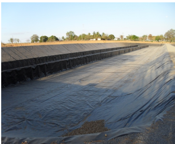
Foto 7: Lagoa de maturação. Chicanas paralelas na direção de entrada do efluente.
