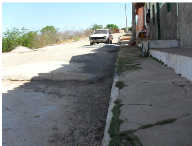
Foto 15: Área Crítica 5 - Rua Boa Vista. Área crítica por conta de erosão.
