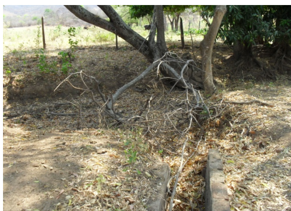
Foto 4: Canaleta do recipiente (tipo fossa) que direcionava parte do efluente acondicionado no riacho intermitente a 5m de distância.
