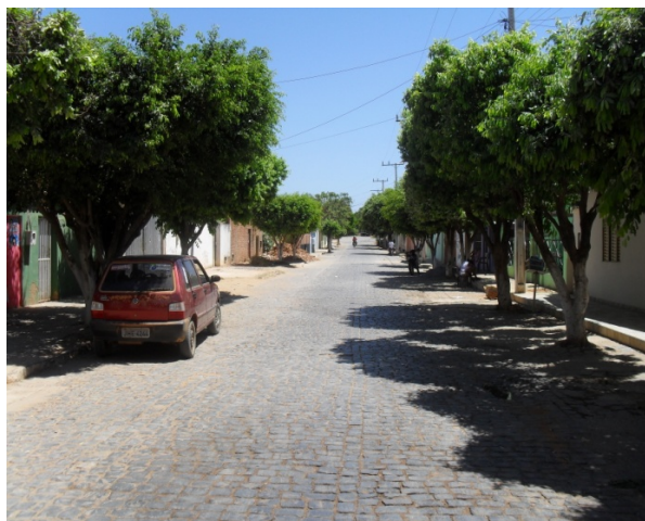
Foto 1: Área Crítica 1 - Rua Lucrécio de Novais. Área crítica por conta de alagamento.
