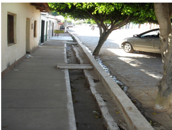
Foto 7: Rua Francisco Moreira Alves. Canaleta de seção retangular 40 cm X 30 cm.
