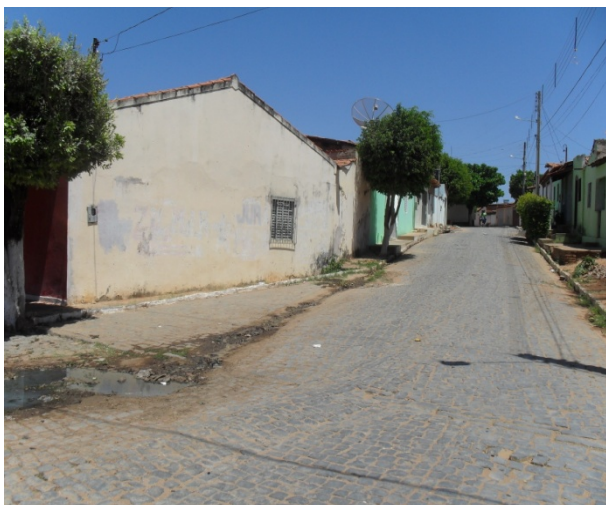
Foto 1: Rua São Miguel. Esgoto secundário a céu aberto escoando pela rua.
