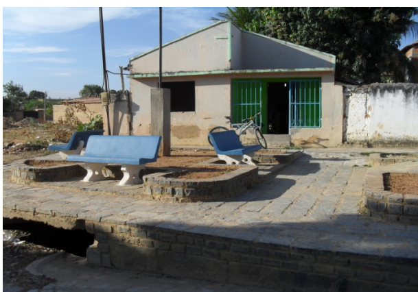
Foto 9: Área Crítica 4 - cruzamento da Rua Capitão Odorico Marques com a Rua Cornélio Lafuente. Área crítica por conta da ocorrência de alagamento.
