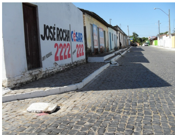
Foto 4: Caixas de passagem da rede antiga de esgoto sanitário.
