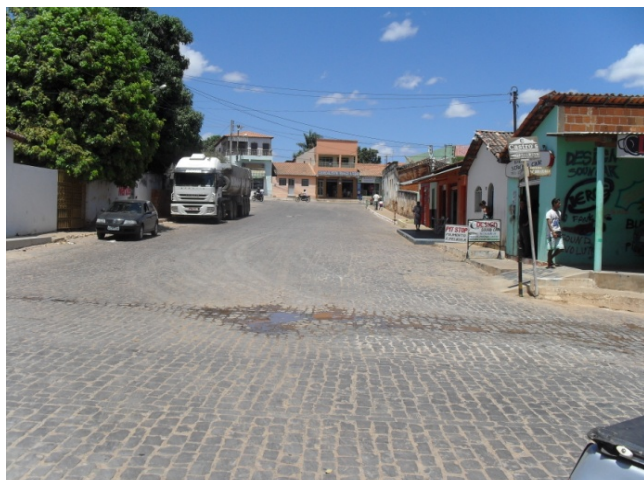
Foto 1: Esgoto secundário escoando numa rua próxima a Avenida Professor Lauro Araújo.
