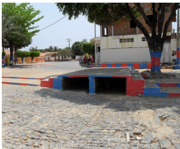
Foto 7: Área Crítica 1 - Praça Castro Alves área crítica por conta de alagamento. Dispositivo de drenagem que facilita a transição das águas pluviais de uma rua para outra da praça.
