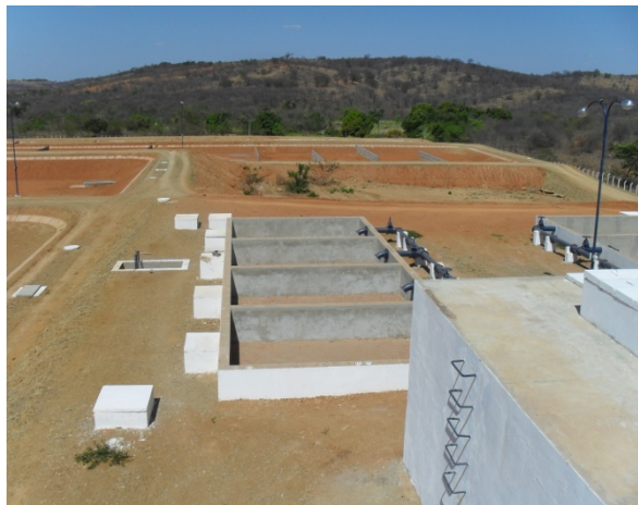
Foto 14: Visão geral da Estação de Tratamento de Esgoto do novo SES implantado via CODEVASF.
