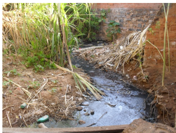
Foto 12: Final da galeria enterrada de alvenaria de pedra que despeja esgotos sanitários e águas pluviais no terreno particular próximo ao rio.
