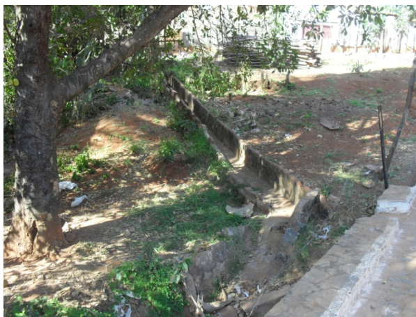
Foto 10: Ponto final da canaleta aberta.
