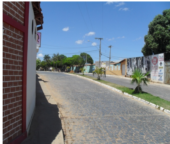
Foto 2: Área Crítica 1 - vista de outro ângulo do trecho final da Avenida Tancredo Neves.
