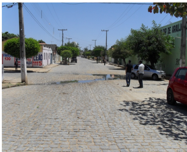
Foto 1: Área Crítica 1 - Rua Lessa. Área crítica por conta da ocorrência de alagamento.
