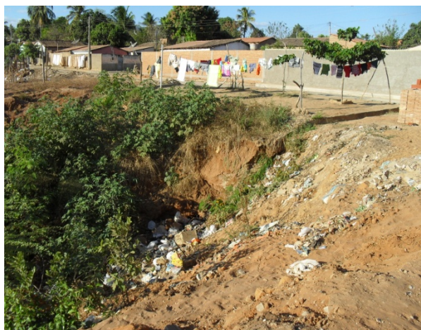
Foto 12: Região próxima as Ruas Ruth Dantas e Manoel Joaquim. Problema de erosão. Bairro Sambaíba.
