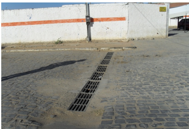
Foto 17: Início do canal de macrodrenagem próximo ao posto de gasolina. Trecho em galeria circular enterrada de 600 mm de diâmetro.
