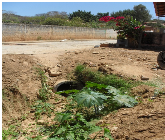
Foto 2: Ponto de lançamento da rede de microdrenagem. Tubulação de concreto de diâmetro de 600 mm.
