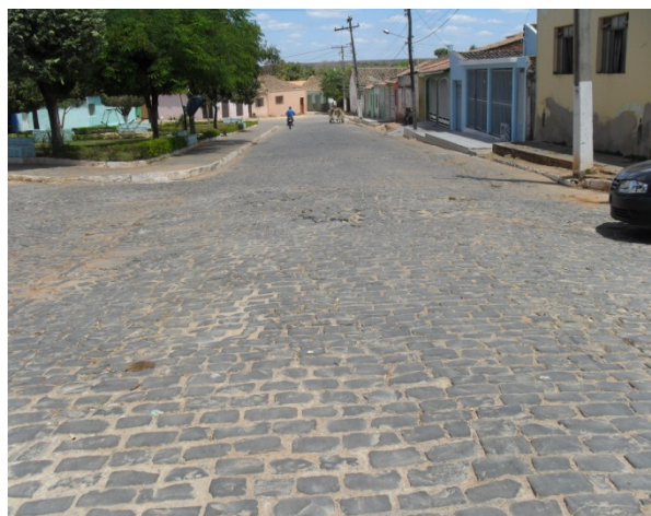
Foto 12: Área Crítica 5 - Praça Alkimin vista de outro ângulo.
