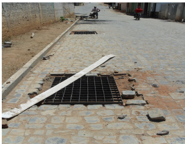
Foto 1: Término da obra de drenagem no final da Rua Manoel da Silva Pereira.
