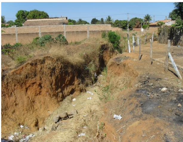
Foto 19: 2º Trecho do Canal de macrodrenagem em leito natural.
