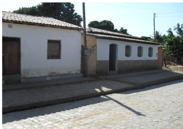
Foto 14: Área Crítica 6 - Rua 1º de Janeiro. Moradores locais construíram muretas para evitar a invasão de suas residências. A prefeitura construiu algumas caixas coletoras de drenagem.
