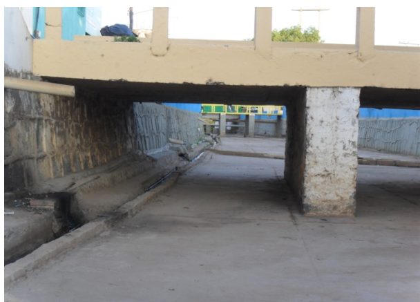
Foto 3: Lançamento difuso de residências ao longo do trecho canalizado do Riacho das Lages.
