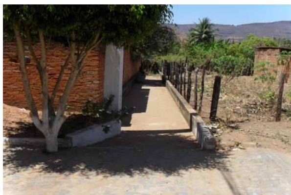
Foto 5: Rua Francisco Nunes Dourado. Trecho no final da rua onde as águas pluviais estão canalizadas. Extensão aproximada de 15m.
