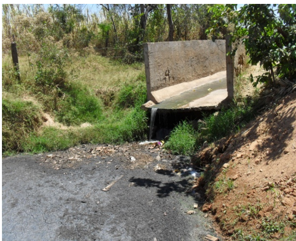
Foto 17: Final do canal de drenagem que se inicia na Rua Amazonas (enterrado) e desemboca (trecho aberto) no Riacho de Santana.
