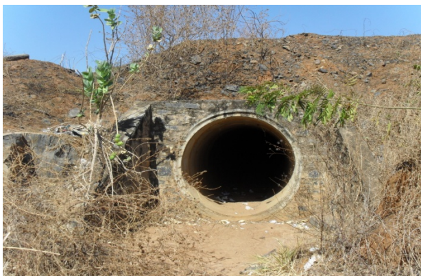
Foto 21: Final do 3º trecho do Canal de macrodrenagem. Galeria circular de concreto de 2000 mm que lança no terreno natural.
