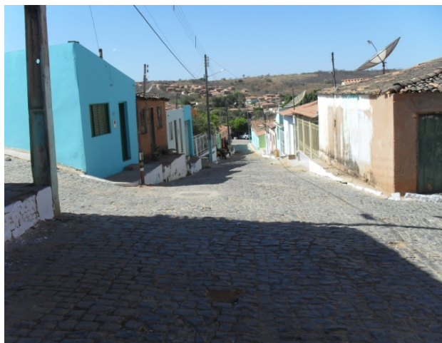
Foto 17: Área Crítica 6 - Rua Santo Antônio. Área crítica por conta de erosão.
