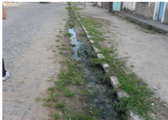
Foto 6: Av. São Francisco de Assis – esgoto secundário lançado a céu aberto.
