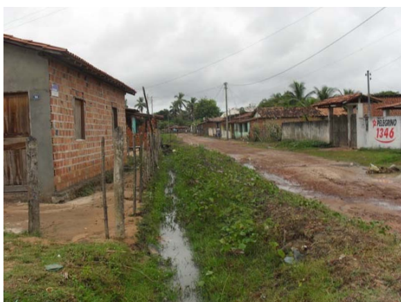
Foto 3: Bairro Nova Itanagra – ruas sem calçamento com valas sem revestimento abertas na lateral por onde escoam águas pluviais e esgoto.
