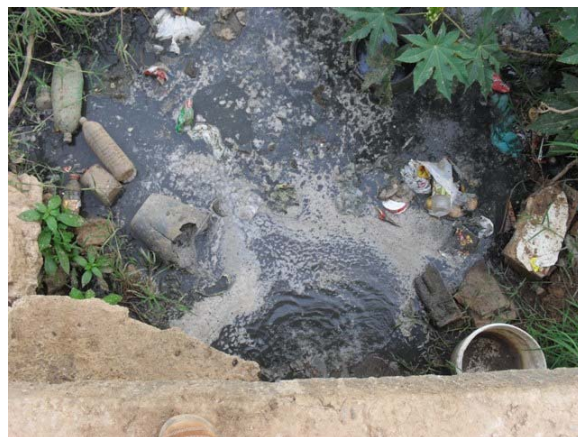
Foto 6: Ponto de lançamento final da galeria de DN 600 mm – termina em Canal coberto na Rua Nova Paraíba (seção 2,00 x 1,0 m).
