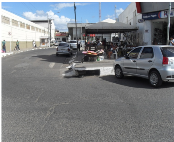
Foto 15: Rua P. C. Bastos, centro da cidade. Área crítica por conta da ocorrência de alagamento. Área crítica 3.
