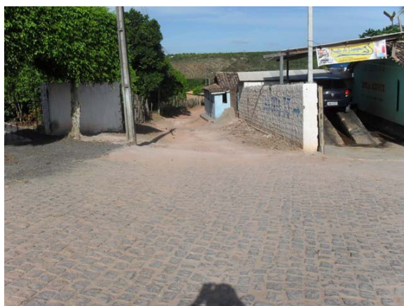
Foto 12: Final da Rua Santa Terezinha – mostrando as erosões ocasionadas pelas chuvas.
