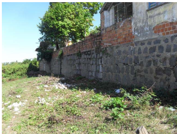
Foto 2: Ponto de lançamento de esgoto secundário e drenagem – escoamento pela margem do rio – saída em tubo PVC DN 200 mm e alguns pontos de lançamento direto no rio.
