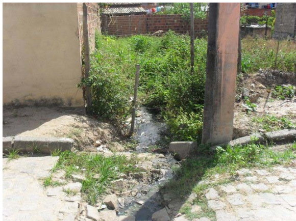
Foto 5: Rua do Loteamento Primavera como Rua José Campo das Fonseca – mostrando o esgoto correndo a céu aberto – desce para área particular pelos quintais das casas – cerca de 600 m até a rede de manilha.
