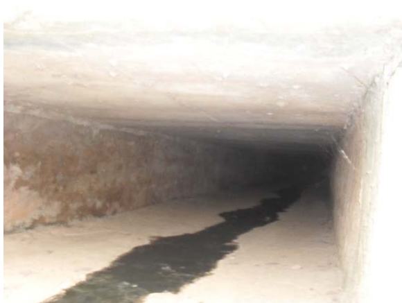
Foto 5: Ponto de lançamento final da galeria de DN 600 mm – termina em Canal coberto na Rua Nova Paraíba (seção 2,00 x 1,0 m).
