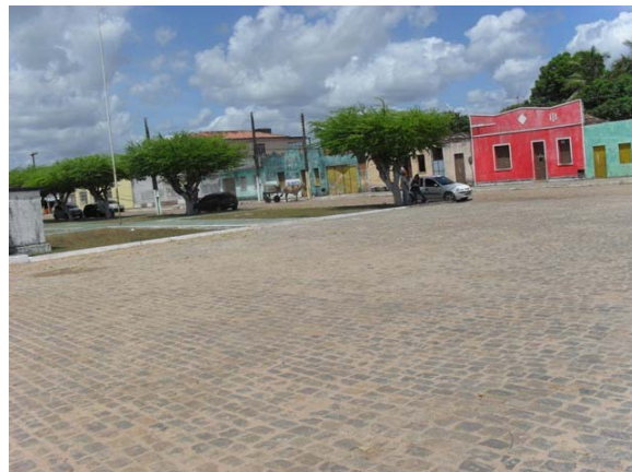
Foto 2: Área Crítica 1 – Rua Horácio Farias com a Rua Antonio Deocleciano Dantas – área de enxurrada.
