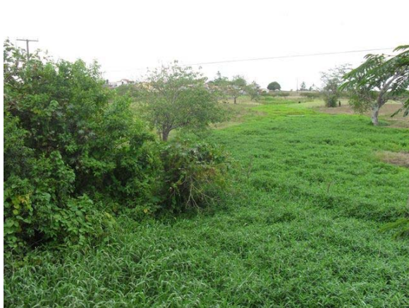
Foto 3: Ponto de lançamento de esgoto e drenagem – tubo de concreto DN 300 mm coberto pela vegetação e escoamento para o Rio Inhambupe (informação do gestor, porém, não está visível).
