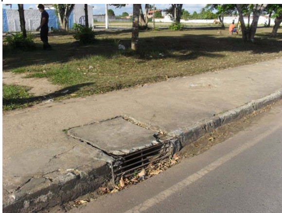
Foto 5: Área crítica 2 – Rua da Bica – área de enxurrada e lançamento de esgotos – situação gravíssima – fotografia mostra a grande erosão na chegada do bueiro – cerca de 1,5 m de profundidade.
