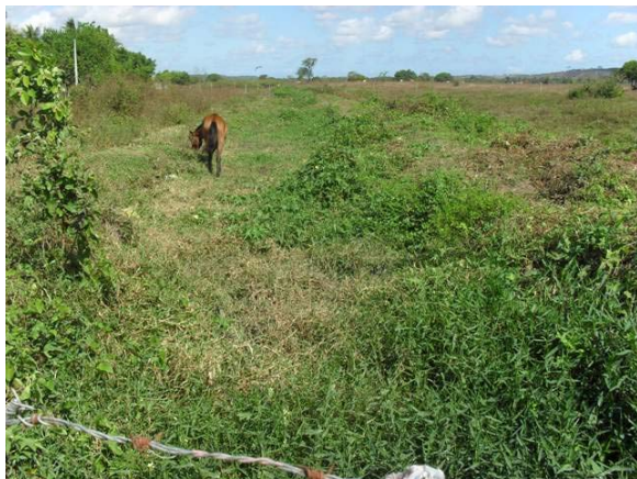
Foto 15: Rua Antonio de Carvalho – ponto de lançamento de drenagem e esgoto – tubo de concreto DN 600 mm – lança em terreno da Prefeitura e segue através de vala sem revestimento e infiltra até a Lagoa dos Patos.
