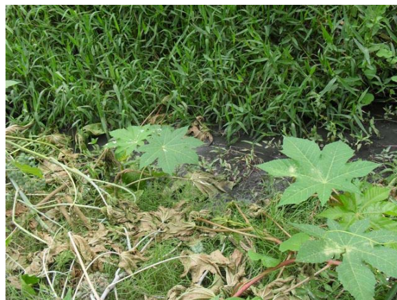
Foto 2: Ponto de lançamento final (esgoto e águas pluviais) – tubo de concreto DN 600 mm semi-enterrado escoando por vala a céu aberto até o Rio Inhambupe.
