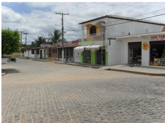
Foto 1: Área Crítica 1 – Rua Luiz Viana com a Rua João Bernardino de Sena – área de enxurrada.
