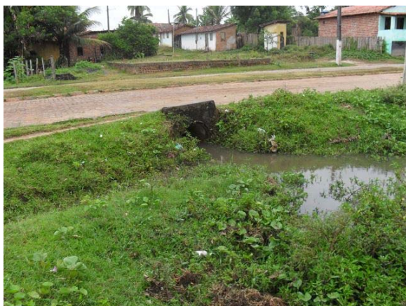
Foto 5: Vista do bueiro que atravessa a Rua Luiz Gonzaga de Lemos – tubo de concreto DN 1000 mm – recebe lançamentos de drenagem e esgotos primários e secundários – escoam em terreno com valas.
