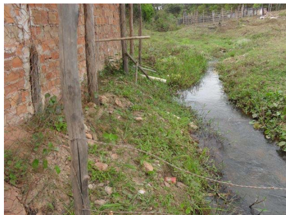
Foto 2: Ponto de lançamento de esgoto difuso e direto no Riacho Maleita - tubo de concreto DN 300 mm (provável, pois não está visível).
