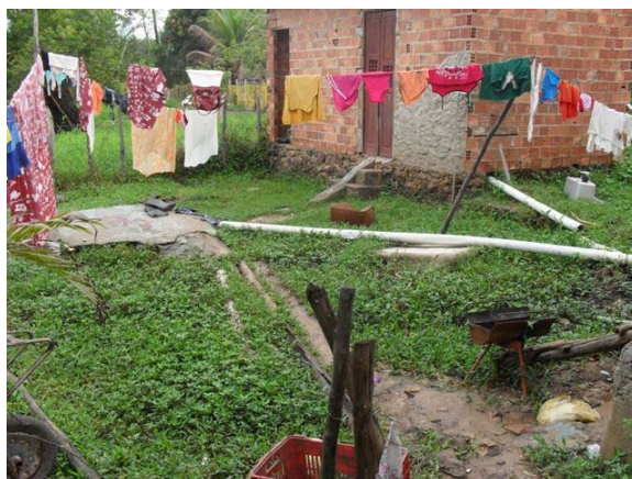
Foto 8: Bairro Nova Itanagra – Rua Tiradentes – fossa coletiva com transbordamento para o Rio Sauípe e situada numa área de brejo.
