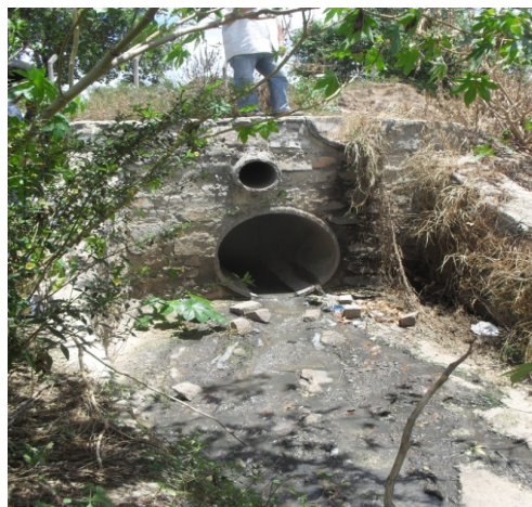
Foto 42: Avenida Ayrton Senna. Detalhe da saída da rede coletora de águas pluviais e esgoto sanitário. Tubulação de concreto de 800 mm de diâmetro.
