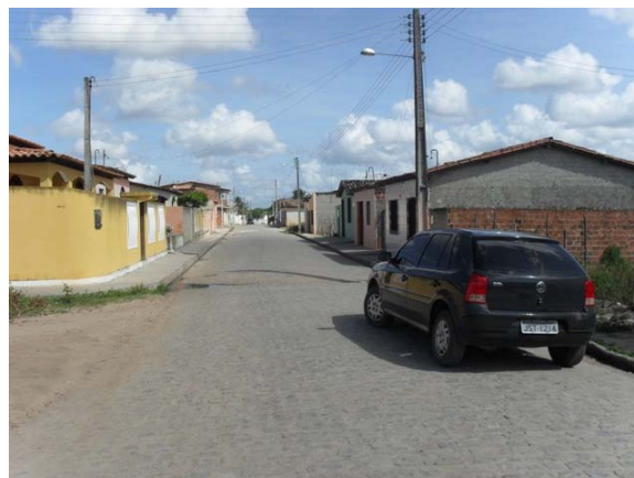
Foto 10: Área Crítica 4 – Rua José Campos da Fonseca – área de enxurrada – mostra as ruas de escoamento.
