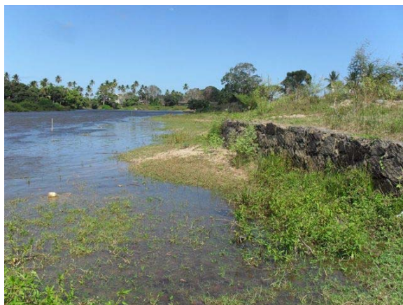
Foto 6: Rio Itapicuru – mostra assoreamento, bancos de areia e trecho de uma contenção em gabião na margem direita – não são lançados esgotos nesta área.
