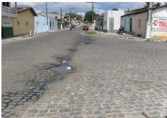
Foto 1: Av. Honório Borges – esgoto a céu aberto e lixo.
