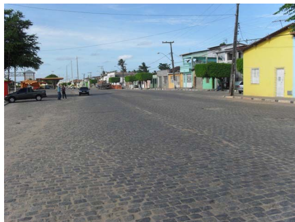
Foto 2: Área Crítica 1 – Rua Siqueira Campos – área de enxurrada.
