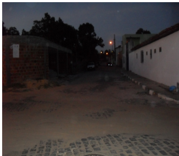
Foto 38: Rua Silva Jardim. Área crítica por conta da ocorrência de alagamento. Área crítica 11.
