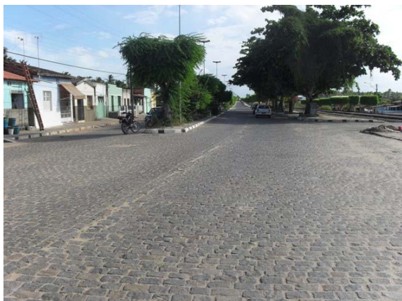
Foto 1: Área Crítica 1 – Rua Siqueira Campos – área de enxurrada.
