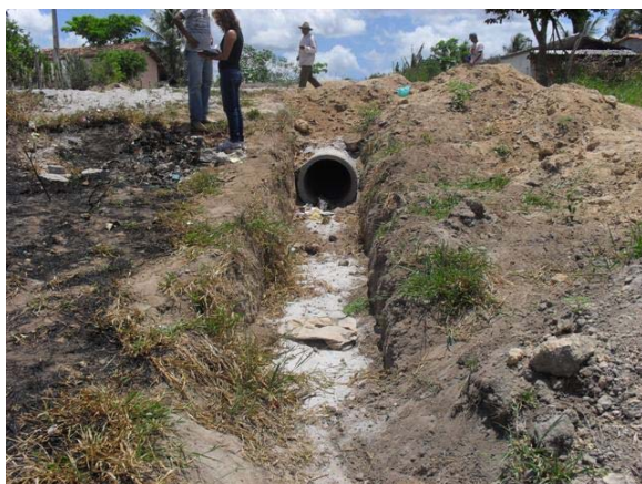
Foto 9: Único ponto de lançamento de drenagem da cidade - vista da rua com pavimentação e com caixas de abertura na guia e lançamento em terreno através de tubo de concreto DN 500 mm.
