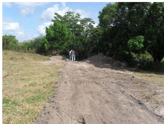
Foto 8: Área Crítica 2 – obra de implantação da rede DN 600 mm com 330 m de comprimento citada anteriormente, segue até o Riacho (+ ou – 500 m) por infiltração.
