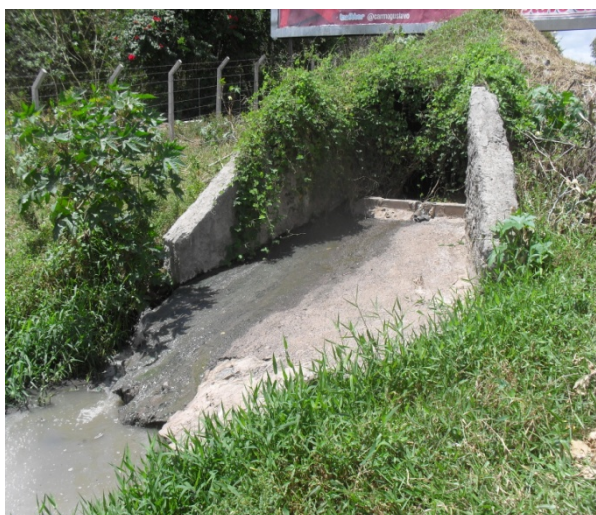
Foto 35: Detalhe da saída da estrutura de macrodrenagem que transporta e esgoto e desemboca a montante da Lagoa Fonte dos Padres. Seção retangular de 1,2m X 1,2m.
