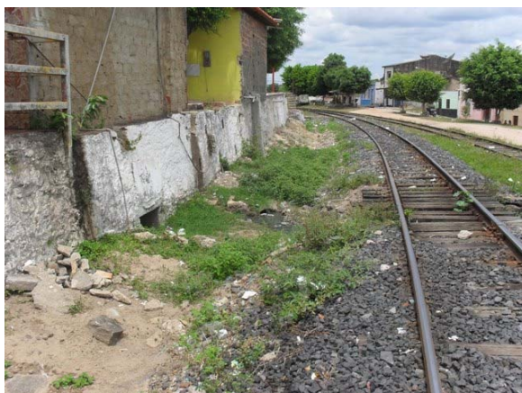
Foto 3: Ponto de lançamento de esgoto primário e secundário e drenagem – caixas e galeria da linha férrea em tubo de DN 600 mm que é reduzido para DN 400 mm – lança em terreno e escoamento em direção ao Rio Aramari.
