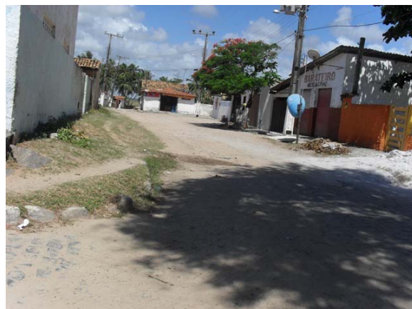
Foto 2: Rua São Domingos – lançamento de esgoto a céu aberto.
