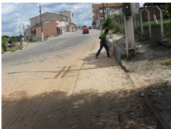
Foto 19: Galeria de drenagem com tubo de concreto de DN 300 mm com caixa de passagem pela linha férrea – escoar no fundo de casa em 2 tubos de DN 300 mm e em vários pontos lançamentos difusos na represa do Rio Aramari.
