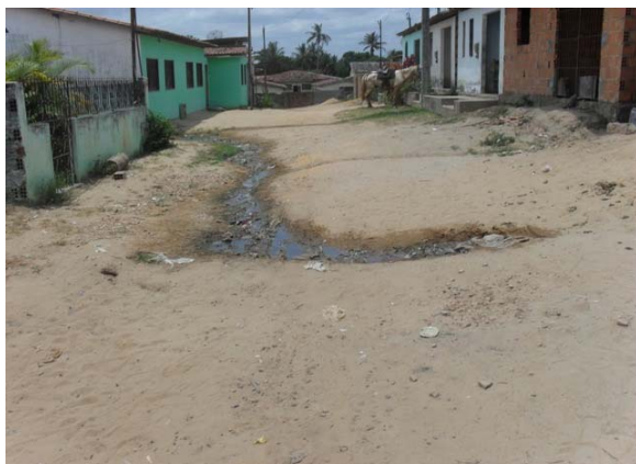
Foto 1: Loteamento Santa Maria – lançamento de esgoto a céu aberto.
