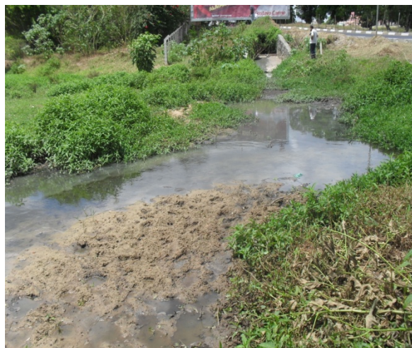
Foto 34: Trecho a montante da Lagoa Fonte dos Padres. Leito do riacho com sinais de assoreamento e presença de esgotos sanitários.
