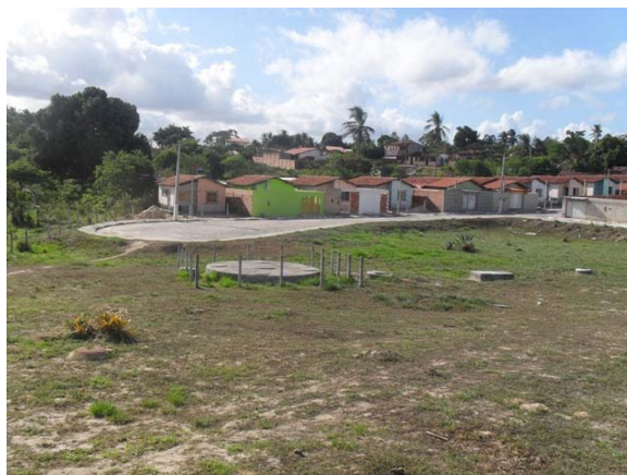
Foto 8: ETE Conjunto Jardim Imperial – DAFA / Caixa de Areia / Grade.
