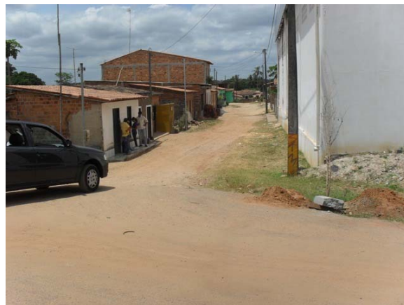
Foto 2: Área Crítica 1 – Loteamento Santa Maria – Rua Sem Saída (denominação do mapa) não tem drenagem e sofre enxurradas.
