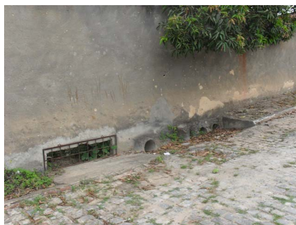
Foto 4: Ponto de lançamento final do Canal da linha férrea – vista da Rua Castro Alves que recebe o lançamento somente de drenagem e direciona para o Rio Aramari. A parte final do Canal é sem revestimento e a céu aberto.
