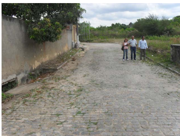
Foto 3: Ponto de lançamento final do Canal da linha férrea – vista da Rua Castro Alves que recebe o lançamento somente de drenagem e direciona para o Rio Aramari. A parte final do Canal é sem revestimento e a céu aberto.
