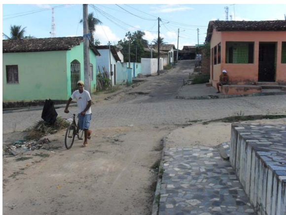
Foto 21: Rua Joana Angélica com a Rua Floresta Negra – mostrando pontos de erosão.
