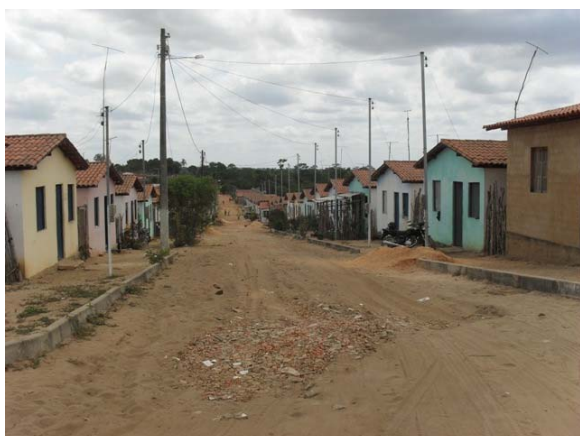
Foto 3: Área Crítica 2 – Loteamento Cruzeiro do Sul – Rua geral do loteamento – área de enxurrada.
