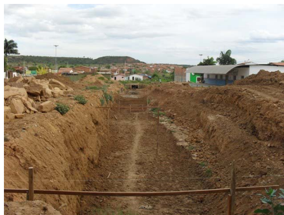
Foto 6: Vista do Canal da Praça da Liberdade – em construção.
