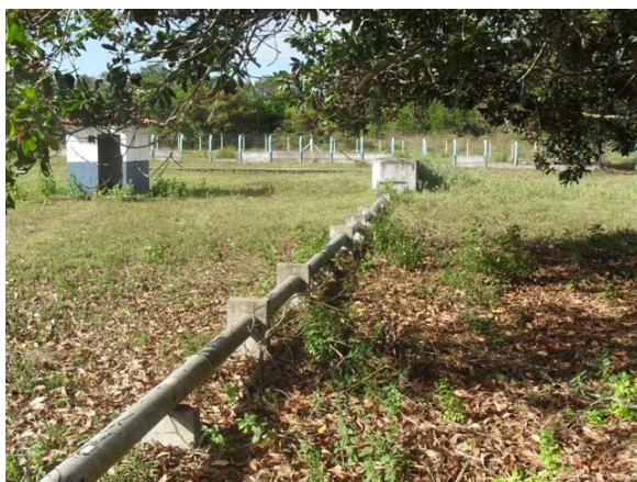
Foto 15: ETE Petrolar – chegada do emissário de esgoto bruto.
