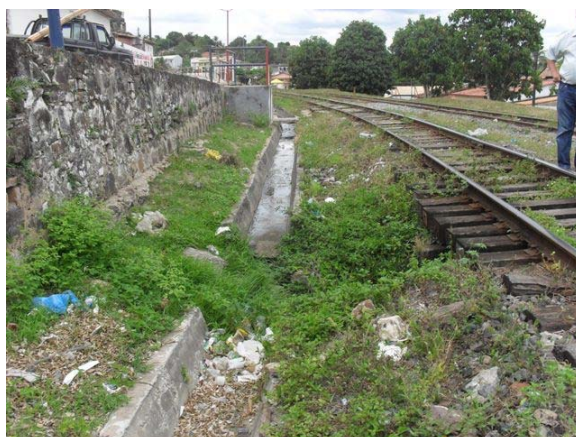
Foto 12: Ponto de lançamento de drenagem com esgoto primário e secundário – tubo de concreto DN 300 mm – galeria da linha férrea (0,50 x 0,30 m) – muito lixo e tubulação danificada que vai até a represa do Rio Aramari.
