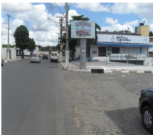
Foto 13: Rua Dantas Bião. Área crítica por conta da ocorrência de alagamento. Área crítica 2.
