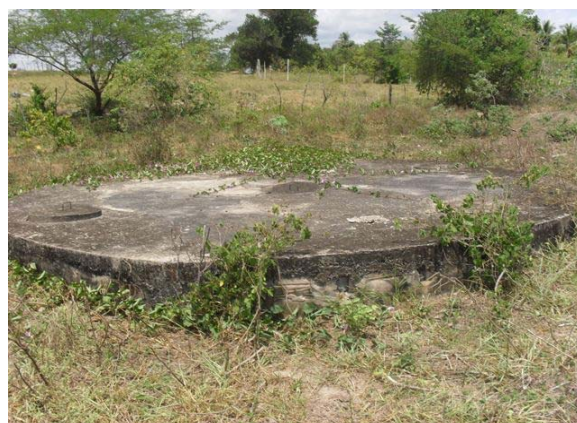
Foto 4: ETE – Reator anaeróbico de fluxo ascendente (DAFA).
