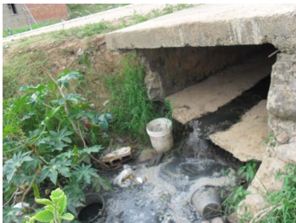
Foto 9: Ponto de lançamento final da galeria de DN 600 mm – termina em Canal coberto na Rua Nova Paraíba (seção 2,0 x 1,0 m).
