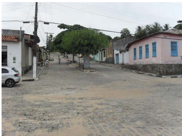
Foto 1: Área Crítica 1 – Rua Clemente Oliveira com a Rua da Trindade – área de enxurrada.
