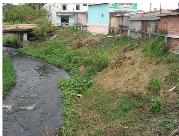
Foto 4: Pontos de lançamento direto de esgoto no corpo receptor e trechos do Rio Catu – a jusante da ponte.
