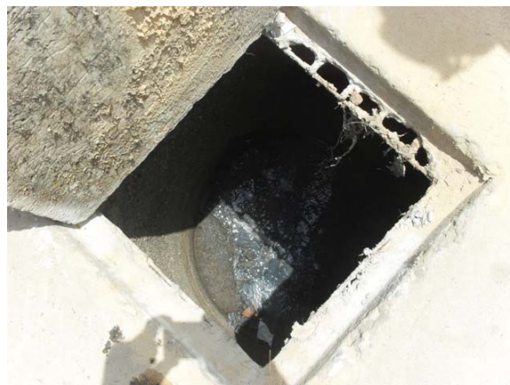
Foto 6: Av. Iderbal Gomes de Cerqueira – vista do aspecto do poço de visita com problemas freqüentes de entupimento.
