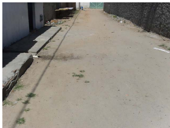
Foto 4: Travessa Antonio Vieira de Castro – pontos de lançamento de esgoto a céu aberto.
