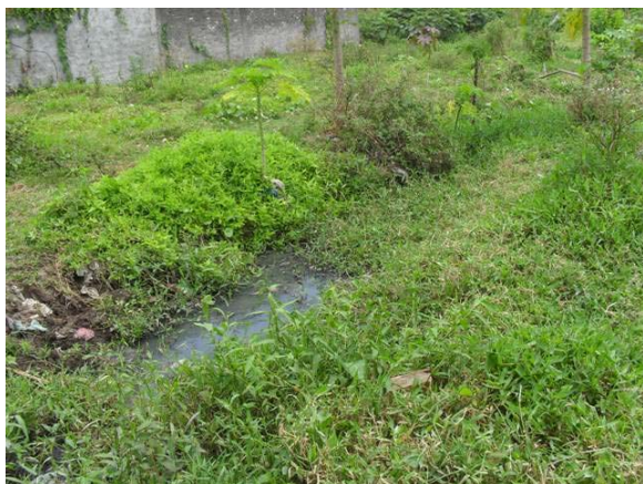
Foto 1: Av. Mangabinha - ponto de lançamento de esgoto e drenagem tubo de concreto DN 600 mm – lança em área particular – presença de lixo e odores fortes.
