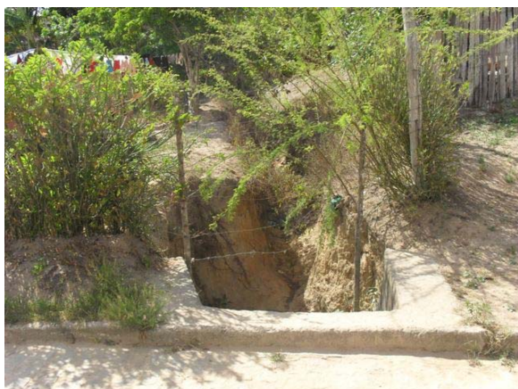
Foto 5: Área crítica 2 – Rua da Bica – área de enxurrada e lançamento de esgotos – situação gravíssima – fotografia mostra a grande erosão na chegada do bueiro – cerca de 1,5 m de profundidade.
