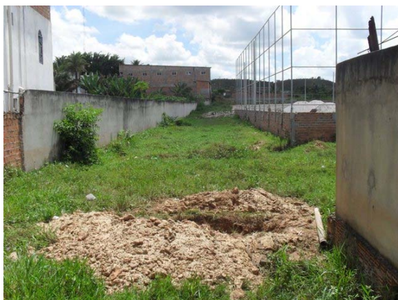
Foto 7: Canalização do Riacho Camtobá – tubo de concreto DN 1.000 com mais ou menos 320 m – caixas e caminhamento tem esgoto clandestino ligado.
