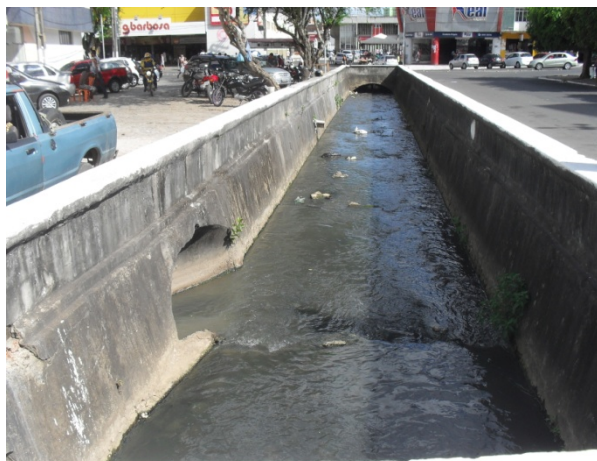
Foto 16: Centro. Trecho canalizado do rio Catu. Canal de seção retangular e paredes revestidas em concreto. Presença de lixo no leito.
