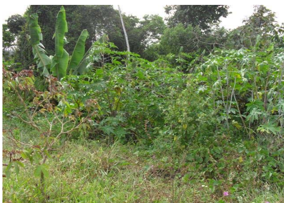
Foto 15: Área do DAFA – rede de tubo de concreto DN 400 mm (na saída grande abismo) – não dá visão para o DAFA devido à vegetação alta.
