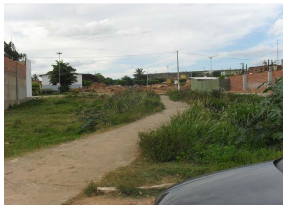
Foto 4: Lançamento das redes de esgoto da Av. das Palmeiras – tubo de concreto DN 600 mm – ponto final na 1ª Travessa da Praça.
