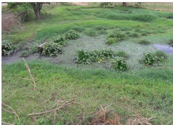
Foto 3: Ponto de lançamento de esgoto de parte da cidade – tubo de concreto DN 600 mm e lançamento final em terreno.
