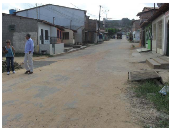
Foto 28: Área Crítica 3 – Rua do Colégio – Bairro Santa Rita com a Rua São João – área de enxurrada.
