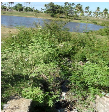
Foto 9: Rua Helena de Castro – ponto de lançamento de drenagem e esgoto secundário – tubo de concreto DN 300 mm – escoamento para o Rio – muito lixo acumulado e mato.
