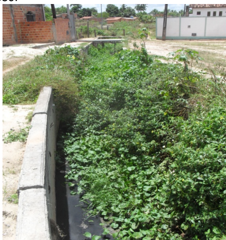
Foto 5: Rua "A". Bueiro de travessia que dá início ao canal de macrodrenagem. Lixo acumulado obstrui o bueiro e provoca o transbordamento no período chuvoso.
