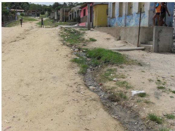
Foto 13: Esgoto a céu aberto no Bairro Alto do Cruzeiro – rua sem pavimentação e com erosão.
