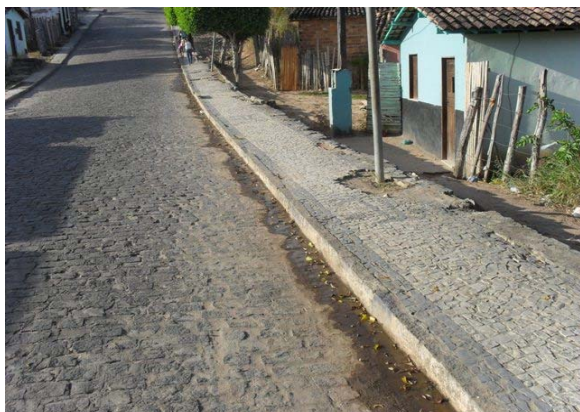
Foto 3: Rua do Hospital – lançamento de esgoto secundário a céu aberto.
