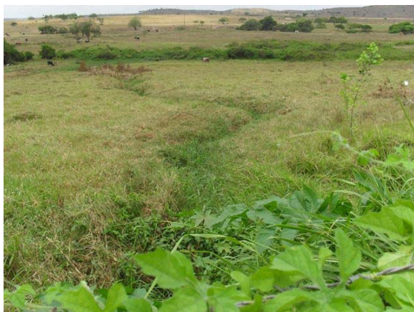
Foto 1: Ponto de lançamento final (esgoto e águas pluviais) – tubo de concreto DN 600 mm coberto pela vegetação – escoamento através de vala sem revestimento até o Rio Inhambupe.
