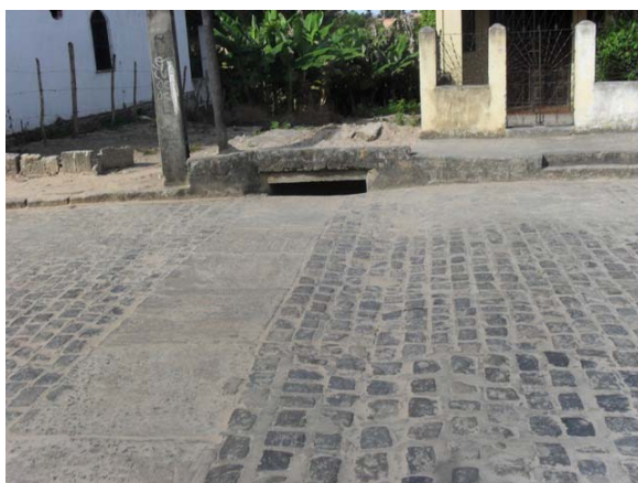
Foto 13: Área Crítica 6 – Rua Pedro Plácido dos Santos – área de enxurrada – mostra ponto de lançamento de drenagem e esgoto DN 600 mm.
