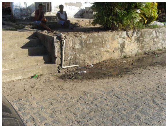
Foto 6: Bairro Vila do Conde – ponto de lançamento de esgoto a céu aberto – presença de muito lixo nas ruas.
