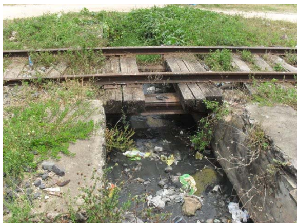
Foto 5: Ponto de lançamento de esgoto primário e secundário e drenagem – caixas e galeria da linha férrea em tubo de DN 600 mm que é reduzido para DN 400 mm – lança em terreno e escoamento em direção ao Rio Aramari.
