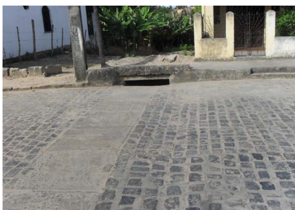
Foto 13: Área Crítica 6 – Rua Pedro Plácido dos Santos – área de enxurrada – mostra ponto de lançamento de drenagem e esgoto DN 600 mm.
