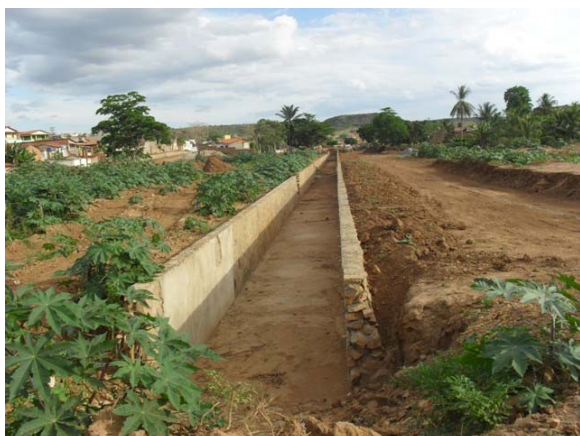
Foto 5: Canal de alvenaria de pedra em construção – trecho intermitente.
