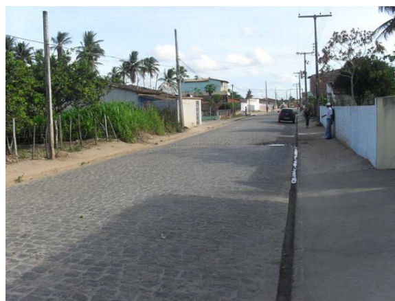
Foto 14: Área Crítica 7 – Rua Joaquim Matos – área de enxurrada – mostra esgotos a céu aberto.
