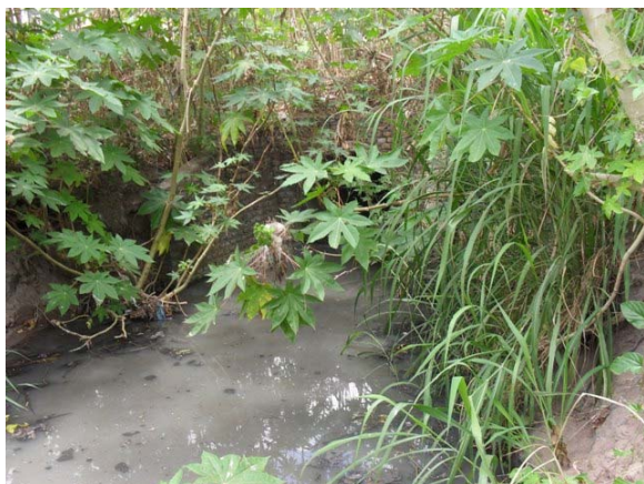
Foto 5: Ponto final de lançamento de drenagem e esgotos – tubo de concreto DN 1.000 mm – lançamento em terreno particular.
