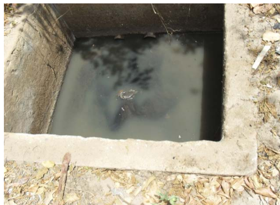
Foto 6: Detalhe da caixa de esgoto.
