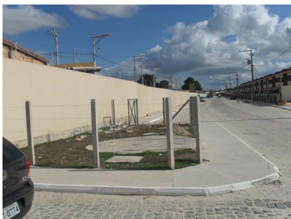
Foto 11: ETE Conjunto Parque Jardim – DAFA / Caixa de Areia / Grade.
