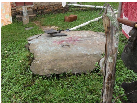
Foto 7: Bairro Nova Itanagra – Rua Tiradentes – fossa coletiva com transbordamento para o Rio Sauípe e situada numa área de brejo.
