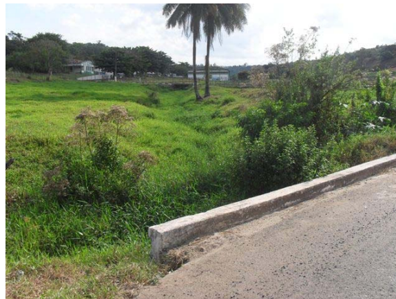
Foto 12: Ponto de lançamento de esgoto da Escola IF – escoam a céu aberto até o Riacho Orobó – travessia da pista através de bueiro triplo DN 1000 mm.
