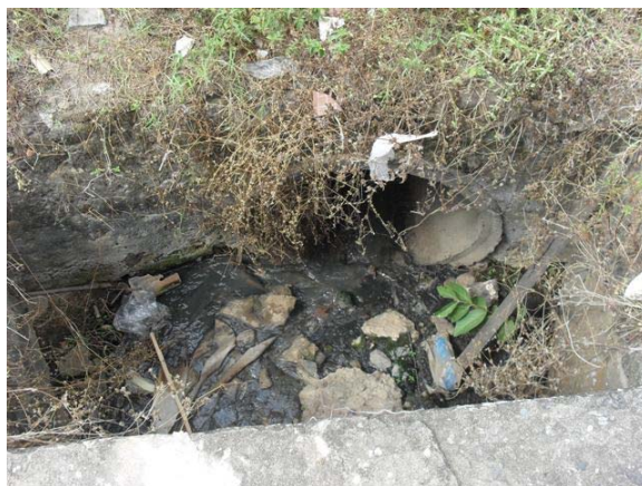
Foto 6: Ponto de lançamento de esgoto – tubo DN 800 mm (mais ou menos 50 m) segue até o Rio Catu em vala aberta – Rua da Linha.
