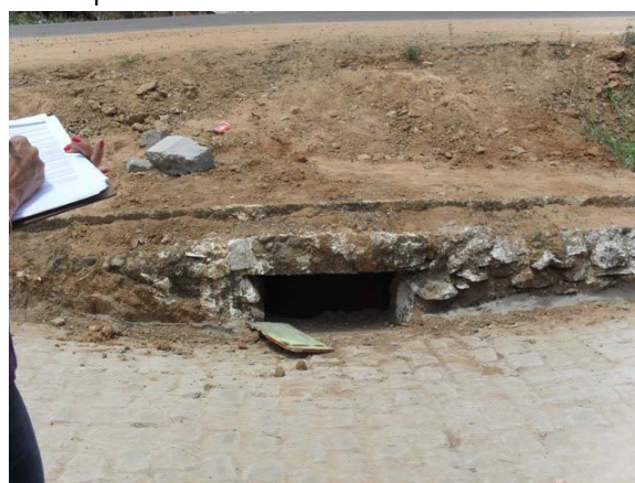
Foto 6: Av. Iderbal Gomes de Cerqueira – vista do aspecto do poço de visita com problemas freqüentes de entupimento.
