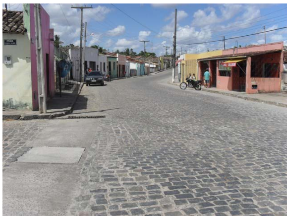
Foto 7: Área Crítica 2 – Rua Marquês de Abrantes – área de enxurrada - mostra as bocas de lobo com lixo, esgoto primário e secundário – lançamento pontual com rede DN 600 mm e comprimento de 330 m atravessando terreno particular até o Riacho Fonte Branca.
