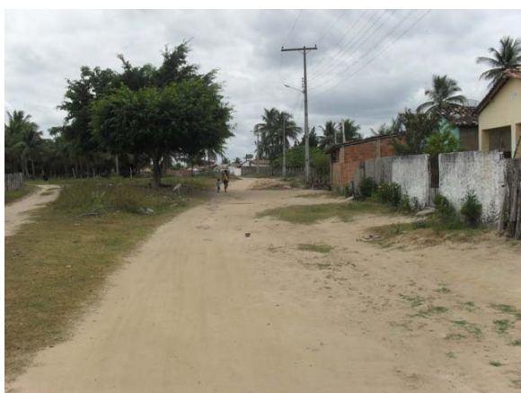
Foto 9: Rua Alzira Barros – final da rede de drenagem – ponto sumidouro.
