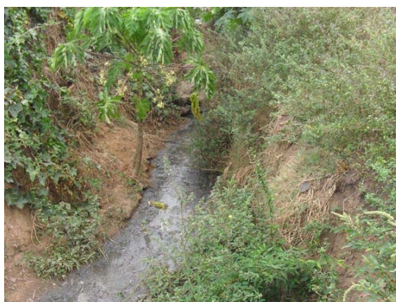
Foto 12: Ponto de lançamento final (drenagem + esgoto) – tubo de concreto DN 600 mm semi-enterrado escoando através de vala a céu aberto até o Rio Inhambupe.
