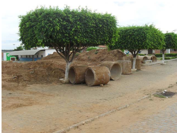
Foto 7: Vista do Canal da Praça da Liberdade – em construção.
