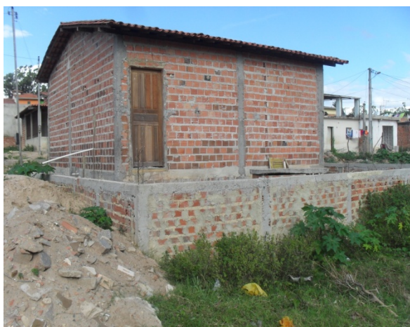
Foto 21: Loteamento duas irmãs. Área crítica por conta da ocorrência de alagamento. Área crítica 5.
