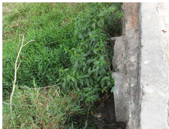
Foto 14: Ponto de lançamento de drenagem e esgoto – mostra de bueiro duplo: 02 tubos de concreto DN 600 mm – escoam através de vala sem revestimento em terreno particular até atingir o Rio Inhambupe.
