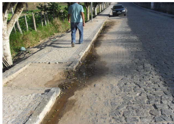
Foto 4: Rua do Hospital – lançamento de esgoto secundário a céu aberto.
