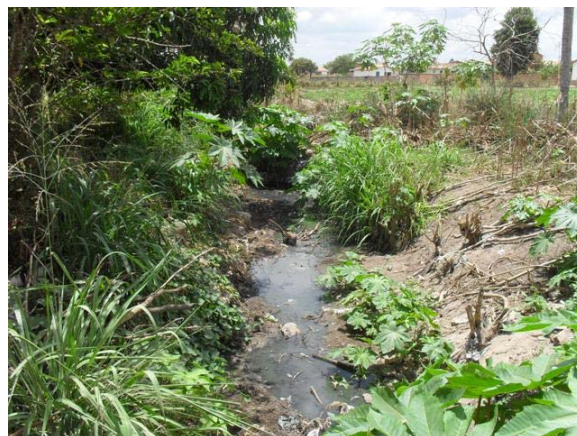
Foto 6: Ponto final de lançamento de drenagem e esgotos – tubo de concreto DN 1.000 mm – lançamento em terreno particular.
