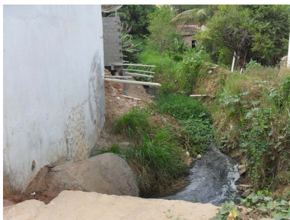
Foto 10: Rua Paraná – esgoto escoando a céu aberto por vala aberta que escoo para o Riacho. Muitas cobras, ratos, muriçocas, fortes odores e grande quantidade de lixo. Vários pontos de lançamentos de esgoto direto na vala.
