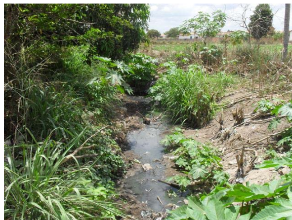
Foto 2: Ponto final de lançamento de esgotos e drenagem – tubo de concreto DN 1000 mm – lança em área particular.
