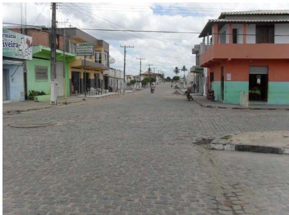
Foto 1: Área Crítica 1 – Rua Francisco Figueiras – área de enxurrada – águas atravessam as casas e atingem a Rua Marechal Dutra, Rua Juazeiro e Rua Jequié.
