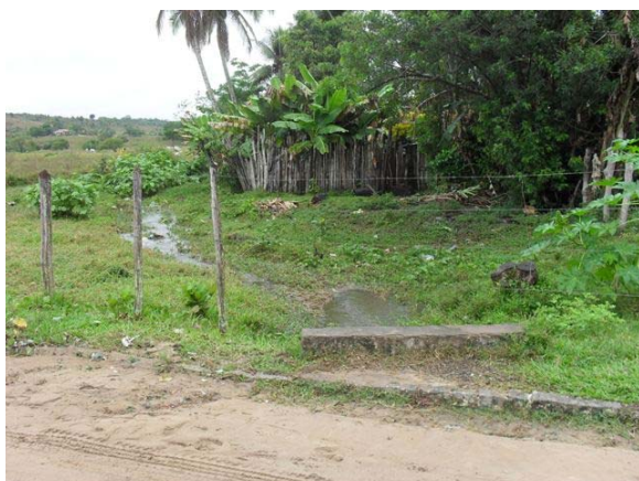
Foto 1: 2ª Travessa Enok de Carvalho - ponto de lançamento de esgotos primários e secundários difusos – terreno com valas.
