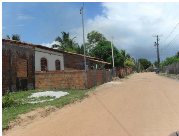
Foto 6: Casas situadas no Bairro Malvinas – área de brejo – as casas tem seus fundos voltados para o Riacho onde lançam seus esgotos.
