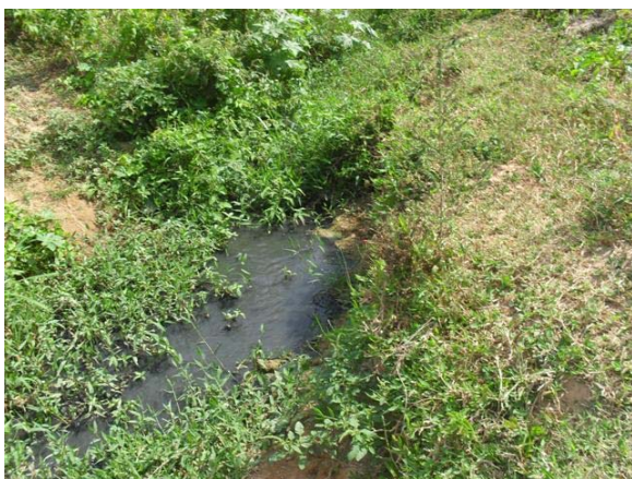
Foto 7: Ponto de lançamento de esgoto e drenagem – Canal sem revestimento e aberto até o Rio Catu - alto nível de comprometimento.
