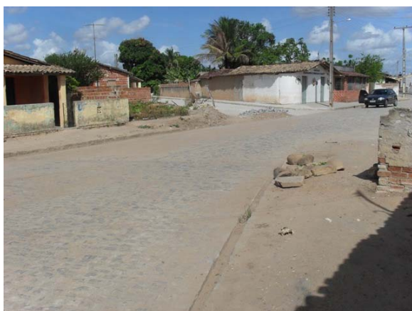
Foto 11: Área Crítica 5 – Rua Pedra Alexandrino – área de enxurrada.
