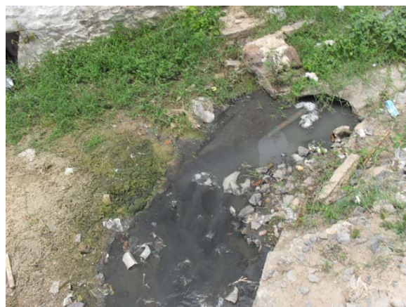
Foto 4: Ponto de lançamento de esgoto primário e secundário e drenagem – caixas e galeria da linha férrea em tubo de DN 600 mm que é reduzido para DN 400 mm – lança em terreno e escoamento em direção ao Rio Aramari.
