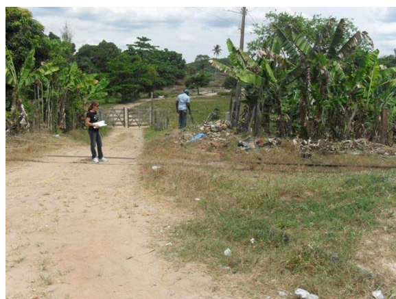
Foto 4: Ponto de lançamento de esgoto – rede de concreto DN 1000 mm – reduz para 2 de DN 300 mm – atravessa a linha férrea e lança no riacho Maleita – não tem visão do tubo – local denominado Sem Terra.
