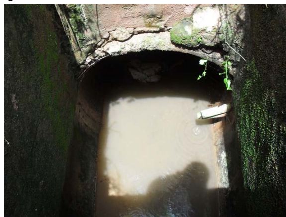
Foto 6: Canalização do Riacho Camtobá – tubo de concreto DN 1.000 com mais ou menos 320 m – caixas e caminhamento tem esgoto clandestino ligado.
