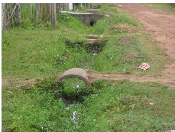
Foto 5: Vista do bueiro que atravessa a Rua Luiz Gonzaga de Lemos – tubo de concreto DN 1000 mm – recebe lançamentos de drenagem e esgotos primários e secundários – escoam em terreno com valas.
