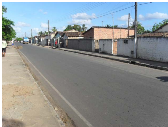
Foto 6: Área Crítica 3 – Av. Luiz Gonzaga com Travessa do Palame – drenagem existente subdimensionada e entupida – manilhas DN 300 mm.
