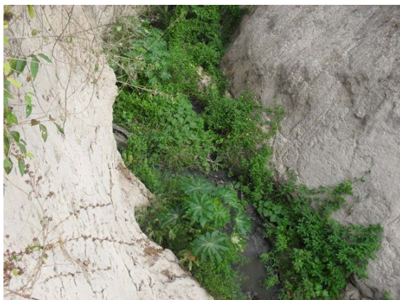
Foto 23: Estrada velha de São Miguel – ponto de saída de drenagem e esgoto – grande erosão com mais de 10 m de profundidade – segue para o Riacho rio Branco e escoá para o Riacho Riachão e Rio Una.
