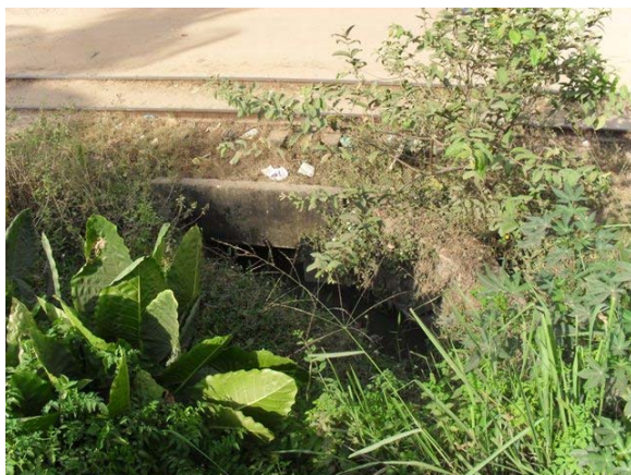
Foto 13: Ponto de lançamento de drenagem e esgoto – Rua Barão de Camaçari – mostra a rua, a saída e o bueiro lançamento seguindo no terreno a céu aberto até o Rio Catu.
