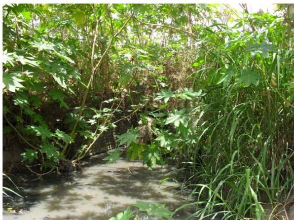
Foto 1: Ponto final de lançamento de esgotos e drenagem – tubo de concreto DN 1000 mm – lança em área particular.
