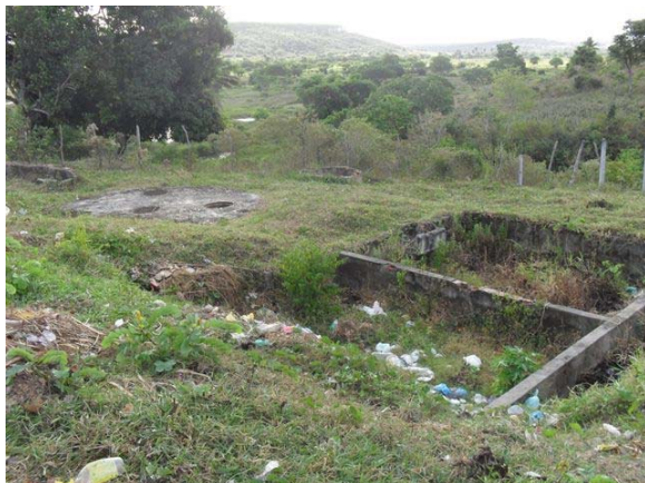
Foto 7: Bairro Beira Rio – estrutura de DAFA abandonada – nunca funcionou – tem cerca de 10 anos e foi implantada pela Urbis durante a implantação do conjunto habitacional.
