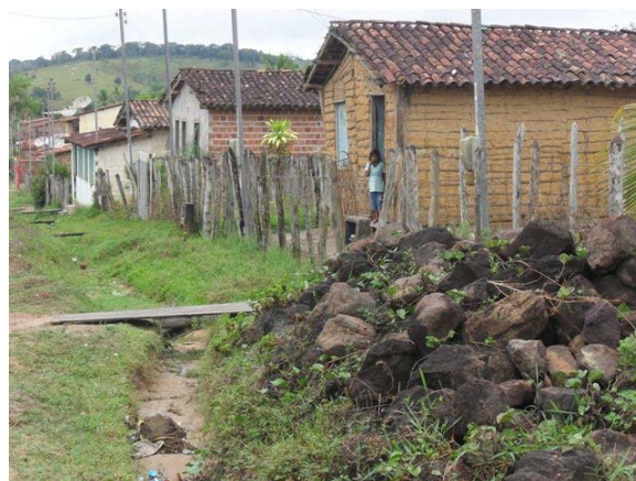
Foto 6: Bairro Nova Itanagra – ruas sem calçamento com valas sem revestimento abertas na lateral por onde escoam drenagem e esgotos.
