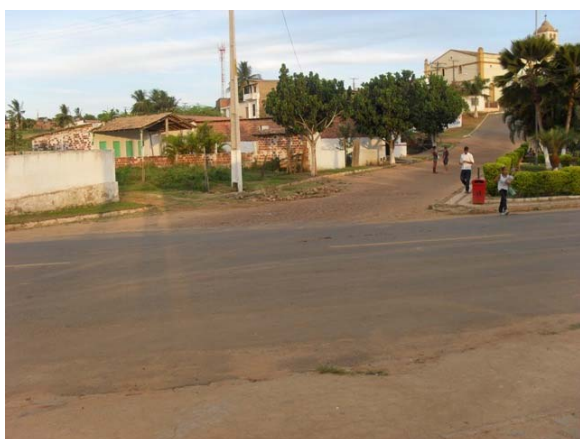
Foto 3: Área Crítica 2 – Praça Jardim do Éden – área de enxurrada.
