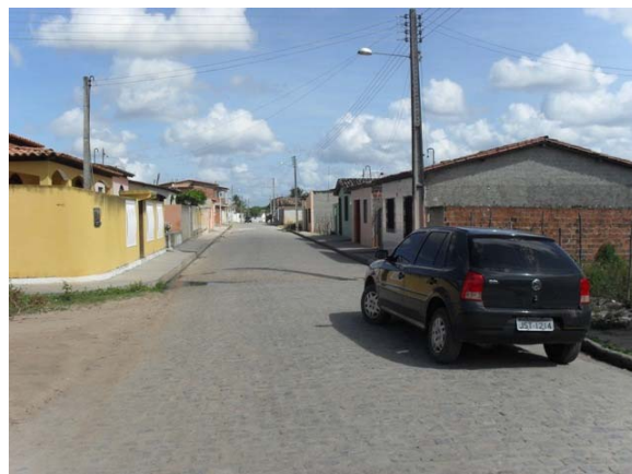
Foto 10: Área Crítica 4 – Rua José Campos da Fonseca – área de escoamento – mostra as ruas de escoamento.
