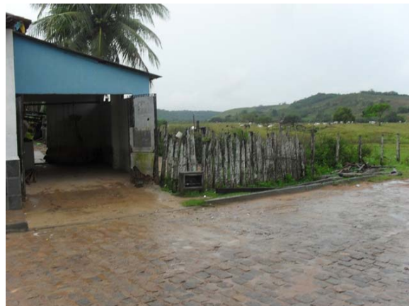
Foto 2: Área Crítica 1 – Rua Belmiro Souza Gomes e Travessa Enok de carvalho – área de enchente e inundação ribeirinha.
