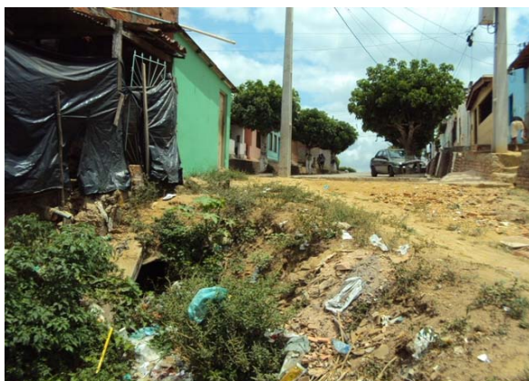
Foto 3: Ponto de lançamento de esgoto secundário – tubo PVC DN 150 mm – escoamento a céu aberto pela encosta.
