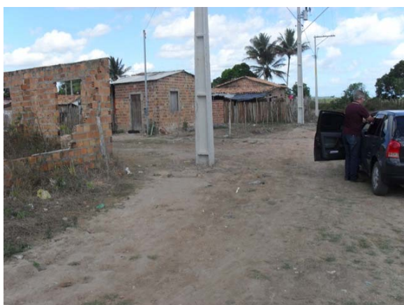
Foto 3: Área Crítica 2 – Rua da Estiva (final da Rua João Rodrigues de Carvalho) – área de enxurrada.
