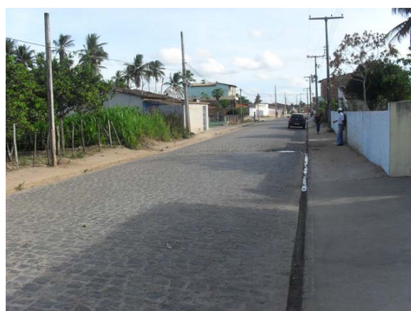
Foto 14: Área Crítica 7 – Rua Joaquim Matos – área de enxurrada – mostra esgotos a céu aberto.
