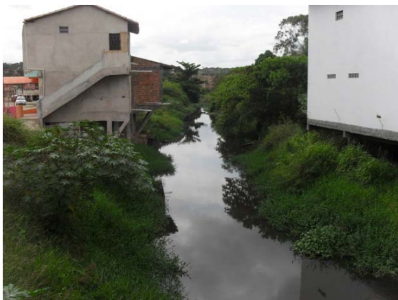
Foto 5: Pontos de lançamento de esgoto direto no Rio Catu – a montante da ponte.
