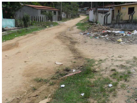
Foto 14: Esgoto a céu aberto no Bairro Alto do Cruzeiro – rua sem pavimentação e com erosão.
