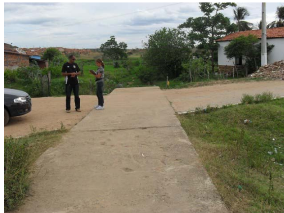
Foto 8: Ponto de lançamento final da galeria de DN 600 mm – termina em Canal coberto na Rua Nova Paraíba (seção 2,0 x 1,0 m).
