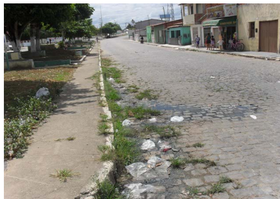
Foto 2: Av. Honório Borges – esgoto a céu aberto e lixo.
