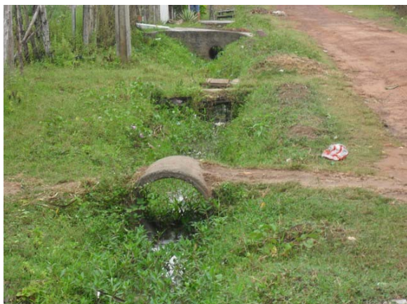
Foto 5: Bairro Nova Itanagra – ruas sem calçamento com valas sem revestimento abertas na lateral por onde escoam águas pluviais e esgoto.
