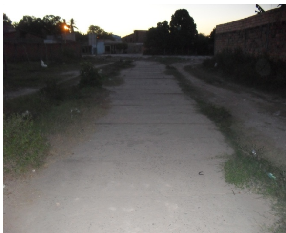
Foto 32: Trecho do canal de macrodrenagem em galeria retangular enterrada da obra em execução próximo à Estação ferroviária de Alagoinhas
