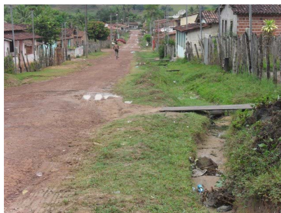
Foto 2: Bairro Nova Itanagra – ruas sem calçamento com valas sem revestimento abertas na lateral por onde escoam águas pluviais e esgoto.
