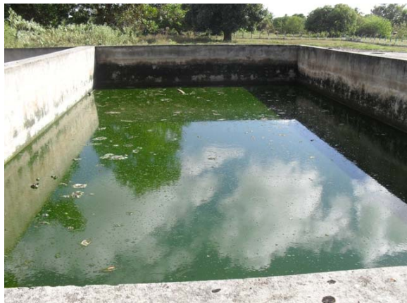
Foto 20: ETE Petrolar – leito de secagem desativado.
