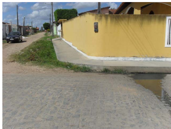
Foto 4: Rua do Loteamento Primavera como Rua José Campo das Fonseca – mostrando o esgoto correndo a céu aberto – desce para área particular pelos quintais das casas – cerca de 600 m até a rede de manilha.
