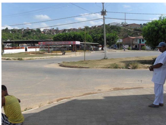
Foto 27: Área Crítica 2 – Rua Armando Ferreira com a Rua Paraná – área de enxurrada – mostra a praça, a linha férrea e a encosta ao fundo.
