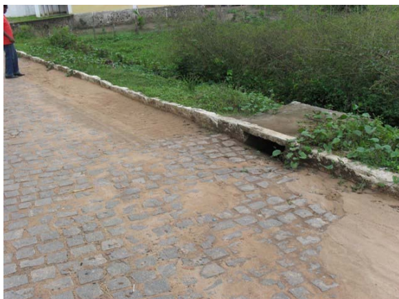
Foto 9: Ponto de lançamento de drenagem e esgoto secundário – Rua Padre Luiz Palmeira – caminhamento apenas nesta rua em tubo de concreto DN 400 mm.
