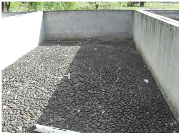
Foto 19: ETE Petrolar – leito de secagem desativado.
