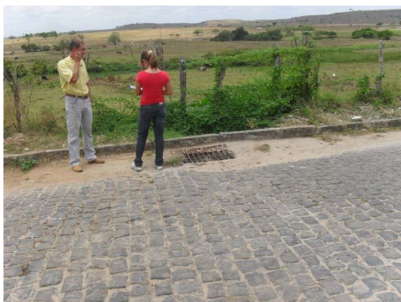
Foto 9: Ponto final de lançamento de drenagem e esgoto – mostra a caixa de drenagem com algum lixo – tubo de concreto DN 300 mm – lança em terreno, vala, e escoar para o Rio Inhambupe.
