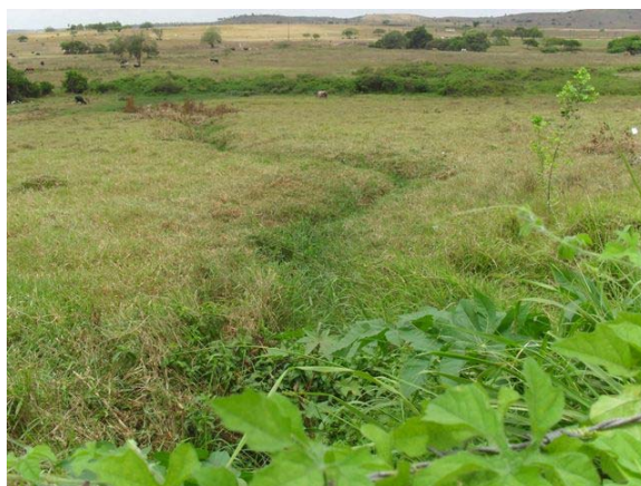
Foto 10: Ponto final de lançamento de drenagem e esgoto – mostra a caixa de drenagem com algum lixo – tubo de concreto DN 300 mm – lança em terreno, vala, e escoar para o Rio Inhambupe.
