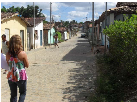
Foto 3: Área crítica 2 – Rua da Bica – área de enxurrada.
