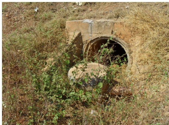
Foto 8: Bueiro de travessia situado próximo a lagoa que facilita o escoamento das águas pluviais através da BA-156.
