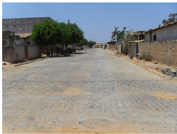
Foto 4: Rua com a rede coletora e as ligações domiciliares já executadas e o pavimento já reconstituído.
