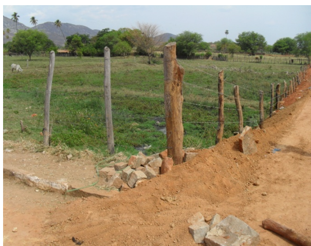
Foto 6: Pontos de lançamento de esgoto sanitário em frente a Rua Capitão Antônio R. de Magalhães.
