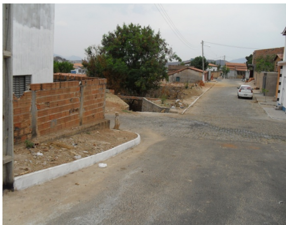
Foto 10: Rua Trajano Santana. Após cruzar algumas propriedades particulares as águas do Riacho Coité passam por cima das ruas e novamente são canalizadas.
