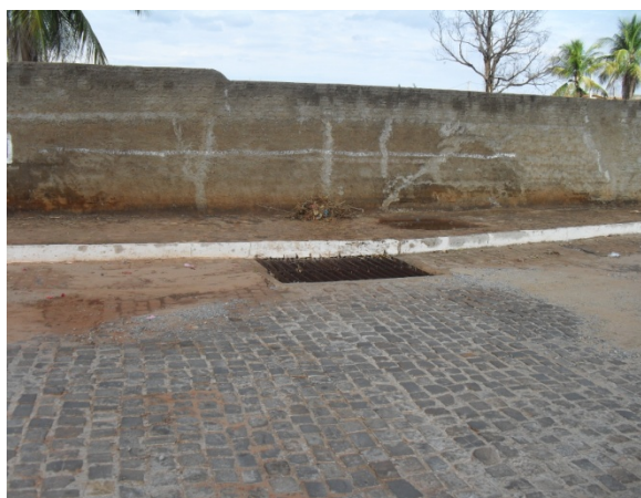
Foto 9: Após seguir trecho paralelo a Rua Professor Luiz Rogério, o canal cruza a rua e passa por debaixo do muro de um terreno particular. Este é o último ponto de coleta de águas pluviais antes de o canal desembocar as águas a céu aberto no terreno natural.
