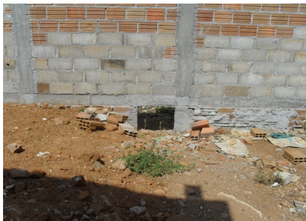
Foto 5: Passagem de água por entre o muro de uma residência deixada para que as águas escoem naturalmente no terreno e não acumulem na área.
