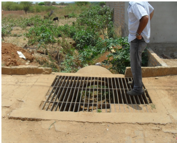
Foto 5: Ponto de lançamento final da galeria circular de macrodrenagem. Avenida Leopoldo Leão.
