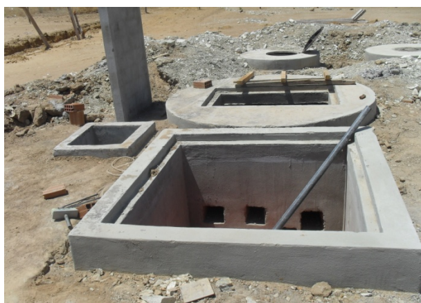
Foto 5: Estação Elevatória de Esgoto próxima à saída da cidade sentido Paramirim. EEE pertencente ao novo SES ainda em fase de implantação.
