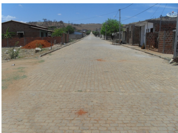
Foto 10: Área Crítica 3 - Rua Brasiliano Marques França. Área crítica por conta da ocorrência de alagamento.
