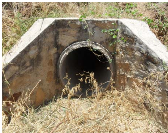
Foto 2: Final da galeria de drenagem que se inicia no cruzamento das ruas Deputado Henrique Brito com e Henrique Cruzes e desemboca no córrego. Diâmetro 1000 mm.
