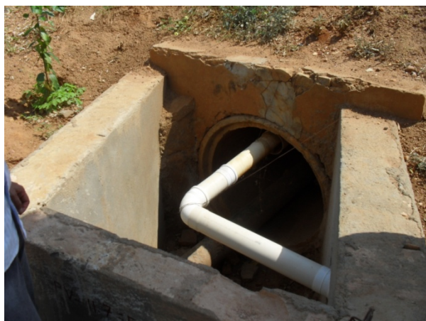
Foto 3: Saída do bueiro de passagem de águas pluviais oriundas da região da rodoviária. Tubulação de esgoto aproveitando o bueiro existente para atravessar a pista.
