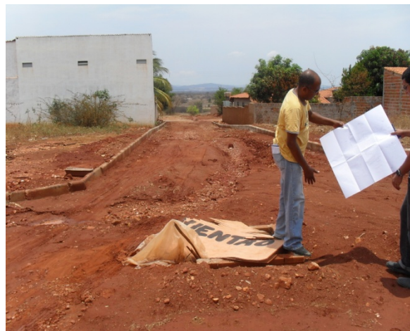
Foto 2: Vista da outra rua que também foi contemplada pela obra de pavimentação e drenagem custeada com recurso federal.
