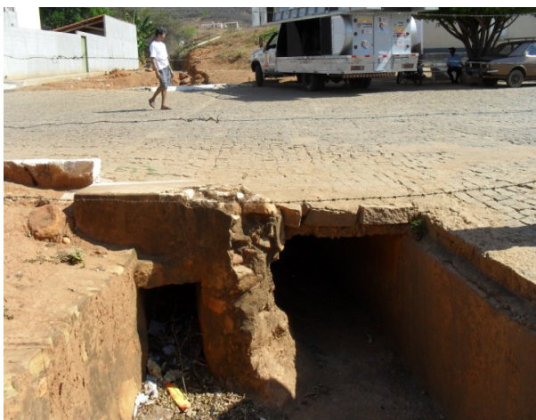
Foto 7: Avenida Barra. Travessia das águas do riacho em galeria retangular. Seção 0,8m X 1m.
