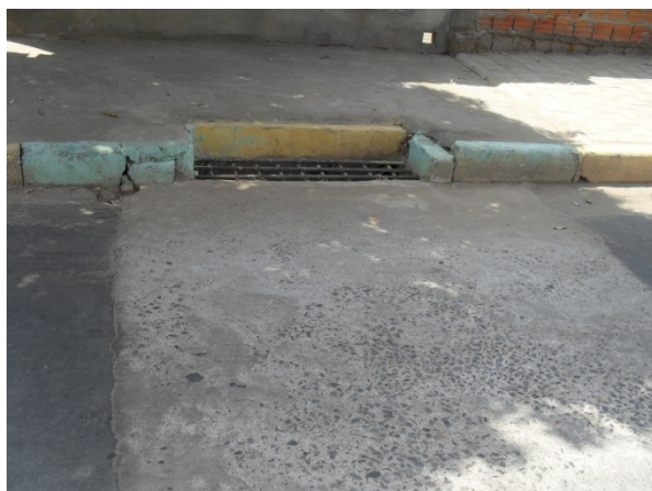
Foto 4: Avenida Ambrósio. Dispositivos de coleta superficial da galeria mista de macrodrenagem.
