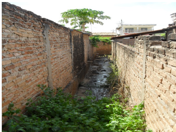
Foto 6: Trecho em aberto do canal misto de macrodrenagem que passa entre as residências da Rua Cláudio Pina.
