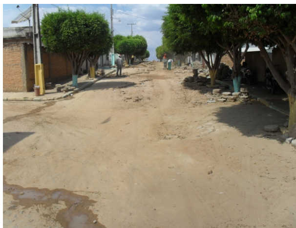
Foto 3: Rua José Joaquim Souza. Obra do novo sistema de esgotamento sanitário em andamento. Assentamento da rede coletora e fechamento das valas.
