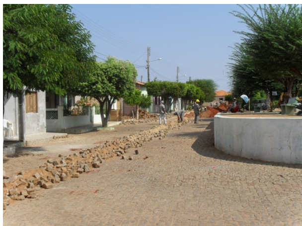
Foto 7: Obra em andamento. Abertura de valas e assentamento da tubulação do novo SES que está sendo implantado com a fiscalização da CODEVASF.
