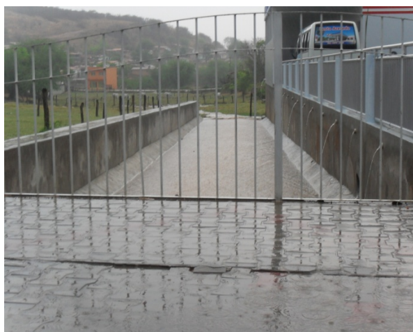
Foto 3: Trecho canalizado recentemente construído para facilitar o escoamento das águas na região onde ocorre o alagamento na avenida flores. Seção retangular de 6m X 1,6m e extensão aproximada de 60m.
