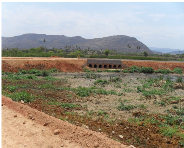
Foto 7: Bueiros de travessia na região próxima a Lagoa de Paramirim. Obra de revitalização do local.
