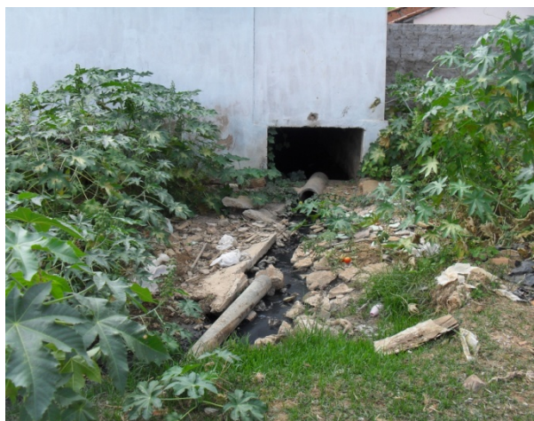
Foto 8: Rua das Comunicações. Ponto final de lançamento do canal misto de macrodrenagem.
