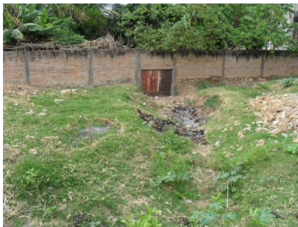
Foto 17: Riacho Boqueirão. Após trecho em canal aberto que passa dentro de terreno particular com parede revestida de concreto, o canal de macrodrenagem segue em um trecho sem revestimento.
