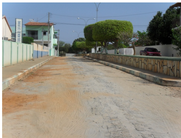
Foto 8: Rede coletora de esgoto sanitário e ligações domiciliares do novo SES em implantação já executadas. Rua em frente a prefeitura.
