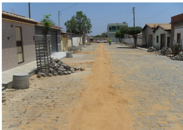
Foto 5: Rua com a pavimentação removida e com as caixas domiciliares prontas para serem implantadas.
