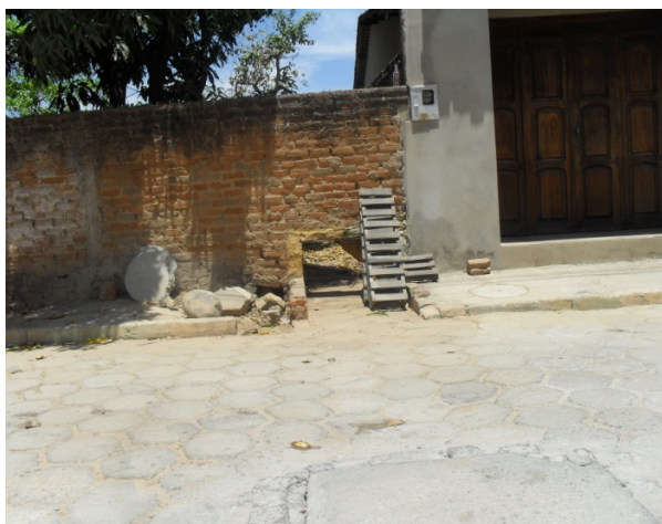
Foto 8: Saída da passagem de água tipo Canal na Rua Nelson de Castro.
