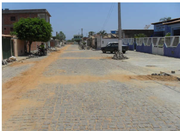
Foto 3: Rua Câmara dos Vereadores - rede coletora e ligações domiciliares já executadas. Fase de compactação e recolocação do pavimento.
