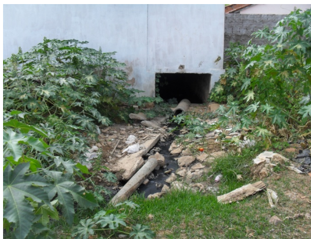
Foto 4: Rua das Comunicações. Ponto de lançamento final de águas pluviais e esgotos sanitários através do canal misto de macrodrenagem.
