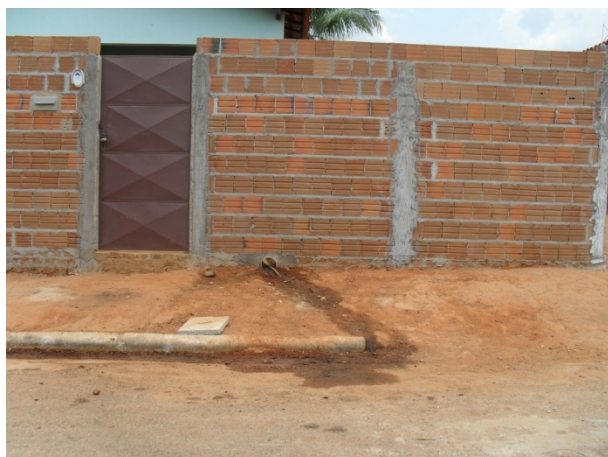
Foto 3: Esgoto secundário a céu aberto na principal área de expansão da sede do município.
