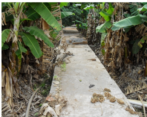
Foto 15: Riacho Boqueirão. Trecho do canal de macrodrenagem em galeria enterrada de seção retangular que passa em terreno particular.
