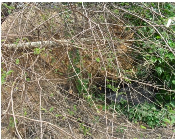
Foto 7: Flávio Barbosa (Coladinho). Ponto de lançamento de esgoto sanitário.
