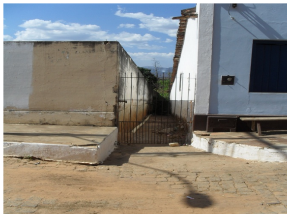
Foto 4: Área Crítica 2 - Rua Deputado Horácio. Passagem de água na região mais baixa da rua.
