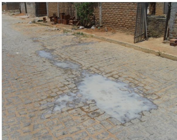
Foto 1: Avenida Professor João Neves de Oliveira. Esgoto secundário a céu aberto.
