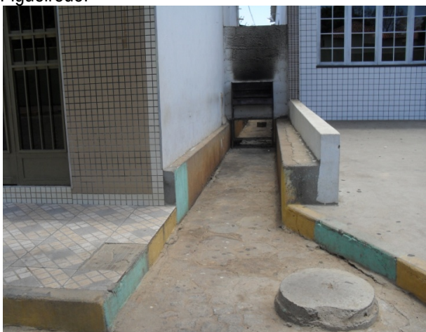
Foto 5: Estrutura de concreto similar a um Canal que realiza a passagem das águas superficiais da Rua Maurina J. Castro para a Avenida Deputado João de Figueiredo.
