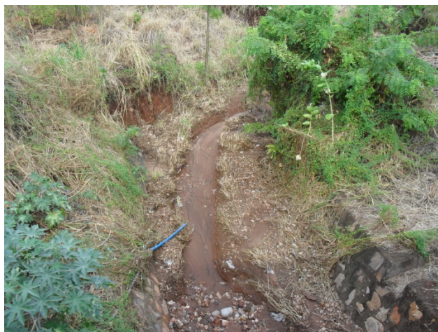
Foto 3: Um curto trecho do canal de macrodrenagem que volta a ser aberto ao passar dentro de uma residência e segue em leito natural por um grande trecho.
