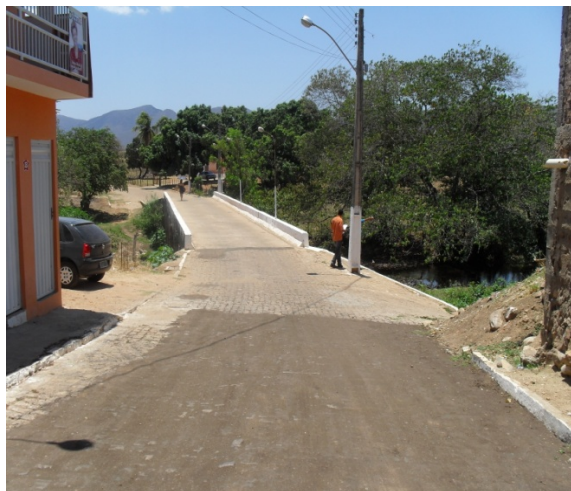
Foto 2: Área Crítica 3 - vista de outro ângulo do trecho final da Avenida Paramirim.
