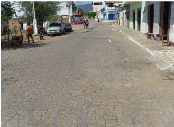
Foto 5: Área Crítica 1 - Avenida Paramirim. Área crítica por conta da ocorrência de chuvas de enxurrada.
