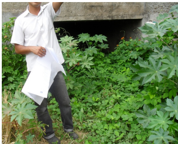
Foto 5: Riacho do Coité. Trecho canalizado do canal de macrodrenagem que passa debaixo de uma escola.
