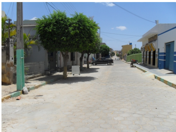
Foto 6: Área Crítica 2 - Avenida Paramirim. Área crítica por conta da ocorrência de enxurrada.
