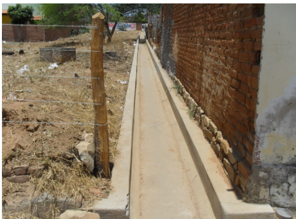
Foto 5: Estrutura de concreto similar a um Canal que realiza a passagem das águas superficiais da Rua Maurina J. Castro para a Avenida Deputado João de Figueiredo.
