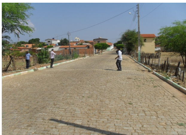
Foto 9: Área Crítica 1 - Rua da Usina. Área crítica devido a ocorrência de alagamento.
