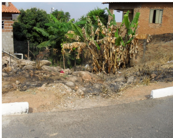
Foto 13: Riacho Boqueirão. Início do canal de macrodrenagem em leito natural na Rua Antônio Alfredo S. Filho.
