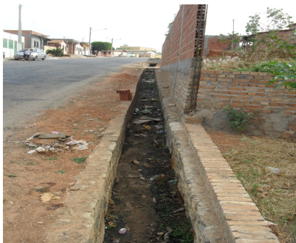
Foto 1: Valeta construída pelo DERBA para realizar a drenagem da rodovia. Seção 50 cm x 50 cm.
