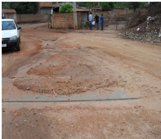
Foto 2: Trecho do canal de macrodrenagem de seção trapezoidal e revestido em alvenaria de pedra coberto por lajes de concreto.
