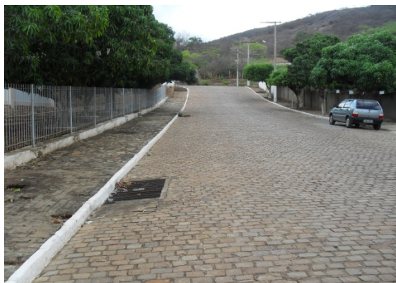
Foto 6: Rua José Lins da Costa. Curto trecho da rede de microdrenagem
