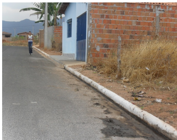
Foto 4: Esgoto secundário sendo lançado a céu aberto.
