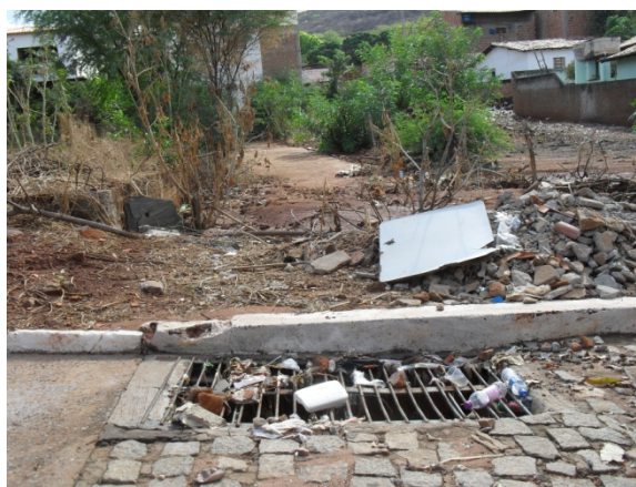
Foto 8: Canal enterrado segue trecho paralelo a Rua Professor Luiz Rogério – trecho antes de cruzar a rua.
