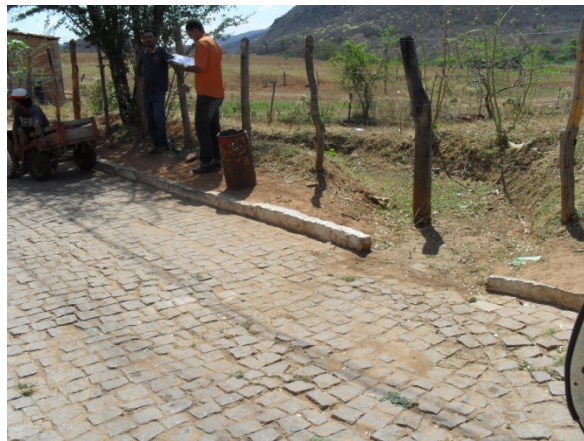
Foto 6: Área Crítica 1 - Avenida Paramirim. Passagem de água situada na região da área crítica.
