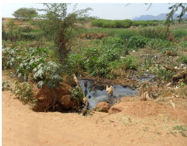
Foto 5: Rua Joaquim Manoel Pereira. Ponto de lançamento de esgoto sanitário.
