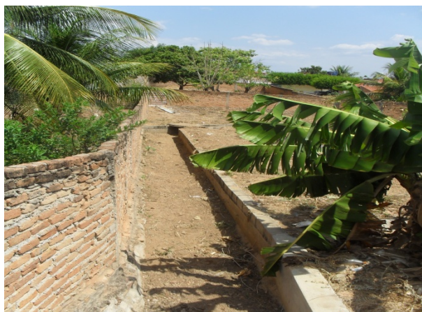
Foto 3: Trecho aberto da galeria mista de macrodrenagem que se inicia na Avenida Ambrósio Domingues Amaral e passa por dentro de residências da Rua Manoel Nicolau da Silva.
