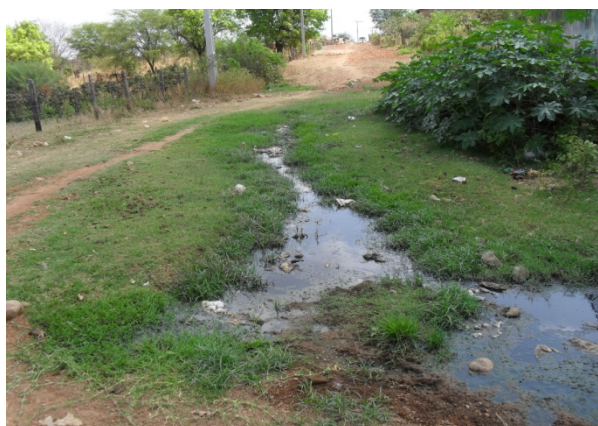
Foto 5: Rua das Comunicações. Esgoto sanitário escoando a céu aberto após ser lançado pelo canal misto de macrodrenagem.
