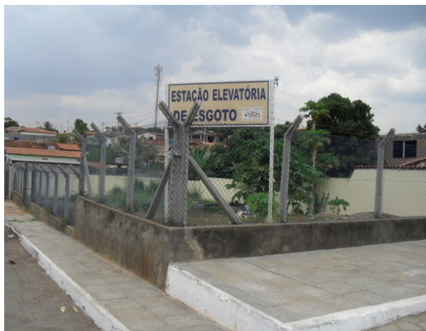
Foto 1: Estação Elevatória de Esgoto. Localizada à margem da principal via de acesso da cidade.
