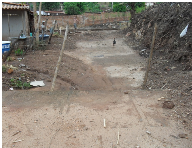
Foto 1: Início do canal de macrodrenagem próximo a estrada para Mosquito. Trecho inicial em seção trapezoidal em alvenaria de pedra aberto.
