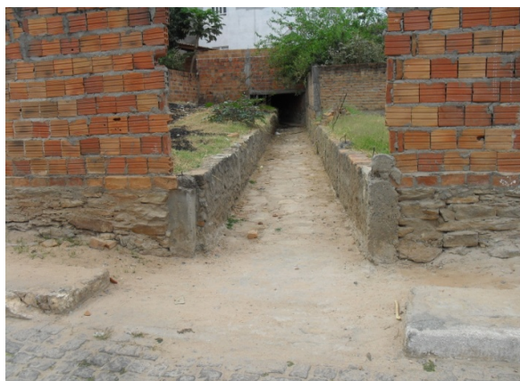
Foto 11: Construções feitas ao longo do caminho natural do Riacho Coité, tem sua base acima de um determinado nível para conservar o local de passagem das águas pluviais.
