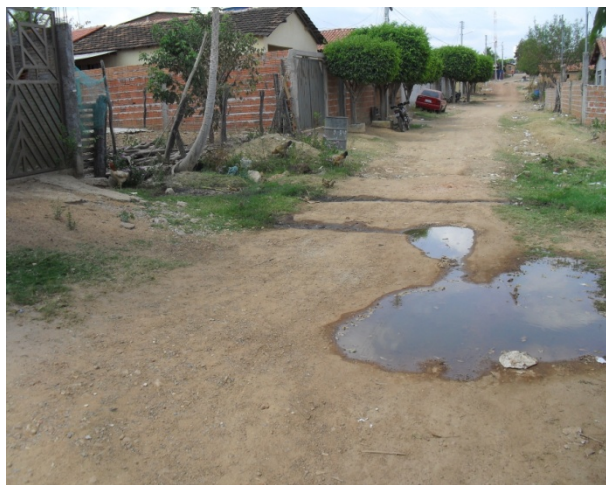
Foto 1: Rua Elisa Maria de Oliveira. Esgoto secundário a céu aberto.
