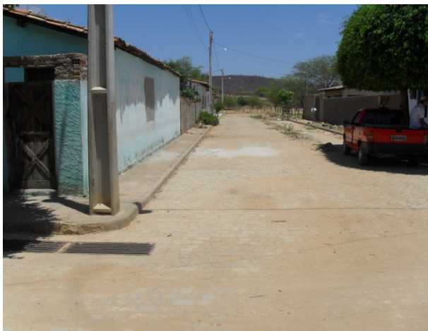
Foto 1: Início da galeria de drenagem no cruzamento das Ruas Deputado Henrique Brito com e Henrique Cruzes.
