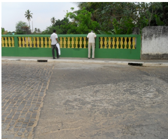
Foto 6: Riacho do Coité. Trecho em galeria retangular enterrada que atravessa a Rua Senhor do Bonfim.
