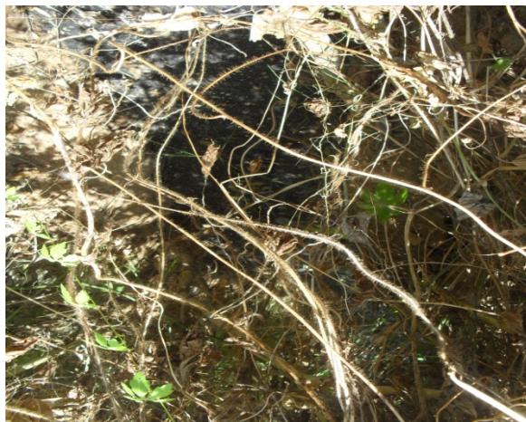
Foto 2: Lançamento de esgotos sanitários e águas pluviais da galeria mista de macrodrenagem que começa na avenida Ambrósio Domingues Amaral e lança no terreno natural.
