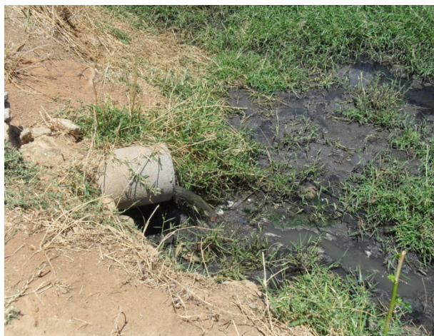
Foto 1: Ponto de lançamento do efluente final que sai da unidade de tratamento.
