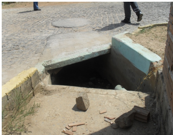
Foto 1: Trecho final da galeria mista de macrodrenagem que se inicia na avenida Ambrósio Domingues Amaral.
