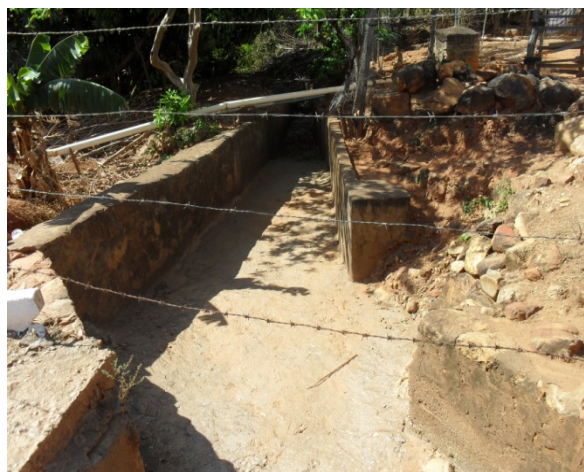
Foto 8: Avenida Barra. Vista de outro ângulo da travessia das águas do riacho em galeria retangular. Seção 0,8m X 1m.
