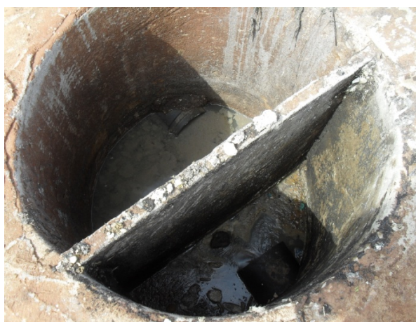
Foto 3: Poço de visita aberto da Estação de Tratamento de Esgoto.
