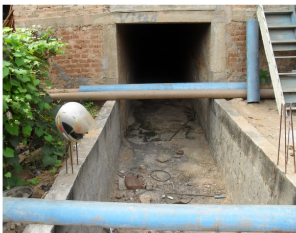
Foto 16: Riacho Boqueirão. Trecho do canal de macrodrenagem em canal aberto de seção retangular que passa debaixo de uma residência da Travessa Bela Vista I.
