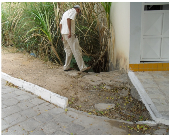
Foto 14: Rua dos Ex-combatentes. Após cruzar a pista, as águas do Riacho Boqueirão seguem em leito natural por entre as casas.
