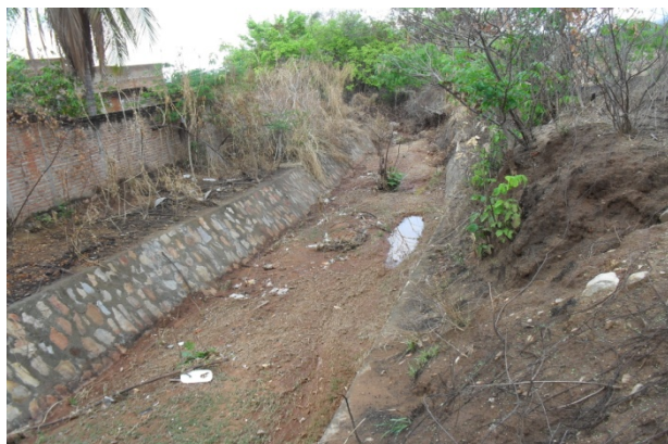
Foto 5: Após uma sequência alternada de trechos cobertos e abertos o canal de macrodrenagem encerra aberto com base média de 6m e altura de 2,5m.
