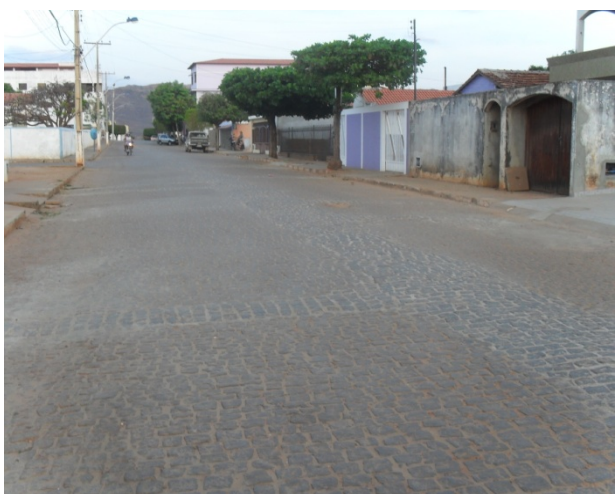
Foto 11: Avenida Botuporã. Rede coletora de esgotamento sanitário e ligações domiciliares do novo SES já implantadas.
