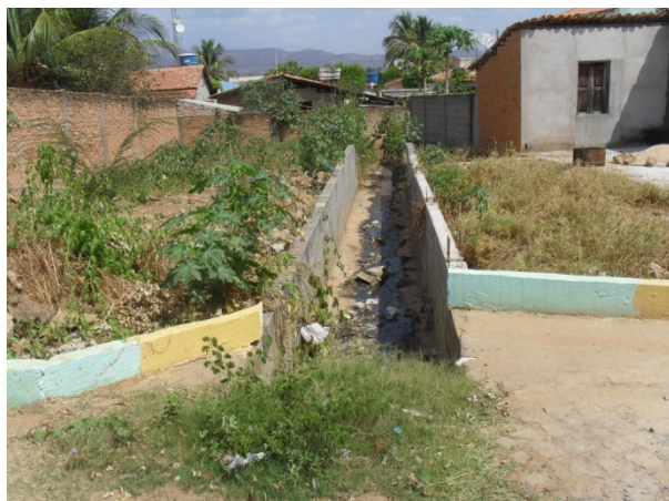
Foto 5: Início do canal misto de macrodrenagem que se inicia em trecho aberto na Rua José Joaquim de Souza. Seção retangular de 1,35m x 1,20.
