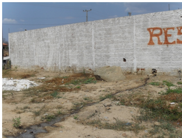
Foto 6: Esgoto de fossa sendo lançado a céu aberto próximo ao restaurante a beira da pista
