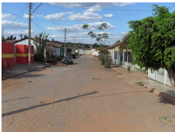
Foto 1: Área Crítica 1 – Rua Castro Alves – ocorrência de enxurradas.
