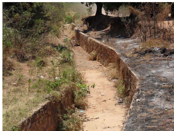
Foto 8: Riacho Brejo Grande – trecho revestido com alvenaria de pedra.
