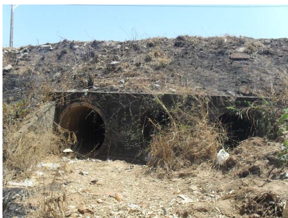
Foto 9: Córrego Natural e bueiro sob a BR-242.
