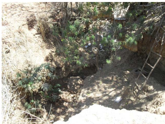
Foto 8: Área de erosão.
