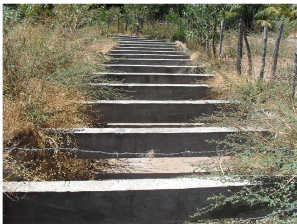
Foto 5: Drenagem – Praça São José.
