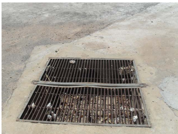
Foto 3: Caixa de tomada d'água – Praça São José.
