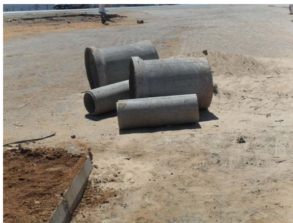
Foto 2: Implantação de pavimentação e drenagem – Rua São José.
