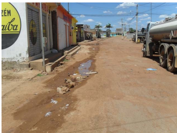
Foto 3: Esgoto secundário lançado a céu aberto na Rua Manoel Remigio – próximo do Açude Municipal.
