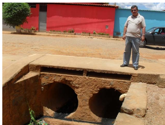
Foto 6: Travessia Claudino Barreto – início do trecho canalizado do Córrego.
