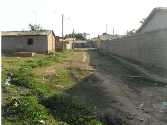
Foto 38: Área Crítica 6 – área de enxurrada - Bairro Santa Luzia.
