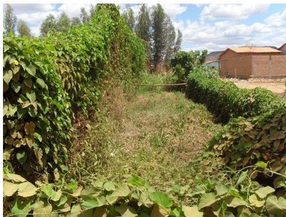
Foto 4: Rua Santa Cruz – lançamento de esgoto secundário a céu aberto.
