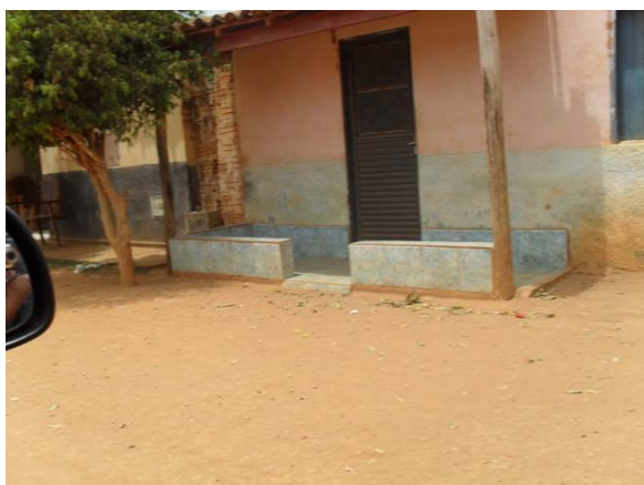
Foto 5: Área Crítica 1 – área de alagamento – Bairro Projetado.
