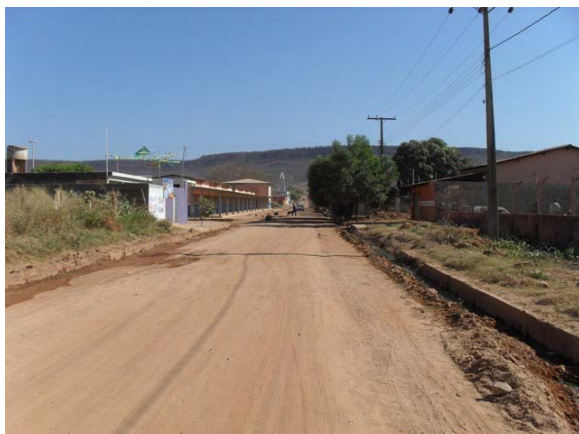
Foto 25: Área Crítica 1 – local de alagamento - Bairro Vila Rica - próximo a BR-020.
