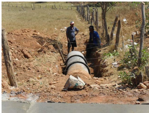
Foto 6: Implantação de pavimentação e drenagem – Rua São José.
