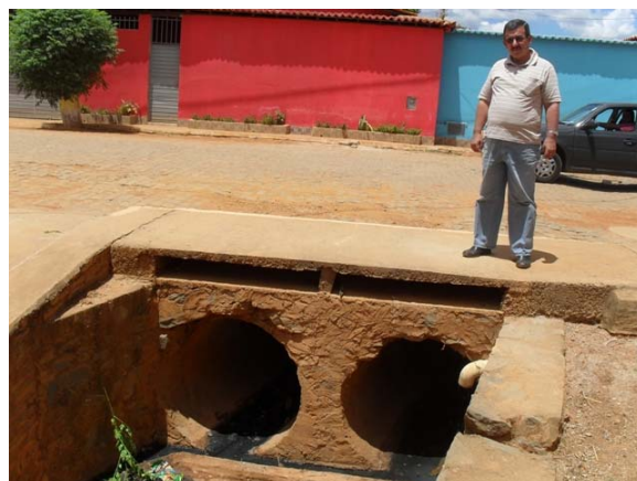
Foto 6: Travessia Claudino Barreto – início do trecho canalizado do Córrego.
