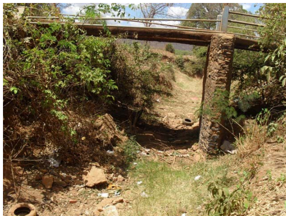
Foto 14: Riacho São Teodoro – Lançamento no Rio Tijucuçu – área alagável intermitente.
