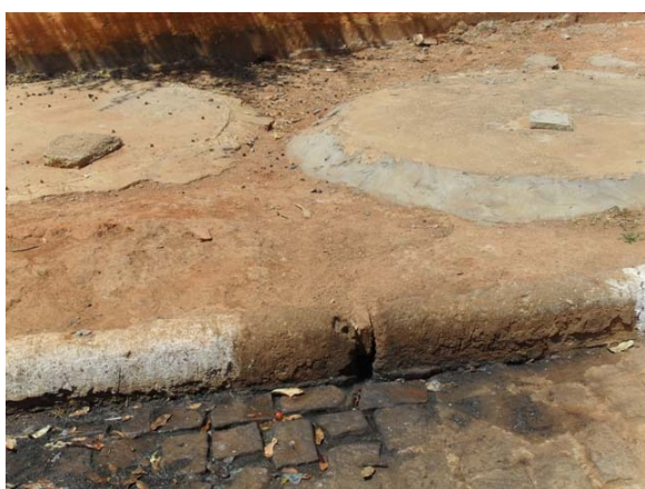
Foto 5: Fossas sépticas construídas nos passeios – Travessa Major Claro 1 e 2.
