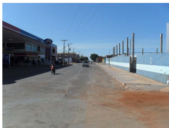
Foto 6: Área Crítica 3 – área de alagamento entre a Rua Senhor do Bonfim e a Rua Paraíba.
