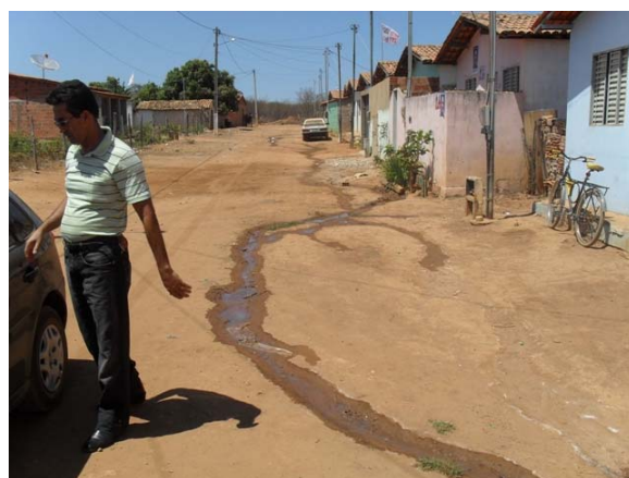
Foto 10: Esgoto a céu aberto – Casas Populares.
