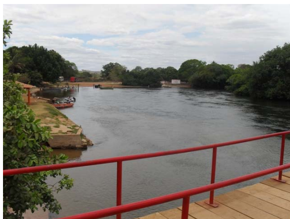
Foto 10: Rio Preto – área de lançamento da drenagem da Rua Abaré.
