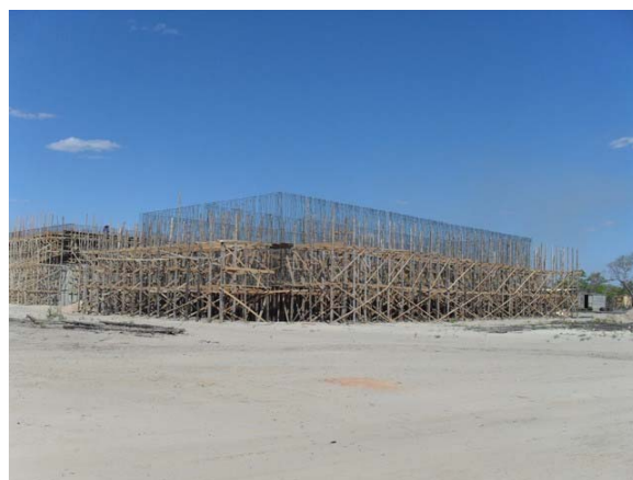
Foto 4: ETE em construção.
