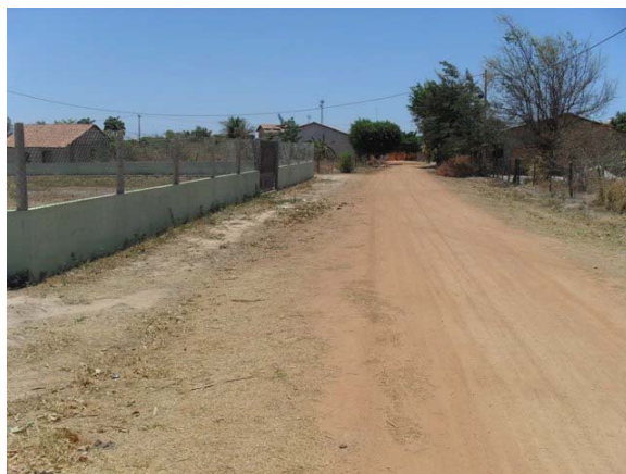
Foto 8: Área crítica 3 – Rua Gerolino Antunes de Carvalho – incidência de alagamentos.
