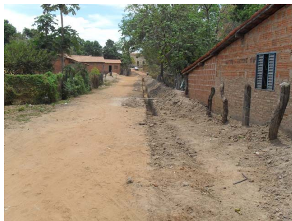
Foto 4: Implantação de rede de esgoto – Rua Joaquim Augusto da Silva.
