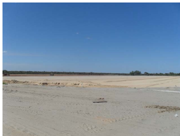
Foto 6: ETE em construção.
