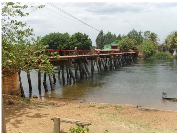
Foto 9: Rio Preto – área de lançamento da drenagem da Rua Abaré.
