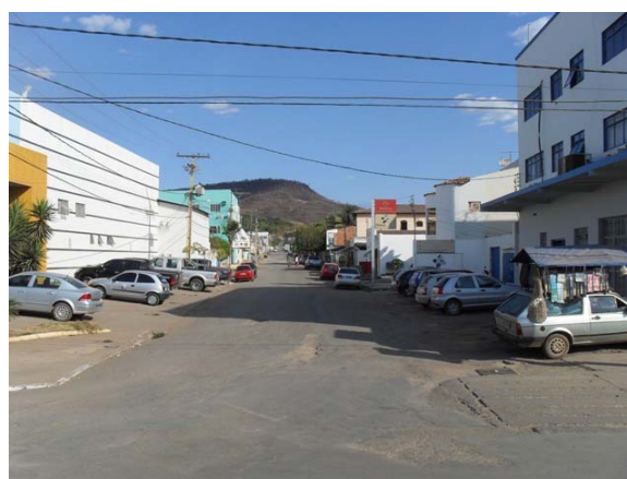
Foto 28: Área Crítica 3 – área de alagamento - Av. Antônio Carlos Magalhães - início do Canal da Vila Dulce.
