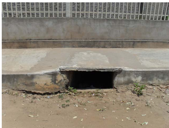
Foto 2: Rua 2 de Julho – boca de lobo na entrada do Canal.
