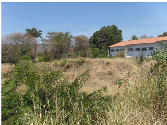
Foto 3: Ponte BR-135 – Leito do Riacho das Neves – ponto de erosão.
