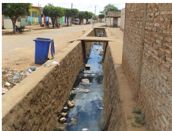
Foto 10: Travessia Rua Alcides R. Delgado – DN 1000 + trecho em alvenaria de pedra.
