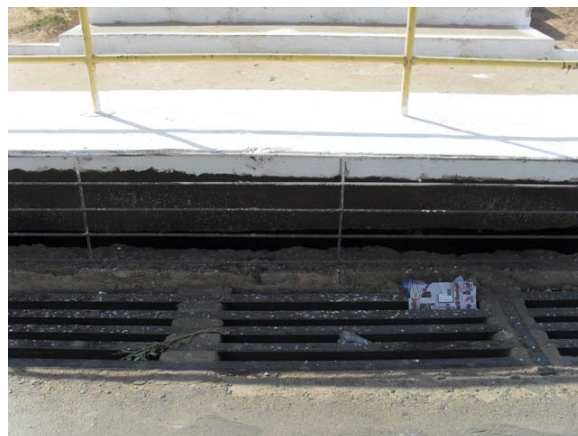
Foto 20: Tomada d'água para o canal Vila Dulce.
