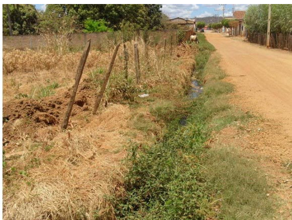
Foto 5: Rua Santa Cruz – lançamento de esgoto secundário a céu aberto.
