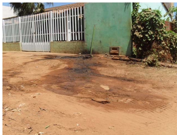
Foto 2: Esgoto secundário lançado a céu aberto.
