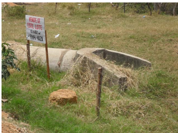
Foto 7: Lançamento da rede de drenagem de diâmetro 1000mm – Rua Abaré.
