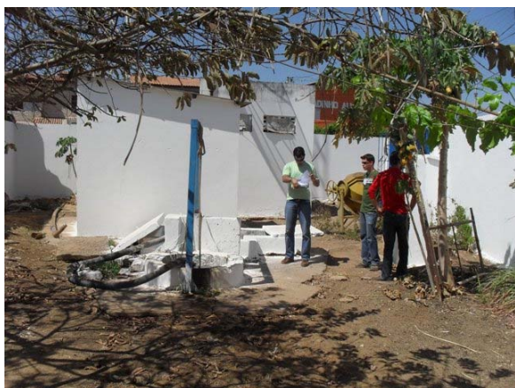
Foto 5: Estação Elevatória - Ribeirão.
