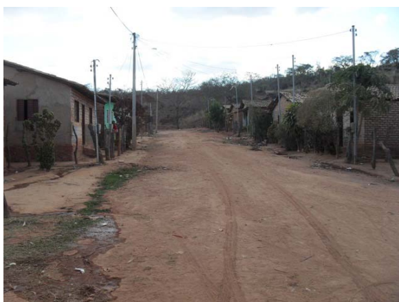
Foto 3: Área Crítica 2 – Bairro Santana – enxurrada.
