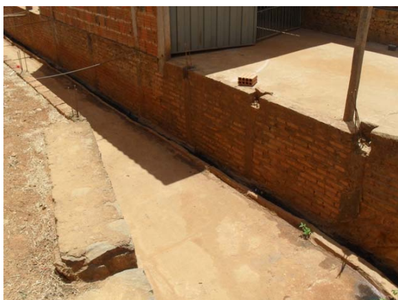
Foto 5: Travessia Claudino Barreto – início do trecho canalizado do Córrego.
