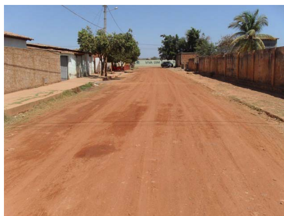
Foto 30: Área Crítica 4 – área de alagamento - Loteamento São Paulo - Rua Uberaba.
