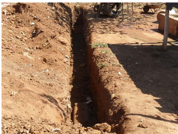
Foto 3: Implantação de pavimentação e drenagem – Rua São José.
