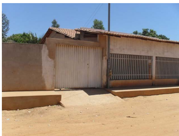
Foto 6: Área Crítica 2 – Rua Jorge Amado – área de alagamento – construções de casas com sarjetas altas e portas com proteção contra a invasão das águas.
