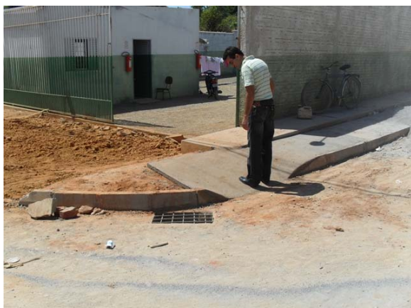
Foto 7: Implantação de pavimentação e drenagem – Rua São José.
