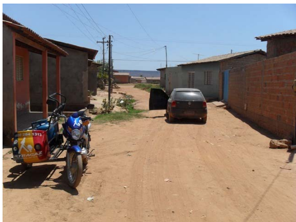
Foto 44: Área Crítica 8 – área de alagamento - Bairro Boa Sorte - Rua F.
