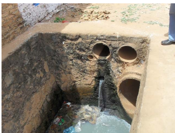
Foto 9: Travessia Rua Alcides R. Delgado – DN 1000 e trecho em alvenaria de pedra.
