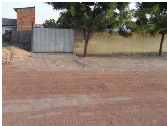
Foto 4: Área crítica 2 – área de alagamento entre a Rua Paraíba e a Rua Manoel Novaes.
