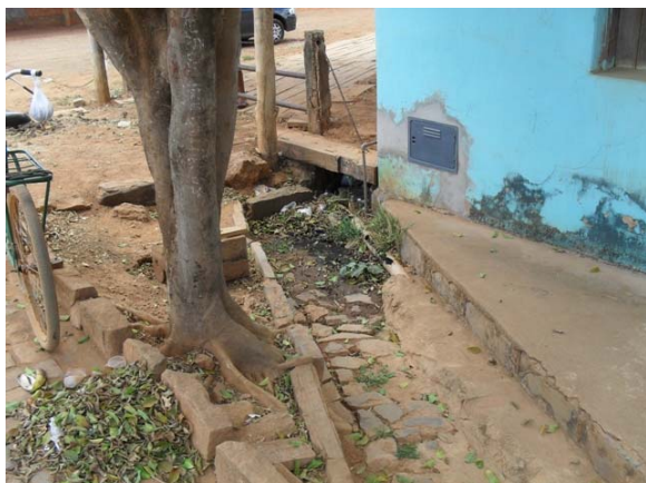
Foto 7: Rua Antônio Inácio – Posto de lavagem de carros – esgoto secundário com canalização de alvenaria de pedra.
