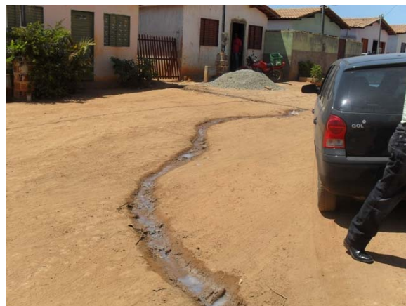
Foto 8: Esgoto a céu aberto – Casas Populares.
