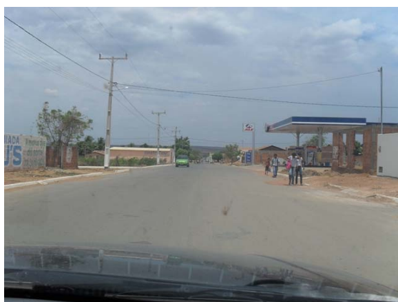
Foto 12: Área Crítica 2 – Loteamento JK.
