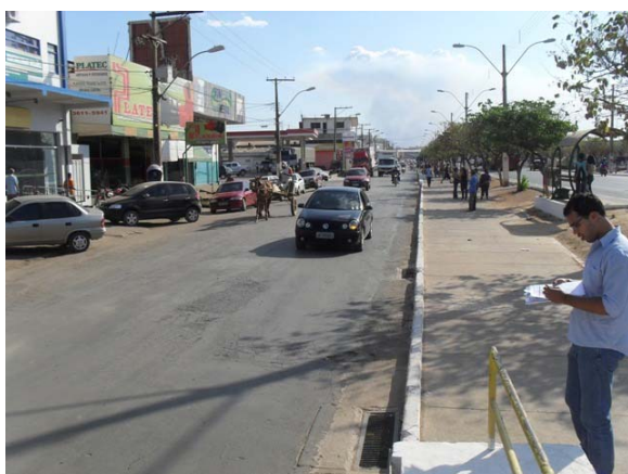
Foto 29: Área Crítica 3 – área de alagamento - Av. Antônio Carlos Magalhães - início do Canal da Vila Dulce.
