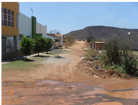
Foto 34: Área Crítica 5 – área de alagamento - Bairro Aratu - Rua Ruy Barbosa.
