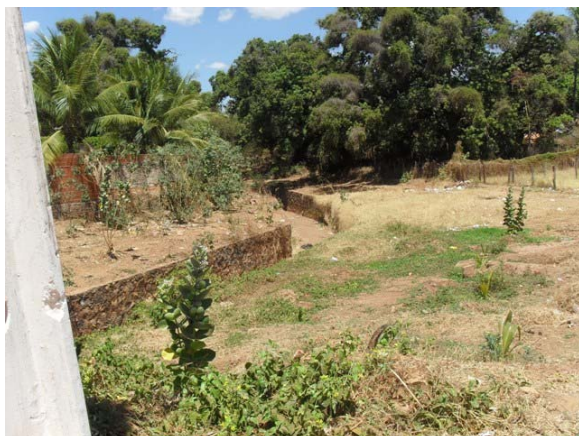
Foto 7: Riacho Brejo Grande – trecho revestido com alvenaria de pedra.
