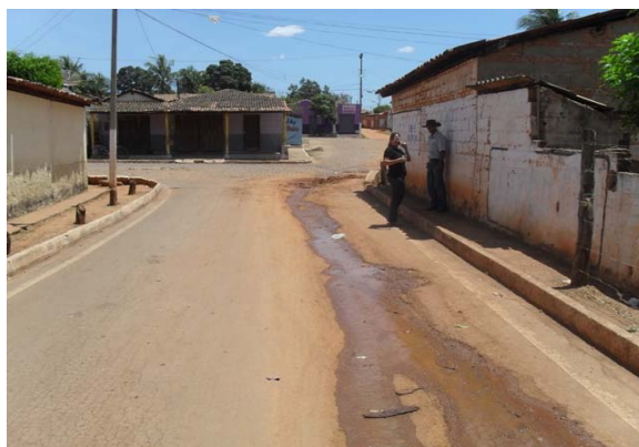
Foto 4: Rua Sete de Setembro – esgoto secundário lançado a céu aberto.
