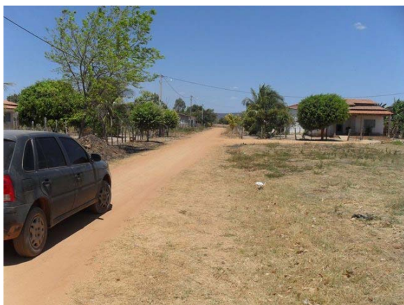
Foto 9: Área crítica 3 – Rua Gerolino Antunes de Carvalho – incidência de alagamentos.
