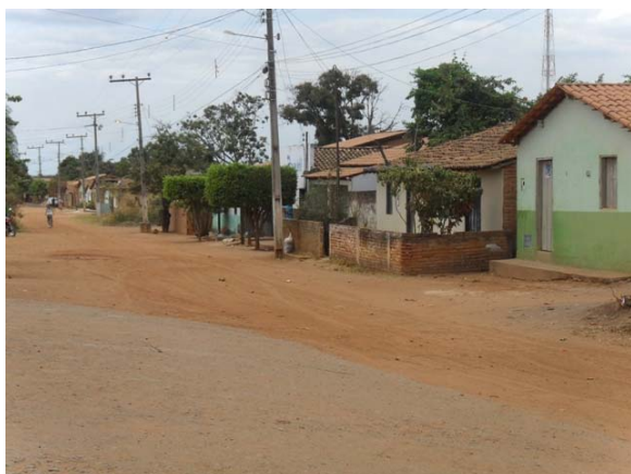
Foto 3: Área Crítica 1 – área de alagamento – Bairro Projetado.
