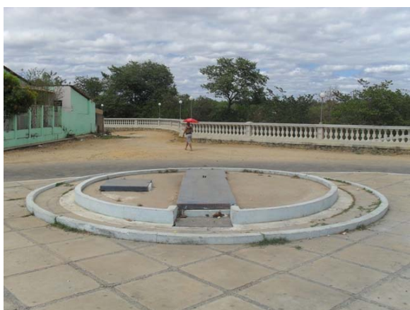
Foto 3: SAAE – Estação Elevatória principal.
