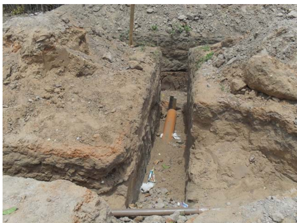
Foto 5: Implantação de rede de esgoto – Rua Joaquim Augusto da Silva.
