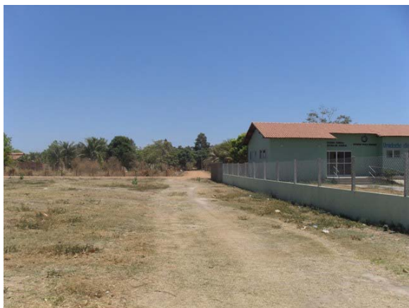
Foto 7: Área crítica 3 – Rua Gerolino Antunes de Carvalho – incidência de alagamentos.
