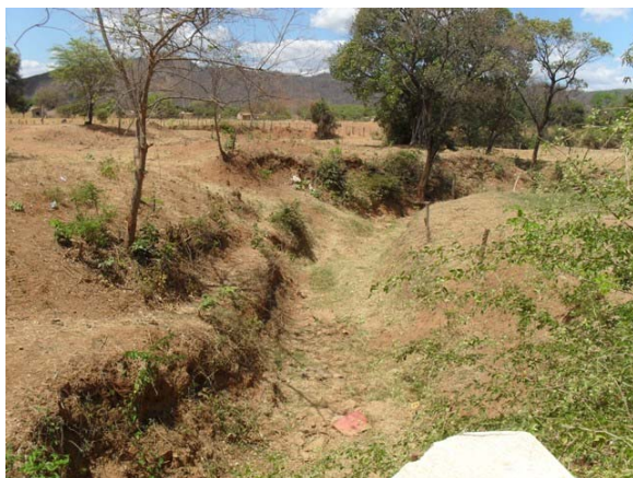
Foto 15: Riacho São Teodoro – Lançamento no Rio Tijucuçu – área alagável intermitente.
