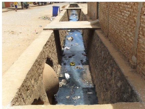
Foto 8: Travessia Rua Alcides R. Delgado – DN 1000 e trecho em alvenaria de pedra.
