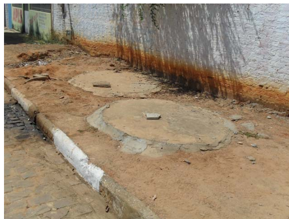
Foto 4: Fossas sépticas construídas nos passeios – Travessa Major Claro 1 e 2.
