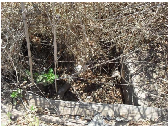
Foto 3: Rua 2 de Julho – final do canal que corre em direção do Riacho Malibu.
