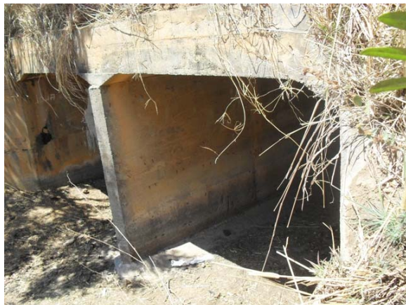
Foto 14: Rio Pederneiras – área da ponte da BR-242.
