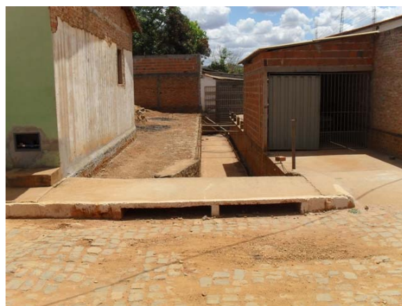
Foto 4: Travessia Claudino Barreto – início do trecho canalizado do Córrego.
