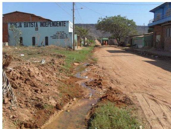
Foto 26: Área Crítica 1 – local de alagamento - Bairro Vila Rica - próximo a BR-020.
