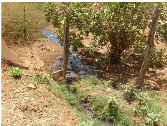
Foto 3: Rua Presidente Tancredo Neves – ponto de lançamento de esgoto a céu aberto.
