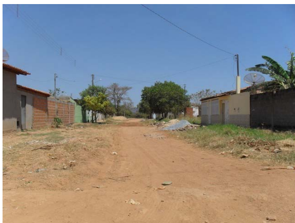
Foto 40: Área Crítica 7 – área de alagamento - Bairro Morada da Lua - Rua Inhazinha Pamplona com a Rua Ulisses Guimarães.
