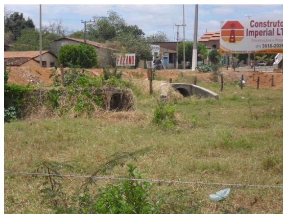
Foto 6: Lançamento da rede de drenagem de diâmetro 1000 mm – Rua Abaré.
