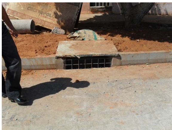
Foto 4: Implantação de pavimentação e drenagem – Rua São José.
