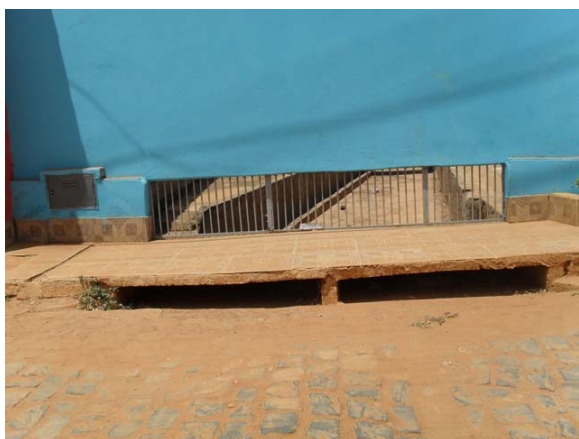
Foto 3: Travessia Claudino Barreto – início do trecho canalizado do Córrego.
