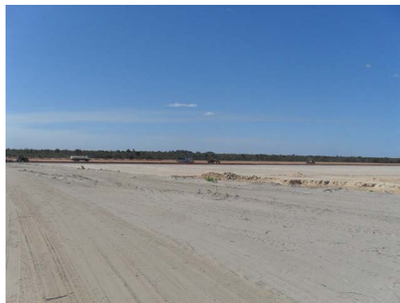
Foto 2: ETE em construção.
