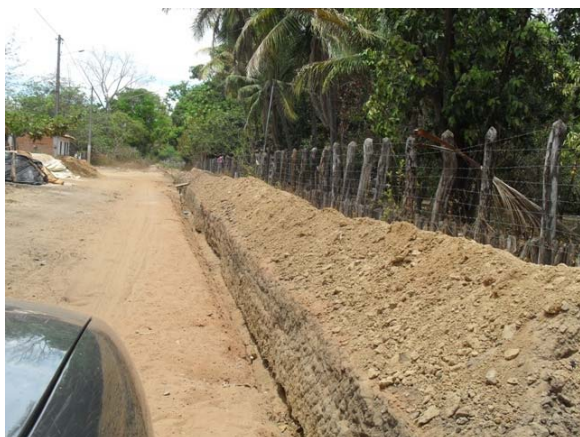
Foto 3: Implantação de rede de esgoto – Rua Joaquim Augusto da Silva.
