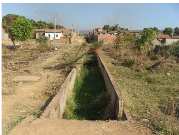
Foto 11: Canal Santa Luzia.
