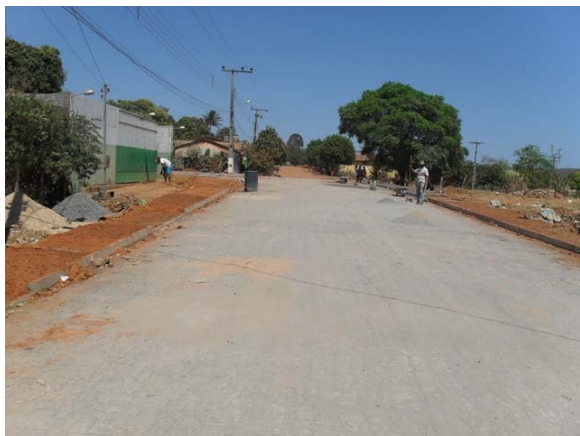
Foto 5: Implantação de pavimentação e drenagem – Rua São José.
