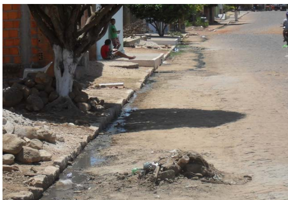
Foto 3: Rua Sete de Setembro – esgoto secundário lançado a céu aberto.
