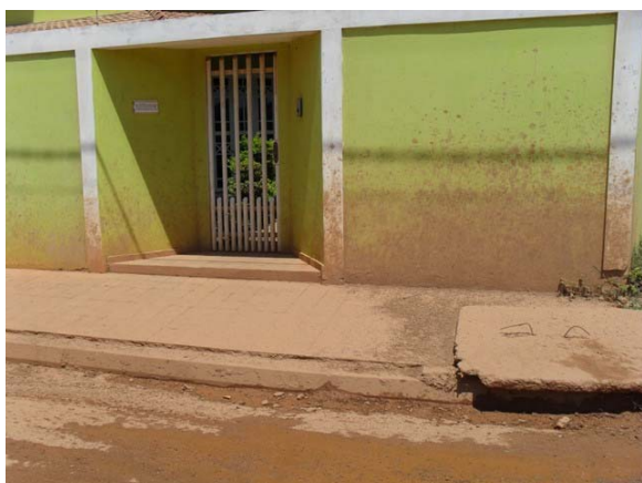
Foto 36: Área Crítica 5 – área de alagamento - Bairro Aratu - Rua Ruy Barbosa.
