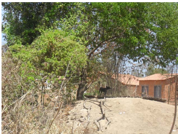
Foto 7: Área de erosão.
