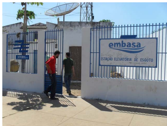
Foto 4: Estação Elevatória - Ribeirão.
