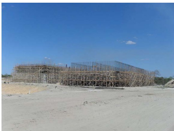
Foto 3: ETE em construção.
