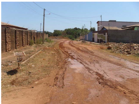
Foto 31: Área Crítica 4 – área de alagamento - Loteamento São Paulo - Rua Uberaba.
