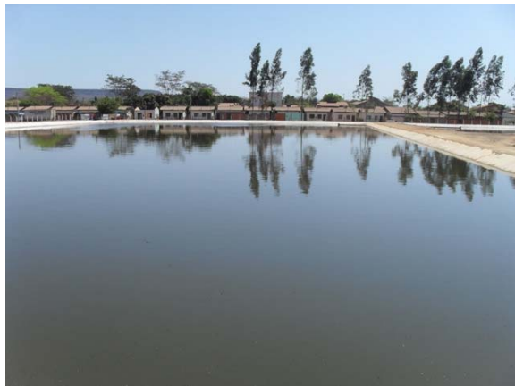
Foto 14: ETE Ribeirão - lagoa facultativa - observar que ao fundo existem residências construídas muito próximo.
