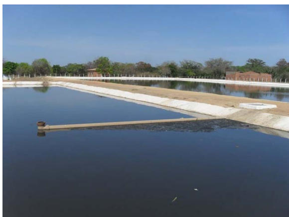
Foto 15: ETE Ribeirão - lagoa facultativa - observar que ao fundo existem residências construídas muito próximo.
