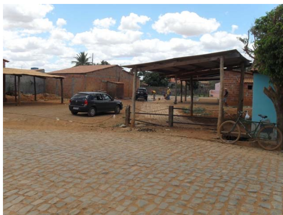
Foto 6: Rua Antônio Inácio – Posto de lavagem de carros – esgoto secundário com canalização de alvenaria de pedra.
