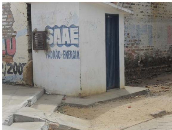
Foto 2: SAAE – Estação Elevatória principal.
