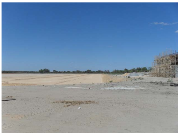
Foto 5: ETE em construção.
