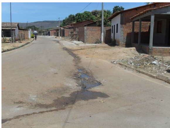
Foto 5: Rua Sete de Setembro – esgoto secundário lançado a céu aberto.
