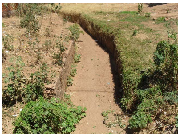
Foto 6: Riacho Brejo Grande – trecho revestido com alvenaria de pedra.
