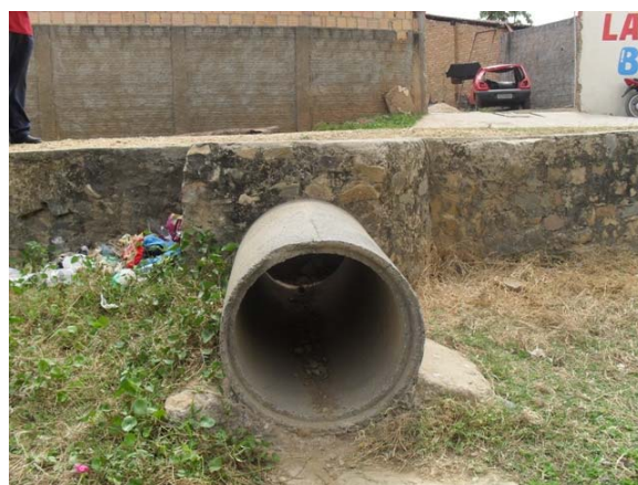
Foto 4: Ponto de lançamento de águas pluviais no pasto.
