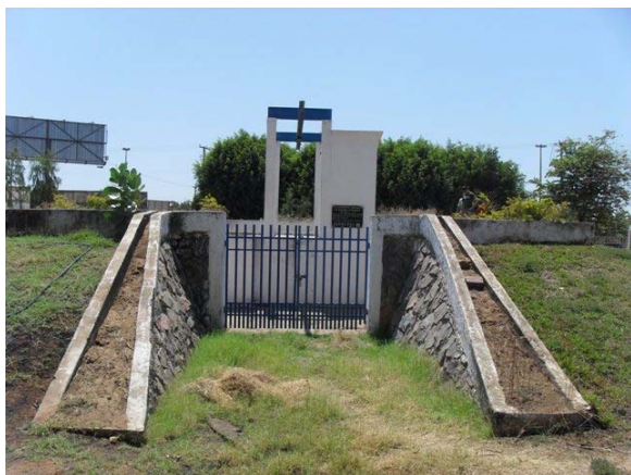
Foto 1: Estação Elevatória - Centro Histórico.
