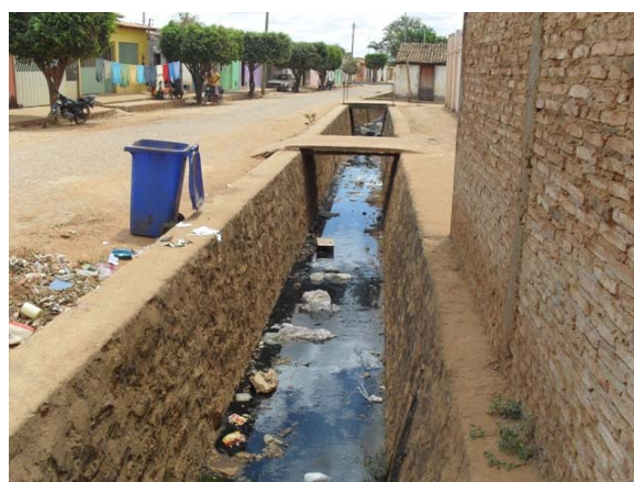
Foto 10: Travessia Rua Alcides R. Delgado – DN 1000 e trecho em alvenaria de pedra.
