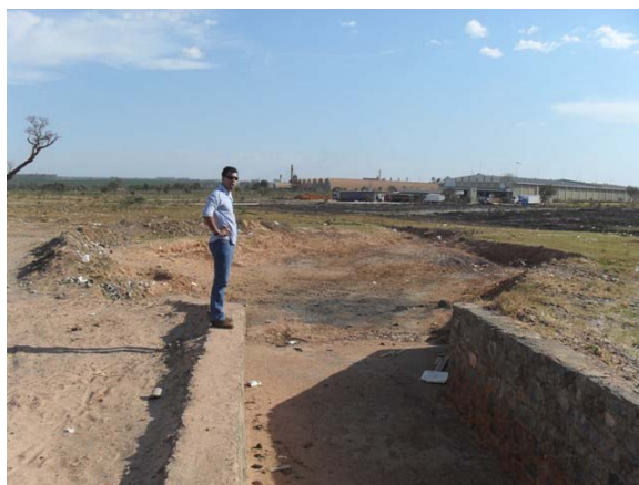
Foto 16: Rua Jacobina – final do Canal Santana do trecho em alvenaria de pedra.
