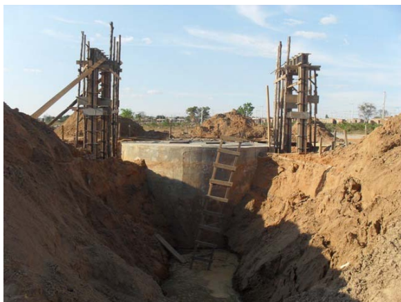
Foto 1: Estação Elevatória em construção.
