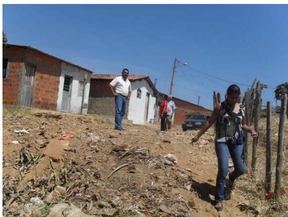
Foto 1: Ponto de erosão – final da Travessa Francisco Macedo.
