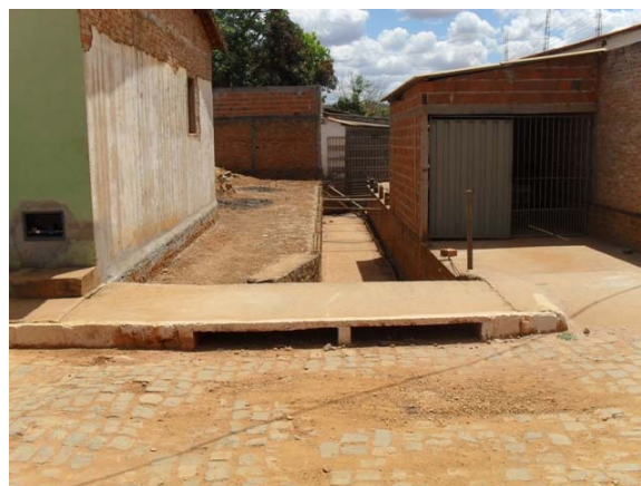
Foto 4: Travessia Claudino Barreto – início do trecho canalizado do Córrego.
