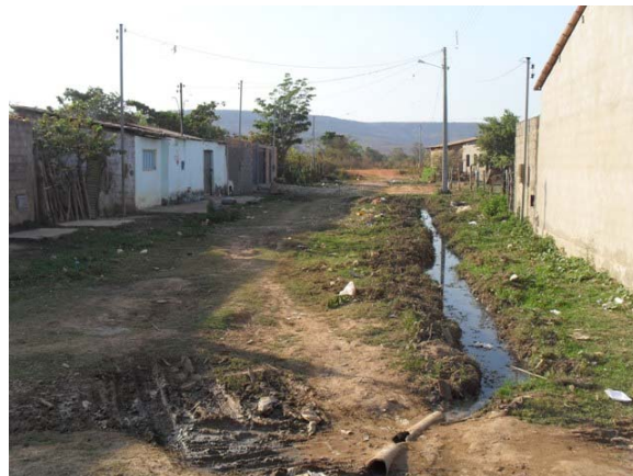
Foto 39: Área Crítica 6 – área de enxurrada - Bairro Santa Luzia.
