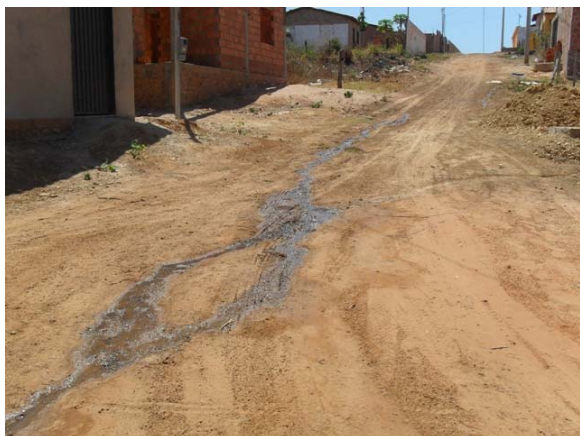
Foto 7: Esgoto a céu aberto – Casas Populares.
