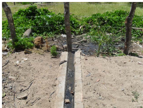
Foto 6: Esgoto a céu aberto – Rua Coronel Antônio Rodrigues Viana.
