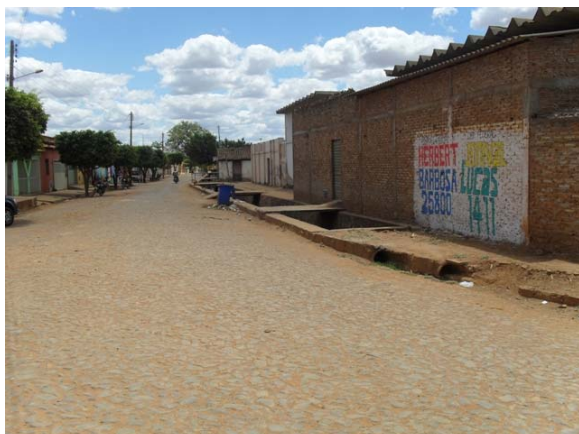
Foto 7: Travessia Rua Alcides R. Delgado – DN 1000 e trecho em alvenaria de pedra.
