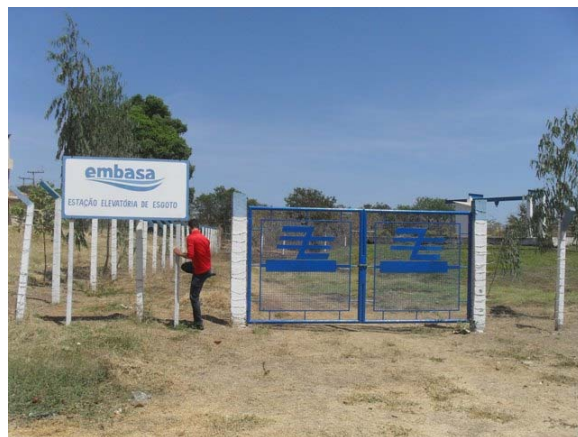
Foto 2: Estação Elevatória - Centro Histórico.
