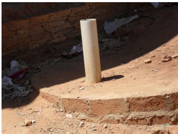
Foto 3: Fossas construídas no passeio.
