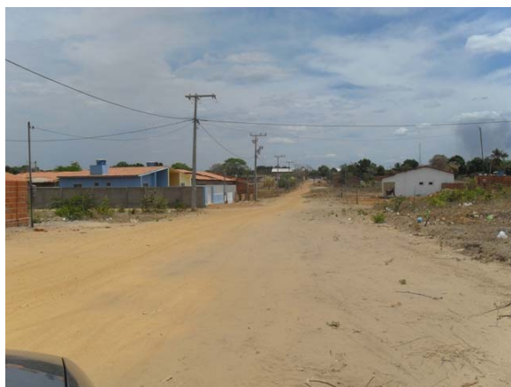
Foto 14: Área Crítica 2 – Loteamento JK.
