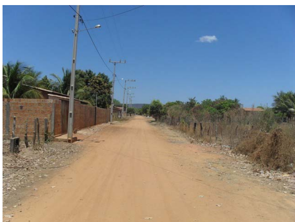
Foto 5: Área Crítica 2 – Rua Jorge Amado – área de alagamento.
