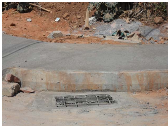
Foto 8: Implantação de pavimentação e drenagem – Rua São José.
