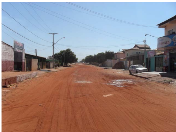
Foto 9: Área Crítica 4 – área de alagamento entre a Rua Piauí e a Rua São Francisco.
