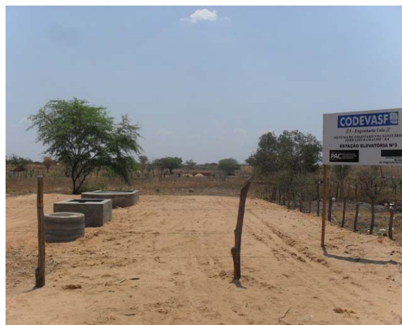
Foto 8: Estação Elevatória nº 3 em implantação.
