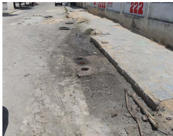
Foto 8: Caixa coletora na Avenida Santo Antônio (próximo ao Correio)
