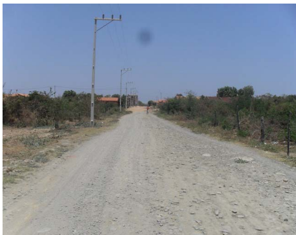
Foto 5: Área crítica 1 – Rua José de Castro – área de alagamento.
