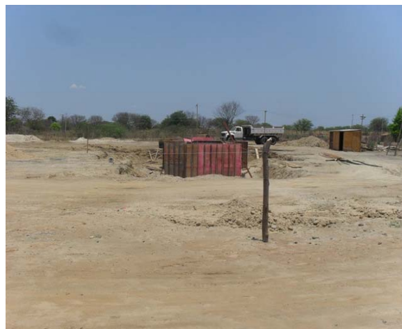
Foto 2: Estação Elevatória em implantação.
