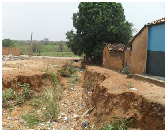
Foto 8: Início da obra do Canal de macrodrenagem.
