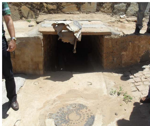
Foto 12: Caixa com abertura na guia - travessia da Av. Airton Senna
