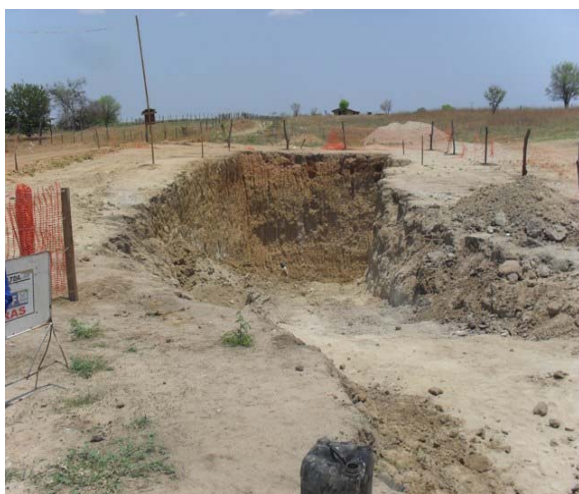
Foto 5: Estação Elevatória nº 3 – em implantação.
