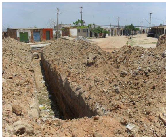
Foto 8: Ponto de lançamento de águas pluviais. Está em implantação o projeto de drenagem (DN 1.000mm).
