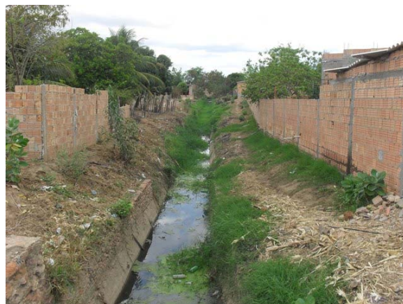
Foto 6: Canal revestido de concreto ( 1,0 x 0.80) – seção trapezoidal – escoamento para o bueiro e continua sem revestimento até a Lagoa do Saquinho.
