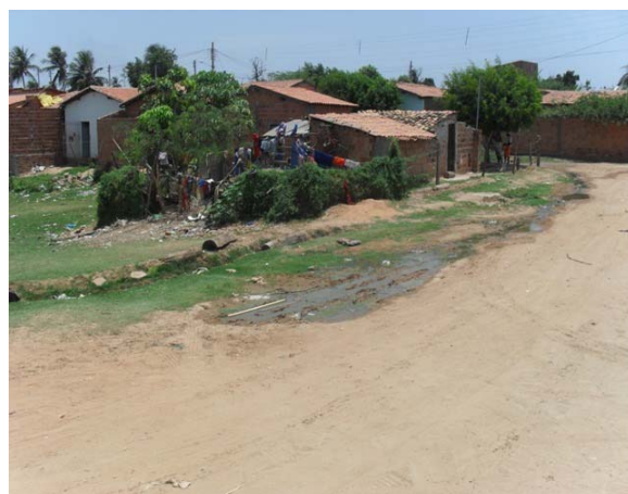
Foto 6: Bacia para acumulação de águas pluviais em implantação – terá sistema de bombeamento – esgoto a céu aberto no local.
