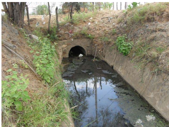
Foto 5: Canal revestido de concreto ( 1,0 x 0.80) – seção trapezoidal – escoamento para o bueiro e continua sem revestimento até a Lagoa do Saquinho.
