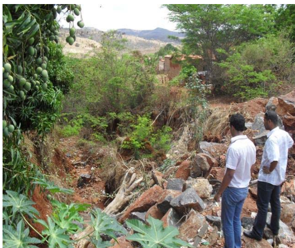
Foto 7: Área Crítica 3 – Rua Amado Magalhães – erosão.
