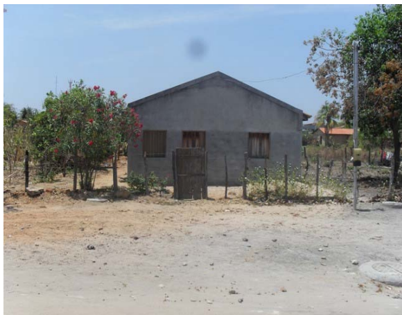
Foto 1: Área Crítica 1 – Rua Porto Seguro – área de alagamento.
