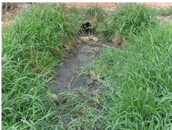
Foto 3: Área da antiga lagoa – vista do final da drenagem com esgoto secundário e primário – DN 800 mm.
