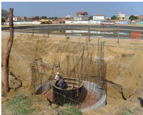
Foto 7: Estação Elevatória de Esgoto em construção – Bairro São Gotardo.
