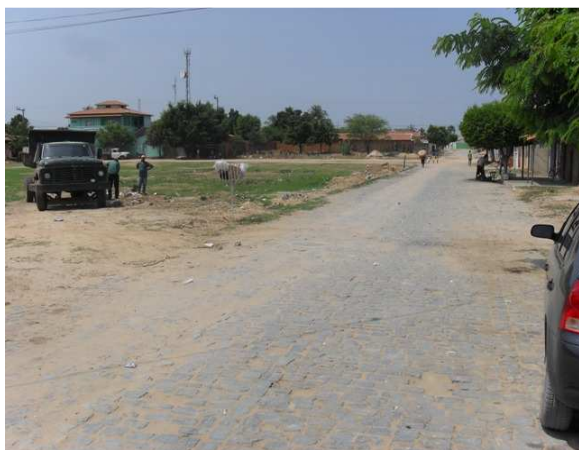
Foto 3: Ponto de drenagem – montante – atravessa o Colégio Professor Aurelino Nunes e vai até a Praça.
