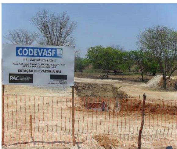
Foto 3: Estação Elevatória nº 5 em implantação.
