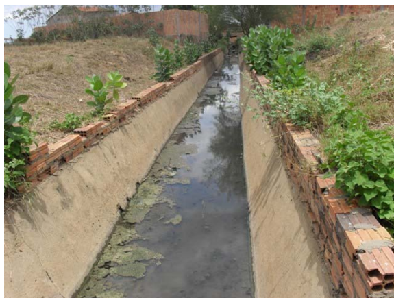
Foto 4: Canal revestido de concreto ( 1,0 x 0.80) m – seção trapezoidal – escoamento para o bueiro e continua sem revestimento até a Lagoa do Saquinho.
