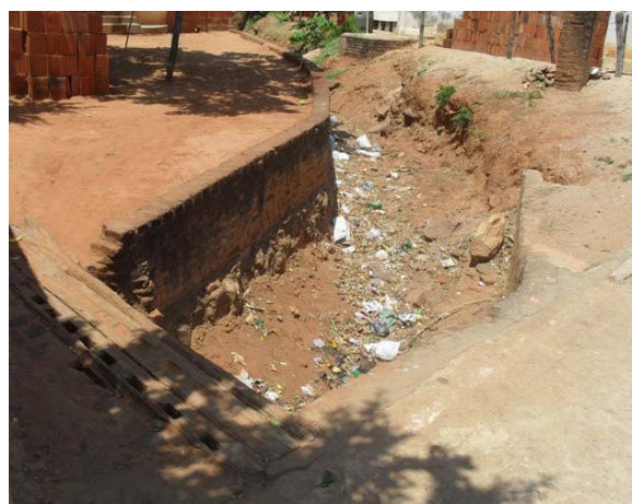
Foto 10: Início da obra do Canal de macrodrenagem.
