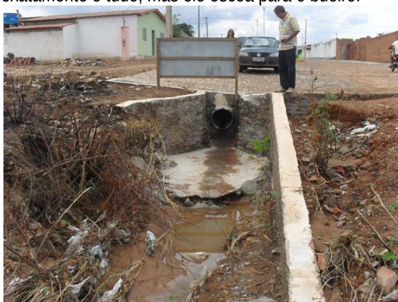
Foto 9: Ponto de lançamento de esgoto – encaminhamento da rede – ponto de saída.
