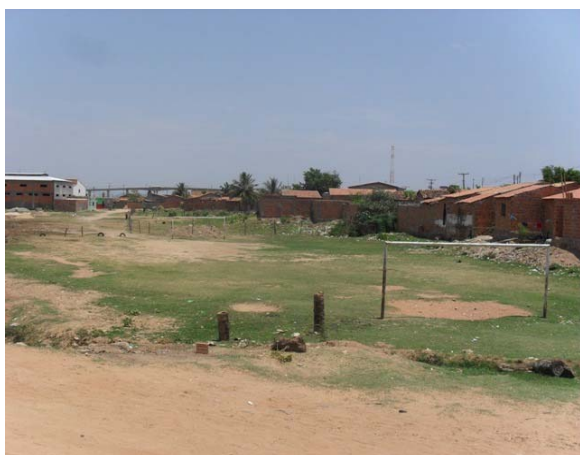
Foto 5: Bacia para acumulação de águas pluviais em implantação – terá sistema de bombeamento – esgoto a céu aberto no local.
