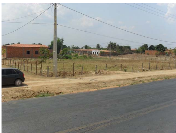
Foto 15: Área Crítica 1 – BA-160 sentido Paratinga / Bom Jesus da Lapa – Bairro Alto da Estrada – área de alagamento.
