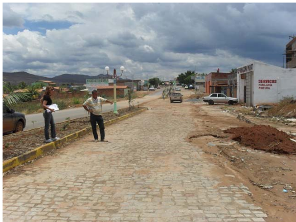
Foto 11: Área Crítica 2 – Rua João Durval Carneiro – área crítica devido enxurrada.
