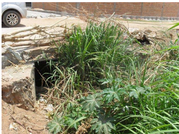
Foto 3: Final do Canal revestido e início do canal natural – previsão de continuar o revestimento até o Riacho.
