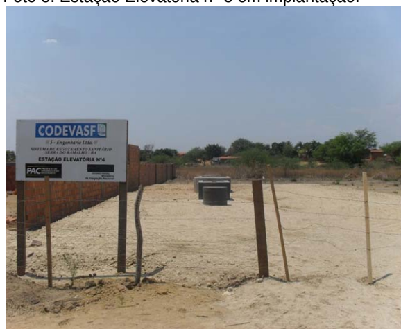
Foto 10: Estação Elevatória nº 4 em implantação.
