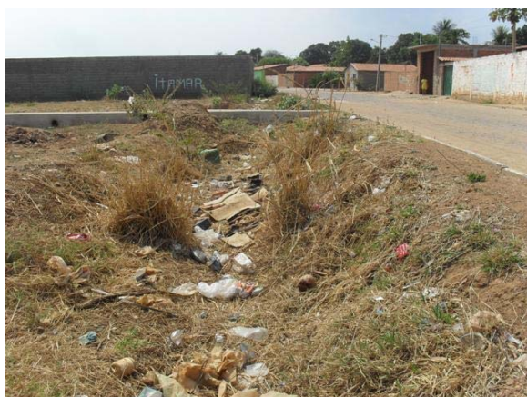
Foto 9: Final do caminhamento em manilha – ponto de lançamento em área de inundação e escoamento até a antiga lagoa.
