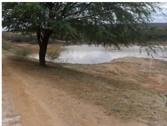
Foto 6: Vista do açude.
