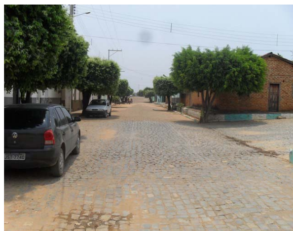
Foto 6: Área Crítica 1 – Av. Elias Pereira de Souza – área de enxurrada.
