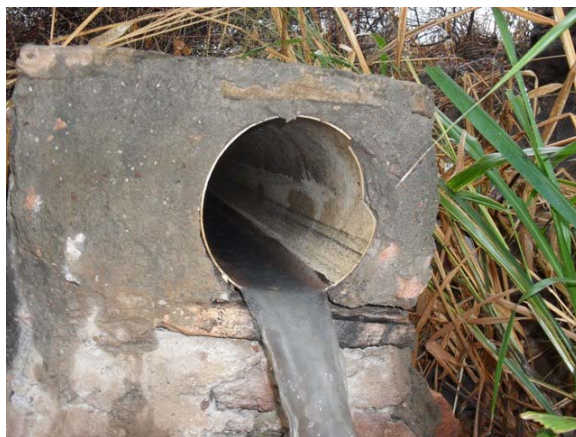
Foto 2: Ponto de lançamento de esgoto – tubo de DN 200 envelopado.
