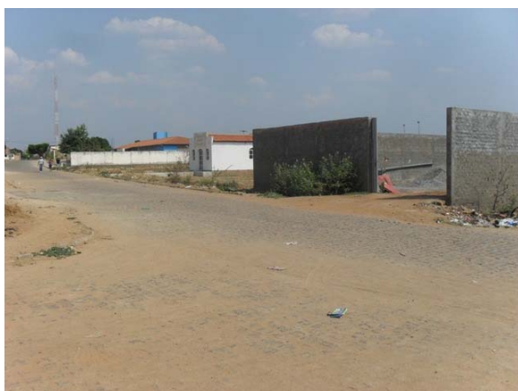
Foto 21: Área crítica 3 – Bairro Vermelho – ruas sem denominação – área que recebe a macrodrenagem e alaga por ser um ponto baixo.
