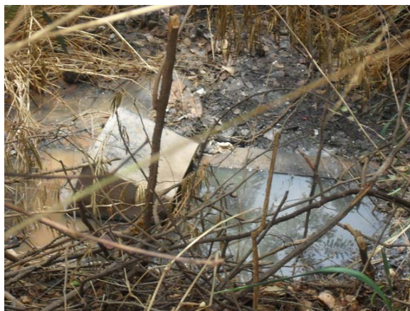
Foto 2: Ponto de lançamento de esgotos na estrada que liga Ipuíara à Brotas de Macaúbas – tubo da rede encaixa no bueiro da estrada – área particular.
