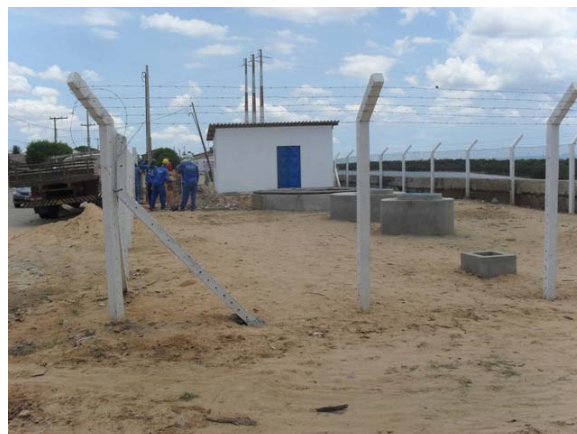
Foto 2: Estação Elevatória (EE 5 do projeto) - em fase de conclusão.
