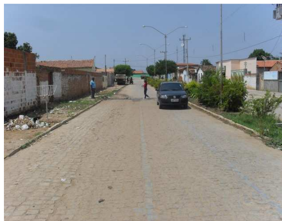
Foto 4: Ponto de drenagem – montante – atravessa a Colégio Professor Aurelino Nunes e vai até a Praça.
