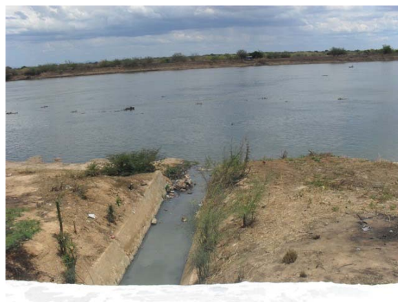
Foto 8: Final da tubulação de concreto – lançamento direto no Rio São Francisco, com presença de esgoto – chega através de tubo de DN 1,0 m – foto mostra a visão a partir da caixa e da comporta e do canal de saída.
