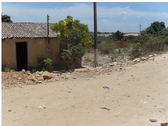
Foto 11: Talvegue – Av. João Durval – área de possível agravamento de problemas de drenagem – águas escoam do morro.
