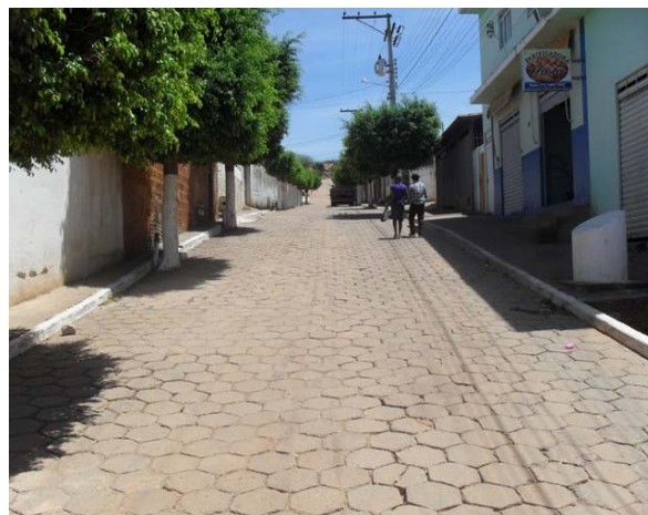
Foto 2: Área crítica 1 – Av. Airton Senna – área de alagamento e enxurrada.
