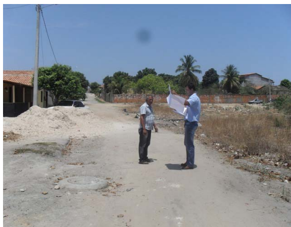
Foto 4: Área Crítica 1 – Rua Porto Seguro – área de alagamento (Bairro Sudoeste).
