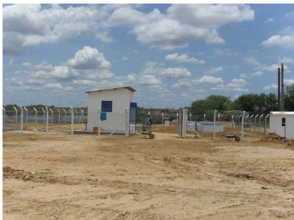
Foto 1: Estação Elevatória (EE 5 do projeto) - em fase de conclusão.
