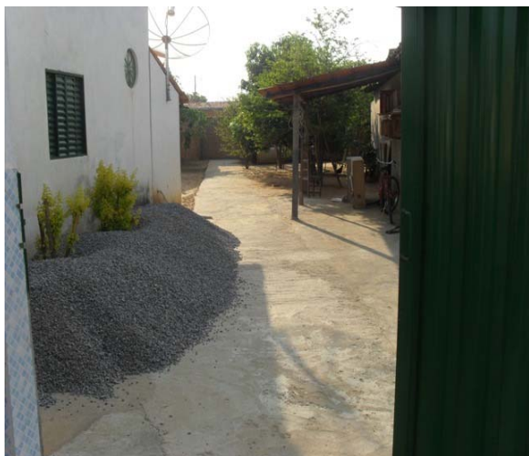
Foto 13: Canal 2 – Bairro Cavallhada – Canal em alvenaria de pedra (1,50 x 1,20) parte aberta e parte coberta – observa-se presença de esgoto.
