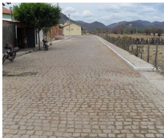
Foto 4: Área Crítica 2 – Rua Germina de Oliveira – área de alagamento.
