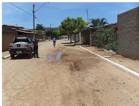
Foto 10: Área Crítica 5 – Rua Ivan Dias Fernandes – área de alagamento.
