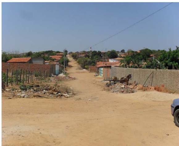
Foto 21: Área Crítica 5 – Bairro Parque Verde – Rua Geraldo Lisboa com a Rua Pedro Américo – área de enxurrada e alagamento.
