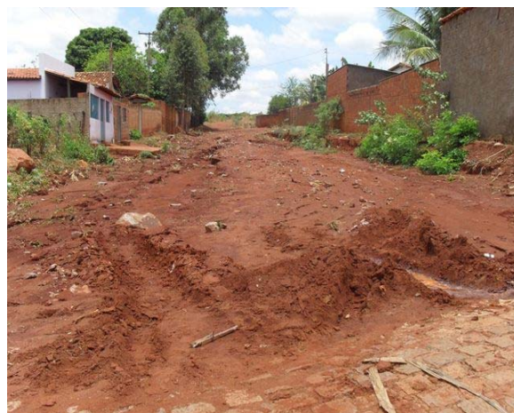
Foto 4: Área Crítica 2 – Praça Vila Eremita – área de alagamento.
