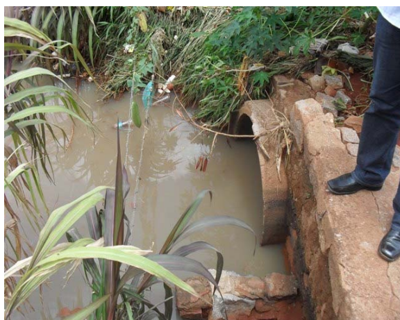
Foto 14: Galeria enterrada na estrada para Santana.
