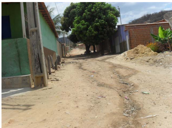
Foto 7: Rua e 1ª Travessa Ouro Preto – esgoto a céu aberto – rua com expectativa de pavimentar e colocar rede de esgoto.
