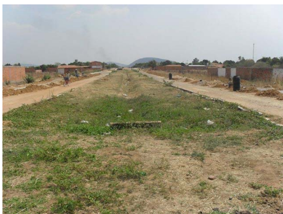
Foto 17: Área Crítica 2 – Av. Rio Branco – vista do Canal e entrada para o bueiro – área de alagamento.
