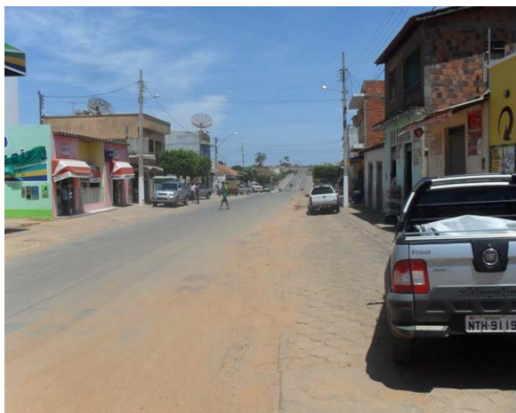
Foto 1: Área crítica 1 – Av. Airton Senna – área de alagamento e enxurrada.
