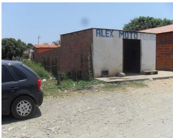
Foto 3: Área crítica 1 – Rua José de Castro – área de alagamento.
