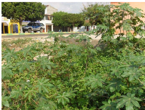
Foto 6: Ponto de lançamento final da rede de PVC de esgoto – final da canaleta - área totalmente coberta pela vegetação.
