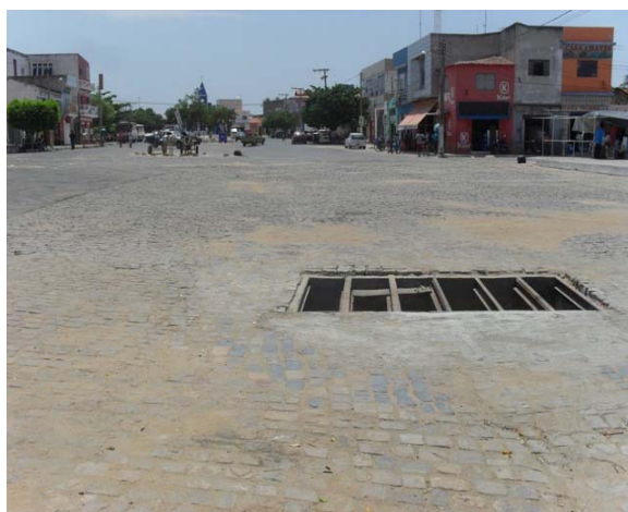
Foto 4: Praça da Feira – ponto de alagamento e em implantação o projeto de drenagem.
