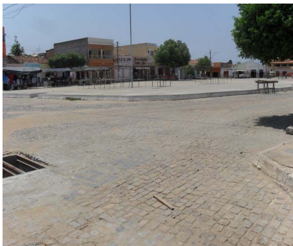
Foto 5: Praça da Feira – ponto de alagamento e em implantação o projeto de drenagem.
