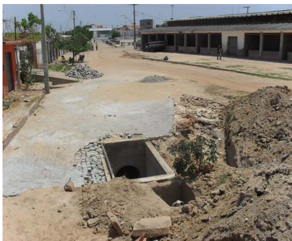
Foto 7: Ponto de lançamento de águas pluviais. Está em implantação o projeto de drenagem (DN 1.000mm).
