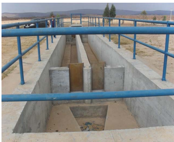
Foto 15: Estação de Tratamento de Esgoto – em fase de conclusão.
