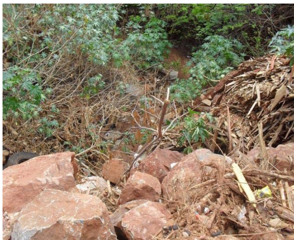
Foto 5: Área Crítica 3 – Rua Amado Magalhães – erosão.
