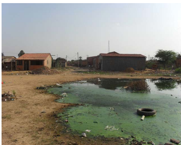
Foto 9: Área Crítica 1 – Bairro Beira Rio – área crítica devido a alagamentos.
