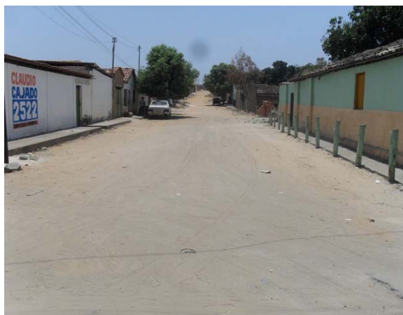
Foto 6: Área Crítica 2 – Rua Democrata – área de alagamento.
