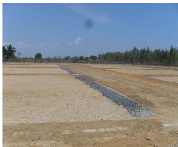
Foto 10: ETE sendo construída pela CODEVASF.
