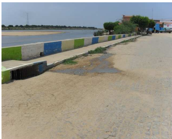
Foto 7: Área do Cais – ponto de inundação – última ocorrência grave foi em 1992 visto ter atingido o telhado das casas.
