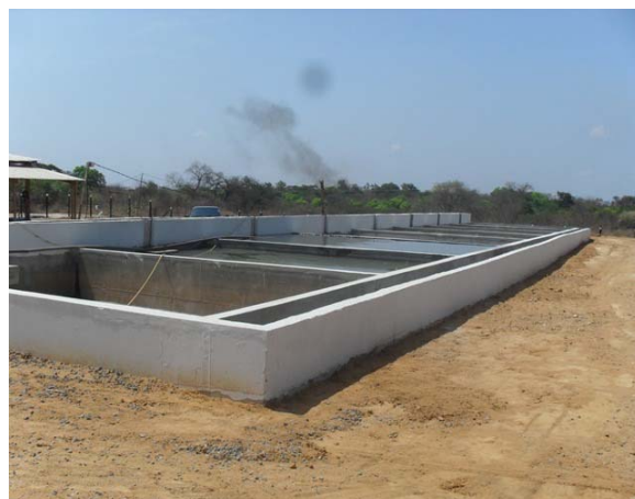
Foto 6: ETE sendo construída pela CODEVASF.
