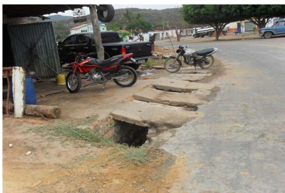
Foto 5: Área Crítica 1 – Rua Padre João Cristiano, Rua Coronel Manoel Ribeiro e Rua Coronel Joviniano Rosa – área de enxurrada e ponto baixo – mostra a vala que recebe as águas de chuva da confluências de várias ruas.
