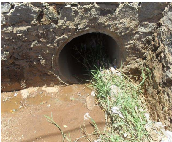
Foto 25: Travessia do Canal da Varginha
