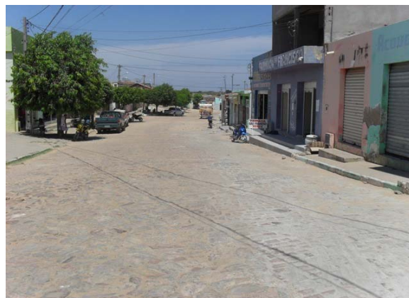
Foto 2: Av. Presidente Dutra – evidência dos trabalhos de implantação da rede de esgoto de má qualidade.
