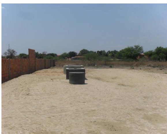
Foto 11: Estação Elevatória nº 4 em implantação.
