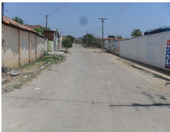
Foto 5: Área Crítica 2 – Rua Democrata – área de alagamento.
