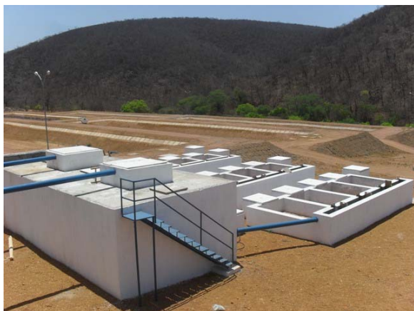
Foto 7: Estação de Tratamento de Esgoto.
