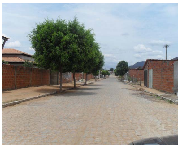
Foto 2: Área Crítica 1 – Rua Tancredo Neves – área de alagamento.
