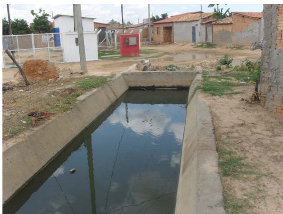
Foto 7: Bairro da Subestação – início do Canal revestido.
