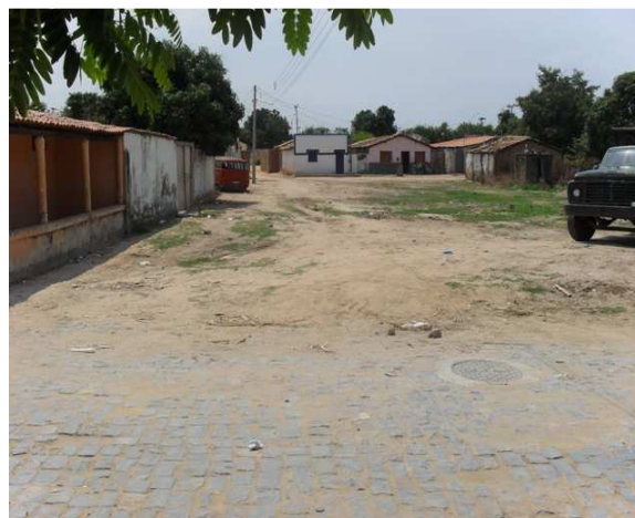
Foto 8: Área Crítica 1 - Baixada Fluminense – área crítica devido a enchentes e inundação ribeirinha.
