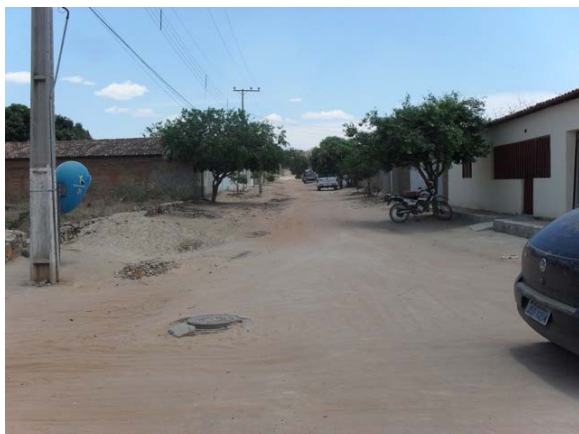
Foto 15: Bairro Renascer do Morro - Rua Joaquim Benedito Sobrinho – rua com erosão.
