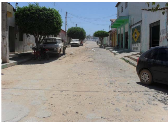
Foto 1: Av. Presidente Dutra – evidência dos trabalhos de implantação da rede de esgoto de má qualidade.
