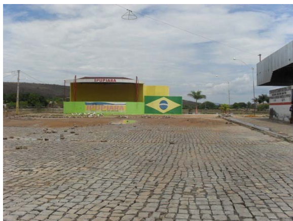
Foto 10: Área Crítica 1 – Rua Sete de Setembro e adjacentes – área crítica devido enxurrada.
