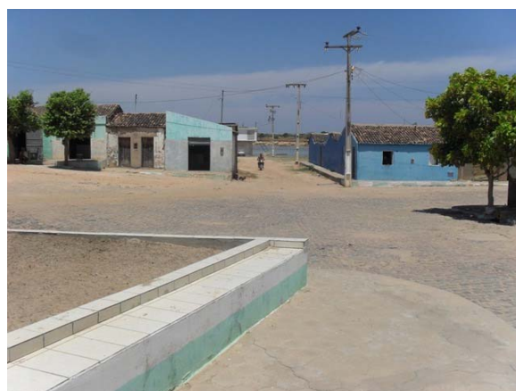
Foto 18: Área Crítica 1 – Praça Dr. Luiz Viana Filho – área de alagamento.
