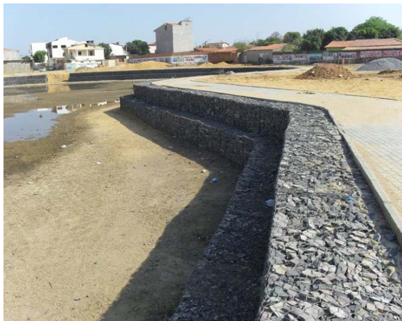
Foto 25: Lagoa de São Gotardo – obra de urbanização em andamento.
