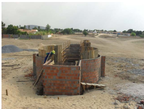
Foto 4: Estação Elevatória 3 em implantação.
