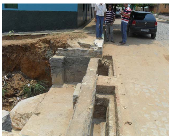
Foto 12: Início da obra do Canal de macrodrenagem.
