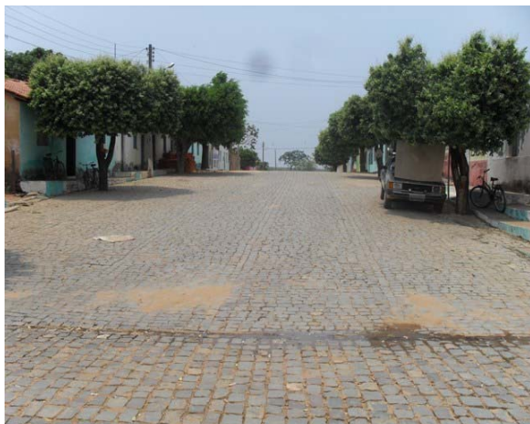
Foto 1: Área Crítica 1 – Av. Elias Pereira de Souza – área de enxurrada.
