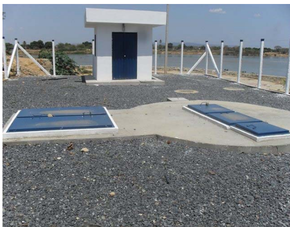
Foto 5: Estação Elevatória recentemente construída.
