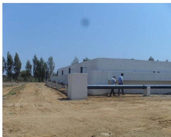
Foto 8: ETE sendo construída pela CODEVASF.
