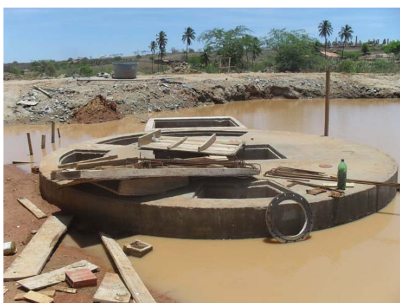
Foto 5: Poço da Estação Elevatória de Esgoto em construção.
