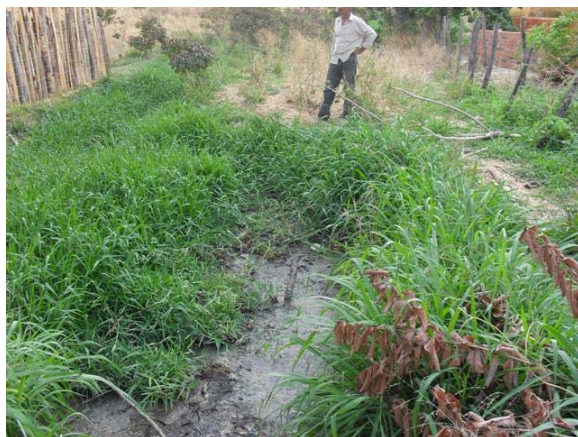
Foto 2: Área da antiga lagoa – ponto de lançamento de esgoto.
