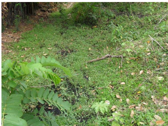
Foto 5: Ponto de lançamento de esgoto a céu aberto as margens do Riacho.
