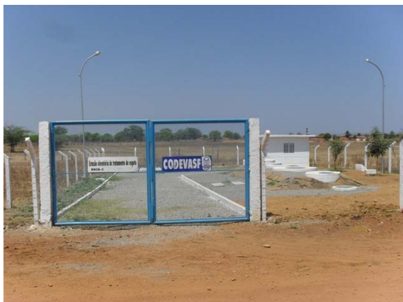
Foto 1: Estação Elevatória – Bacia C.
