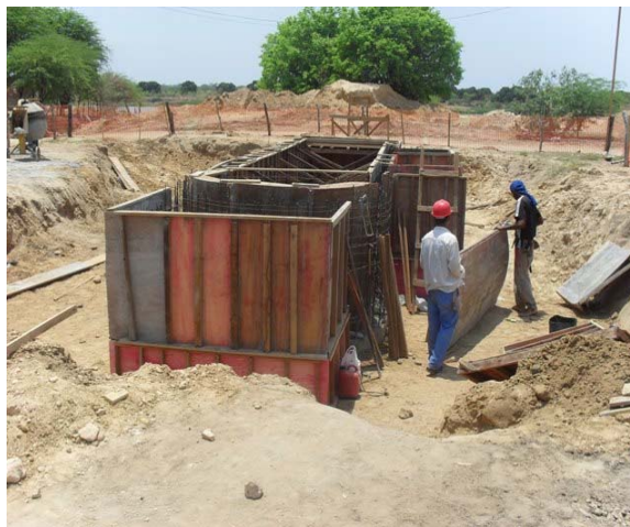
Foto 4: Estação Elevatória nº 1 – em implantação.
