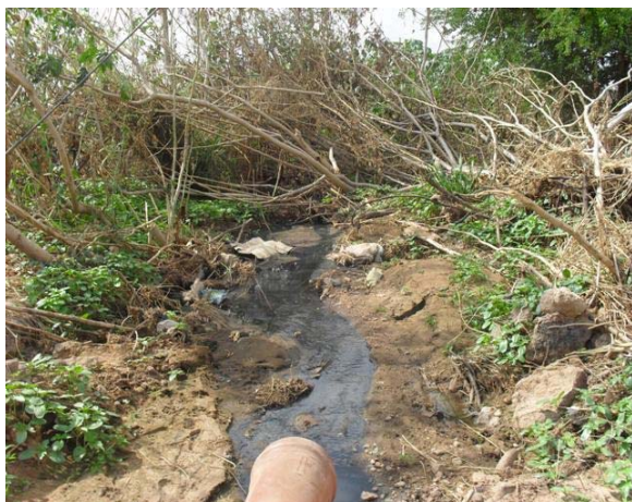
Foto 13: Ponto de lançamento de esgoto – tubo de ferro fundido DN 300 mm (água e esgoto) – escoamento para a Lagoa.
