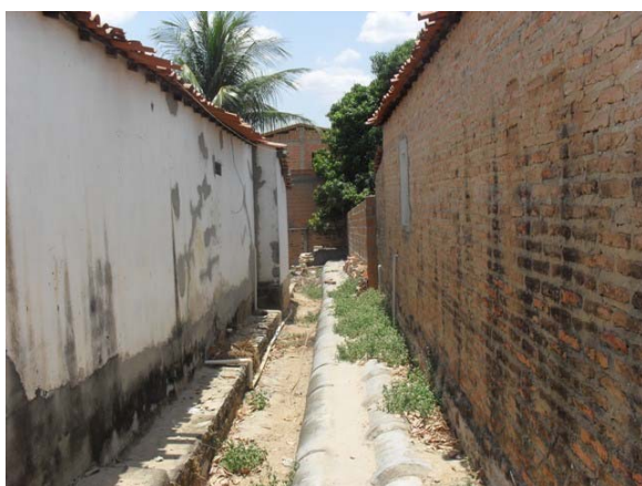
Foto 9: Área Crítica 2 – Av. das Oliveiras – área de enxurrada.
