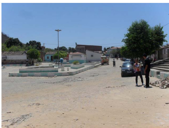
Foto 17: Área Crítica 1 – Praça Dr. Luiz Viana Filho – área de alagamento.
