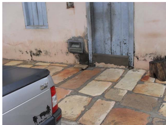
Foto 8: Área Crítica 3 – Rua Coronel José Campos (nas imediações da Praça Dr. João Borges) – ponto baixo sem dispositivo de drenagem – águas descem com velocidade sobre as testadas das casas.
