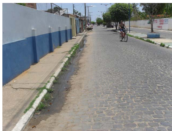
Foto 4: Alameda Plínio Mariano – caixas de gordura – solução para esgoto.
