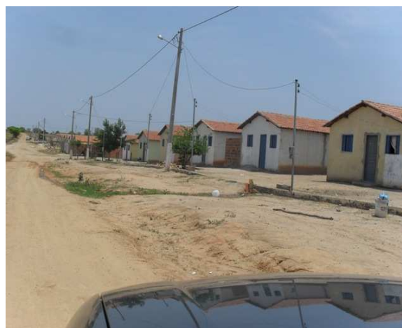
Foto 12: Área Crítica 4 – Conjunto Habitacional – sem drenagem, sem pavimentação, com sistema de fossas e área crítica devido enxurrada.
