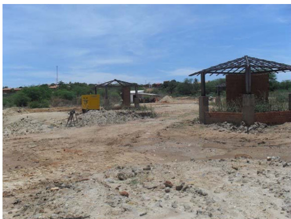
Foto 3: Construção da Estação Elevatório de Esgoto.
