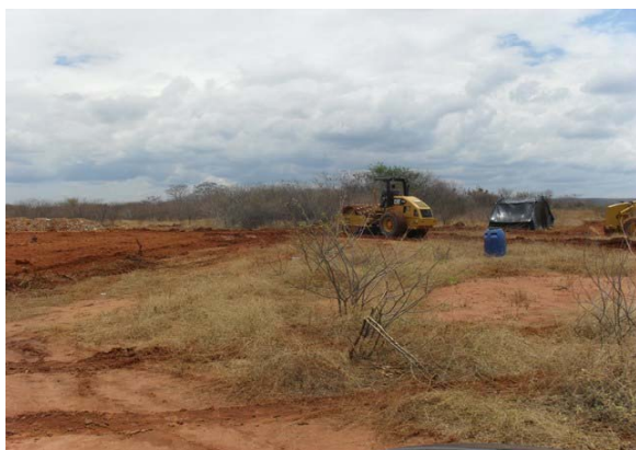
Foto 5: Área de implantação da ETE – início dos trabalhos de terraplanagem.
