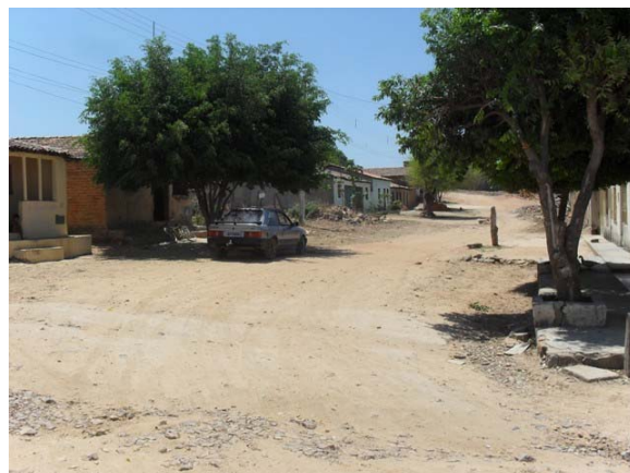
Foto 4: Rua Manoel Novais com a perpendicular Travessa Manoel Novais – contribuem par a Av. Rui Barbosa. Nas imediações da base do morro tem ponto de minação no período de chuvas – observa-se ponto de erosão.
