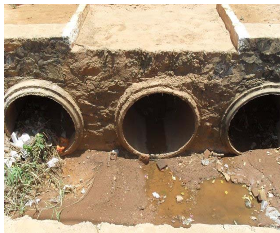
Foto 26: Travessia do Canal da Varginha
