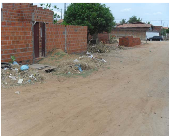
Foto 1: Área Crítica 1 – Rua 1º de Maio – área de alagamento.
