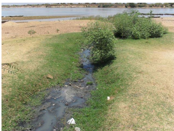
Foto 11: Rua Mangabeira e adjacências - ponto de lançamento da rede de esgoto (manilha DM 200 mm).
