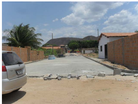
Foto 2: Final do Canal revestido e início do canal natural – previsão de continuar o revestimento até o Riacho.
