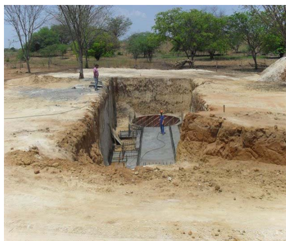
Foto 4: Estação Elevatória nº 5 em implantação.
