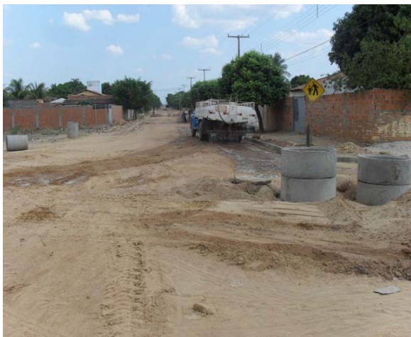
Foto 15: Bairro Alto do Fundão – área sendo pavimentada com sistema de drenagem.
