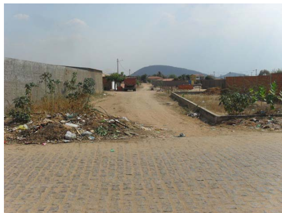
Foto 20: Área crítica 3 – Bairro Vermelho – ruas sem denominação – área que recebe a macrodrenagem e alaga por ser um ponto baixo.
