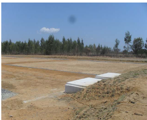
Foto 9: ETE sendo construída pela CODEVASF.
