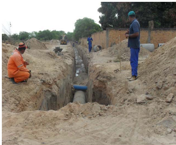
Foto 16: Bairro Alto do Fundão – área sendo pavimentada com sistema de drenagem.
