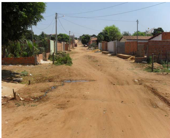
Foto 23: Área Crítica 5 – Bairro Parque Verde – Rua Pedro Américo – área de enxurrada e alagamento.
