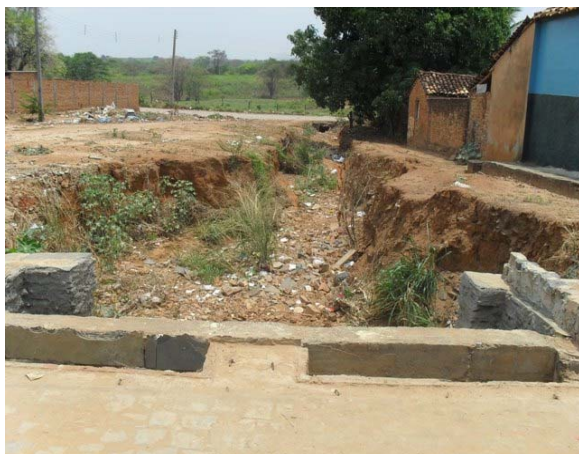
Foto 7: Início da obra do Canal de macrodrenagem.
