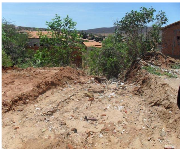
Foto 7: Área Crítica 3 – Rua Coronel Augusto – área de alagamento e enxurrada.
