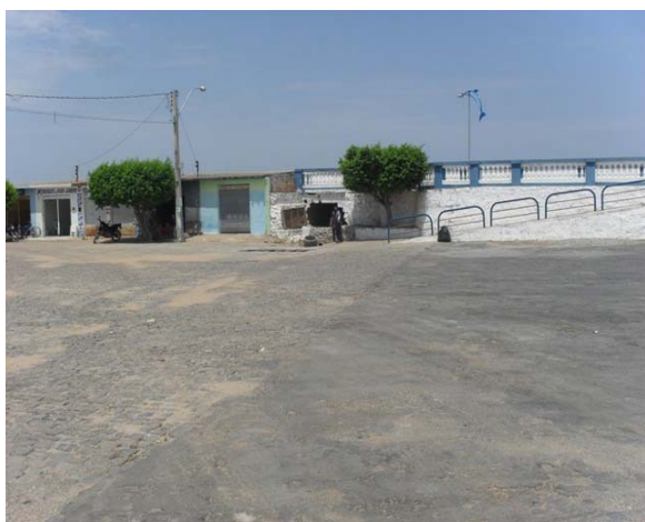
Foto 3: Praça da Feira – ponto de alagamento e em fase de implantação o projeto de drenagem.
