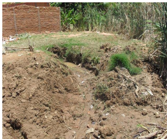
Foto 8: Área Crítica 4 – Loteamento Manoel Azevedo – área de alagamento.
