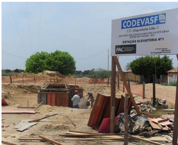
Foto 3: Estação Elevatória nº 1 – em implantação.
