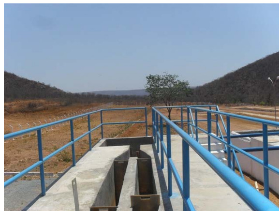
Foto 8: Estação de Tratamento de Esgoto.
