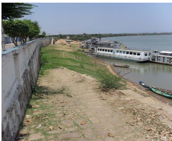
Foto 9: Pontos de lançamento de esgoto e drenagem – difuso – em todo o Cais.
