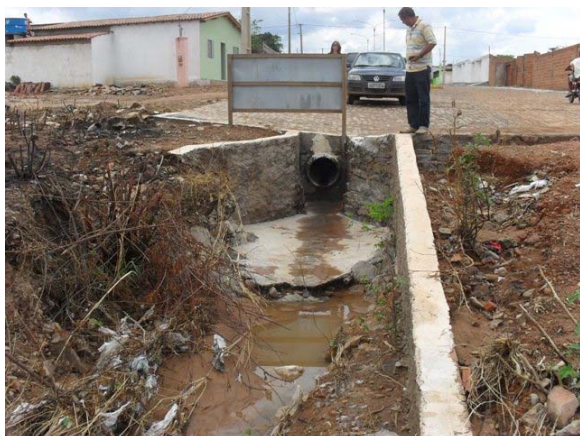
Foto 5: Av. Barra do Mendes - ponto de lançamento de drenagem – tubo DN 600 (aproximadamente 500m) – vai para o açude.
