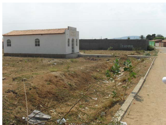
Foto 10: Final do caminhamento em manilha – ponto de lançamento em área de inundação e escoamento até a antiga lagoa.
