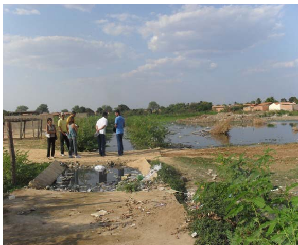
Foto 7: Canal 1 – Bairro Beira Rio – lançamento na Lagoa Beira Rio.
