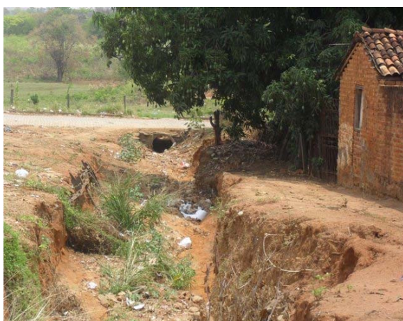
Foto 9: Início da obra do Canal de macrodrenagem.
