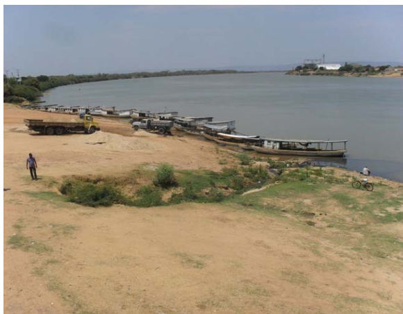
Foto 1: Ponto de lançamento de esgoto e drenagem no Rio – 02 tubos de DM 800 mm.
