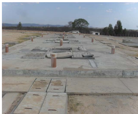
Foto 16: Estação de Tratamento de Esgoto – em fase de conclusão.
