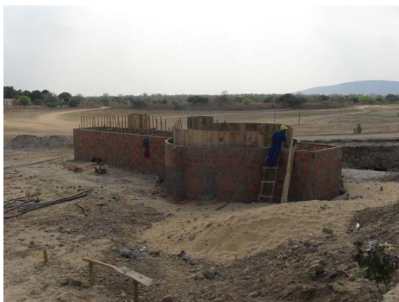
Foto 5: Estação Elevatória 3 em implantação.
