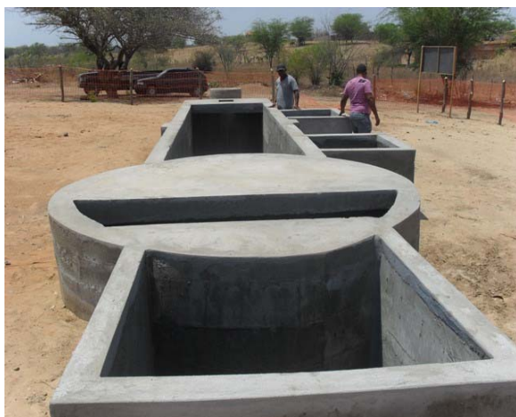
Foto 7: Estação Elevatória nº 2 em implantação.
