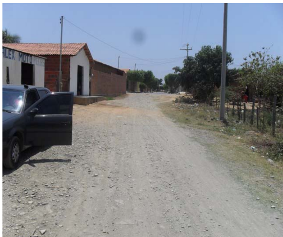
Foto 1: Área crítica 1 – Rua José de Castro – área de alagamento.
