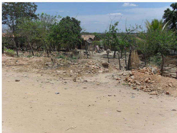
Foto 12: Talvegue – Av. João Durval – área de possível agravamento de problemas de drenagem – águas escoam do morro.
