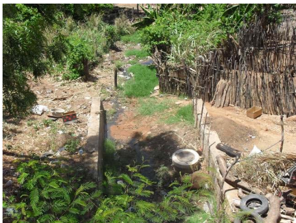
Foto 1: Canal de águas pluviais recebendo contribuição de esgotos.
