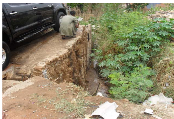
Foto 6: Área Crítica 1 – Rua Padre João Cristiano, Rua Coronel Manoel Ribeiro e Rua Coronel Joviniano Rosa – área de enxurrada e ponto baixo – mostra a vala que recebe as águas de chuva da confluências de várias ruas.
