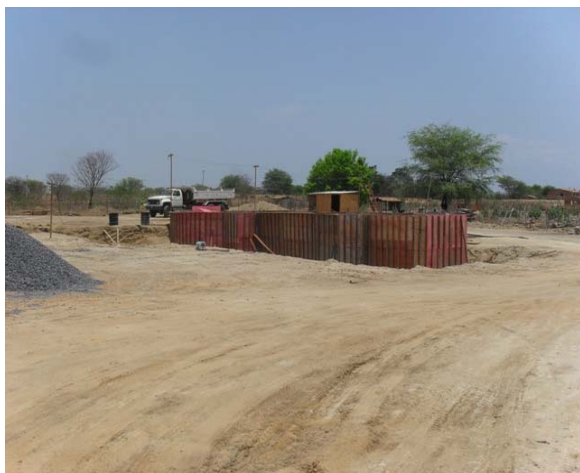
Foto 1: Estação Elevatória em implantação.
