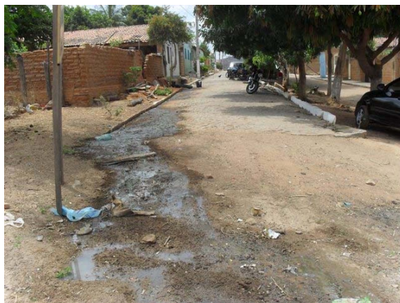
Foto 6: Rua e 1ª Travessa Ouro Preto – esgoto a céu aberto – rua com expectativa de pavimentar e colocar rede de esgoto.
