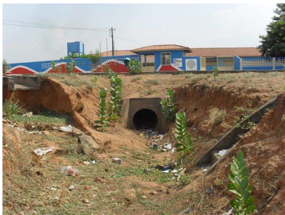
Foto 7: Vista final do Canal e início do trecho em manilha DN 800 mm.
