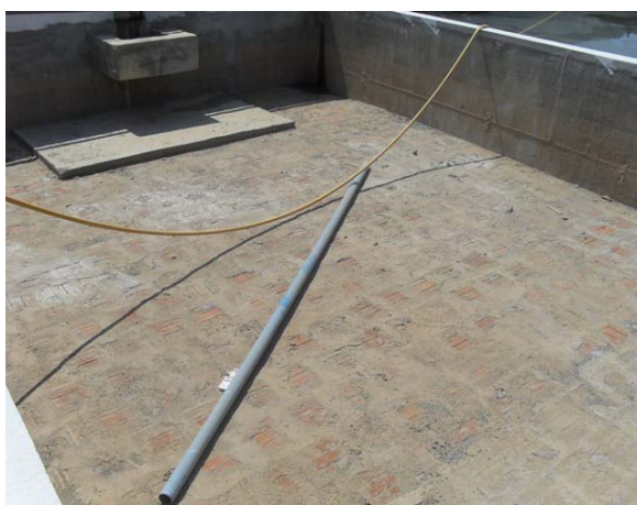
Foto 7: ETE sendo construída pela CODEVASF.
