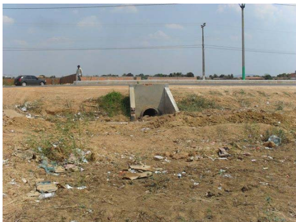
Foto 3: Ponto de lançamento de águas pluviais.
