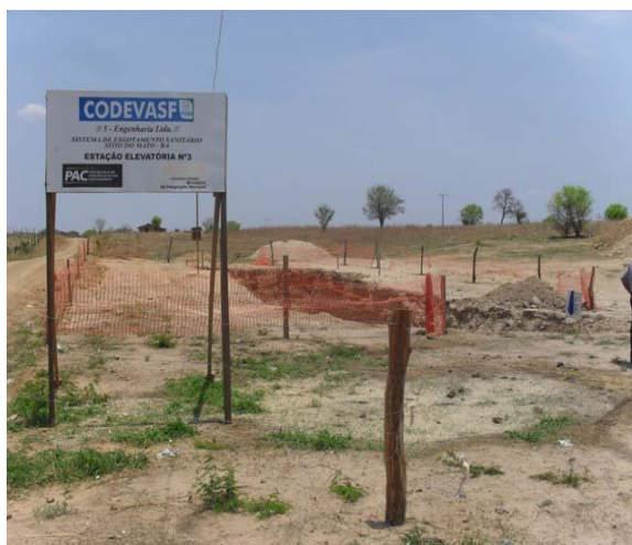
Foto 6: Estação Elevatória nº 3 – em implantação.
