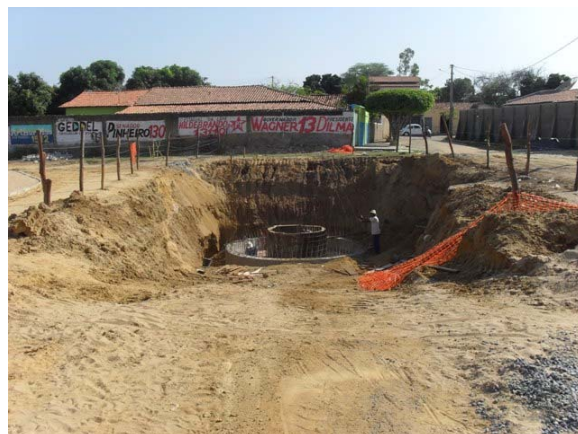
Foto 6: Estação Elevatória de Esgoto em construção – Bairro São Gotardo.
