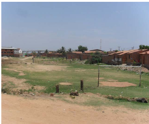
Foto 9: Bacia para acumulo das águas pluviais. Está sendo implantado o projeto de drenagem que terá sistema de bombeamento.
