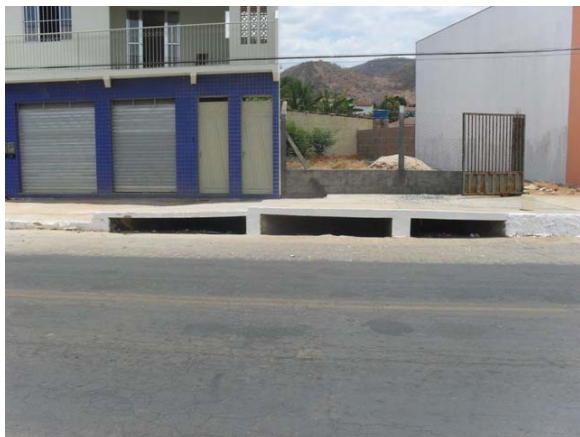
Foto 1: Início do Canal revestido.
