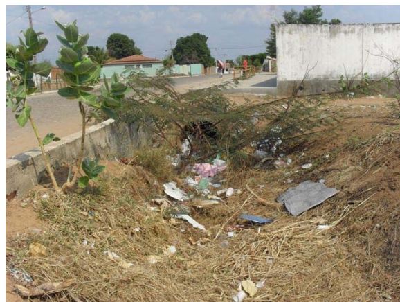
Foto 8: Final do caminhamento em manilha – ponto de lançamento em área de inundação e escoamento até a antiga lagoa.
