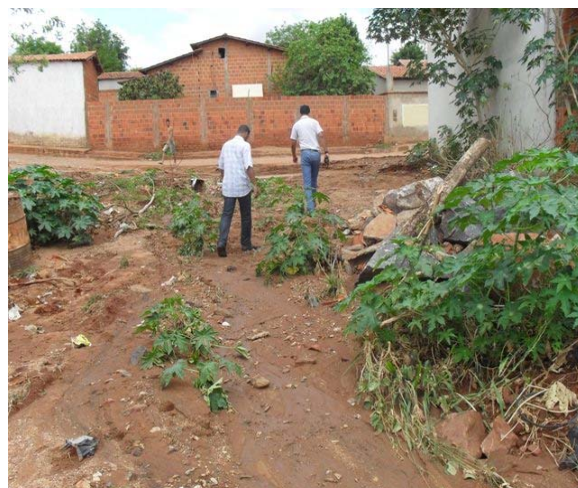
Foto 8: Área Crítica 4 – Rua Ruy Barbosa – área de erosão e alagamento.
