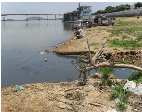
Foto 3: Ponto de lançamento de esgoto e drenagem no Rio – 02 tubos de DM 800 mm.
