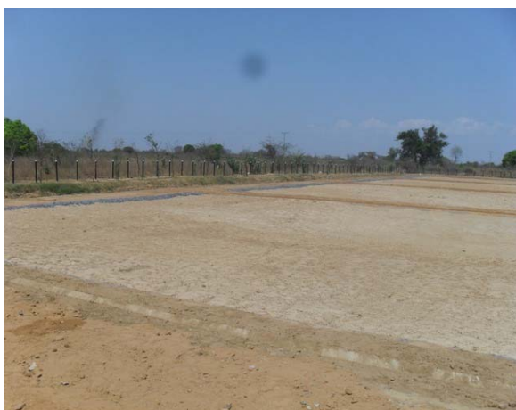
Foto 11: ETE sendo construída pela CODEVASF.
