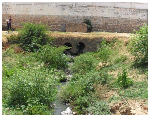
Foto 2: Ponto de lançamento de esgoto e drenagem no Rio – 02 tubos de DM 800 mm.
