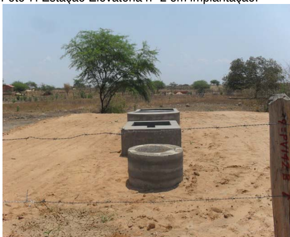
Foto 9: Estação Elevatória nº 3 em implantação.
