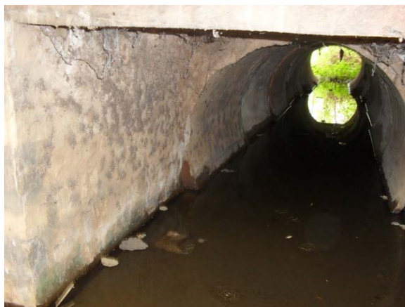
Foto 2: Ponte sobre o Riacho – muito lixo – ponto de lançamento de esgoto.
