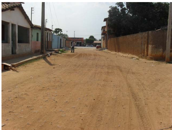
Foto 1: Trecho com rede de drenagem – apresenta pontos de esgoto clandestinos.
