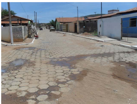
Foto 9: Área Crítica 5 – Rua Ivan Dias Fernandes – área de alagamento.
