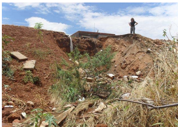
Foto 6: Av. São Sebastião Alcântara – ponto de lançamento de esgoto secundário. Não se vê exatamente o tudo, mas ele escoar para o bueiro.
