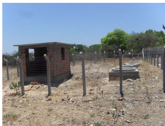
Foto 6: Estação de Tratamento de Esgoto – em fase de conclusão situada no Povoado Bairro do Carmel no Município de Xique-Xique – obra paralisada.
