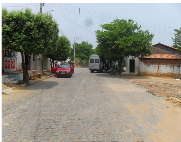
Foto 5: Área Crítica 1 – Av. Elias Pereira de Souza – área de enxurrada.
