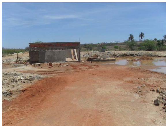
Foto 4: Construção da Estação Elevatório de Esgoto.
