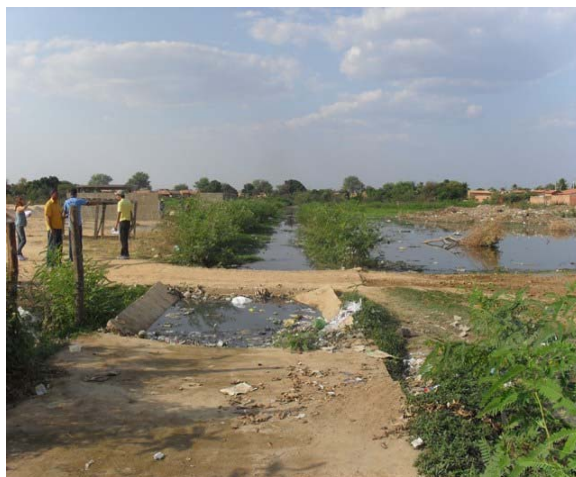
Foto 8: Canal 1 – Bairro Beira Rio – lançamento na Lagoa Beira Rio.
