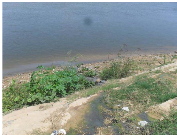
Foto 2: Esgoto lançado diretamente no Rio São Francisco.
