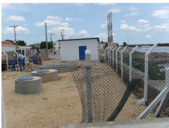
Foto 3: Estação Elevatória (EE 5 do projeto) - em fase de conclusão.
