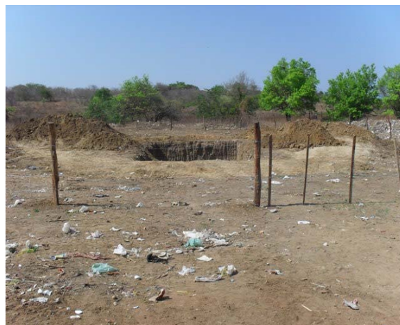
Foto 8: Estação Elevatória de Esgoto em construção – Bairro São Gotardo.
