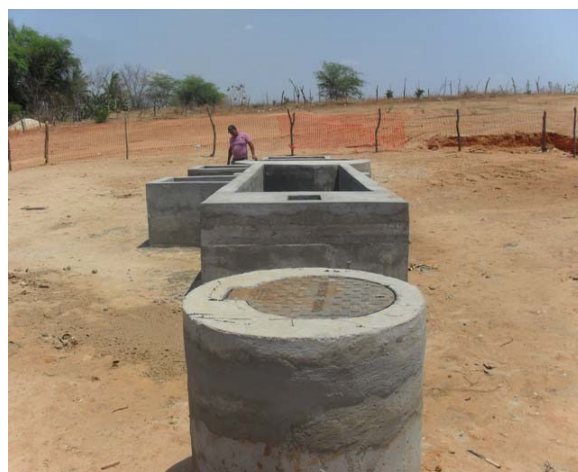
Foto 6: Estação Elevatória nº 2 em implantação.
