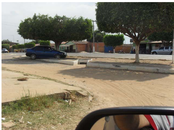
Foto 13: Trecho com rede de drenagem.
