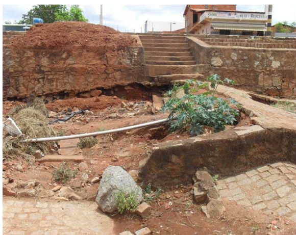
Foto 13: Galeria enterrada na estrada para Santana.
