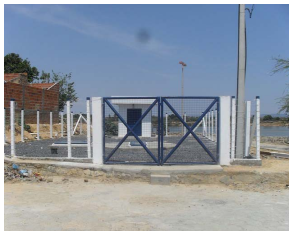
Foto 4: Estação Elevatória recentemente construída.
