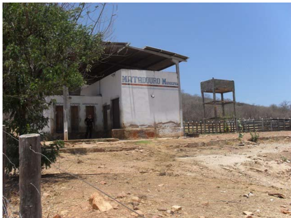
Foto 13: Matadouro – fossa construída a certa de 3 meses (fossa com sumidouro) e está localizada aproximadamente 80 m do Rio Paramirim.
