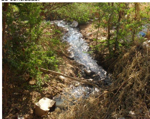
Foto 18: Ponto de lançamento de esgoto a céu aberto – tubo de concreto com DN 300 mm – escoamento para o Rio.
