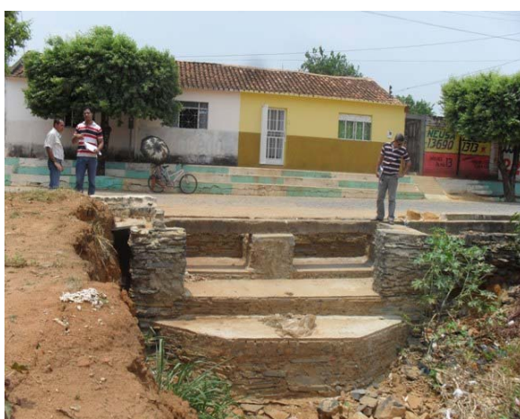
Foto 11: Início da obra do Canal de macrodrenagem.
