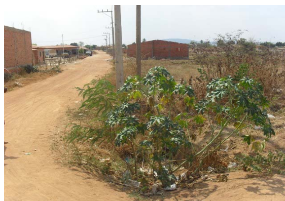
Foto 12: Vista a jusante do bueiro que atravessa a Av. José Eduardo Porto – dá vazão as águas de alagamento.
