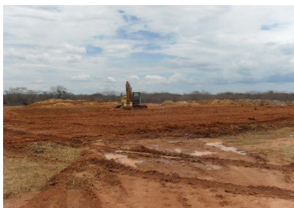
Foto 4: Área de implantação da ETE – início dos trabalhos de terraplanagem.
