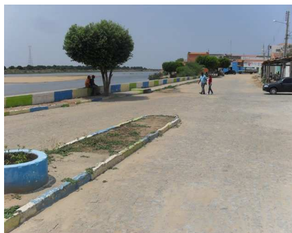
Foto 6: Área do Cais – ponto de inundação – última ocorrência grave foi em 1992 visto ter atingido o telhado das casas.
