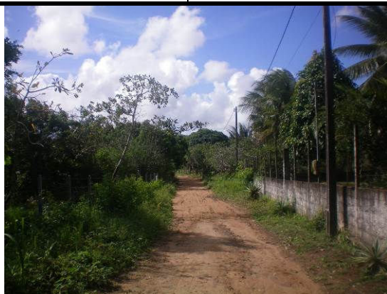
Via de Acesso Principal a Localidade de Biribeira
