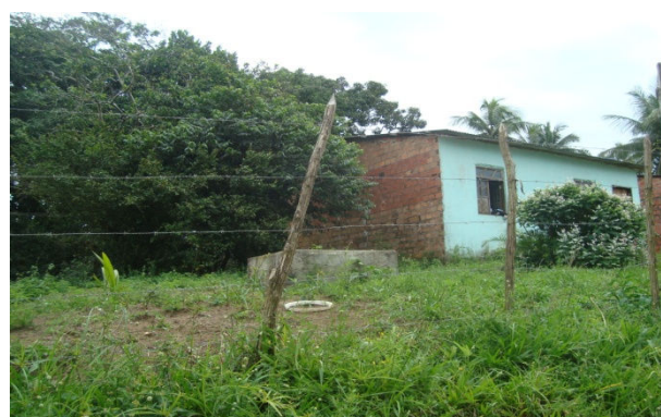
Figura 6.51 - Base do Reservatório de 2.000 L – Comunidade de Barragem
