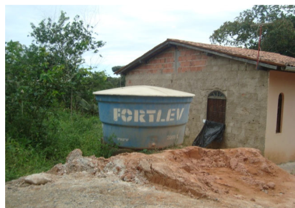
Figura 6.45 - Reservatório de 2.000 L (RAD 2), Comunidade Pedreira Carangi
