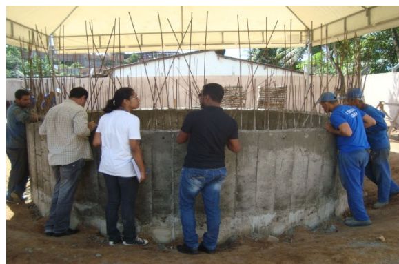
Figura 6.62 - Estação Elevatória de Esgoto (EE-2), em Instalação, Jardim Campo Verde
