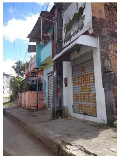
Figura 6.18 - Via Coletora B: Mobiliário Desordenado
