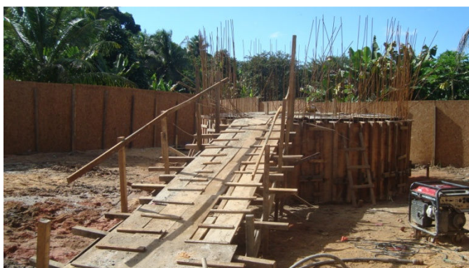
Figura 6.55 - Estação Elevatória de Esgoto (EE-1), em Instalação, Jardim Campo Verde
