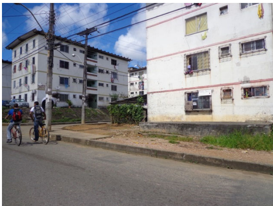
Figura 6.13 - Via Coletora B: Calçadas Descontínuas e Ciclistas
