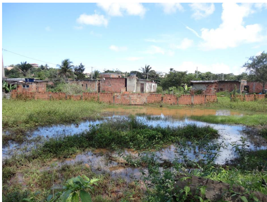
Figura 4.1 - Áreas Alagadas Devido a Drenagem Deficiente – Ocorreu depois da Construção das Casas. Coord.: UTM 8.573.735 / 568.212
