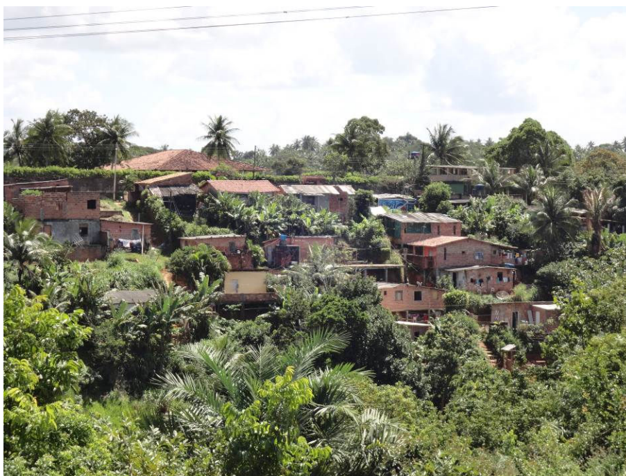
Figura 8.9 - Construção de Residências em Terrenos de Declividade Forte. Coord.: UTM 8.574.589 / 568.513
