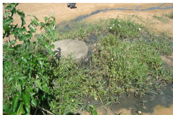
Figura 6.58 - Poço de Visita Transbordando, Esgoto a Céu Aberto – Jardim Campo Verde
