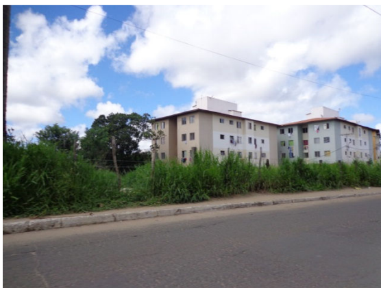
Figura 6.5 - Via Coletora B: Pavimentação e Calçadas
