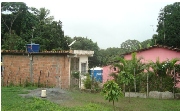
Figura 6.38 - Vista Parcial da Localidade Pedreira Aratu
