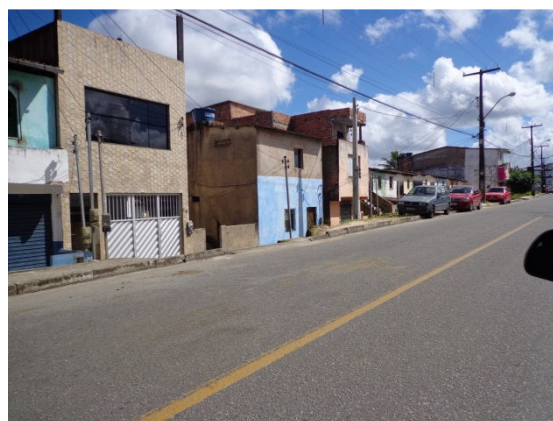
Figura 6.16 - Via Coletora B: Edificações Implantadas abaixo do Nível da Rua
