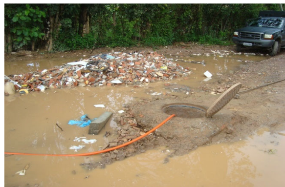
Figura 6.105 - Ponto de Entulho Vias de Acesso, Comunidade do Bosque Ipitanga
