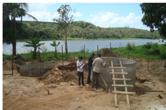
Figura 6.64 - Estação Elevatória de Esgoto (EE-4), em Instalação, Nova Esperança, as Margens da Represa Ipitanga 3
