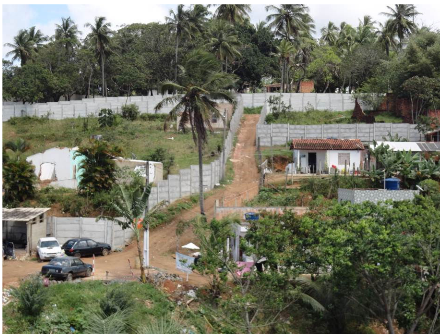
Figura 8.8 - Abertura de Vias de Acesso Desprovida de Drenagem Superficial no Sentido do maior Declive. Coord.: UTM 8.576.407 / 568.975
