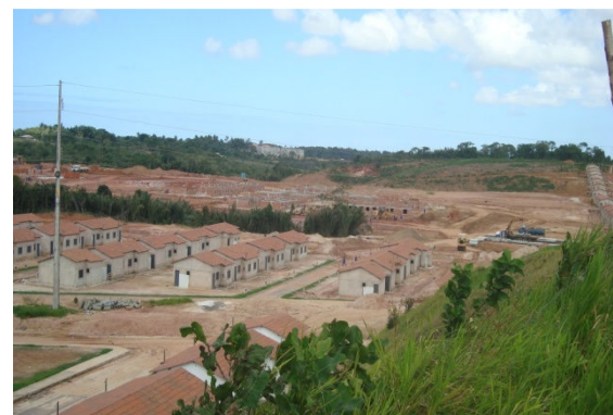
Figura 6.72 - Unidades Habitacionais em Construção, Loteamento Ceasa (Demanda por Rede de Esgoto)
