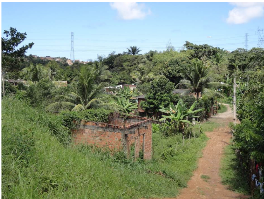
Figura 8.14 - Ocupação na Planície do Rio Ipitnaga em Áreas Suscetíveis a Alagamento. Coord.: UTM 8573628/ 567671
