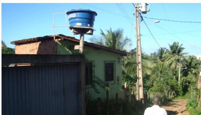
Figura 6.20 - Reservatório com Tampa, Comunidade Alto do Girassol
