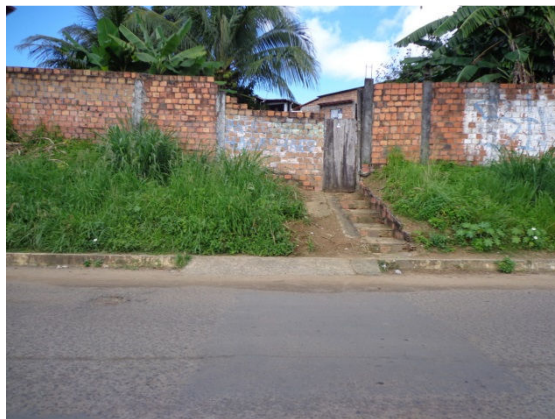
Figura 6.8 - Via Coletora B: Acesso Precário
