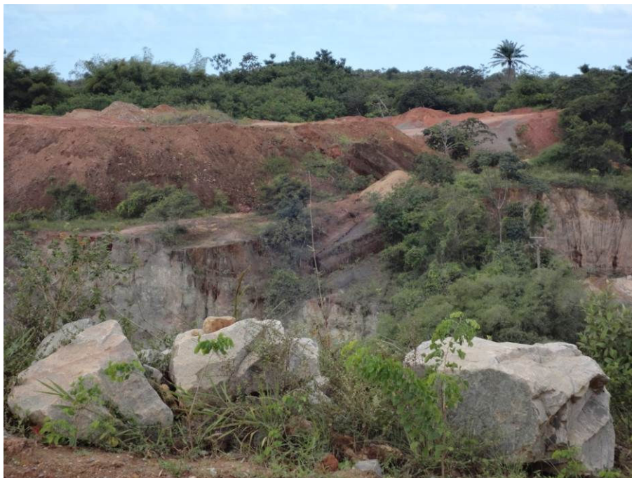
Figura 8.3 - Área da Pedreira Carangi Mostrando Área de Material de Expurgo e Blocos de Rocha Soltos Coord.: UTM 8.576.721 / 566.042
