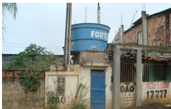
Figura 6.47 - Reservatório de 2.000 L, Localidade de Biribeira
