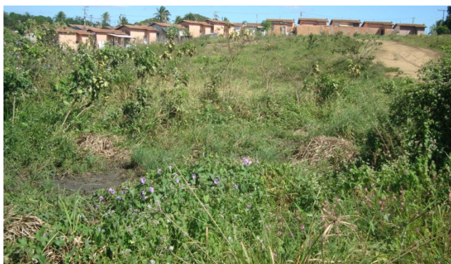
Figura 6.61 - Outra Fossa Séptica que Recebe Esgoto o Coletado do CH Jardim Campo Verde, Praticamente Soterrada
