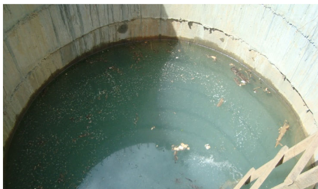
Figura 6.65 - Estação Elevatória de Esgoto (EE-4), em Instalação, Nova Esperança, as Margens da Represa Ipitanga 3
