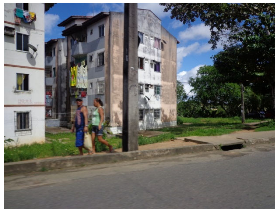
Figura 6.14 - Via Coletora B: Descontinuidade da Calçada
