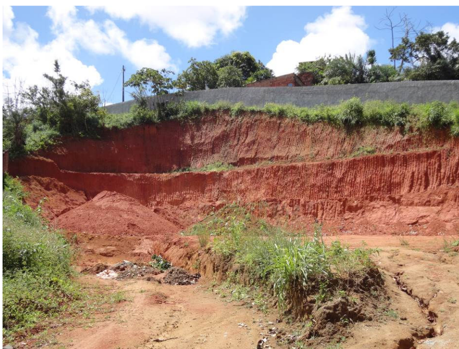
Figura 4.11 - Área de Corte Vertical do Embasamento Cristalino Aparentando Boa Estabilidade. Coord.: UTM 8.573.658 / 567.482
