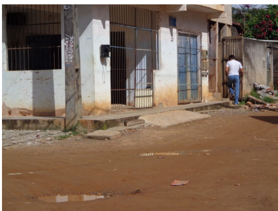
Figura 6.34 - Calçada Estreita e Desprovida de Rampa
