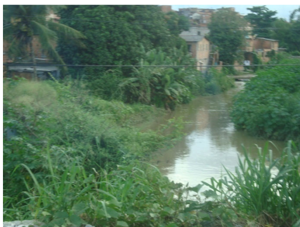
Figura 4.36 - Ocupações Irregulares na Área de Preservação Permanente do Rio Ipitanga entre os Bairros de São Cristóvão e Cassange
