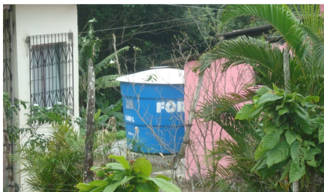
Figura 6.41 - Reservatório de 2.000 L, localizado na casa de seu Mário, Comunidade Pedreira Aratu
