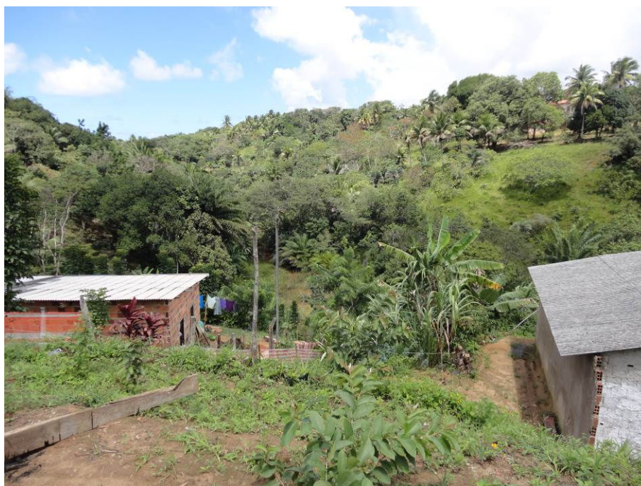
Figura 8.10 - Residências Construídas em Área de Vertente com Corte para Nivelamento do Terreno. Coord.: UTM 8.575.346 / 567.412
