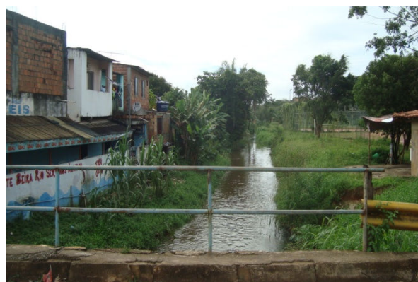
Figura 6.13 - Ponte sobre Rio Ipitanga, Limite entre Cassange e São Cristóvão, Comunidades do Bosque Ipitanga e Vila Santana (Lado Esquerdo da Ponte Loteamento Parque São Cristóvão)
