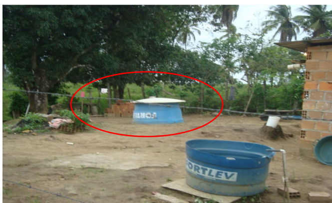
Figura 6.44 - Reservatório de 2.000 L Furado
