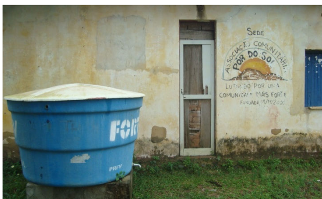
Figura 6.34 - Reservatório de 2.000 L, Loteamento Pôr do Sol
