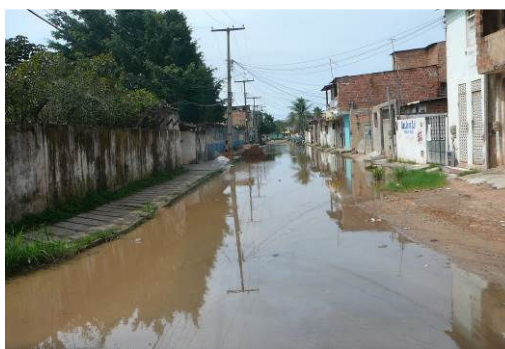
Figura 4.24 - Via de Circulação Alagada
