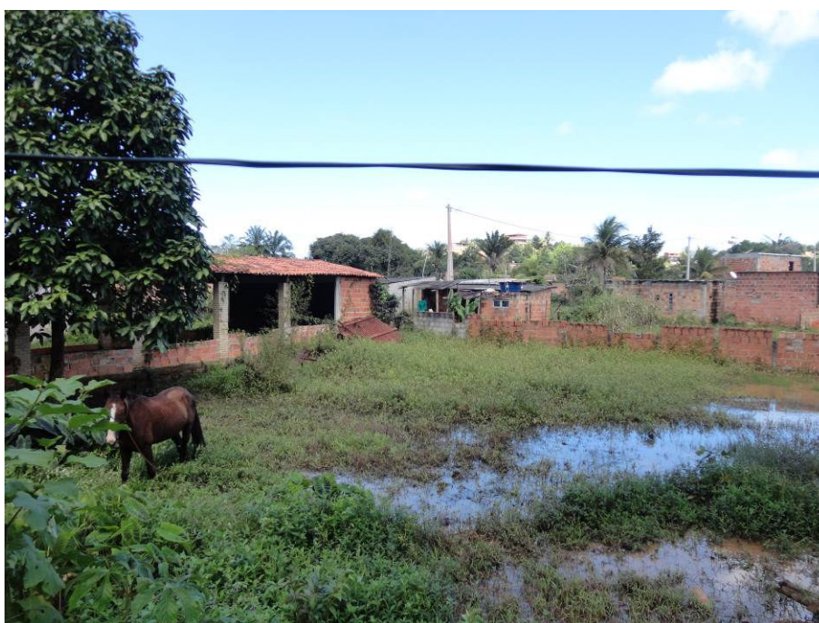
Figura 8.12 - Áreas Alagadas Devido ao Bloqueio da Drenagem Natural pelos Muros de Alvenaria e Construções. Coord. UTM 8.573.735 / 568.212
