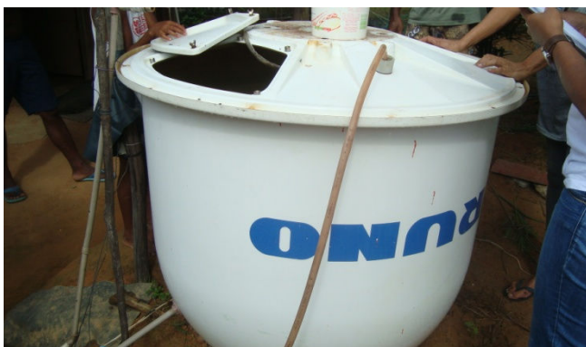
Figura 6.32 - Reservatório (Reutilização de Reservatório que Armazenava Produto Químico) que Armazena Água Captada em Poço
