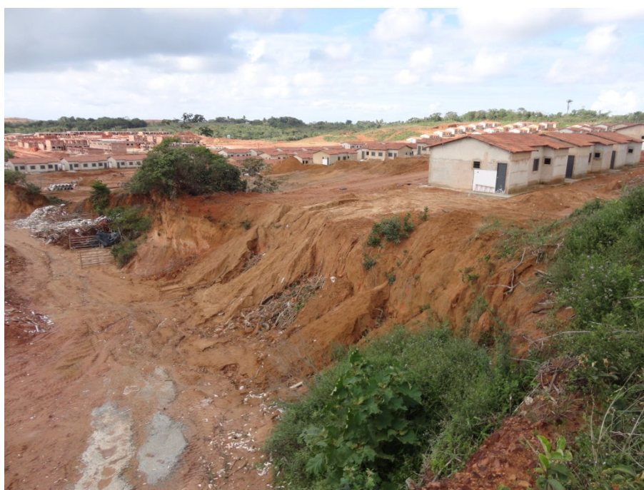
Figura 4.14 - Processos Erosivos em Taludes nas Áreas de Terraplanagem para Construção de um Conjunto Habitacional. Coord.: UTM 8.580.452/ 567.118
