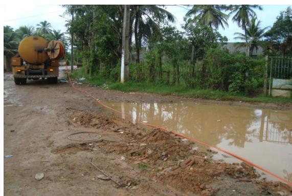
Figura 6.74 - Equipamento da Embasa, Desobstruindo Rede de Esgoto, Comunidade do Bosque Ipitanga
