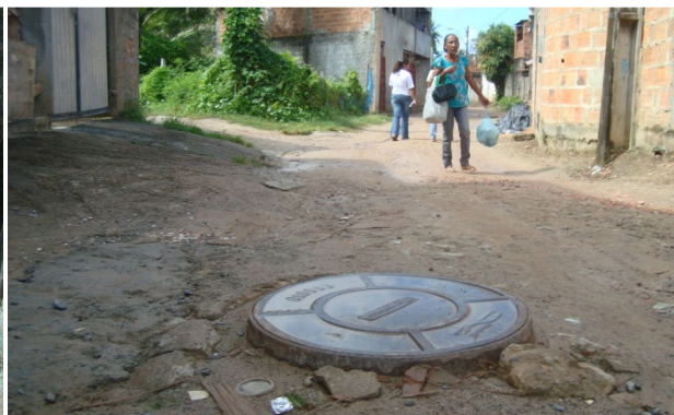
Figura 6.76 - Poço de Visita (PV), Loteamento Vila Santana
