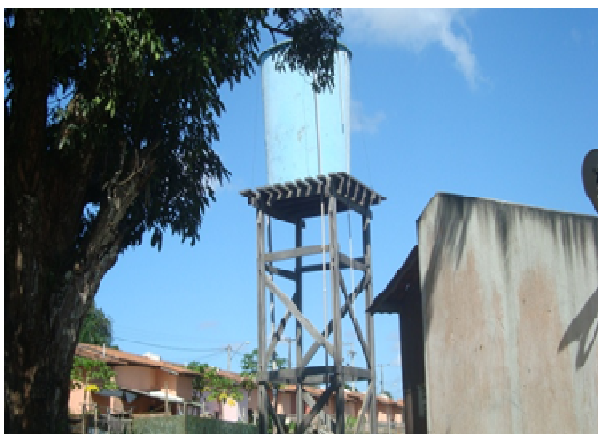
Figura 6.8 - Reservatório Elevado (RED), Atualmente Desativado, CH Jardim Campo Verde
