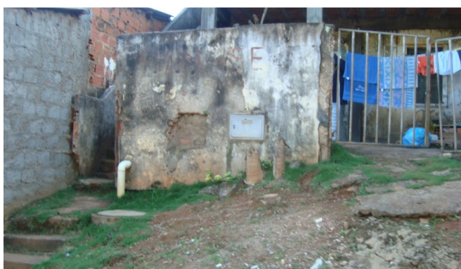
Figura 6.22 - Instalação de Hidrômetros em Algumas Casas
