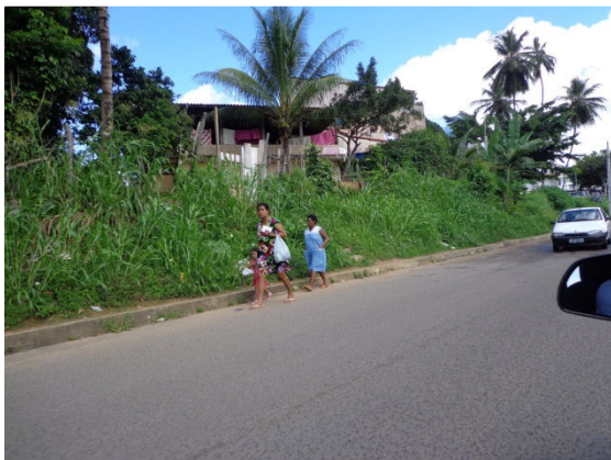
Figura 6.7 - Via Coletora B: Via Desprovida de Calçada
