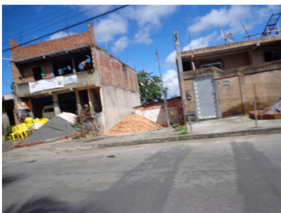
Figura 6.15 - Via Coletora B: Material de Construção na Calçada
