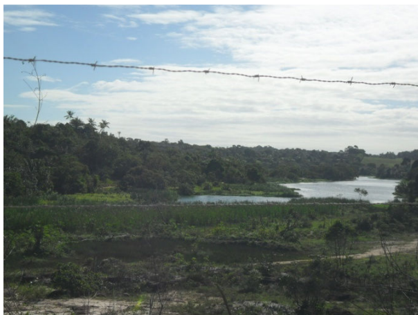
Figura 2.9 - Vista do Reservatório da Represa Ipitanga III – Área Interna Próxima a Lavra de Extração de Arenoso, Localidade CEPEL
