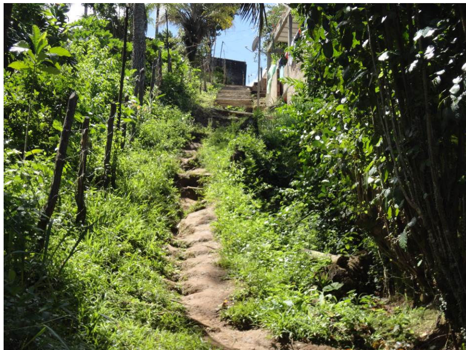
Figura 8.15 - Escadaria de Acesso em Área Íngreme Destruída pela Erosão Coord.: UTM 8.573.735 / 568.212
