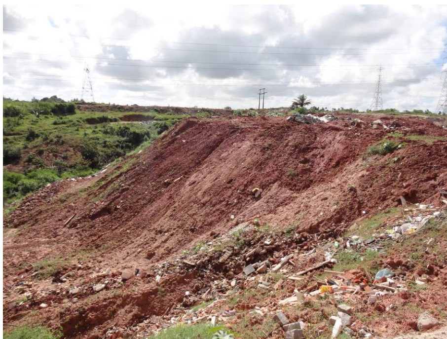
Figura 6.7 - Área de Disposição de Entulho. Coord.: UTM 8.575.196 / 568.973
