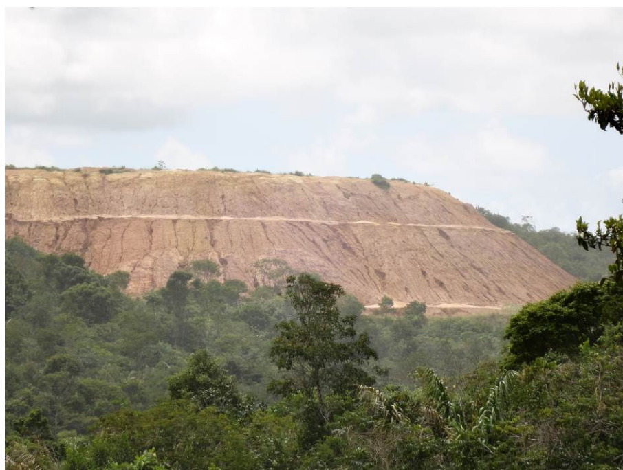
Figura 6.4 - Fotos de Talude de Corte de Áreas de Empréstimo de Material de Cobertura do Aterro Metropolitano. Coord.: UTM 8.579.077 / 567.379
