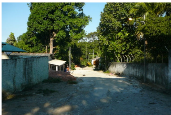
Figura 4.27 - Via sem Pavimentação
