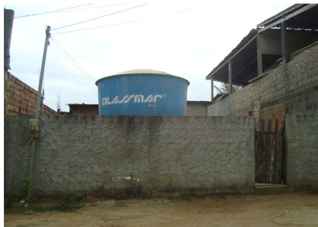
Figura 6.27 - Reservatório de 10.000 L, Instalado pela Comunidade
