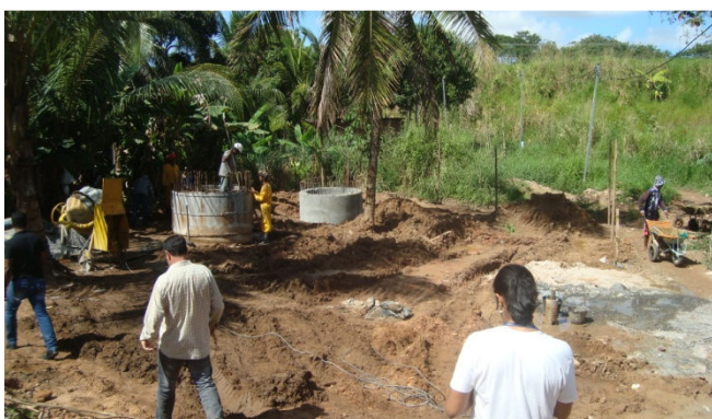
Figura 6.63 - Estação Elevatória de Esgoto (EE-3), em Instalação, Nova Esperança
