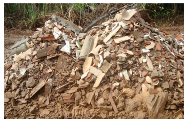
Figura 6.111 - Ponto de Entulho, Estrada que dá Acesso a Comunidade de Barragem
