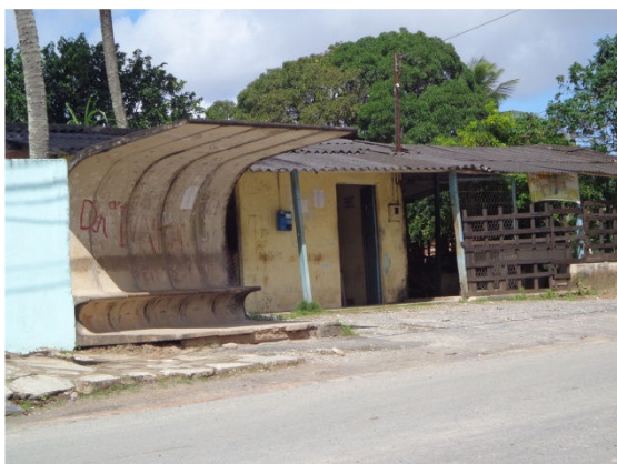
Figura 6.19 - Estrada das Pedreiras: Abrigo de Ônibus nas Proximidades da Pedreira Aratu
