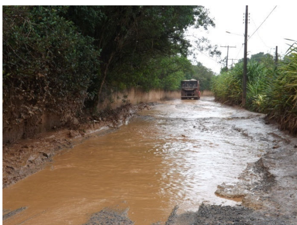
Figura 6.9 - Ausência de Infraestrutura Associada a Drenagem de Águas Pluviais – Localidade de Pedra Azul
