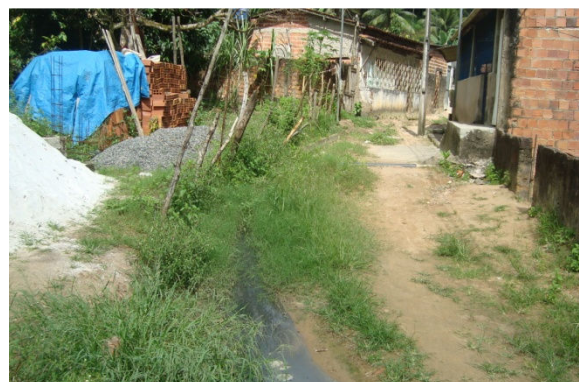
Figura 6.68 - Esgoto a Céu Aberto – Nova Esperança, Áreas de Baixada
