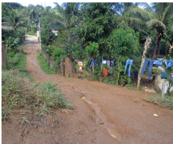
Figura 5.8 - Via sem Pavimentação, sem Drenagem e sem Calçada
