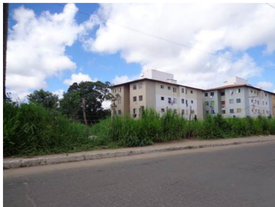
Figura 5.6 - Via Coletora B: Pavimentação e Calçadas
