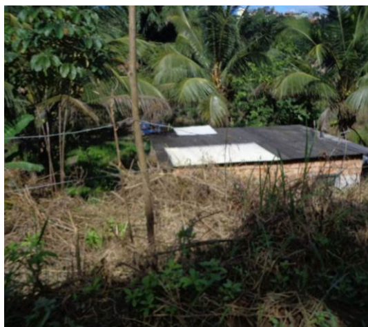
Figura 5.9 - Edificação Implantada abaixo da Cota de Nível da Via
