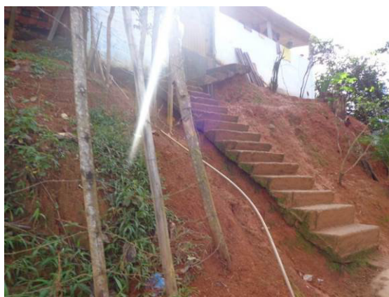
Figura 5.11 - Acessos em Unidades Habitacionais
