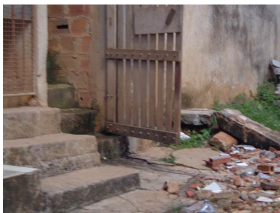
Figura 5.10 - Acessos em Unidades Habitacionais
