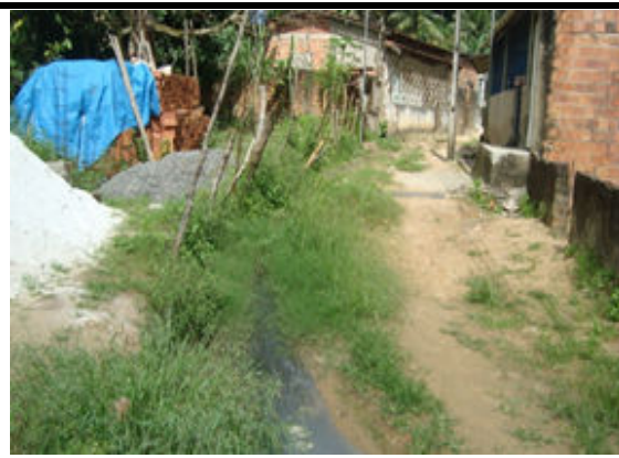
Esgoto Correndo a Céu Aberto na Localidade de Nova Esperança, Áreas de Baixada
