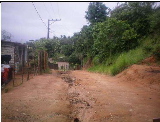
Via de Acesso Precário na Localidade de Carobeira “Buracão”
