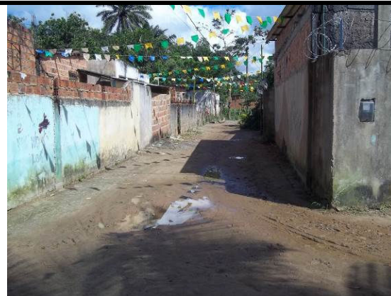
Padrão de Ocupação e Vias de Acesso, Localidade de Canto do Rio
