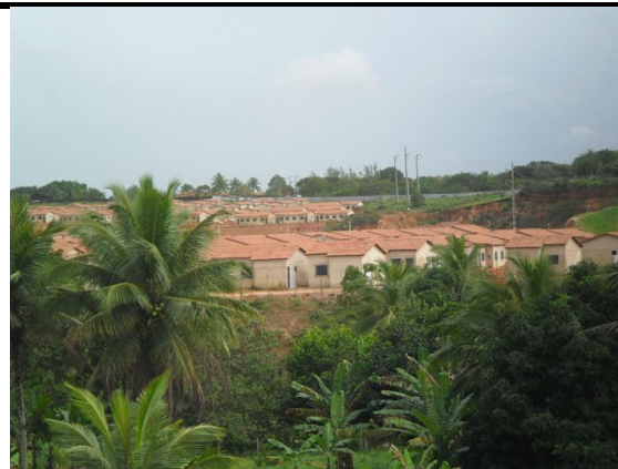
Vista Panorâmica da Localidade Loteamento Bom Sucesso
