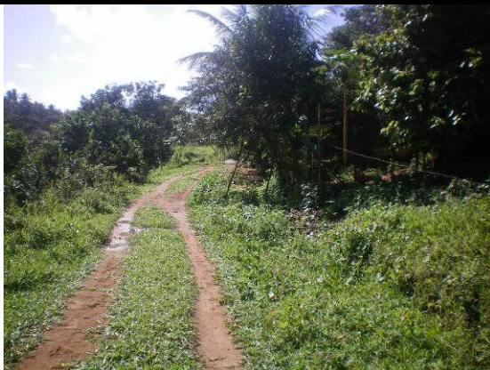
Via de Acesso de Padrão Rural, Localidade de Pôr do Sol
