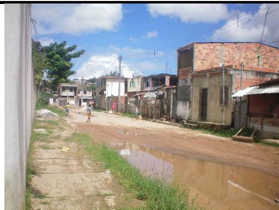
Precariedade do Sistema de Drenagem, Comunidade de Vila Santana
