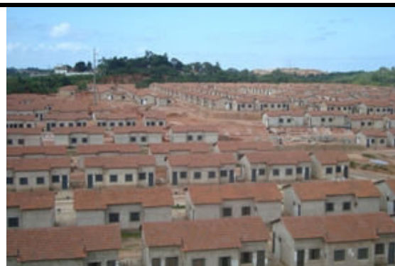
Unidades Habitacionais em fase de Conclusão, em Área Ampliada do Loteamento CEASA
