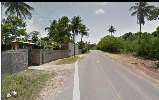
Ocupações Próximas à Estrada das Pedreiras, região da Localidade Coração de Maria
