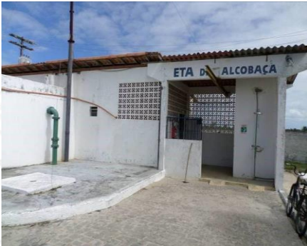
Foto 3 – ETA (Sistema Sede – Alcobaça)
