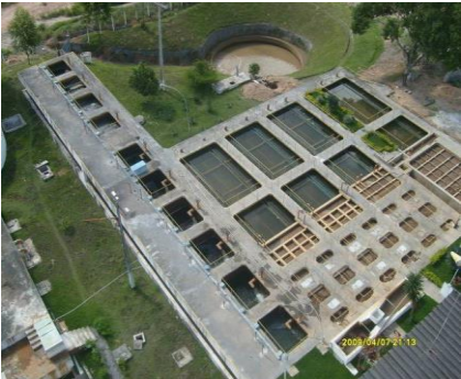
Foto 1 – Decantadores e Filtros (ETA Antiga – Eunápolis)
