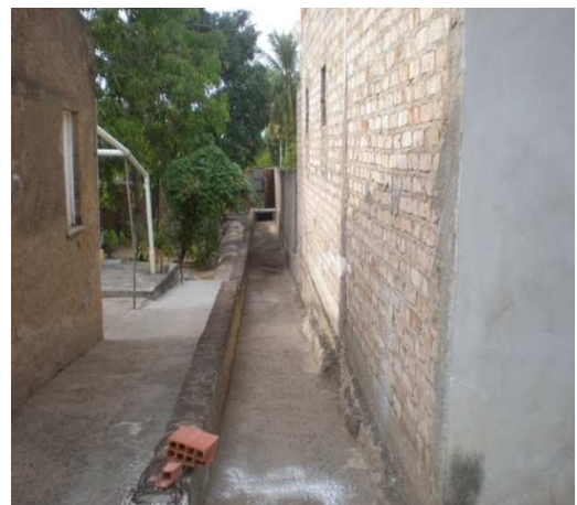
Foto 6: Galeria de Águas Pluviais
