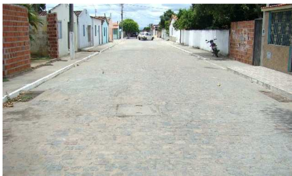
Foto 3: PV inicial da rede de drenagem principal da cidade executada em manilhas de 500 mm
