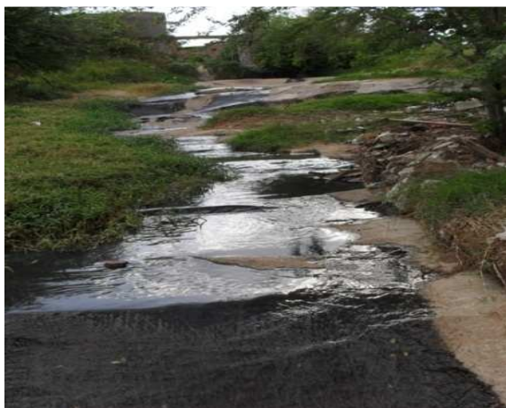
Foto 1: Trecho em que o Riacho Cairu escoar livre, embora receba contribuição de esgotos sanitários e apresente-se assoreado. É uma área crítica
