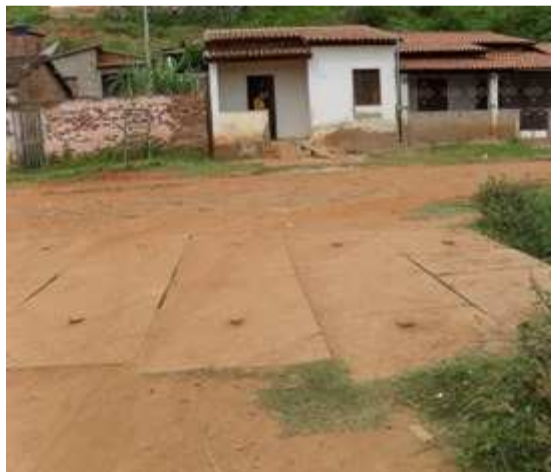
Foto 8: Rua Castelo Branco - ponte sobre a galeria
