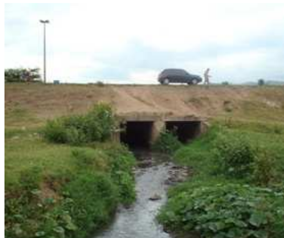
Foto 16: Final do canal sob a BA 052 - jusante
