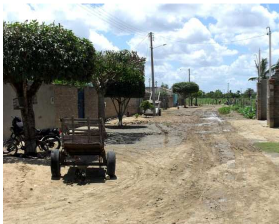
Foto 14: Área Crítica – Setor susceptível à inundação, convergente à principal várzea receptora do escoamento superficial de boa parte da cidade
