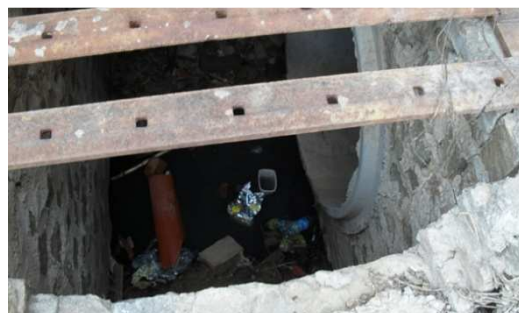
Foto 8: Detalhe da caixa de entrada com grelha horizontal, próximo a rua Araújo Sampaio
