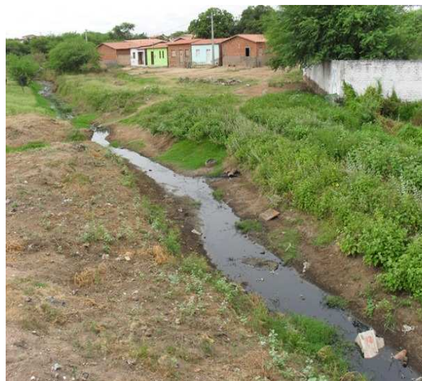
Foto 14: O córrego principal, em situação que se desenvolve não confinado, veiculando basicamente esgotos sanitários,
