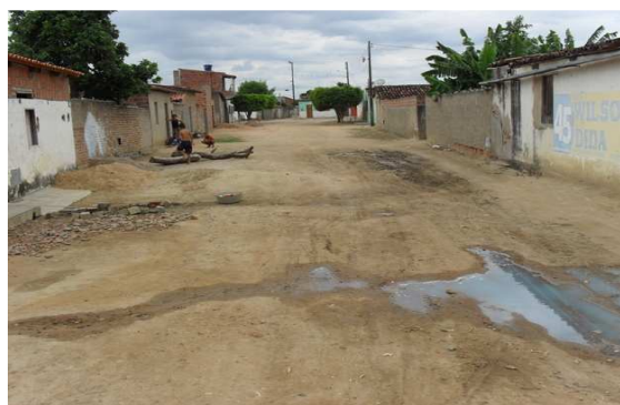
Foto 6: Área crítica, susceptível à inundação. Corresponde ao setor urbano situado na entrada da cidade, denominado “Populares”
