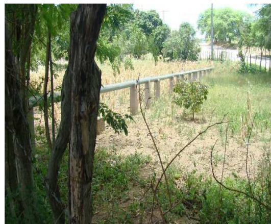
Foto 2: Adutora de esgotos chegando na ETE
