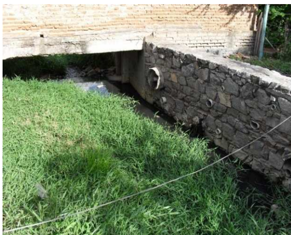
Foto 3: Ponto de lançamento das estruturas do "sistema informal" na calha retificada do Riacho Cairu, no centro da cidade
