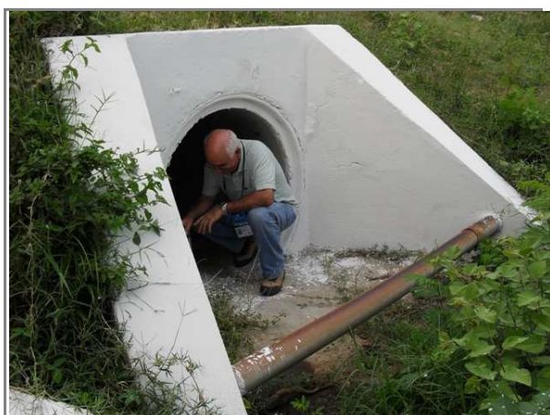
Foto 3: Bueiro para a passagem do principal veio de escoamento que adentra no setor urbano sob rodovia do acesso secundário à cidade
