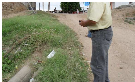
Foto 2: Manilha de saída de água – rua Laurindo Gonçalves com rua Durvalato Ribeiro
