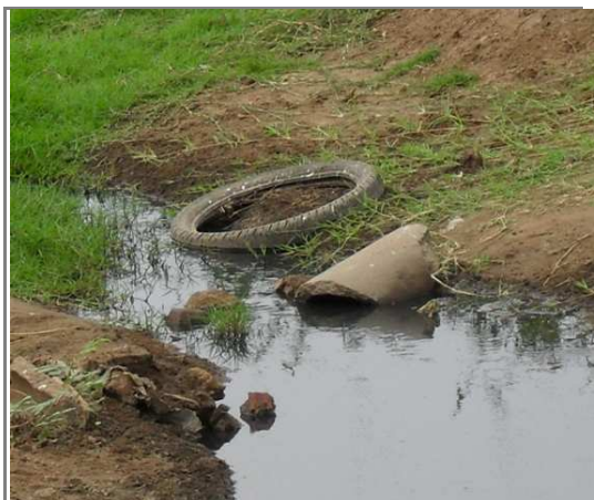
Foto 11: Ponto de lançamento, em condições críticas no córrego principal, de uma tubulação do sistema misto informal que atende uma parcela da cidade
