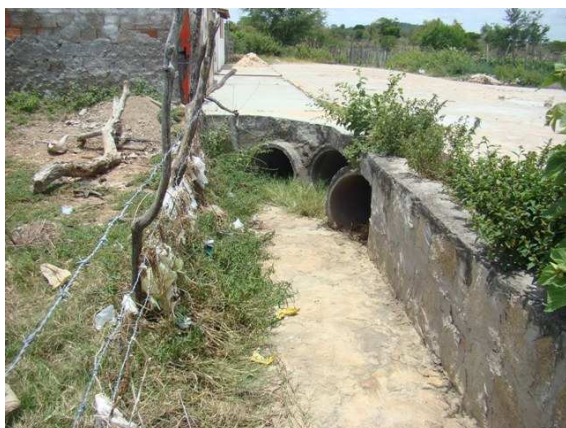
Foto 7: Macro drenagem, travessia da Rua José Alves
