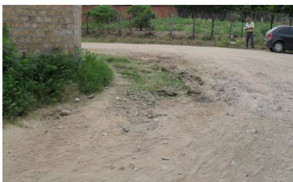
Foto 11: Área de inundação, cruzamento da rua Josefina com a rua Otilia
