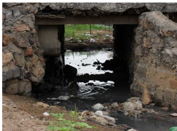
Foto 6: Pontilhão em construção sobre o córrego principal e ponto de lançamento de tubulação do sistema misto informal
