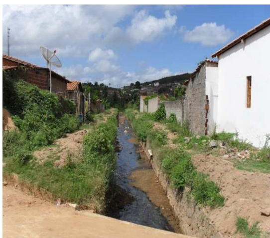
Foto 9: Canal revestido em alvenaria de pedra (Salgadinho)
