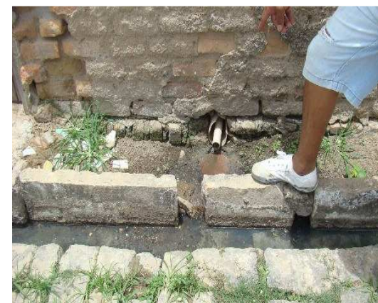
Foto 6: Detalhe de contribuição de esgoto secundário doméstico na calha aberta na rua Josefa Maria de Oliveira Silva
