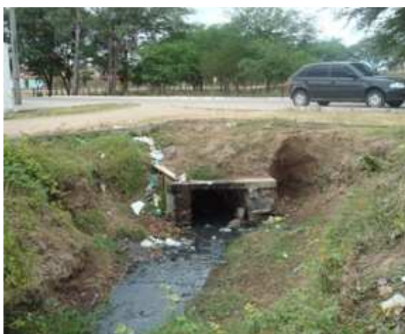
Foto 7: Final canal natural - início canal - lança canal revestido
