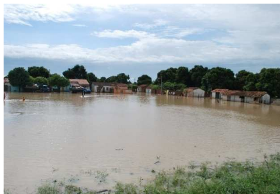
Foto 16: Inundação da área crítica ocorrida em outubro de 2009. Contornolândia
