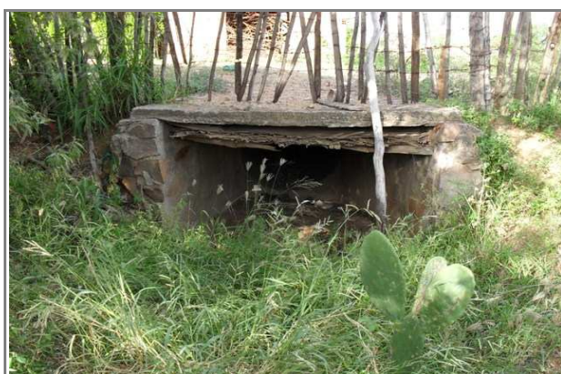
Foto 9: Estrutura do tipo "pontilhão" para a passagem do veio principal convergente à cidade
