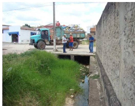
Foto 8: Saída da galeria de macro drenagem após a Rua José Alves
