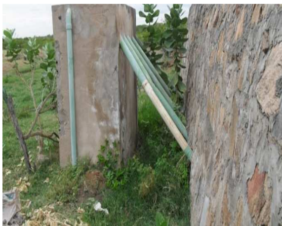
Foto 1: Estação de tratamento
