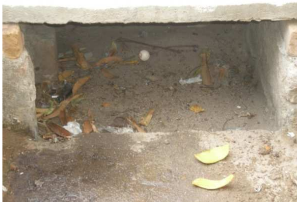
Foto 5: Acesso à galeria
