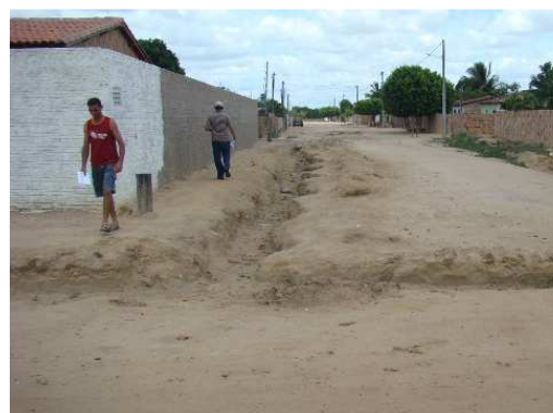
Foto 6: Vala aberta para escoamento do alagamento ocorrido em outubro de 2009
