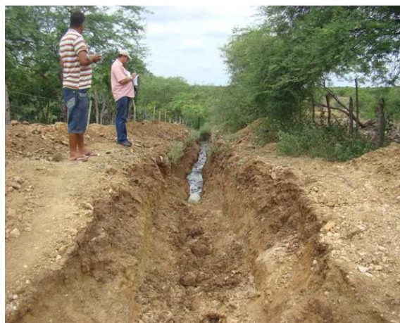
Foto 4: Ponto de lançamento de esgotos em direção ao Rio Jacuípe.
