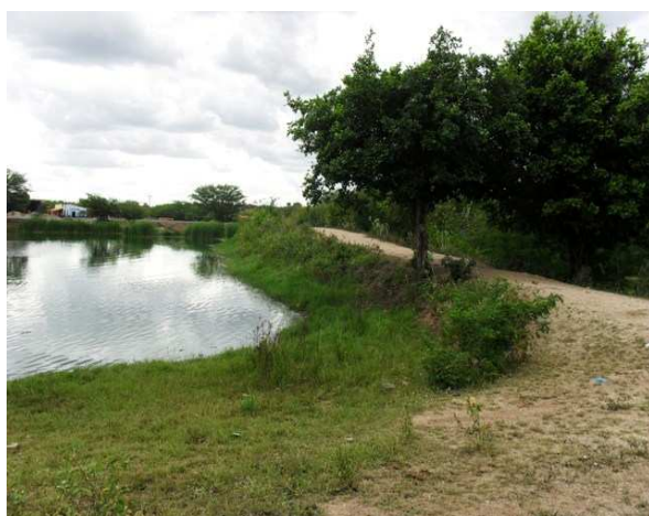
Foto 15: Barramento que provoca a detenção das águas do principal veio de escoamento, à jusante da mancha urbana
