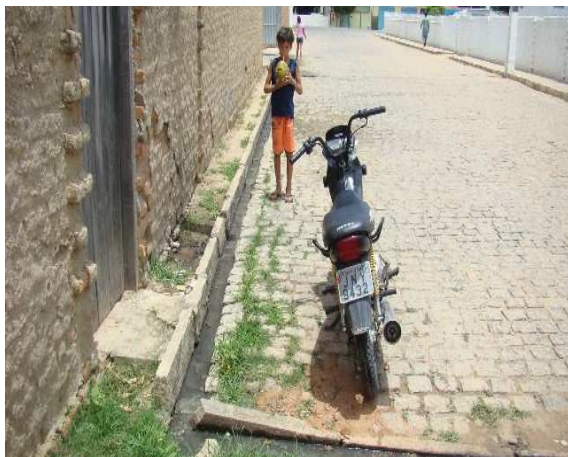
Foto 7: Valeta com esgotos secundários correndo a céu aberto. Rua Josefa Maria de Oliveira Silva
