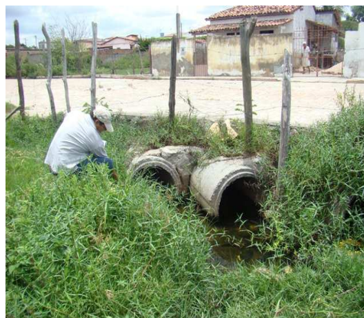
Foto 10: Ponto de descarte da macrodrenagem em área de pasto
