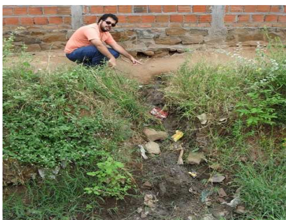
Foto 3: Lançamento de esgotos sanitários no córrego central, no centro da cidade
