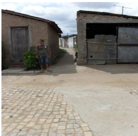
Foto 21: Beco por onde passa estrutura da macrodrenagem de parcela do setor urbano que descarrega diretamente no Rio Jacuípe
