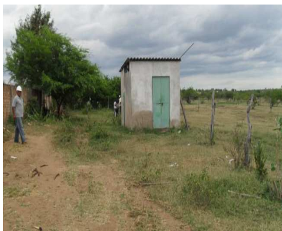
Foto 4: Vista da casa de bombas
