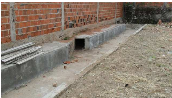
Foto 7: Detalhe da canaleta de saída da água – próximo a rua Araújo Sampaio
