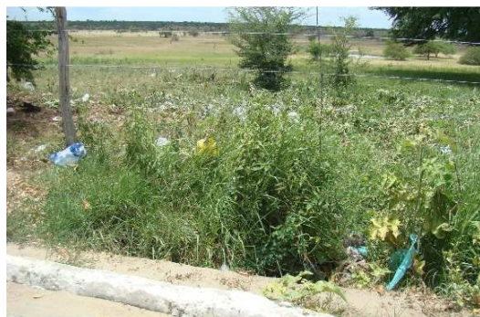
Foto 4: Ponto de descarga da rede de drenagem principal da cidade
