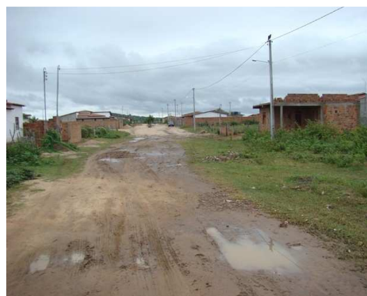
Foto 12: Travessa JK, ponto de alagamento
