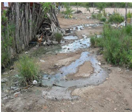
Foto 5: Esgoto a céu aberto
