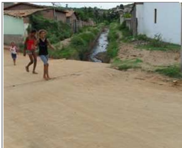
Foto 6: Área Crítica 5 – Rua da Corrida – baixada - ponto de alagamento
