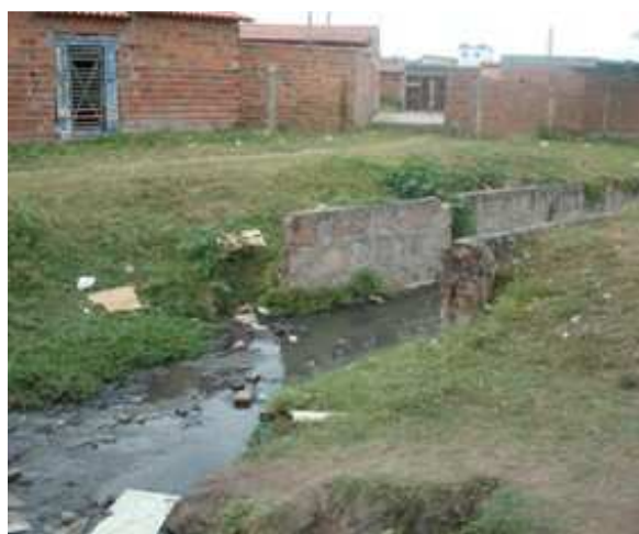
Foto 8: 2ª travessa João Evangelista - Início canal alvenaria de pedra_1
