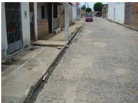
Foto 5: Valeta executada pela Prefeitura para carreamento de esgotos secundários na rua Manoel Nunes Cunha
