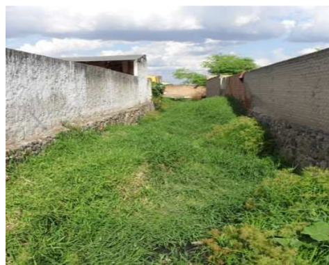
Foto 12: Trecho em que o Riacho Cairu está canalizado e é confinado pelas muradas de lotes
