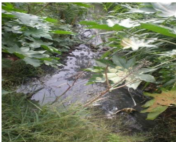
Foto 9: Passagem de esgoto
