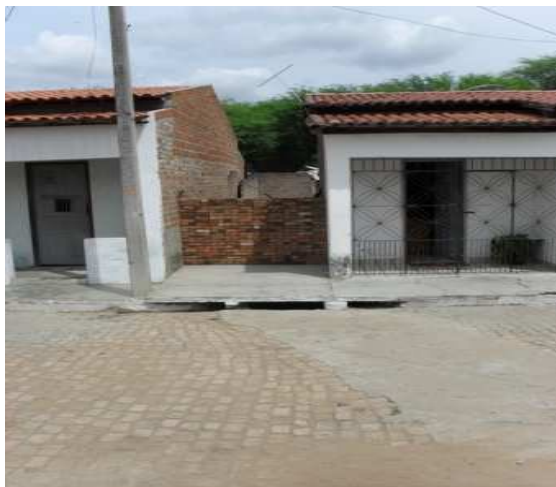
Foto 1: Beco por onde passa estrutura da macrodrenagem de parcela do setor urbano que descarrega diretamente no Rio Jacuípe
