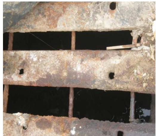
Foto 2: Caixa de passagem águas pluviais com grelha (detalhe)
