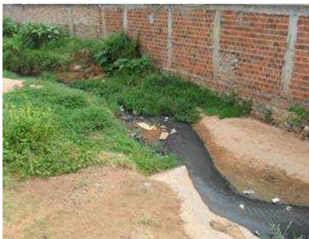
Foto: Galeria lançando esgotos no Riacho Salgadinho
