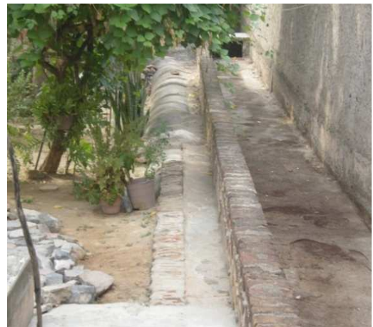
Foto 4: Tubulação e Galeria de águas pluviais – centro
