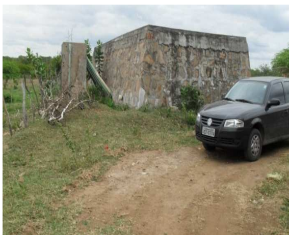
Foto 3: Vista parcial da Estação de tratamento
