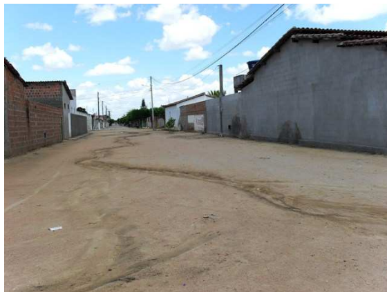
Foto 12: Vala expontânea do escoamento, em via não pavimentada, dos esgotos secundários, convergentes à várzea principal
