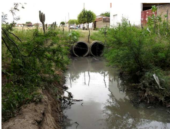
Foto 1: Ponto de descarga da drenagem pluvial no canal que conduz parcela das contribuições sanitárias
