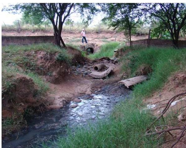
Foto 5: ETE desativada próxima a calha do Rio Jacuípe com importante contribuição de esgotos
