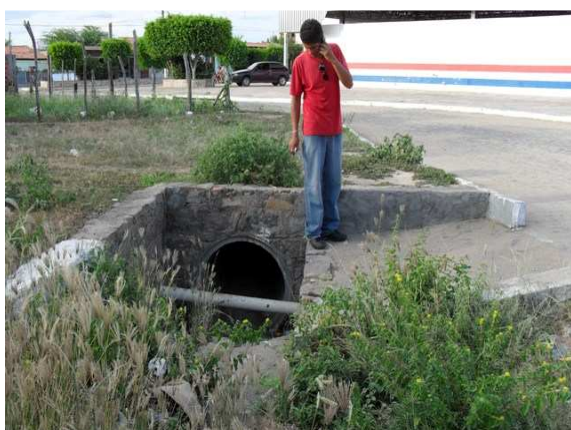
Foto 3: Estrutura que concentra as contribuições pluviais e sanitárias de amplo setor urbano, convergente à descarga principal
