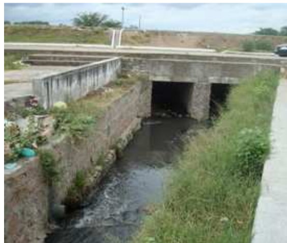
Foto 14: Final canal na Av. César Borges
