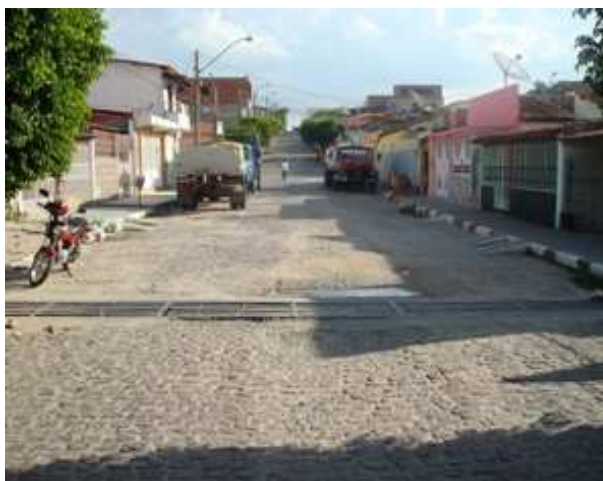
Foto 1: Rua Aida Curi - canaleta transversal_1
