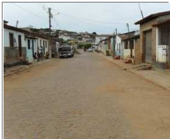
Foto 4: Área Crítica 4 - Rua Cosme de Farias - ponto de alagamento, vista da rua
