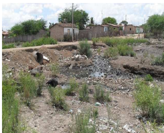
Foto 10: Chegada águas pluviais e esgoto no corpo receptor
