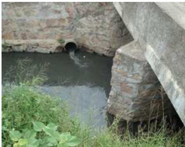
Foto 15: Lançamento drenagem da Av. César Borges
