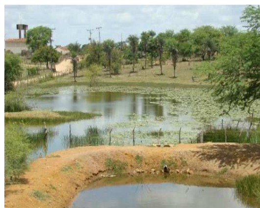
Foto 4: Tanque de macrófitas e lagoa de descarte da ETE
