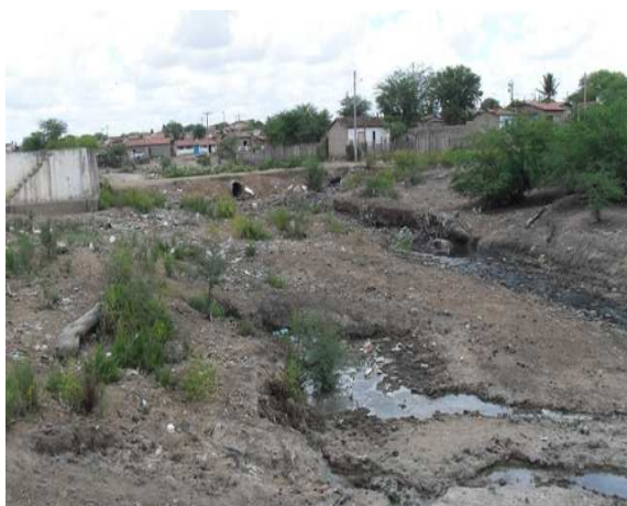
Foto 5: Drenagem natural – Alto do Cruzeiro com esgoto
