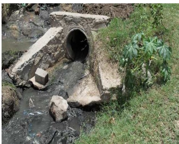
Foto 9: Chegada águas pluviais e esgoto no corpo receptor
