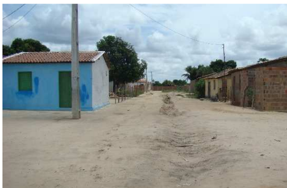
Foto 7: Vala aberta para escoamento de alagamento 2009
