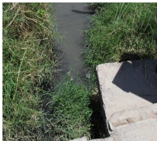
Foto 8: Saída de Galeria de Águas Pluviais com esgoto
