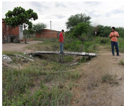
Foto 2: Trecho da vala de escoamento construída para disciplinar o leito do veio principal convergente ao miolo da cidade
