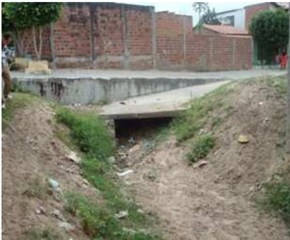
Foto 1: Final galeria- 2ª travessa Aida Curi
