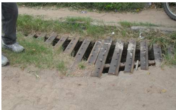
Foto 3: Caixa de entrada de galeria com grelha Horizontal - rua Durvalato Ribeiro
