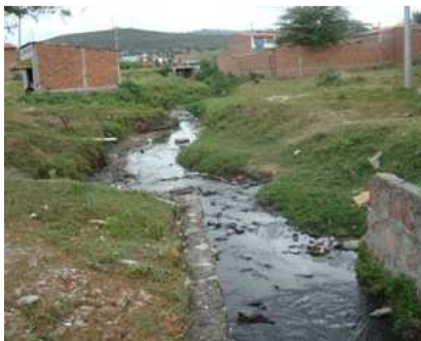
Foto 9: 2ª tv João Evangelista - Início canal alvenaria de pedra_2
