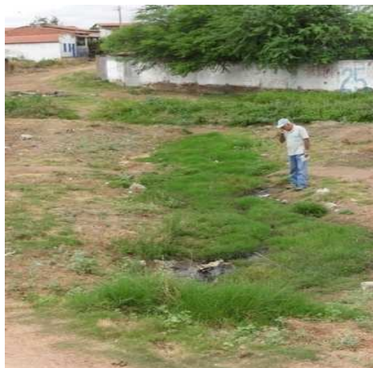
Foto 13: O córrego principal, em situação que se desenvolve não confinado, porém apresentando evidente degradação da condição ambiental
