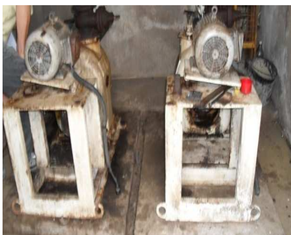
Foto 5: Detalhes das Bombas: EE - Esco XT3 auto-escorvante
