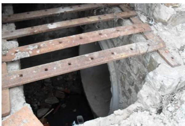
Foto 9: Detalhe da caixa de entrada com grelha horizontal próximo a rua Araujo Sampaio
