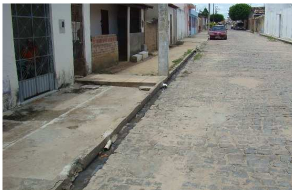
Foto 3: Valeta executada pela Prefeitura para carreamento de esgotos secundários na Rua Manoel Nunes Cunha
