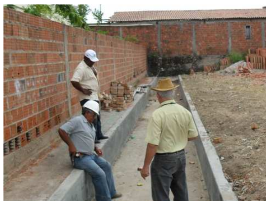
Foto 6: Canaleta, passagem da água próxima a rua Araujo Sampaio
