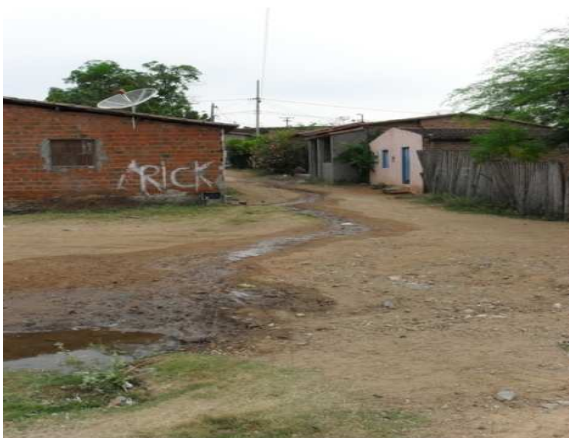
Foto 11: Águas servidas, convergindo ao riacho principal, advindas de setor não pavimentado e desprovido de tubulação coletora
