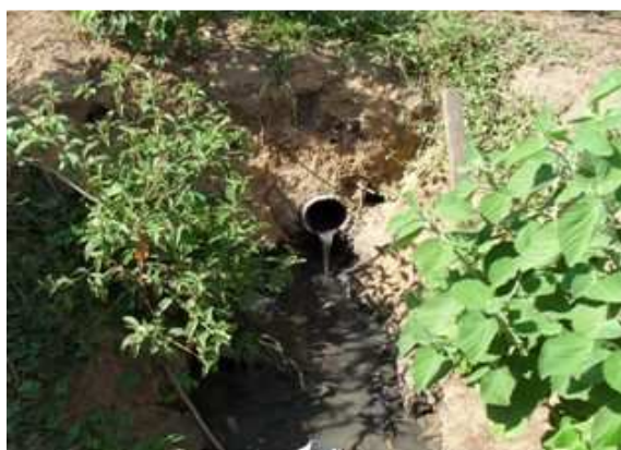
Foto 5: Ponto de lançamento de esgotos na vertente Sul
