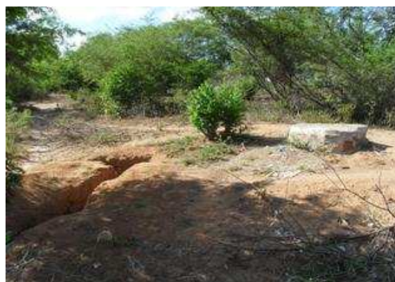
Foto 4: Ponto de lançamento de esgotos na vertente Sul
