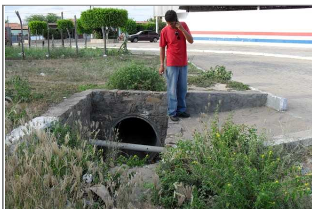
Foto 7: Estrutura que concentra as contribuições pluviais e sanitárias de amplo setor urbano, convergente à descarga principal
