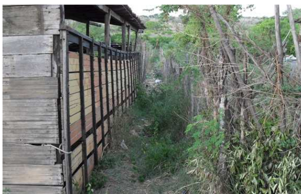
Foto 11: Passagem águas pluviais por quintais
