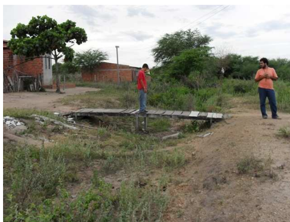
Foto 2: Trecho da vala de escoamento construída para disciplinar o leito do veio principal convergente ao miolo da cidade
