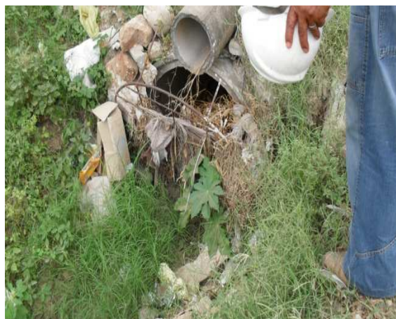
Foto 10: Detalhe saída da água (2 manilhas) - Travessa Laurindo Gonçalves
