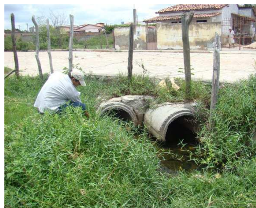
Foto 10: Ponto de descarte da macro drenagem em área de pasto
