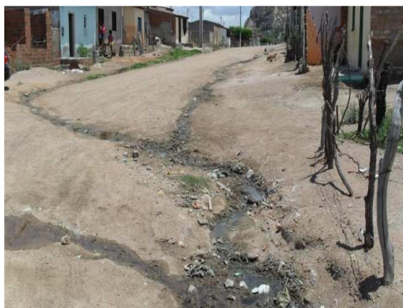
Foto 6: Esgoto a céu aberto
