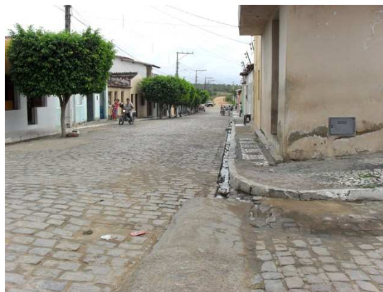
Foto 2: Lançamento de esgoto secundário em sarjeta, convergente ao setor baixo onde se estabelece a várzea receptora principal
