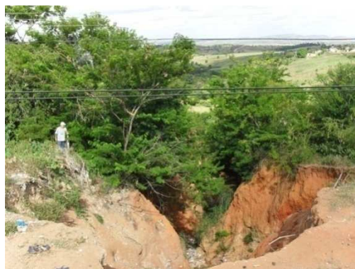
Foto 10: Outra vista da voçoroca localizada. O fenômeno foi provocado por indisciplinada convergência do escoamento superficial sobre a rodovia. Área crítica
