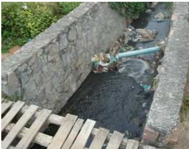
Foto 13: Adutora atravessando canal
