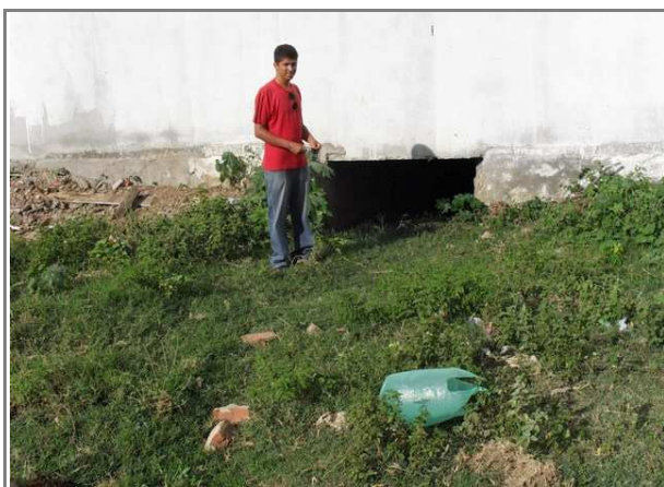
Foto 11: Ponto de passagem da drenagem pluvial sob um estabelecimento comercial
