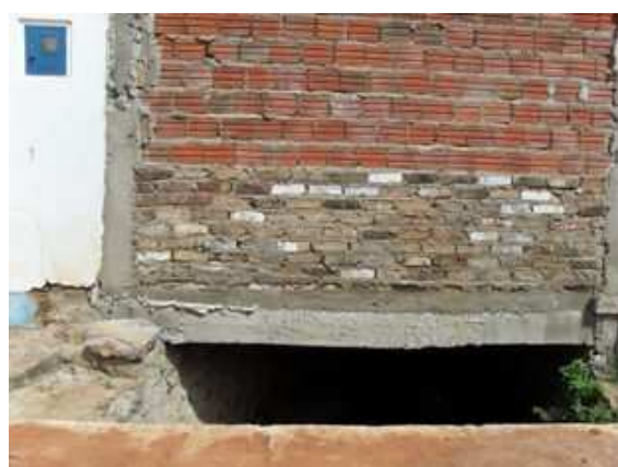
Foto 4: Galeria sob casas
