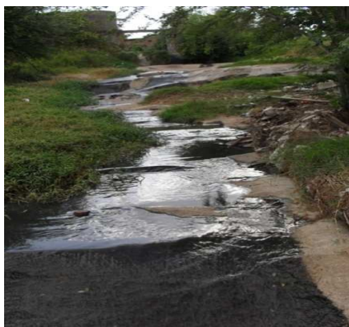
Foto 16: Trecho em que o Riacho Cairu escoar livre, embora receba contribuição de esgotos sanitários e apresente-se assoreado. É uma área crítica
