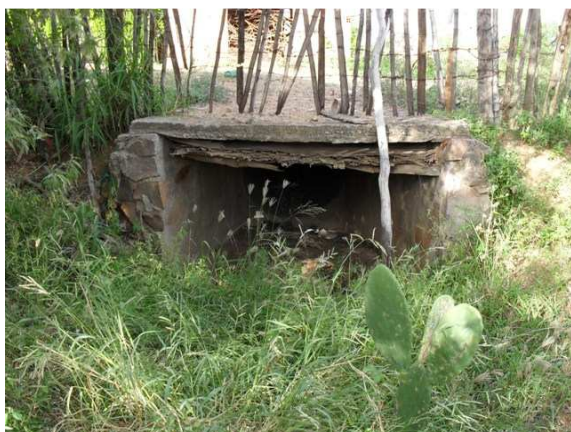
Foto 5: Estrutura do tipo "pontilhão" para a passagem do veio principal convergente à cidade
