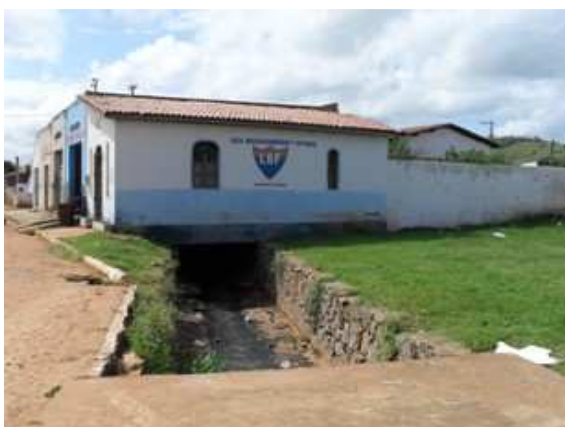
Foto 3: Galeria passando sob diversas casas
