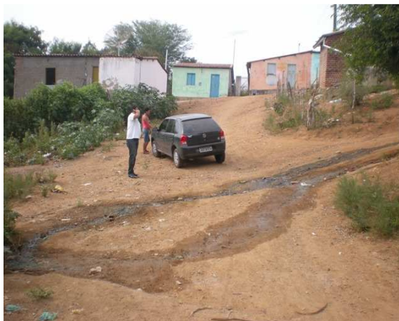
Foto 3: Esgoto correndo a céu aberto
