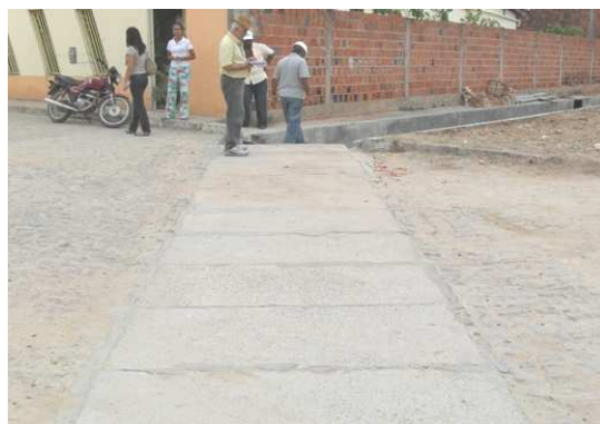
Foto 4: Galeria da rua Araujo Sampaio – extensão 6 metros (2x1)
