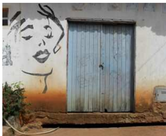
Foto 2: Galeria sob casas
