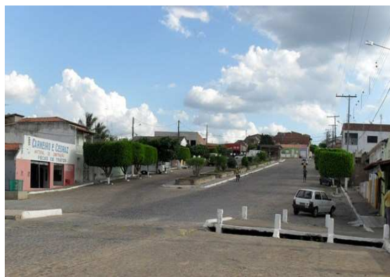
Foto 8: Travessia do trecho "endicado" do Riacho Cairu, sob a Avenida Bonfim, a principal artéria urbana. Área crítica, sujeita à alagamento
