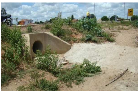
Foto 11: Vista de jusante do bueiro sob a BA 418
