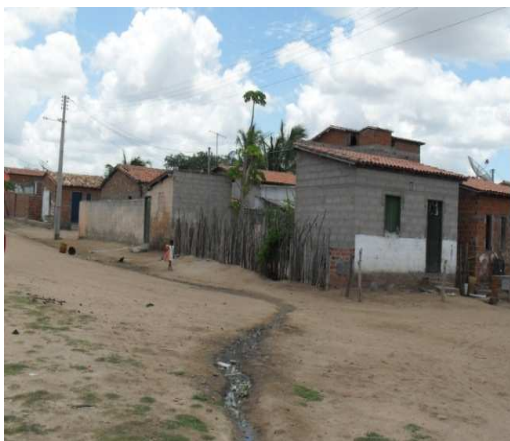
Foto 1: Esgoto a céu aberto
