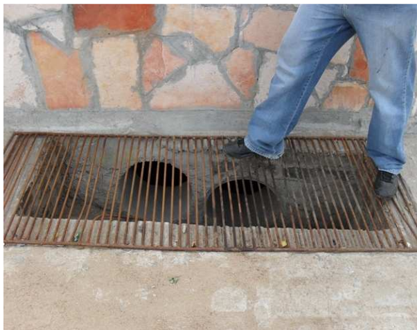
Foto 5: Estrutura (tipo boca-de-lobo) para captação das águas pluviais que se concentram nas proximidades do centro de abastecimento
