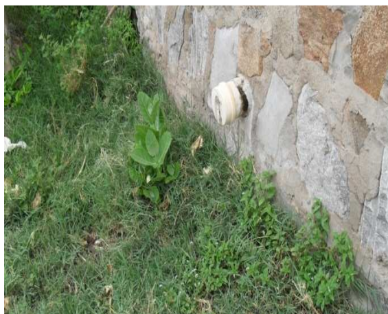
Foto 2: Detalhe do tubo da saída do lodo
