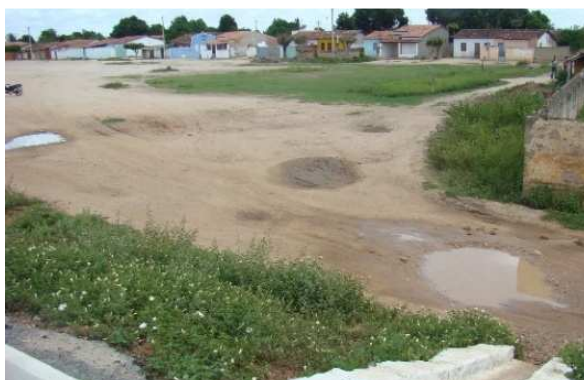
Foto 5: Bairro Contornolândia, área crítica de alagamento
