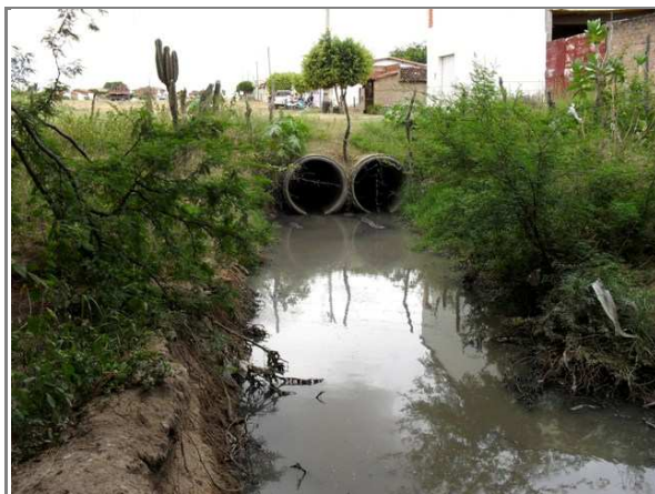
Foto 1: Ponto de descarga da drenagem pluvial no canal que conduz parcela das contribuições sanitárias
