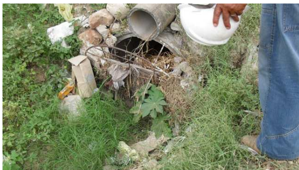
Foto 1: Detalhe da drenagem com duas manilhas – rua Laurindo Gonçalves
