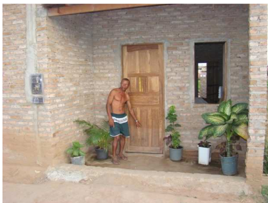
Foto 7: Residência atingida pelo alagamento da Baixa da Presa. Travessa 14 de maio.
