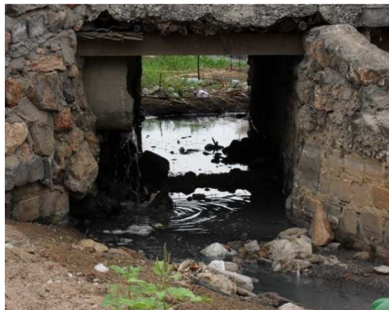
Foto 12: Pontilhão em construção sobre o córrego principal e ponto de lançamento de tubulação do sistema misto informal
