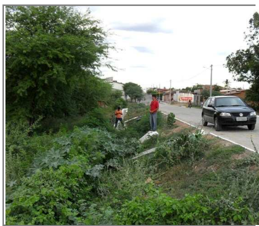
Foto 4: Rodovia que dá acesso a Capela de Alto Alegre. Denota-se, a estrutura do tipo "bueiro" para a passagem do veio que adentra ao setor urbano
