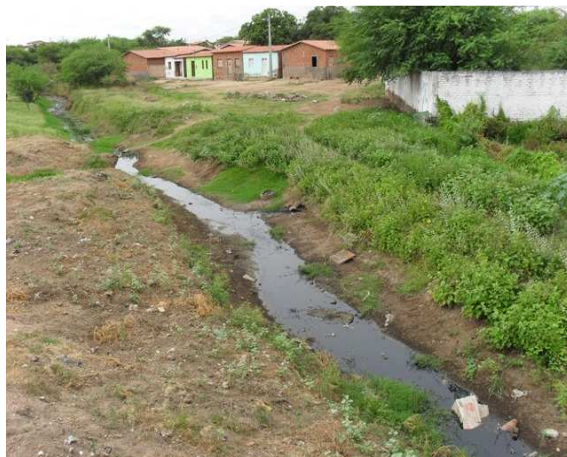
Foto 8: O córrego principal, em situação que se desenvolve não confinado, veiculando basicamente esgotos sanitários
