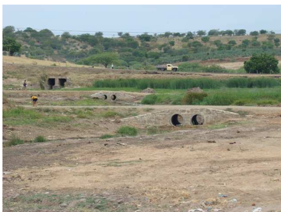
Foto 3: Baixa da Presa vendo-se ao fundo o bueiro sob a BR 407 que causa alagamento na área
