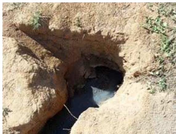
Foto 2: Ponto de lançamento de esgotos na vertente Sul
