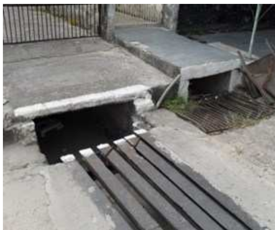
Foto 2: Rua Aida Curi - Final canaleta transversal_2
