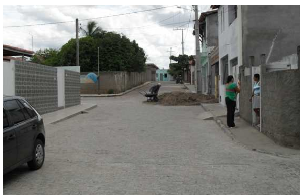
Foto 12: Área crítica de alagamento
