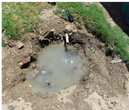
Foto 4: Ponto de acumulação de esgoto secundário em setor urbano onde a fossa absorvente é insuficiente à infiltração.
