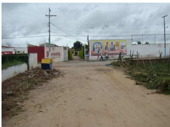
Foto 11: Ponto de alagamento da Av. JK
