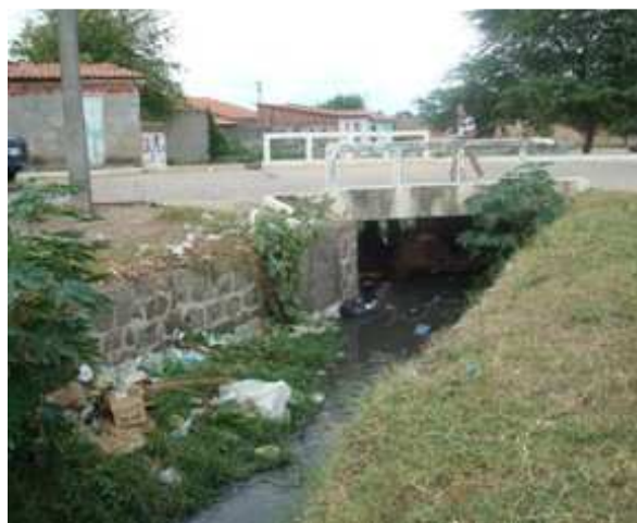
Foto 10: Rua Daniel Ferreira-travessia_1
