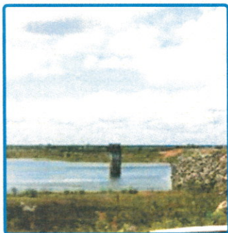
RESERVATÓRIO DE SÃO JOSÉ DO JACUIPE
