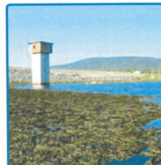
RESERVATÓRIO DE FRANÇA
