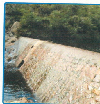
SAA PALMEIRAS - VISTA PARCIAL DA BARRAGEM DE NÍVEL
