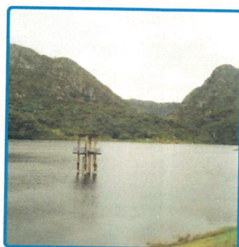
SIAA DE ANTÔNIO GONÇALVES - VISTA GERAL DO LADO DA BARRAGEM DO AIPIM
