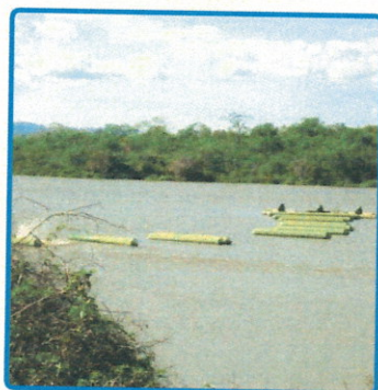
SAA BRUMADO - CAPTAÇÃO FLUTUANTE, RIO DE CONTAS
