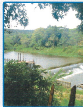
SAA DE ILHÉUS - SISTEMA SAA CAPTAÇÃO DE ÁGUA DA EM
