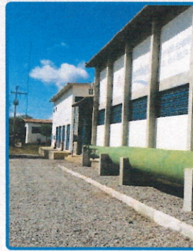
ESTAÇÃO ELEVATÓRIA DE BRUTA NO INÍCIO DA ADUT DE PEDRAS ALTAS
