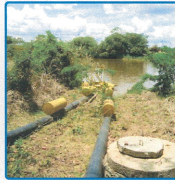
SIAA SANTANA - ÁREA DA CAPTAÇÃO, RIO CORRENTE
