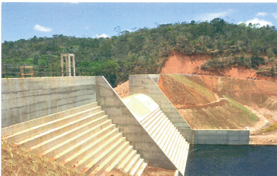
Figura 3.21: Barragem do Rio Tijuco
