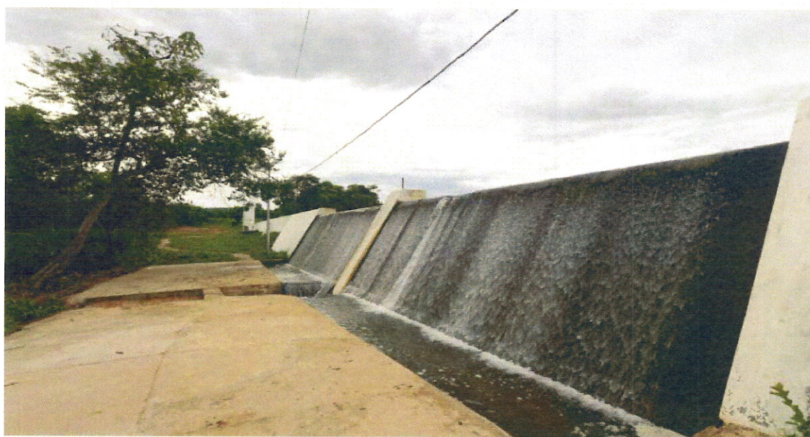
Figura 3.23: Barragem Cabeceira do Rio.
