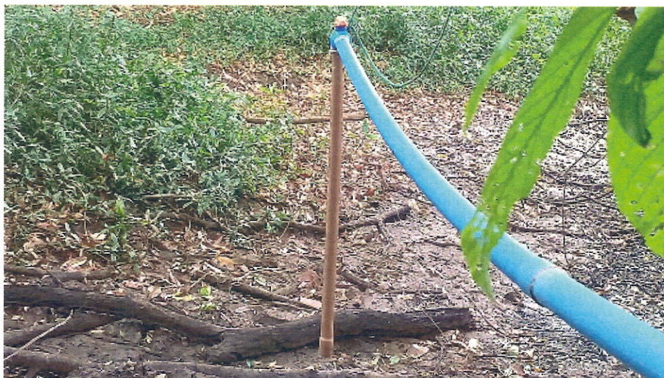
Figura 3.25: Estrutura de captação de água aparente no Rio Utinga
