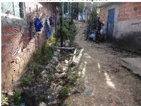
Foto 3.83 - Esgotamento sanitário e drenagem urbana em vala a céu aberto em Marcelino - Bom Despacho
