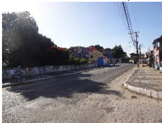
Foto 3.95 - Rua Ubaldo Osório Pimentel, sede de Itaparica
