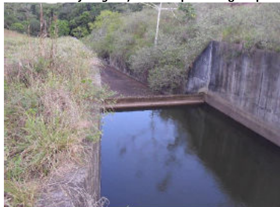
Foto 4.2 - Vertedor da Barragem de Tapera (antes do fusegate ) – Município de Jaguaripe
