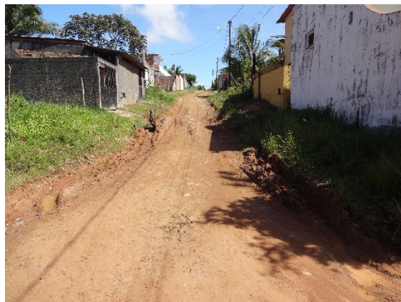
Foto 3.107 - Via sem infraestrutura urbana – Porto dos Santos
