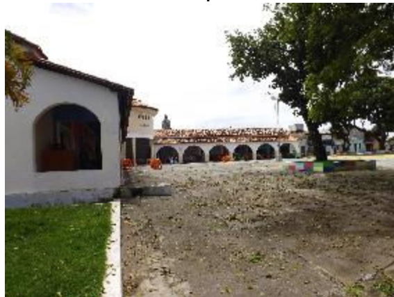
Foto 3.74 - Vista do Mercado à Rua Regis Pacheco – sede do município
