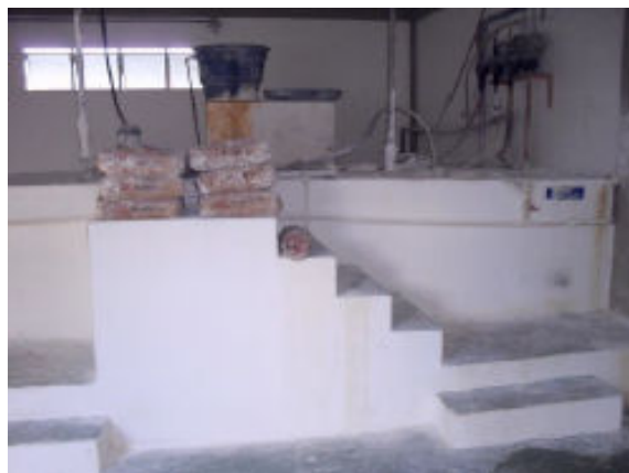
Foto 4.17 - Tanques de mistura de hidróxido de cálcio
