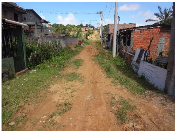
Foto 3.106 - Via sem infraestrutura urbana – Porto dos Santos
