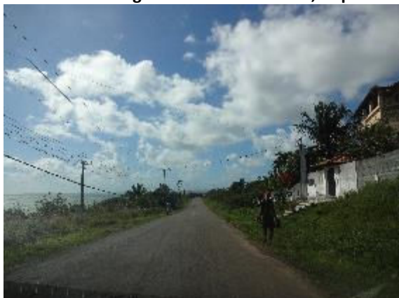
Foto 3.91 - Rodovia BA-533 – Trecho entre Manguinhos e Porto Santos, Itaparica
