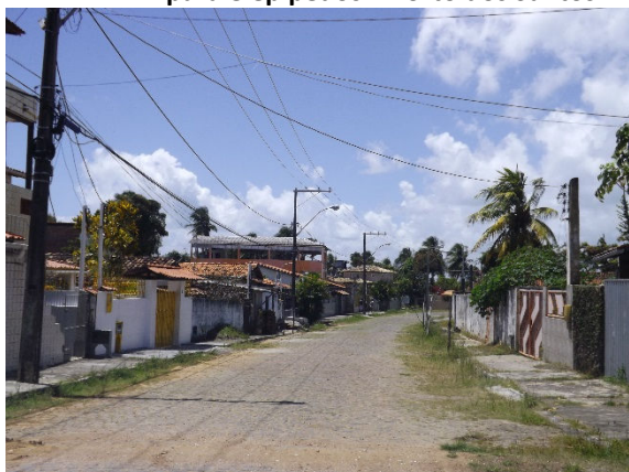
Foto 3.104 - Rua Nova com pavimentação em paralelepípedos – Porto dos Santos
