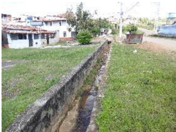
Foto 3.79 - Vista canal de drenagem – Conjunto habitacional Urbis
