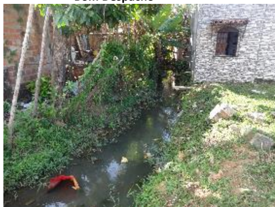
Foto 3.84 - Esgotamento sanitário lançado em córrego existente em Marcelino - Bom Despacho
