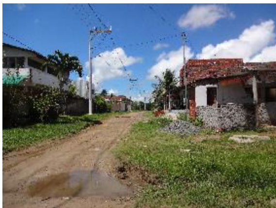
Foto 3.113 - Via local da localidade sem pavimentação
