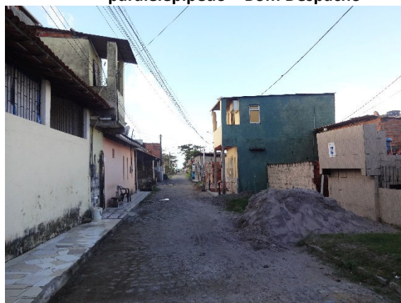
Foto 3.101 - Via local com pavimentação em paralelepípedo – Bom Despacho
