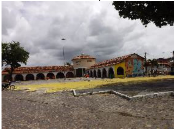
Foto 3.73 - Vista do Mercado à Rua Regis Pacheco – sede do município
