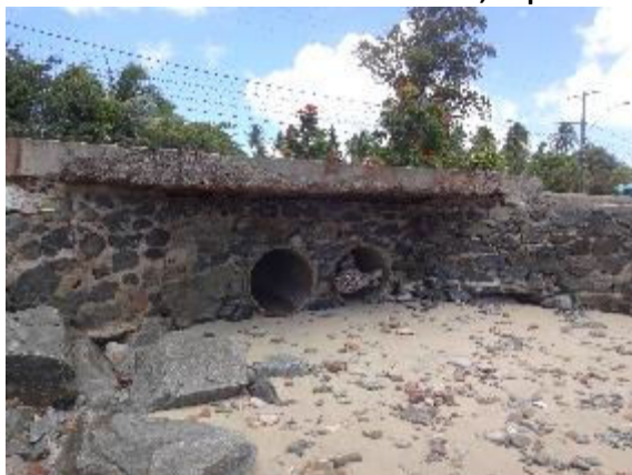
Foto 3.93 - Rodovia BA-533 – Galeria de drenagem - Trecho de Ponta de Areia, Itaparica
