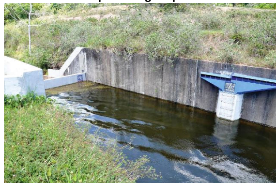
Foto 4.4 - Canal do vertedor com fusegate – Município de Jaguaripe
