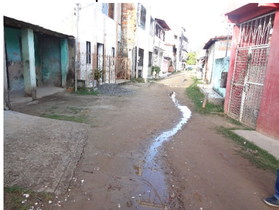
Foto 3.103 - Via local sem pavimentação – Bom Despacho
