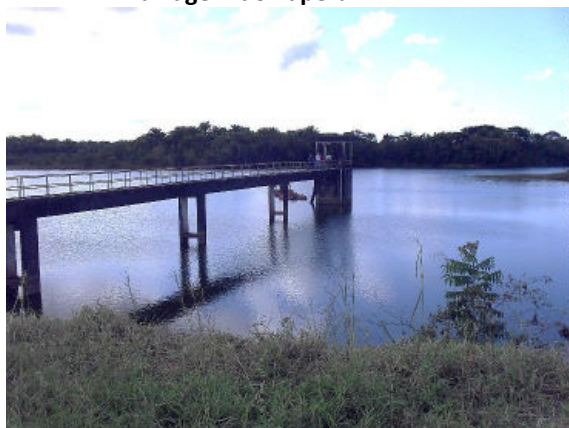
Foto 4.5 - Vista da torre de tomada d'água – Barragem do Tapera
