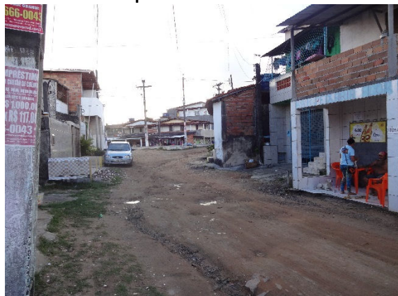
Foto 3.102 - Via local sem pavimentação – Bom Despacho
