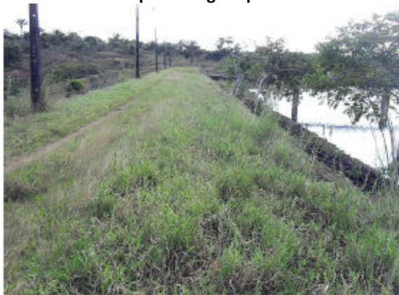
Foto 4.1 - Crista da barragem de Tapera – Município de Jaguaripe
