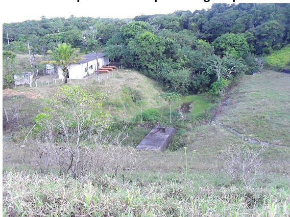
Foto 4.7 - Vista da EEAB a partir da barragem de Tapera – Município de Jaguaripe
