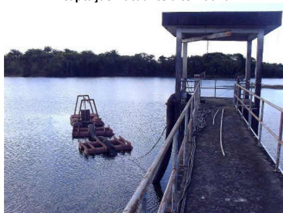
Foto 4.6 - Detalhe da torre de tomada d'água e captação flutuante alternativa
