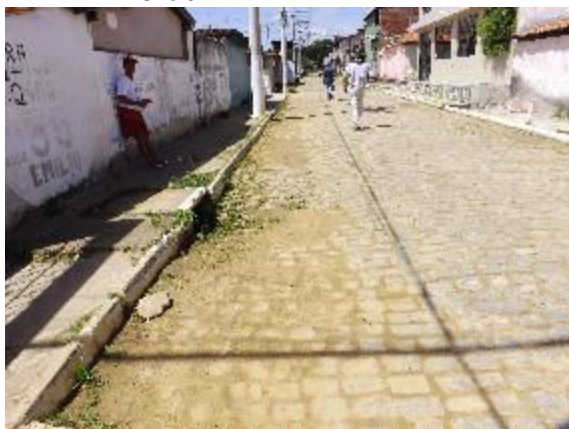
Foto 3.77 - Vista via interna Conjunto habitacional Urbis
