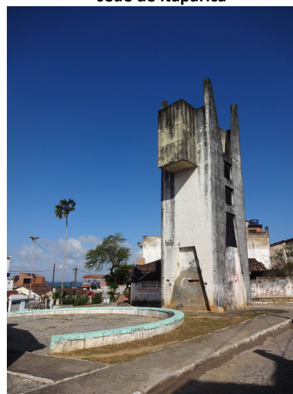
Foto 4.23 - Vista do reservatório desativado no bairro do Alto do Santo Antônio – sede de Itaparica
