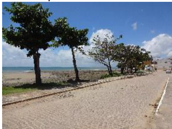
Foto 3.90 - Rodovia BA-533 – Trecho de Amoreiras, Itaparica
