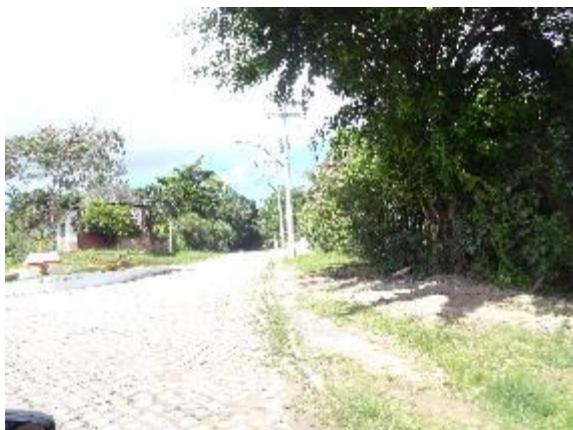
Foto 3.109 - Acesso à localidade de Misericórdia pela Rodovia BA-532
