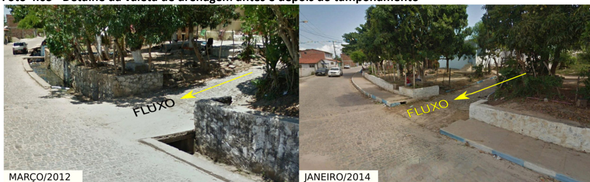
Foto 4.63 - Detalhe da valeta de drenagem antes e depois do tamponamento
