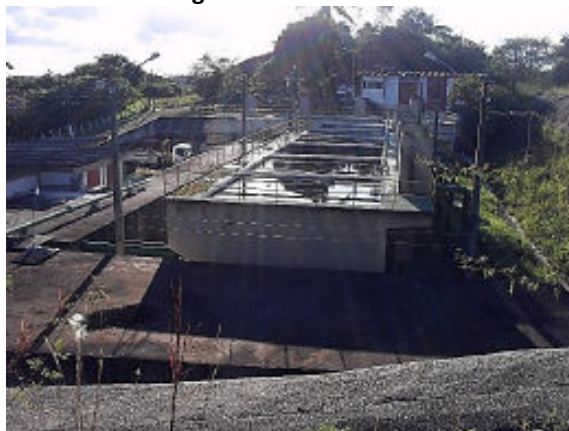
Foto 4.10 - Vista geral da ETA
