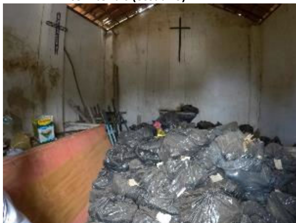
Foto 4.51 - Capela do cemitério utilizada como almoxarifado e depósito de resíduos cemiteriais (ossuário)
