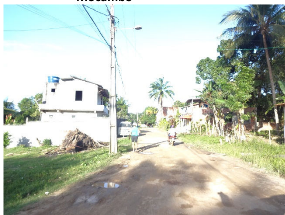
Foto 3.115 - Rua Mocambo sem pavimentação, sem esgotamento e sem drenagem - Mocambo
