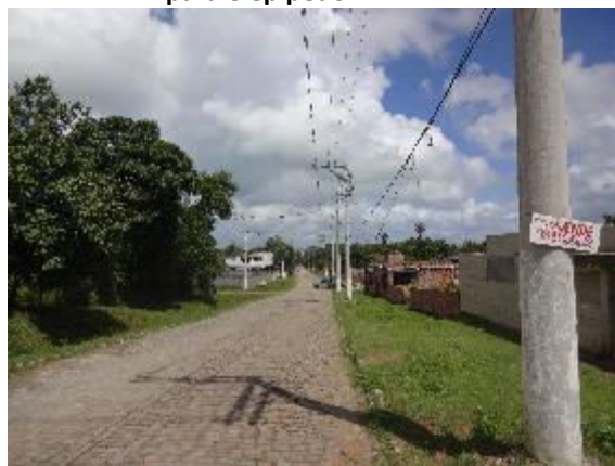
Foto 3.110 - Via de acesso à localidade de Misericórdia revestida em paralelepípedo
