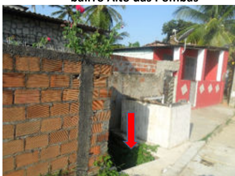
Foto 3.56 - Detalhe do córrego do Galvão (apontado com seta vermelha), e suas margens (Áreas de Preservação Permanente) ocupadas por construções residenciais, no bairro Alto das Pombas
