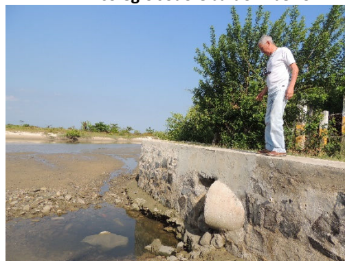
Foto 3.43 - Detalhe de tubulação com saída de drenagem para o manguezal em transversal próxima ao colégio João Ubaldo Ribeiro
