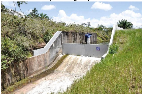
Foto 4.3 - Canal do vertedor com fusegate – Município de Jaguaripe
