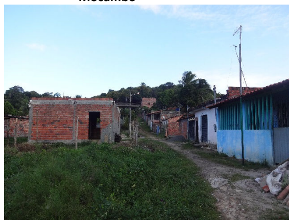
Foto 3.116 - Via local sem pavimentação, sem esgotamento e sem drenagem - Mocambo
