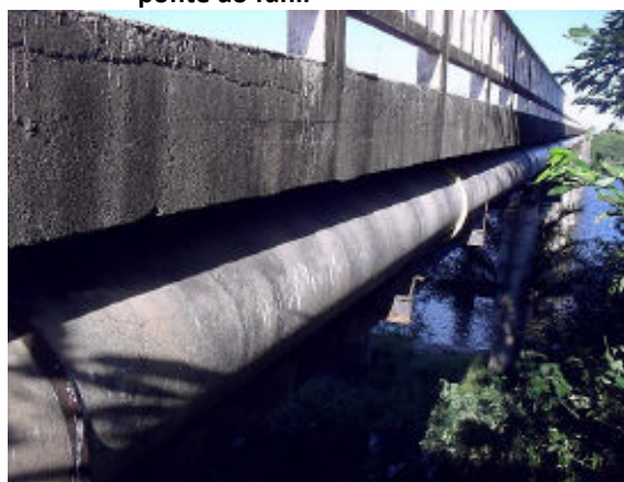
Foto 4.9 - Vista do trecho da AAB2 que passa sob a ponte do funil
