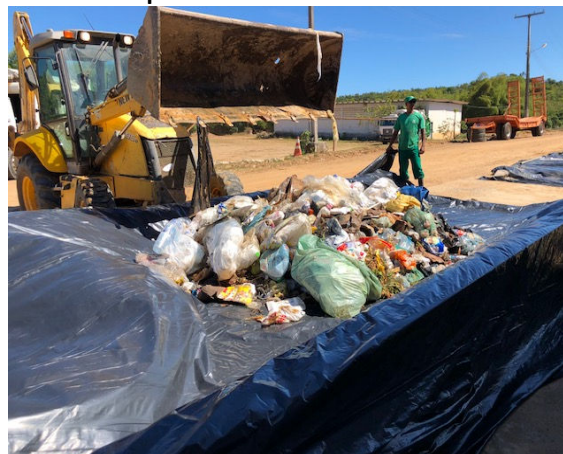
Foto 4.58 - Máquina carregadeira depositando na lona plástica os resíduos coletados da pilha de RSU
