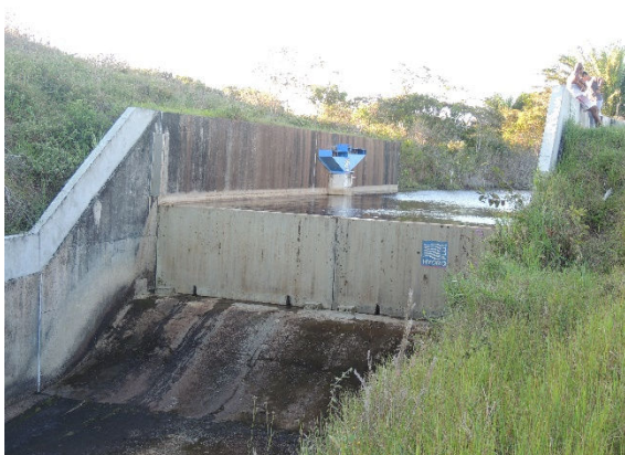
Foto 3.12 - Barragem Tapera - Vertedouro
