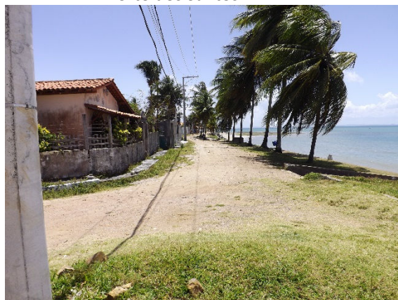
Foto 3.105 - Rua Beira Mar sem pavimentação – Porto dos Santos
