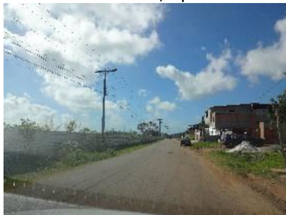
Foto 3.92 - Rodovia BA-533 – Trecho às margens de Porto dos Santos, Itaparica
