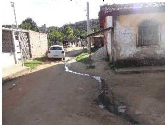
Foto 3.82 - Vista da inexistência de drenagem urbana e de pavimentação em Marcelino, Bom Despacho
