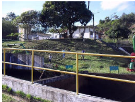
Foto 4.11 - Vista da entrada da ETA
