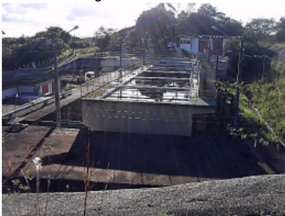
Foto 1.19 - Vista geral da ETA
