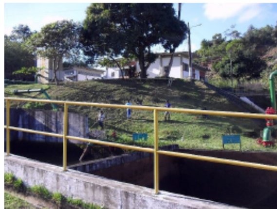
Foto 1.20 - Vista da entrada da ETA
