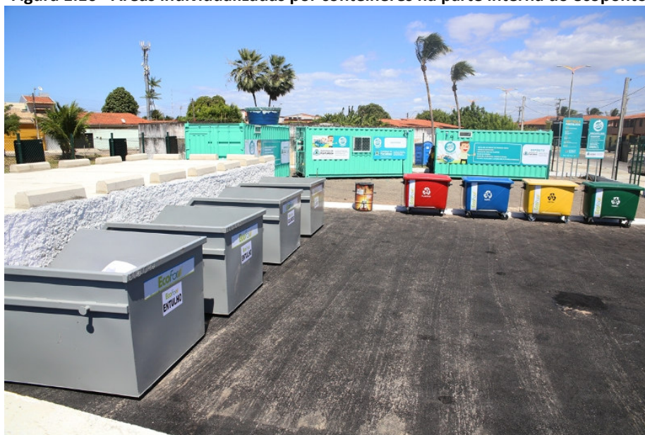
Figura 1.16 - Áreas individualizadas por contêineres na parte interna do ecoponto
