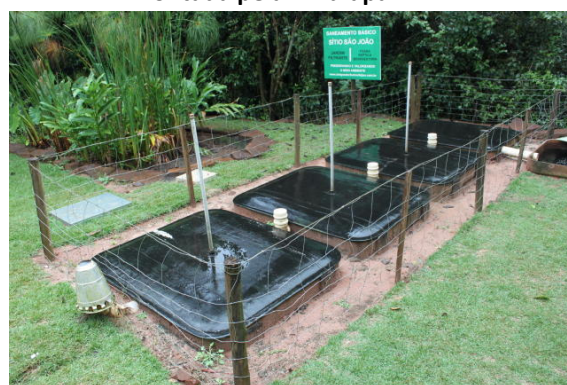
Foto 1.2 - Modelo de fossa séptica biodigestora montada pela Embrapa
