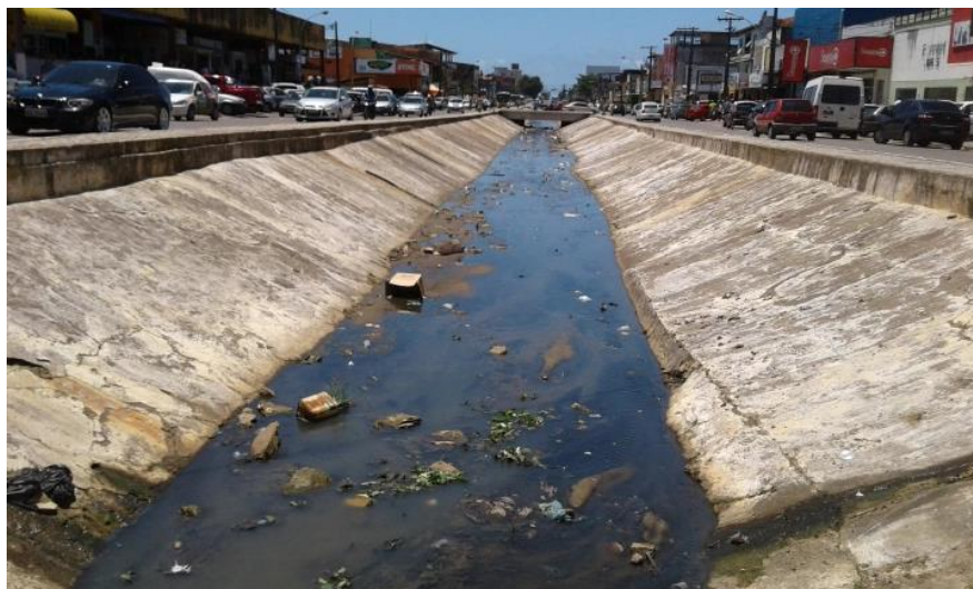
Figura 6.4 - Canal em frente à Central de Abastecimento de Ilhéus
