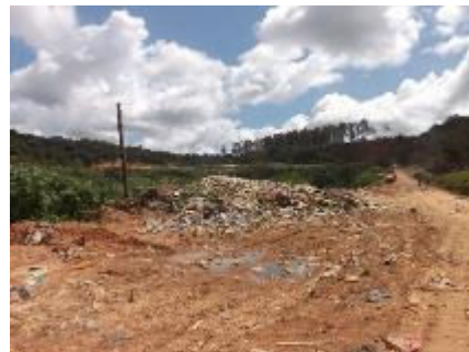
Foto 3.142 -Vista da via interna do aterro sanitário de Catu
