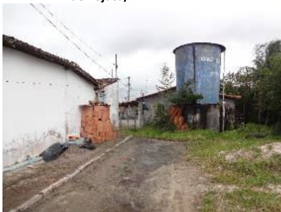
Foto 3.98 - Sistema Simplificado de Captação de Água – Distrito de Miranga - município de Pojuca/BA
