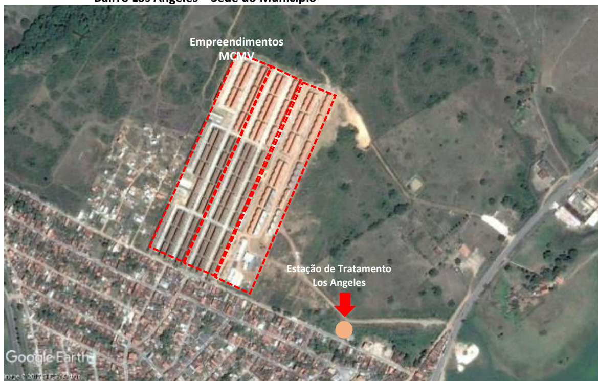
Figura 3.24 - Empreendimentos Minha Casa Minha Vida / Localização Estação de Tratamento de Esgoto – Bairro Los Angeles – Sede do Município
