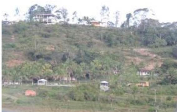
Foto 3.39 - Área destinada à turismo rural e retiro (SIRGAS 2000 UTM 24S 579905 E e 8638085 N)
