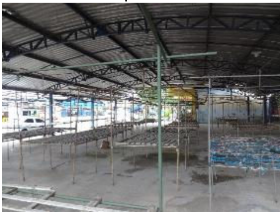
Foto 3.76 - Vista interna do Mercado Municipal de Pojuca – Bairro Pojuca Nova – Sede do Município
