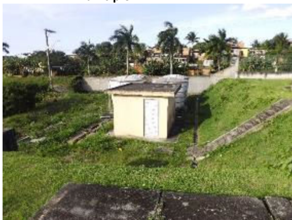
Foto 3.118 - Estação de Tratamento de Esgoto do Hospital Municipal de Pojuca– Sede do Município
