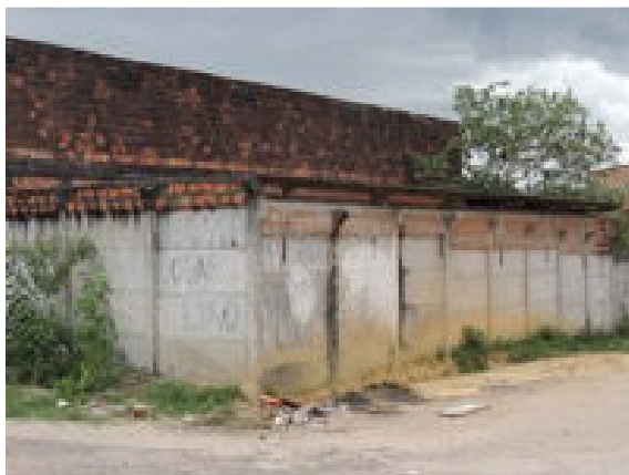
Foto 3.49 - Local destinado resíduos sólidos na Rua Dr. Alfredo Leite
