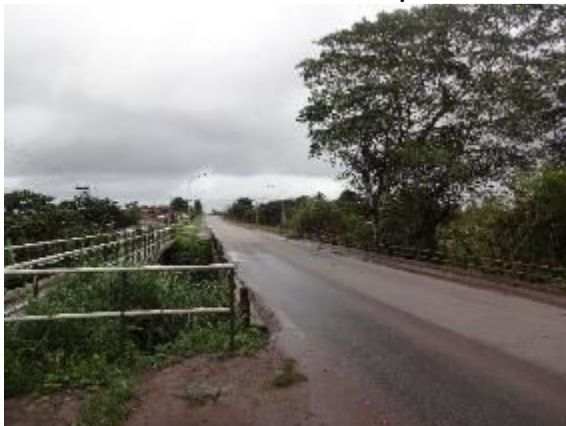
Foto 3.78 - Vista geral da rodovia BA-093 – Bairro Retiro– Sede do Município
