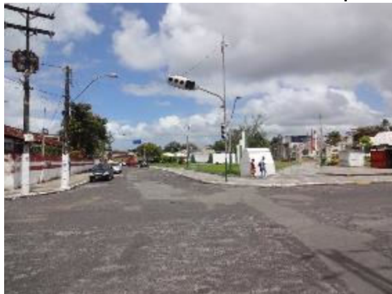
Foto 3.64 - Via local com revestimento em CBUQ –Bairro Centro - Sede do Município
