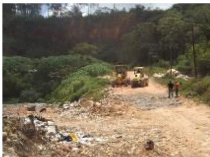
Foto 3.145 -Vista máquinas para acomodação dos resíduos no aterro
