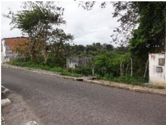
Foto 3.112 - Estação de Tratamento de Esgoto do Bairro de São Francisco (ETE 1) – Sede do Município
