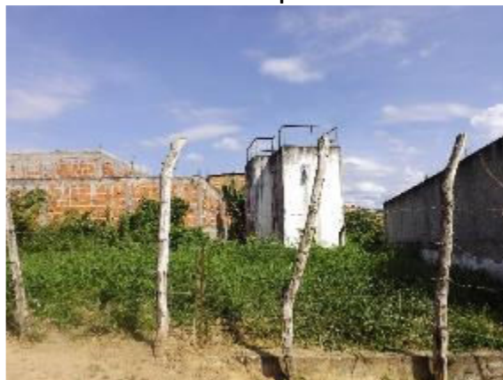
Foto 3.81 - Construção irregular sobre estação de tratamento de esgoto do conjunto habitacional Luís Eduardo Magalhães – Sede do Município
