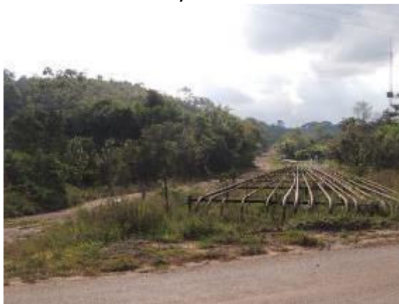
Foto 3.43 - Dutos próxima à ponte de ferro (SIRGAS 2000 UTM 24S 588910E e 8636661N)
