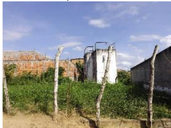
Foto 3.115 - Estação de Tratamento de Esgoto do Bairro de Cajazeiras (ETE 3) – Sede do Município
