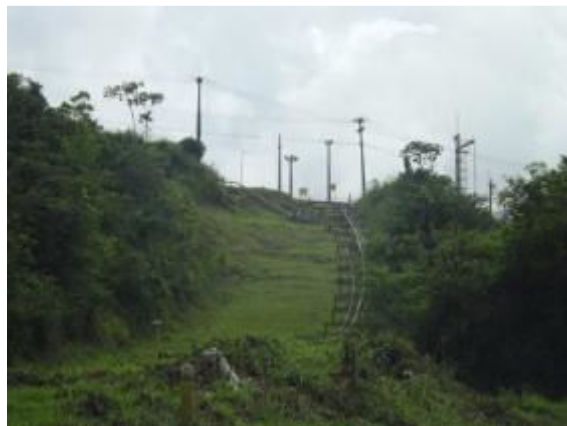
Foto 3.42 - Dutos próximos à Ferbasa, bairro Central
