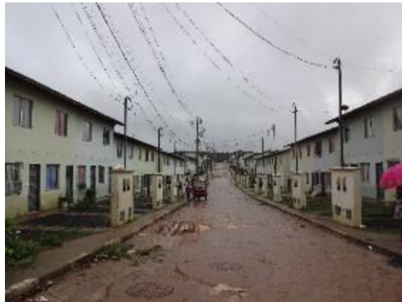
Foto 3.109 - Vista do Residencial Novo Caminho - PMCMV – Los Angeles – Sede do Município
