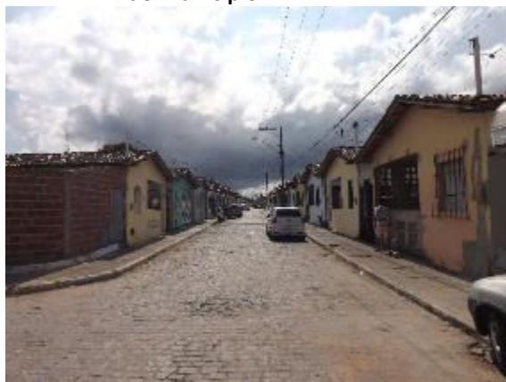
Foto 3.66 - Via local com revestimento em paralelepípedo –Bairro Vitória - Sede do Município
