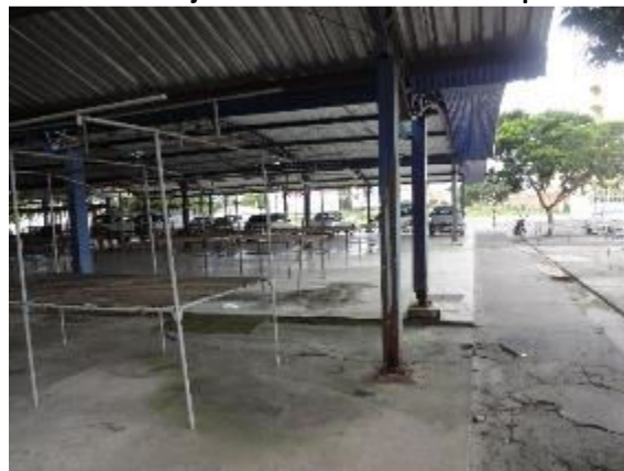
Foto 3.77 - Mercado Municipal e de Abastecimento de Pojuca – Bairro Pojuca Nova - Sede do Município
