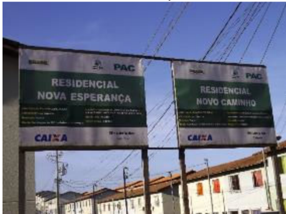
Foto 3.108 - Residencial Nova Esperança (300 unidades habitacionais)/Residencial Novo Caminho (300 unidades habitacionais) - PMCMV – Los Angeles – Sede do Município
