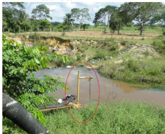
Foto 3.85 - Dispositivo de içamento para a bomba submersa
