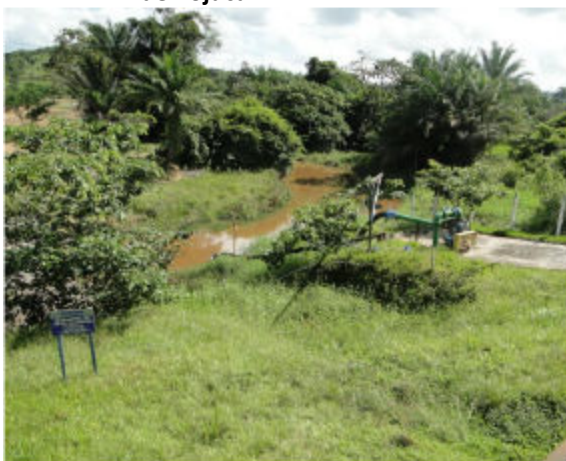
Foto 3.84 - Vista geral da área da captação do SAA de Pojuca
