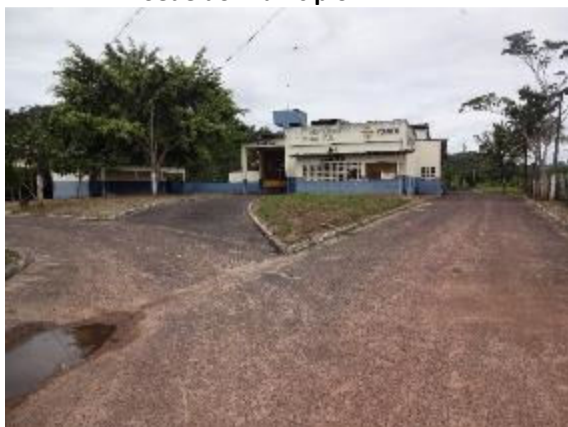
Foto 3.104 - Matadouro Municipal de Pojuca – Sede do Município
