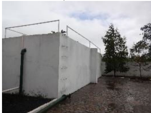
Foto 3.117 - Estação de Tratamento de Esgoto do Bairro de Los Angeles – Sede do Município
