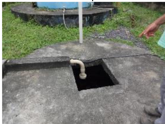
Foto 3.107 - Sistema de Tratamento de Esgoto existente do Matadouro Municipal – Sede do Município
