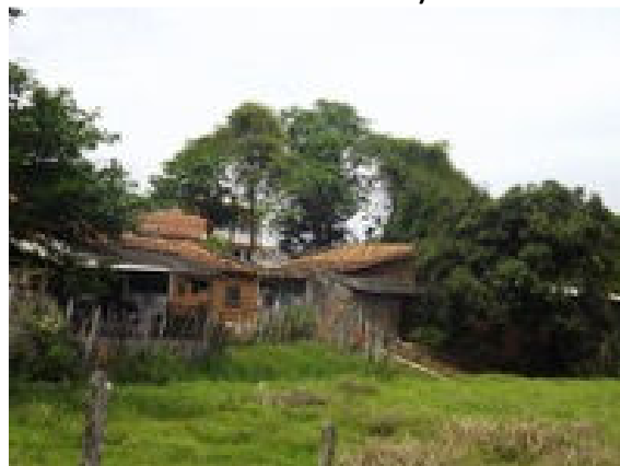
Foto 3.54 - Margens do rio Catu, com ocupações residenciais (SIRGAS 2000 UTM 24S 572193 E e 8628344N)
