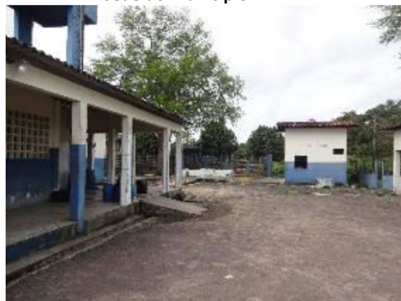
Foto 3.105 - Matadouro Municipal de Pojuca – Sede do Município
