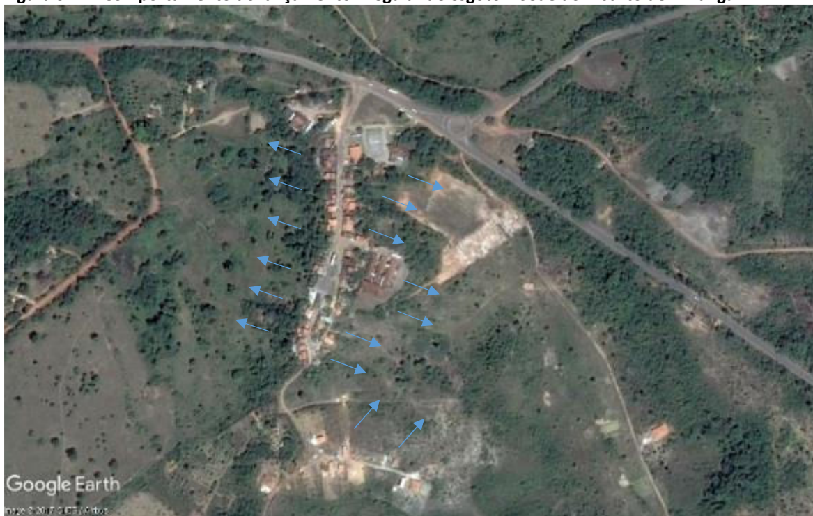
Figura 3.21 - Comportamento do lançamento irregular de esgoto – Sede do Distrito de Miranga
