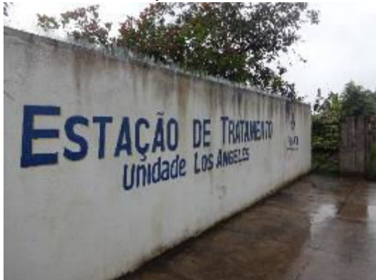
Foto 3.116 - Estação de Tratamento de Esgoto do Bairro de Los Angeles – Sede do Município
