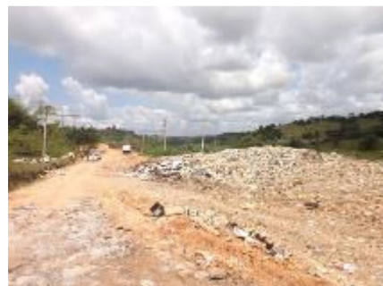
Foto 3.146 -Vista caminhões tipo caçamba no aterro
