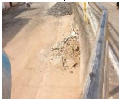
Foto 3.136 -Resíduos de Construção e Demolição dispostos em via pública
