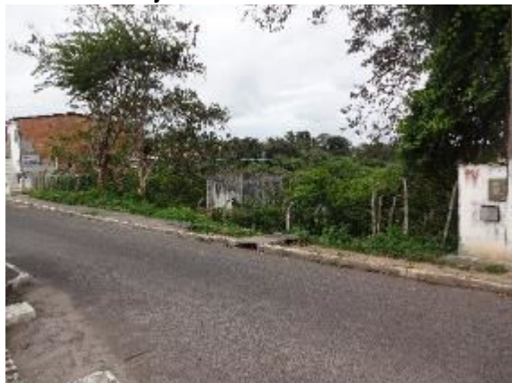
Foto 3.122 - Local do lançamento de esgoto 6 na Rua Conselheiro Saraiva ao lado da ETE desativada (São Francisco) – Sede de Pojuca
