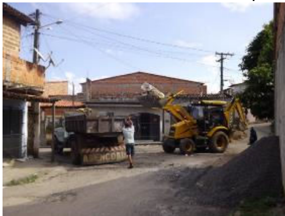
Foto 3.124 - Coleta de Resíduos de Construção Civil – Bairro Centro– Sede do Município
