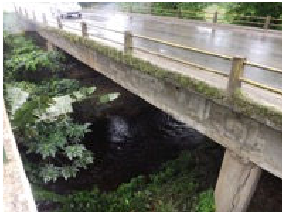
Foto 3.4 - Rio Catu sob travessia da Rod. BA-093
