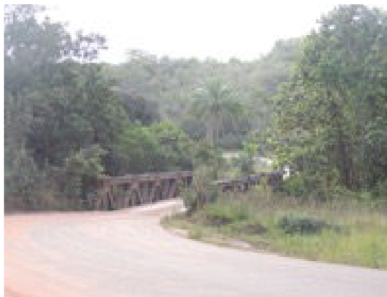
Foto 3.46 - Visão Geral da Ponte de Ferro sobre o rio Quiricó Grande e aspecto de sua faixa de Área de Preservação Permanente
