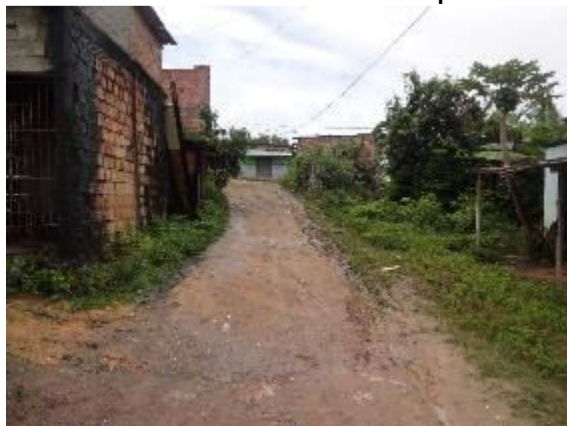
Foto 3.68 - Via local sem revestimento – Bairro Palmeiras- Sede do Município
