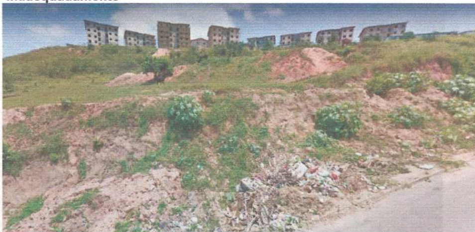
Figura 7 - morros com presença de erosões e resíduos sólidos dispostos inadequadamente
