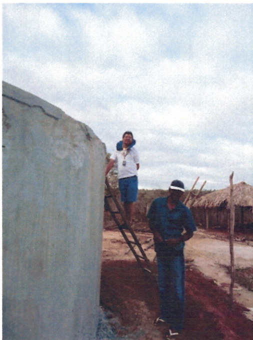
Figura 28 - Construção de reservatório na Aledeia Payayá
