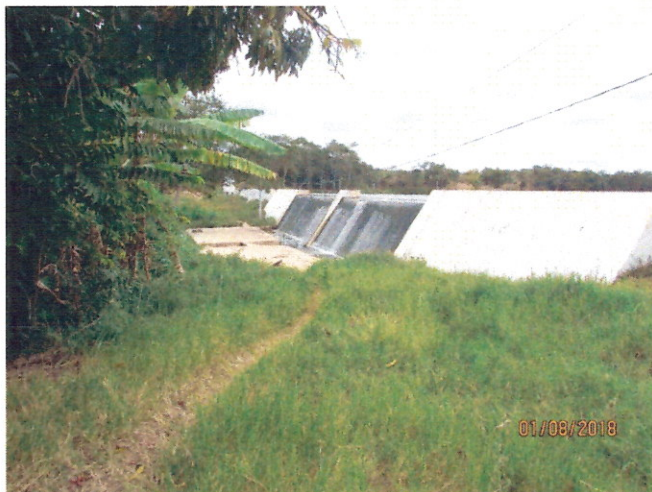
Figura 26 - Vista do paramento de jusante da barragem após as obras de recuperação
