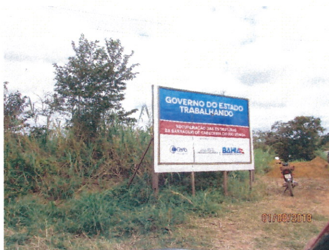
Figura 25 - Placa da obra de recuperação da barragem
