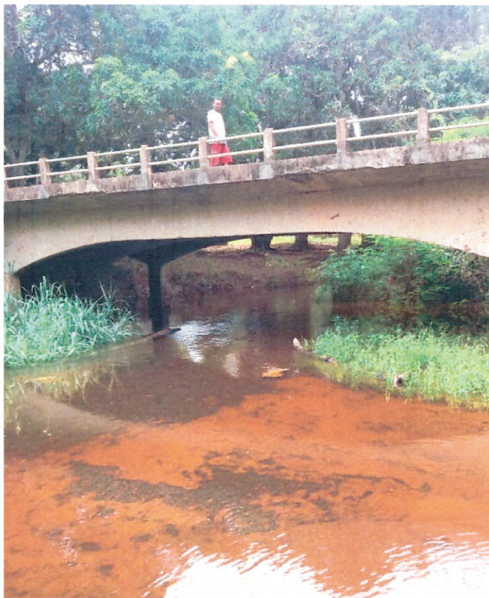
Figura 44 – Ponte da estrada velha São José-Lençóis no rio Utinga.
