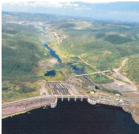
Figura 7 – Vista geral da Barragem de Pedra do Cavalo
