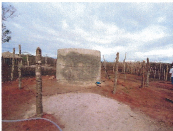
Figura 29 – Obra de construção de um dos reservatórios da Aldeia Payayá concluída
