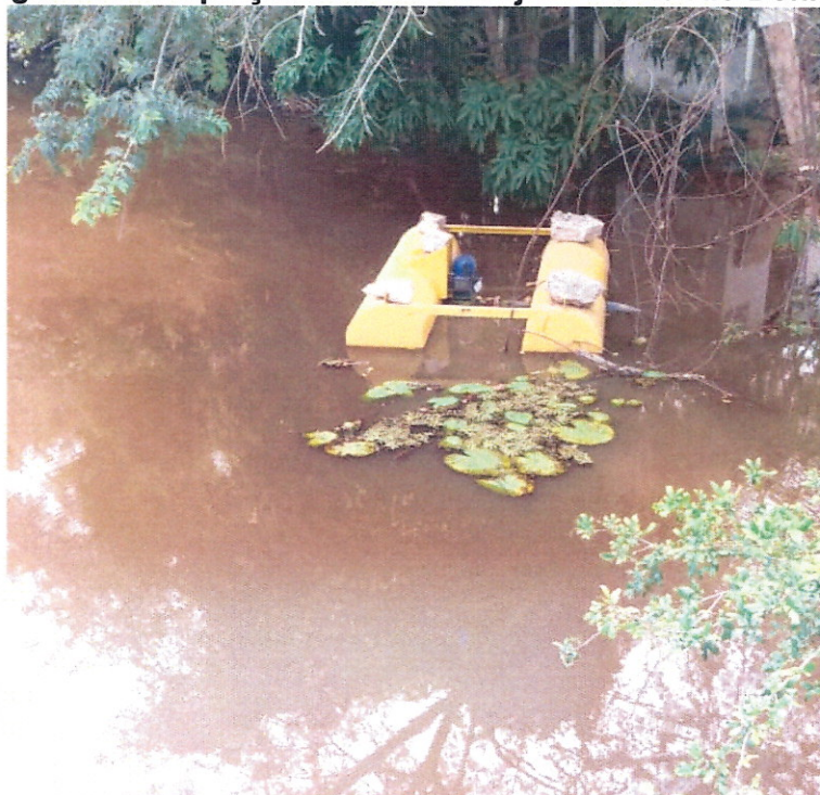
Figura 45 – Captação do SSA de Lajedinho no Rio Bonito.
