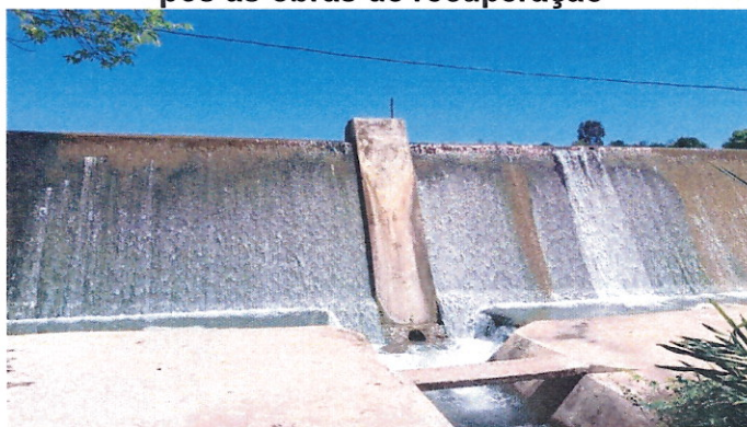
Figura 14 - Vista frontal de jusante da Barragem de Nível da Cabeceira do Rio Utinga após as obras de recuperação
