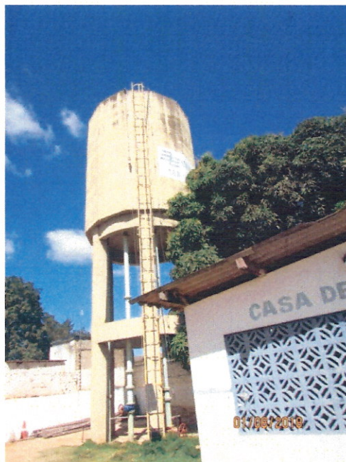
Figura 36 - Reservatório de Água Tratada com capacidade de 100m 3 , existente na ETA de Utinga
