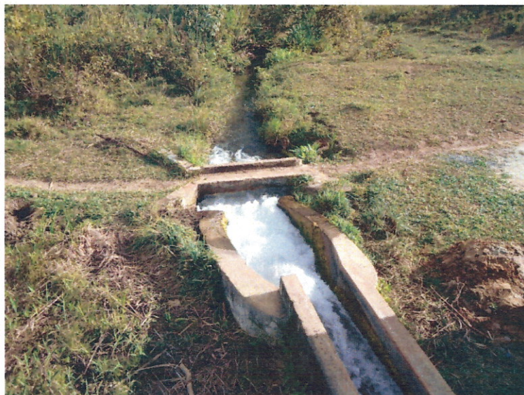
Figura 21 - Tomada com saída para canal de irrigação (canal B)
