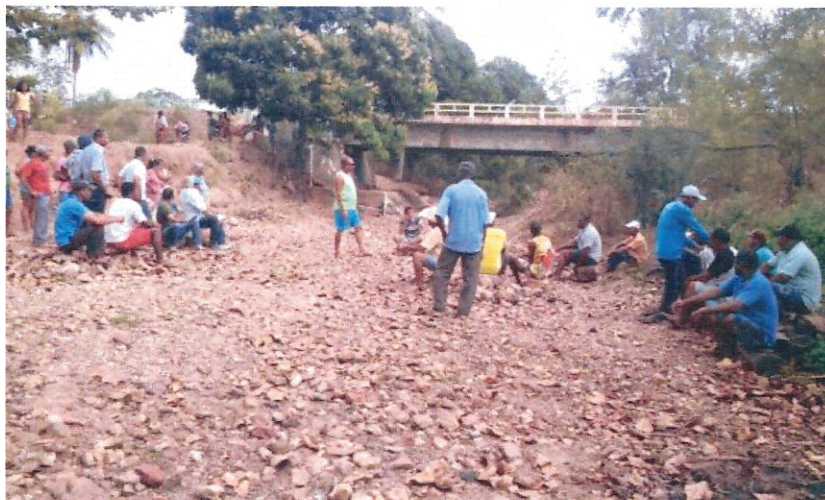
Figura 43 - Rio Utinga Seco - Ponte da BA 164
