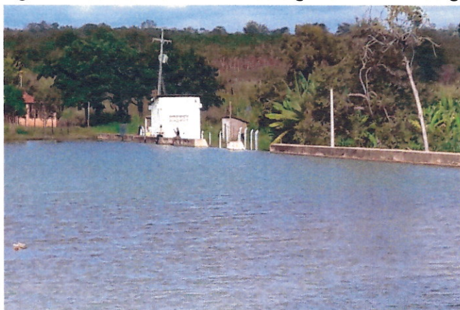
Figura 3 – Vertedouro da Barragem do Rio Utinga
