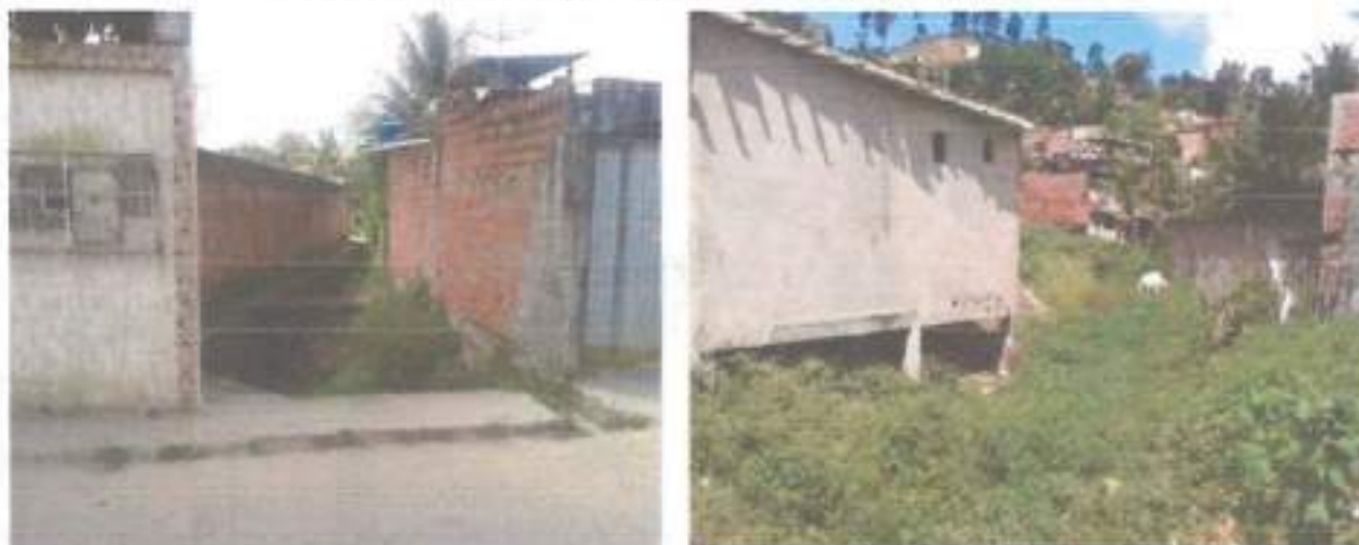
Figura 17 – Ocupação irregular às margens de córregos
