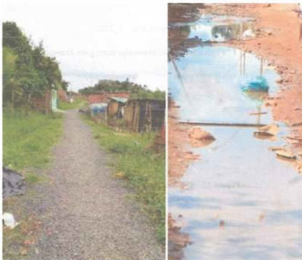
Figura 16 – Esgoto a céu aberto e disposição irregular de resíduos em Caboto
