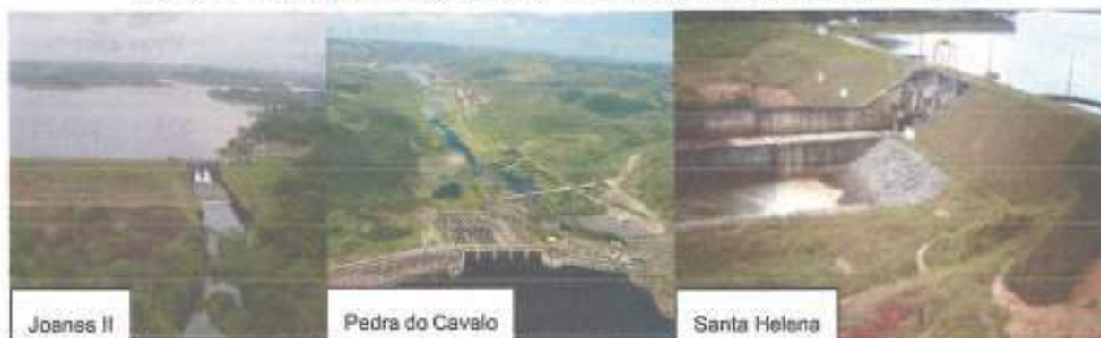
Figura 11 – Barragens que atendem o SIAA Recôncavo e SIAA Salvador
