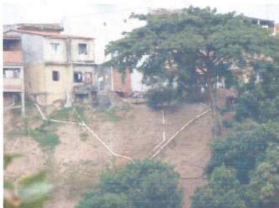
Figura 18 – Descarte de esgoto irregular em taludes
