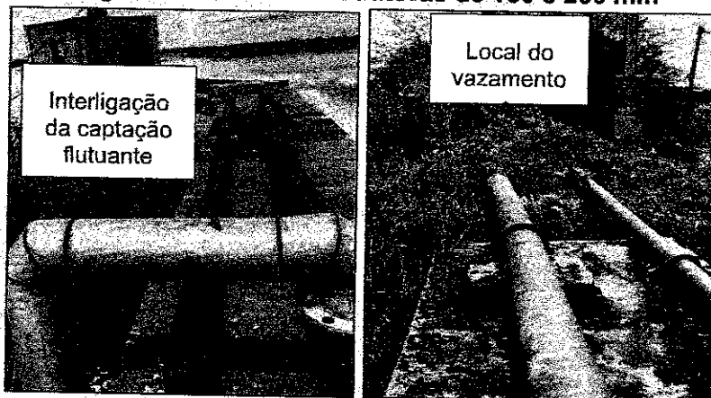
Figura 14 – Vista das adutoras de 150 e 200 mm
