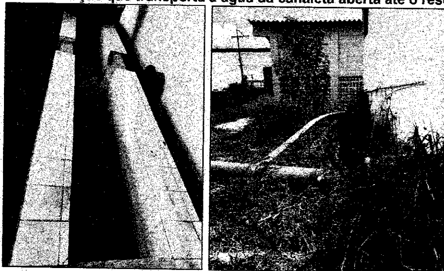
Figura 19 – Tubulação que transporta a água da canaleta aberta até o reservatório
