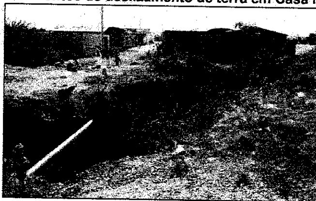
Figura 42 – Pontos de deslizamento de terra em Casa Nova/BA
