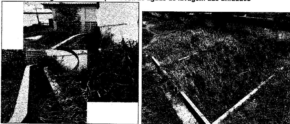
Figura 22 – Canal que escoar as águas de lavagem das unidades
