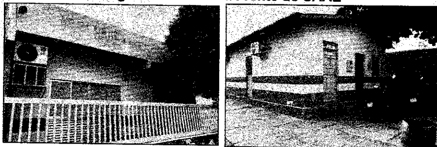
Figura 10 - Vista da Frente do SAAE
