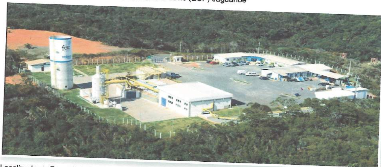
Vista aérea da Estação de Condicionamento Prévio (ECP) Jaguaribe
