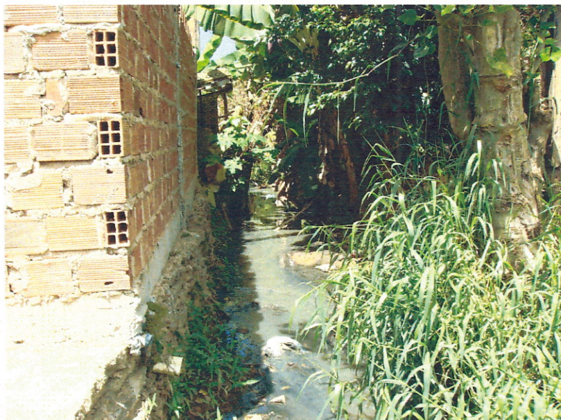
Figura 15 – Ocupações irregulares ao longo das margens do córrego existente no Trecho Crítico 05.
