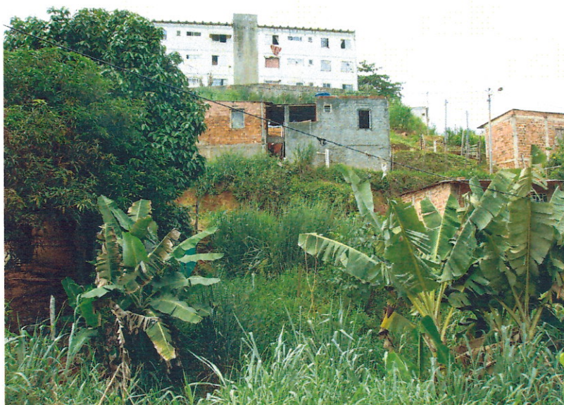
Figura 18 – Encosta irregularmente ocupada, localizada no fundo do Conjunto Habitacional Colinas de Pituáçu.
