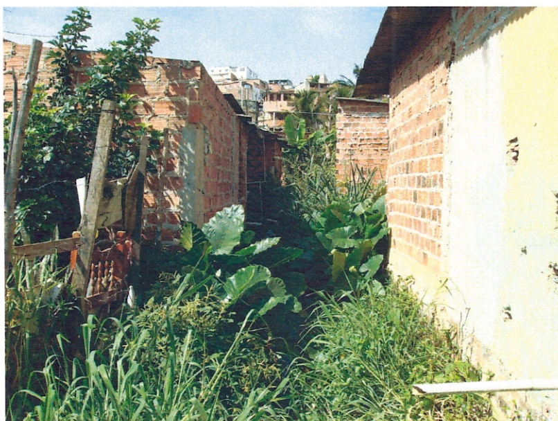
Figura 11 – Ocupações irregulares nas margens de um córrego existente na área do Trecho Crítico 03.
