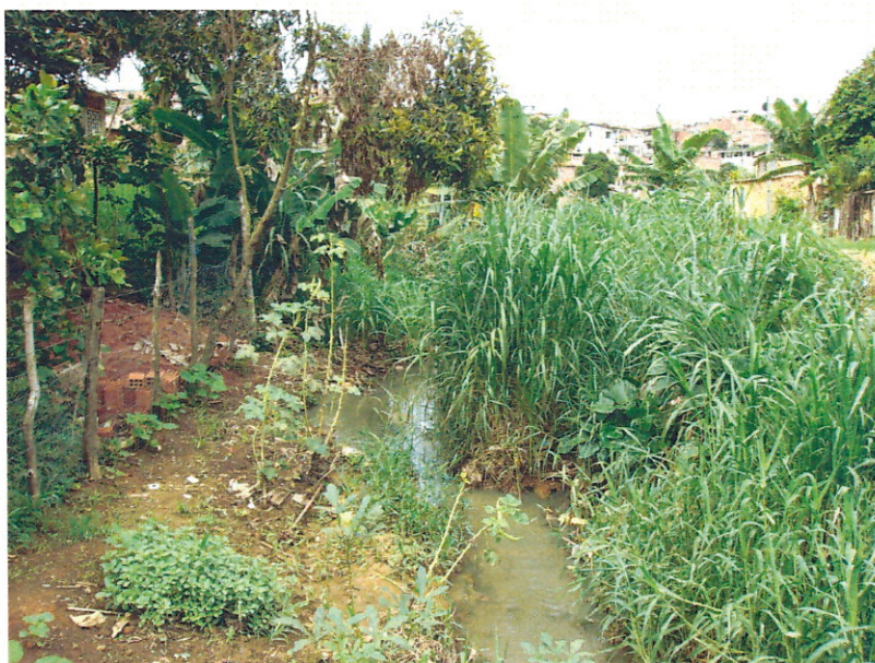
Figura 19 – Córrego existente na região com suas margens ocupadas.
