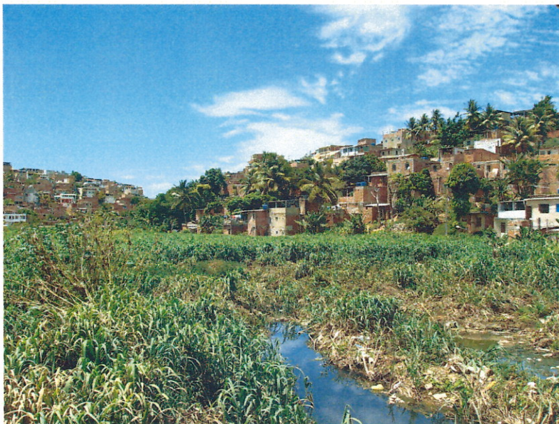
Figura 12 – Ocupações irregulares no dique existente na Av. Gal Costa, área do Trecho Crítico 03.
