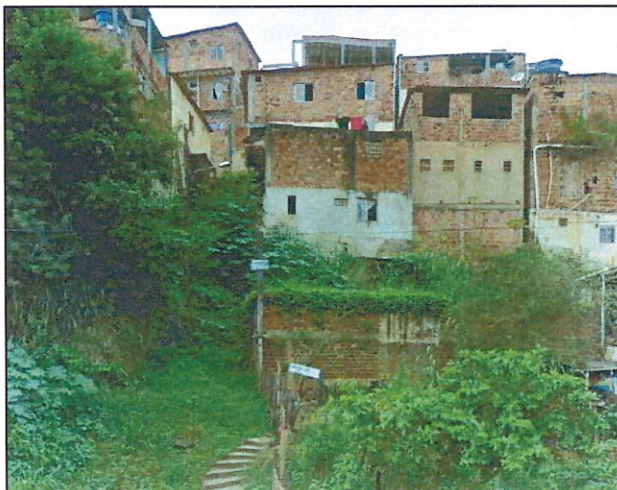
Figura 24 – Dificuldade de acesso – Residências na Av. Gal Costa
