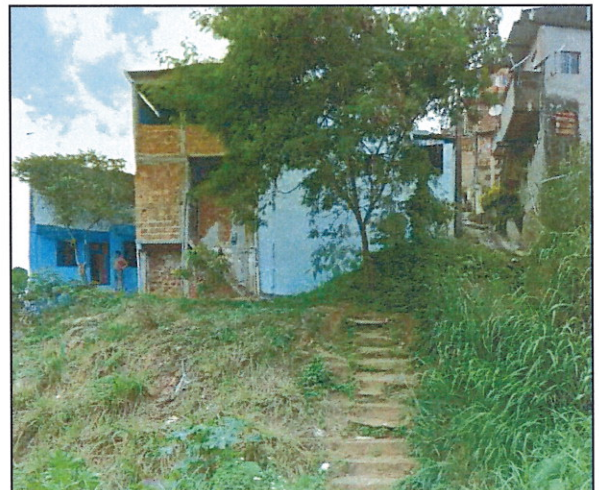
Figura 25 – Dificuldade de acesso – Residências na encosta da Av. Gal Costa
