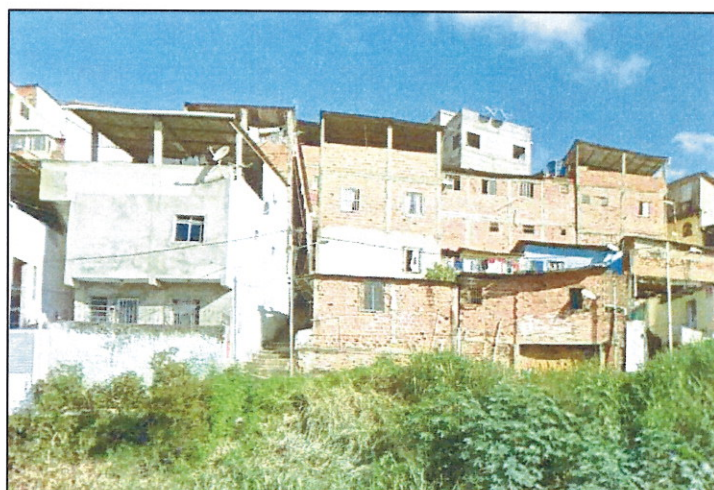
Figura 15 – Escada de acesso às residências
