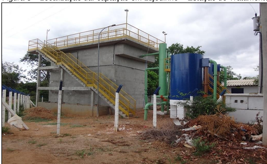
Figura 5 – Localização da. captação em Lajedinho - Estação de Tratamento
