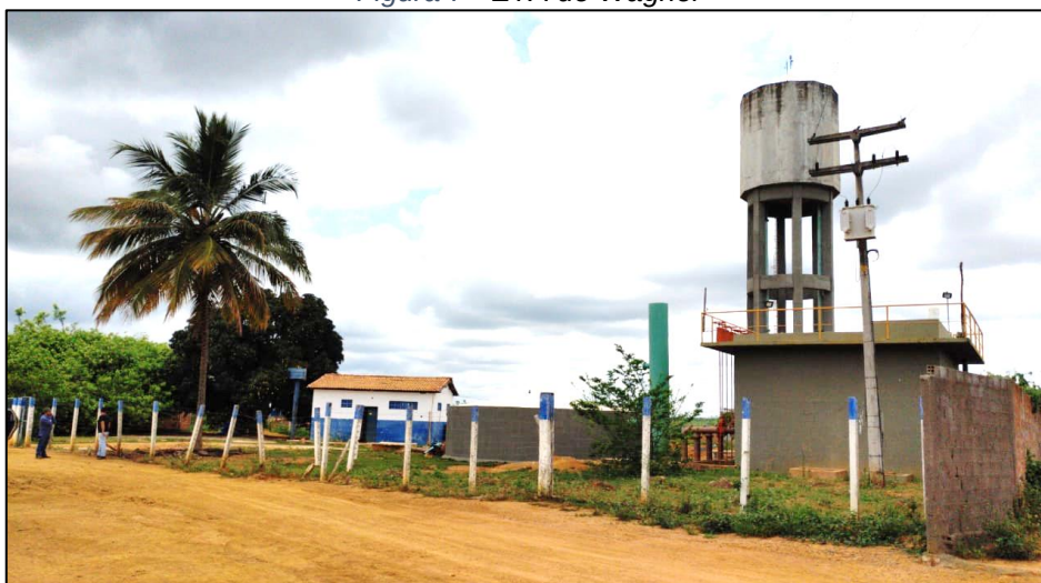
Figura 7 - ETA de Wagner
