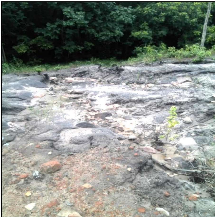
FIGURA 9 - EXEMPLO DE ÁREA DE EROSÃO VISTORIADA AS MARGENS DO RIO BONITO.
