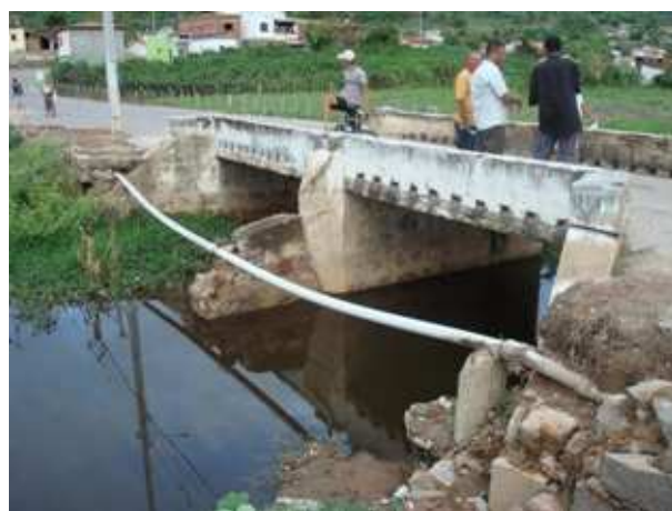
Foto 12: Riachão do Coité – Vista da ponte - jusante
