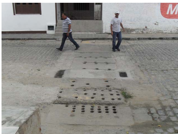
Foto 5: Travessia de rua – Canal da Av. Antonio Lopes.
