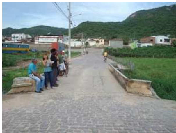
Foto 10: Riachão do Coité – Vista da ponte que é encoberta na época das águas
