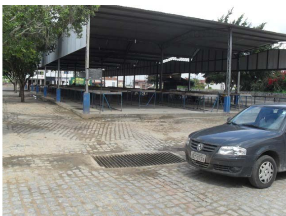
Foto 5: Caixa com grelha – Centro de Abastecimento.
