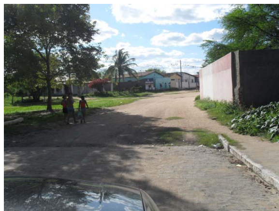
Foto 4: Área crítica de alagamento – Rua do Chalet.
