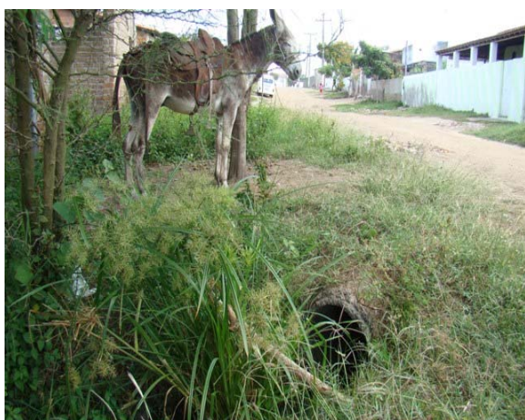
Foto 3: Final da galeria de micro-drenagem na Rua Elias Bernardino Carneiro.
