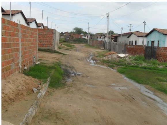
Foto 1: Conjunto Aloísio Carneiro – Área Crítica 1 – área de alagamento.
