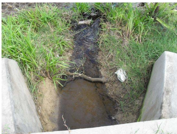
Foto 3: Lançamento no Açude Municipal.
