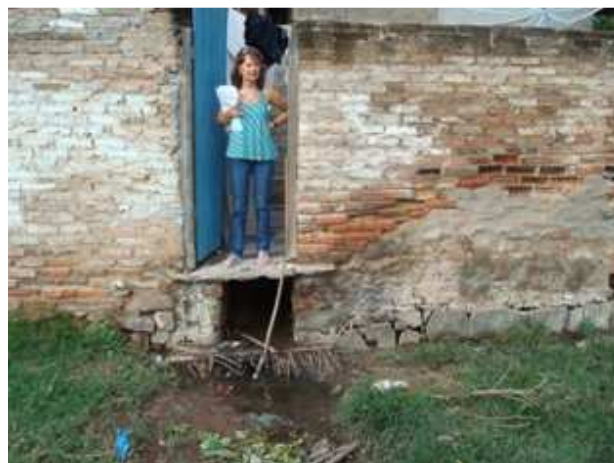
Foto 8: Rua São Gonçalo II – Vista da caixa de captação de galeria sob imóvel - jusante
