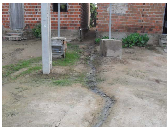
Foto 6: Lançamento de esgoto secundário a céu aberto – Rua Angélico.
