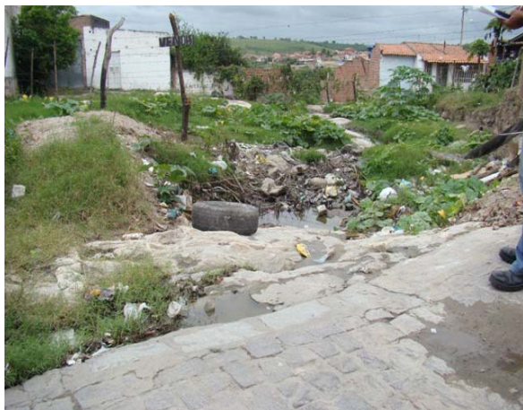
Foto 1: Ponto de início do Canal de macrodrenagem – Rua da Pampulha.
