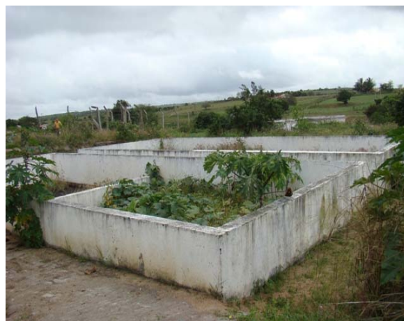
Foto 4: Estação de tratamento.
