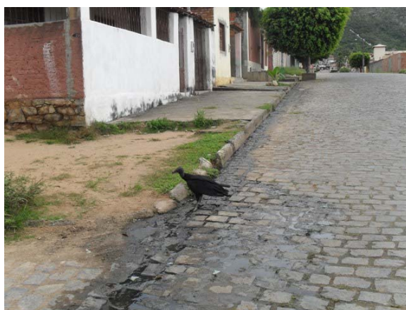
Foto 6: Lançamento a céu aberto – sarjeta – Rua Bela Vista.
