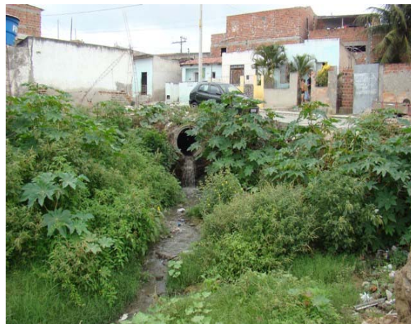
Foto 2: Início de macrodrenagem – Canal da Pampulha.
