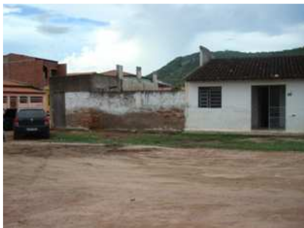
Foto 22: Rua Belmiro Matos – inundação
