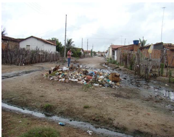
Foto 3: Chegada de esgoto do Bairro Fernando Nery I.
