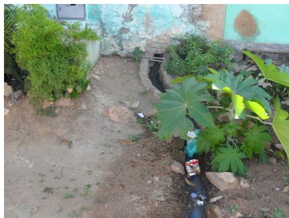
Foto 10: Lançamento a céu aberto – Rua Martins Santana.
