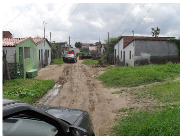
Foto 6: Área Crítica de alagamento – Rua José Luiz Sobrinho.
