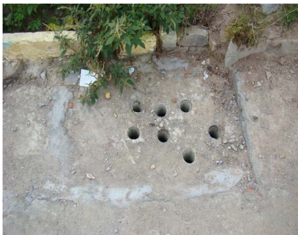
Foto 3: Rua do Sisal – caixa coletora de águas pluviais e esgoto com diâmetro de 300 mm.
