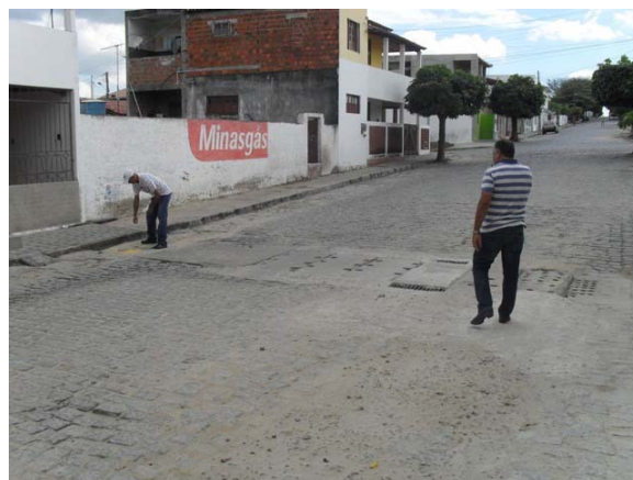
Foto 4: Travessia de rua – Canal da Av. Antonio Lopes.
