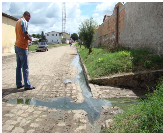
Foto 2: Início da galeria de micro-drenagem na Rua Josefina Carneiro de Almeida.
