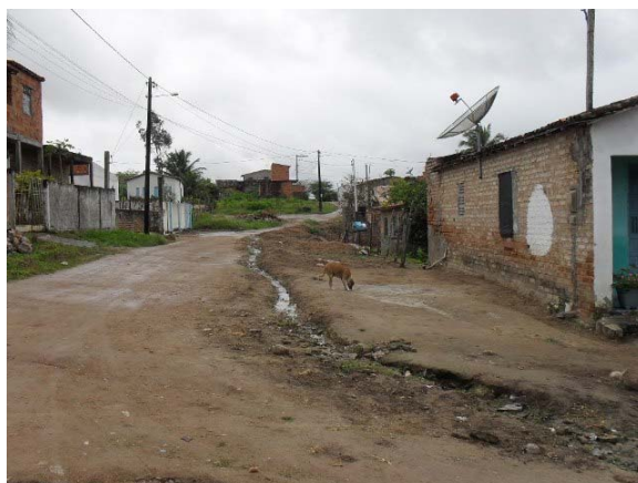
Foto 6: Esgoto a céu aberto – Bairro Algarobas – Rua Maravilha
