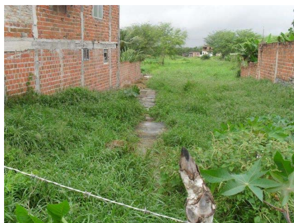
Foto 8: Rua João Muniz Barreto – receptor de águas pluviais.
