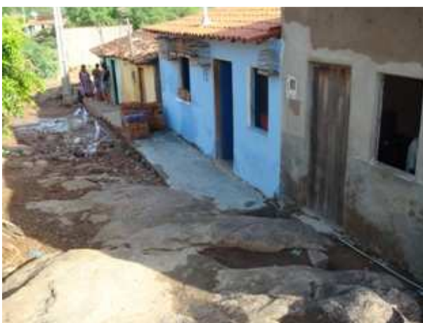
Foto 4: Rua São Gonçalo – Casas atingidas por enxurradas
