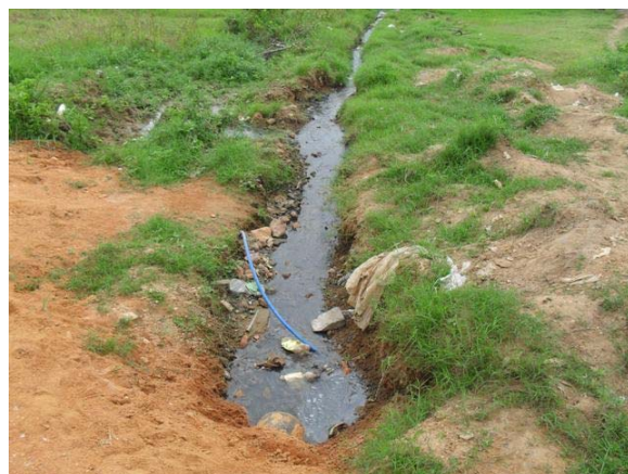
Foto 10: Efluente do DAFA – Situação crítica
