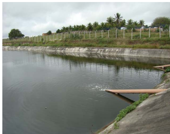
Foto 2: Estação de tratamento.
