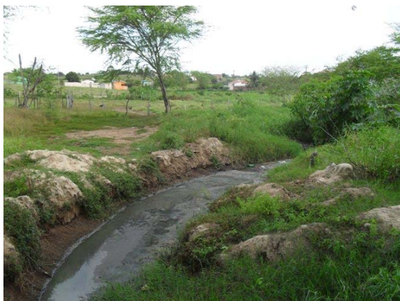
Foto 3: Lançamento de esgoto a céu aberto – final da Rua Santos Antônio com a Rua Cajazeiras.
