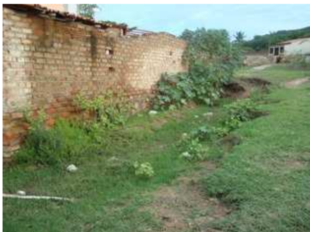
Foto 13: Bairro Alto – Rua Ramiro Pimentel – enxurrada
