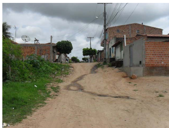
Foto 6: Lançamento de esgoto a céu aberto – Rua José Pedro de Carvalho.
