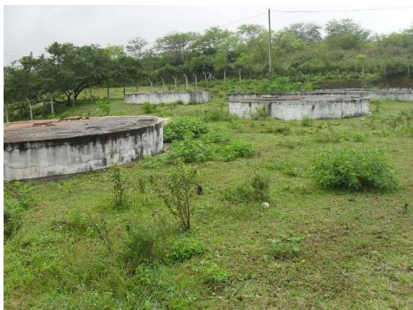
Foto 3: Vista geral da ETE.
