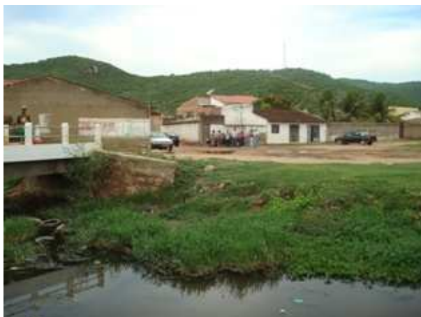
Foto 21: Rua Belmiro Matos – inundação
