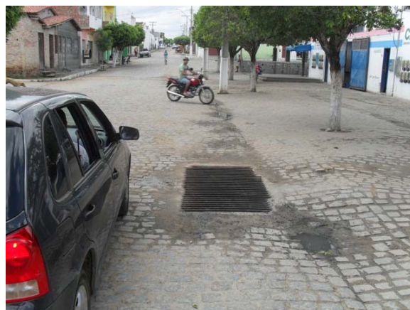
Foto 4: Rua Graciliano Carneiro – caixa com grelha.
