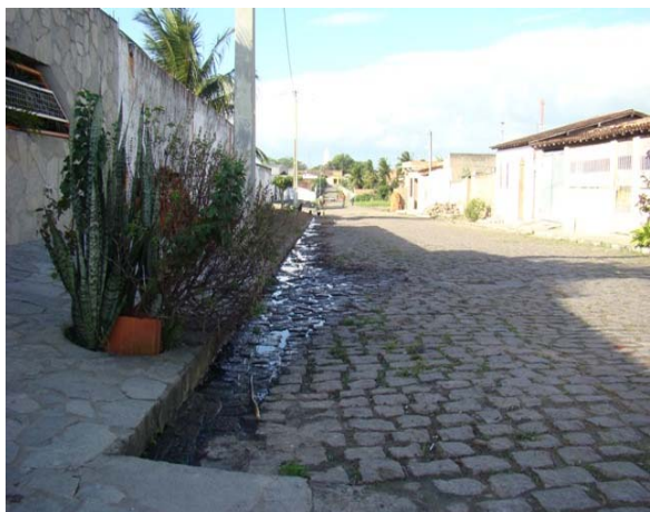
Foto 1: Esgoto secundário a céu aberto – Rua B.
