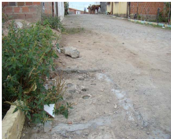
Foto 2: Rua do Sisal – caixa coletora de águas pluviais e esgoto – diâmetro de 300mm.
