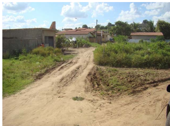
Foto 6: Área Crítica 2 – Rua Antônio Balbino.
