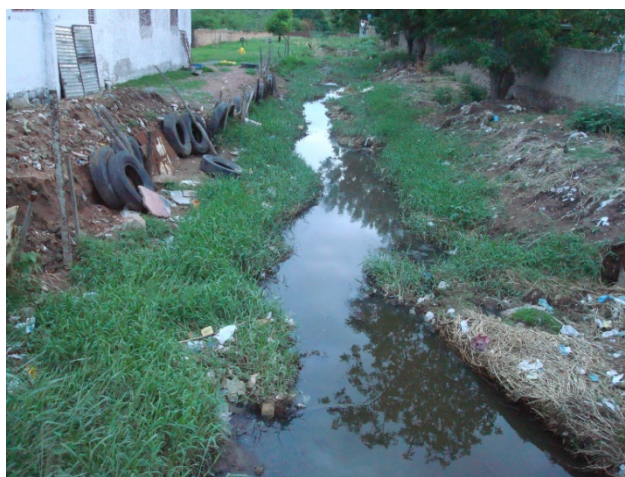
Foto 4: Riacho do Pontilhão – jusante – esgoto a céu aberto
