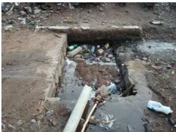
Foto 9: Rua São Gonçalo II – Vista da caixa do bueiro sob a via férrea
