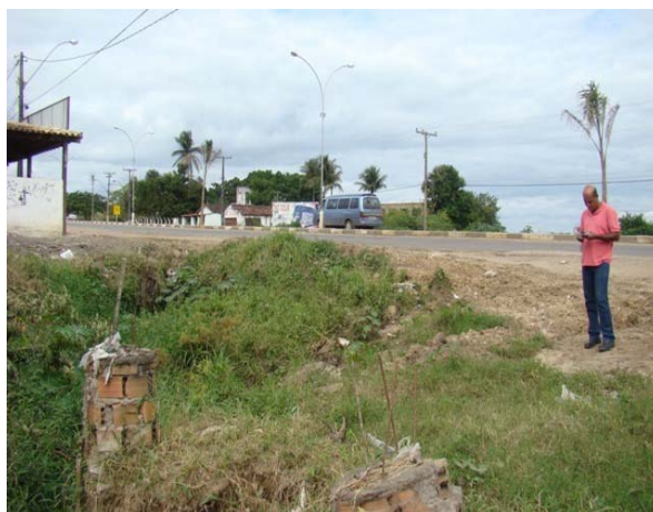
Foto 6: Área de descarte de drenagem e esgotos de parte do centro – próximo da rodovia BA-049.
