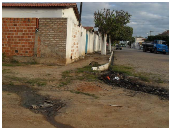
Foto 10: Lançamento de esgoto secundário a céu aberto – Rua Manoel Fidelis
