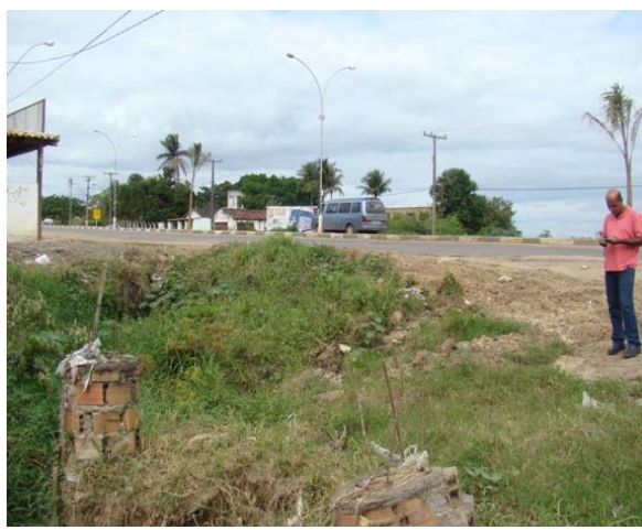
Foto 6: Área de descarte de drenagem e esgoto de parte do centro. Próximo da Rodovia BA-409.
