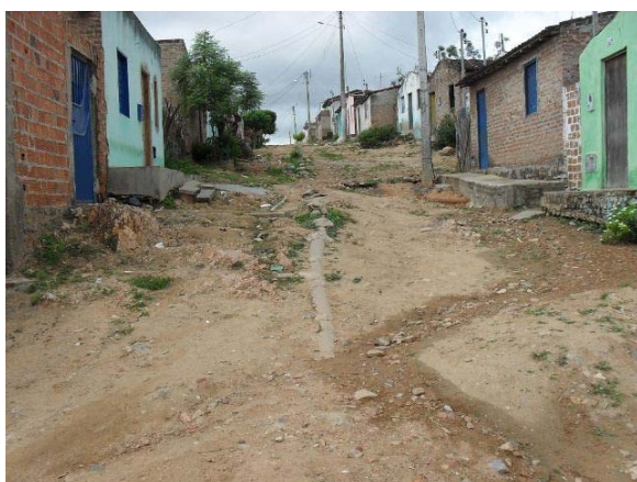
Foto 5: Rede de esgoto 0200 – Rua Q – Bairro Cascalheira.
