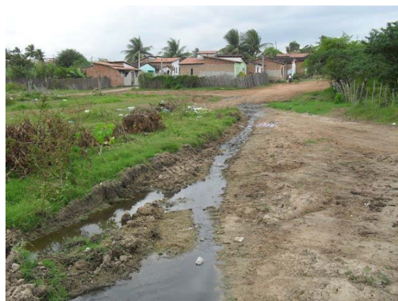
Foto 6: Lançamento de esgoto a céu aberto no Conjunto Retiro Velho.
