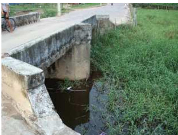
Foto 11: Riachão do Coité – Vista da ponte -montante
