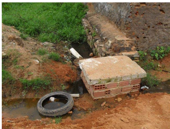
Foto 4: Caixa de revisão no passeio.
