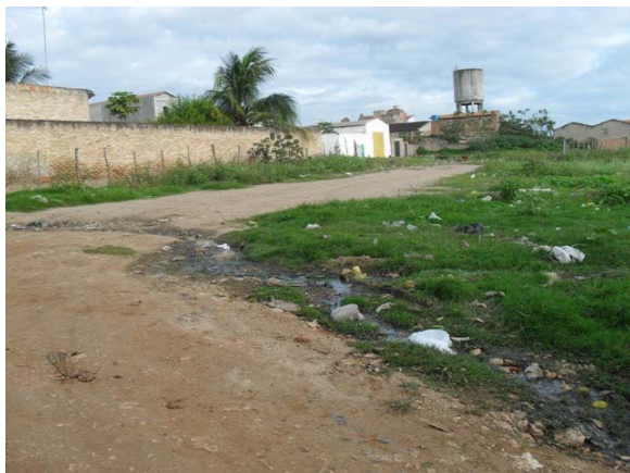
Foto 1: Lançamento de águas pluviais e esgoto secundário a céu aberto – Rua Manoel Fidelis.
