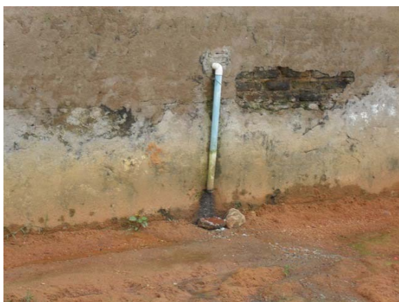
Foto 11: Lançamento de efluente secundário no passeio.
