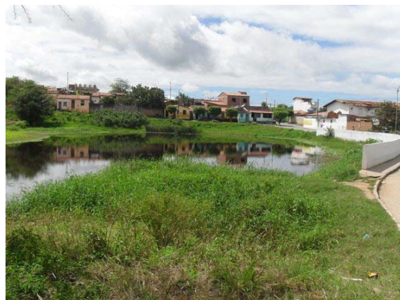
Foto 8: Tanque do Gado – receptor de águas pluviais e esgoto.
