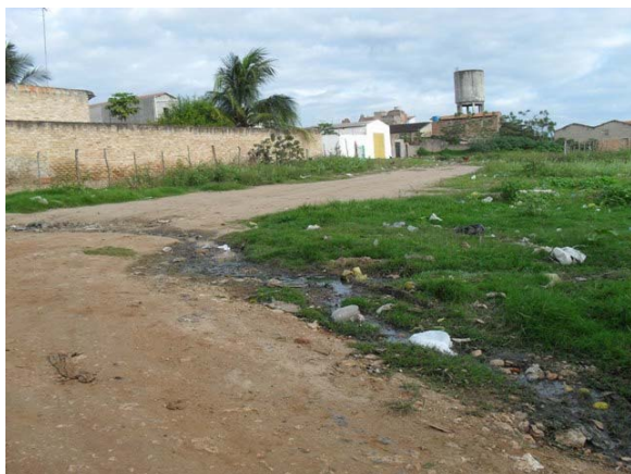
Foto 7: Lançamento de esgoto secundário a céu aberto – Rua Manoel Fidelis.
