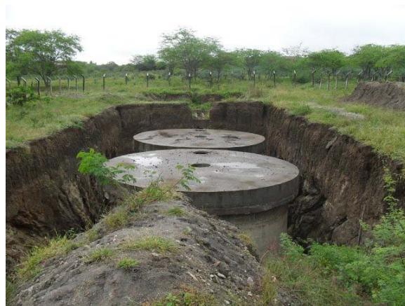
Foto 2: DAFA construído a mais de 2 anos – sem operação.
