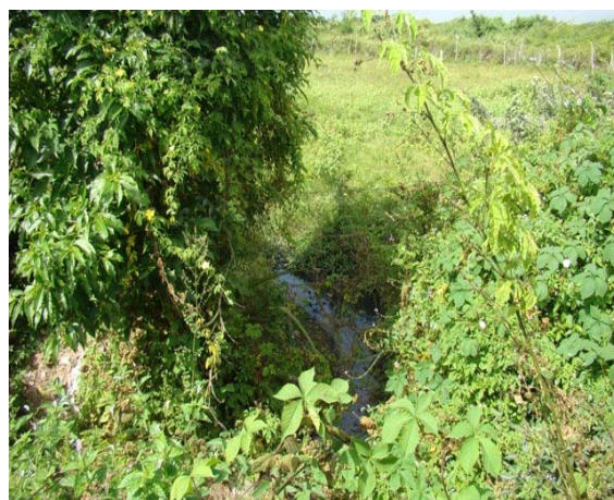
Foto 4: Área de chegada de várias redes de esgoto – Rua do Campo.
