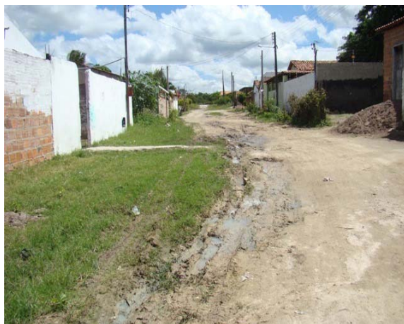
Foto 10: Ponto de lançamento de esgoto secundário a céu aberto – Rua José Sarney.
