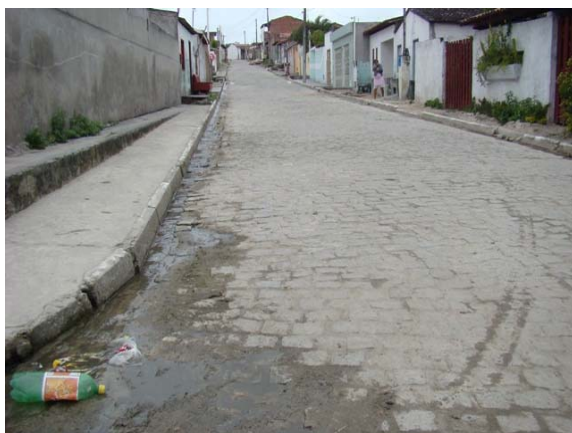
Foto 5: Ponto de lançamento de esgoto a céu aberto – Rua Joviniano Martins dos Santos com a Rua João Guilhermino – Bairro Jaqueira.
