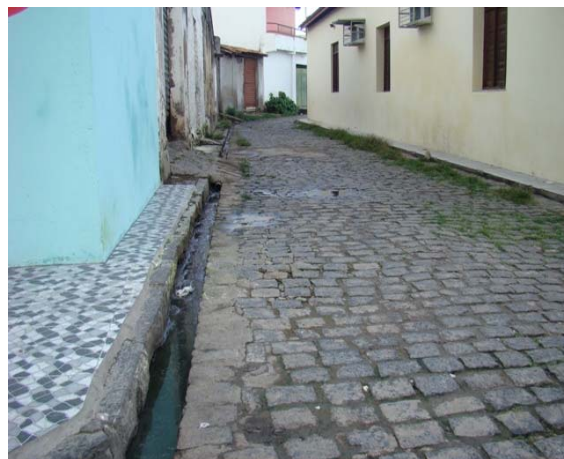
Foto 8: Esgoto secundário a céu aberto – ao lado da Câmara Municipal – Praça Dr. João Campos.
