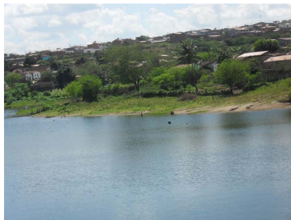
Foto 8: Açude Municipal – receptor de águas pluviais e esgotos – cidade ao fundo.
