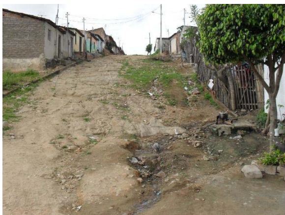
Foto 3: Esgoto a céu aberto – Rua O – Bairro Cascalheira.
