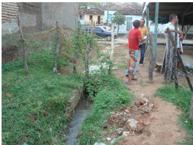
Foto 1: Ponto final da galeria e início de vala nos quintais – Rua do Vintém.
