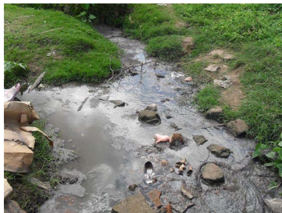
Foto 4: Lançamento de esgoto a céu aberto – final da Av. Bezerra de Menezes.
