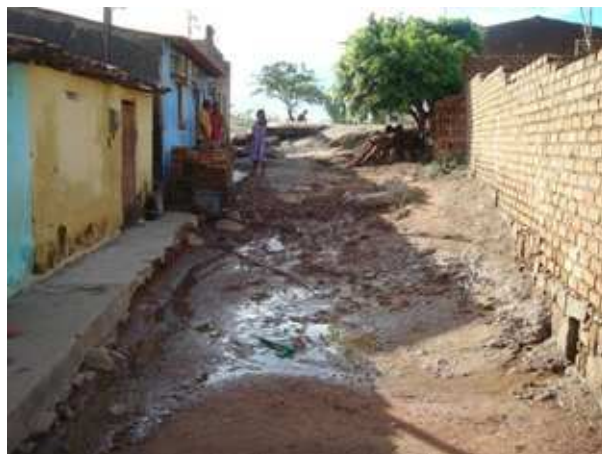
Foto 2: Rua São Gonçalo – atingida por enxurradas.
