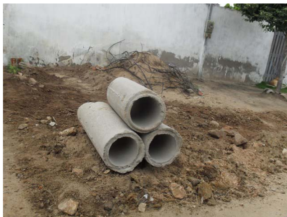
Foto 2: Tipo de manilha utilizada em redes de água pluvial e esgoto.
