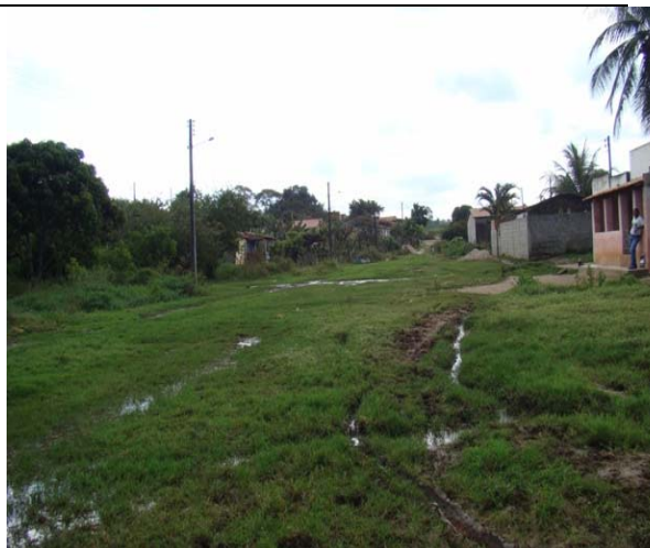
Foto 2: Área Crítica 1 – Rua Rui Barbosa – Bairro Recreio – Vila de Fátima.
