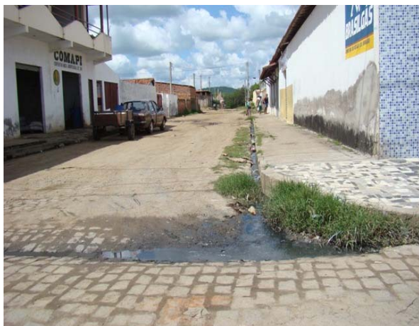
Foto 1: Esgoto a céu aberto – Na Av. Elvira Freitas com a Rua Luis França Carneiro.
