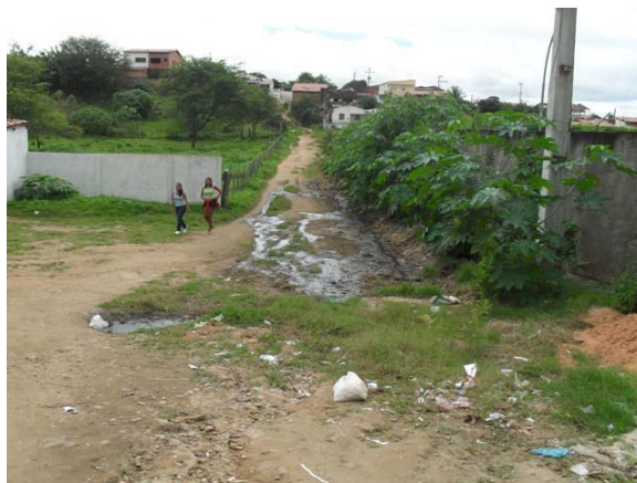
Foto 2: Lançamento a céu aberto – Rua Monsenhor Belenguer.
