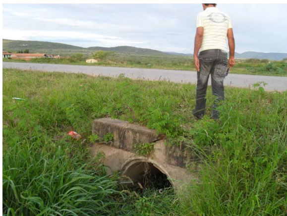
Foto 7: Travessia da rodovia – bueiro.
