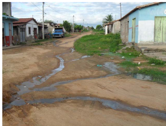
Foto 8: Lançamento de esgoto secundário a céu aberto – Travessa João Felisberto.
