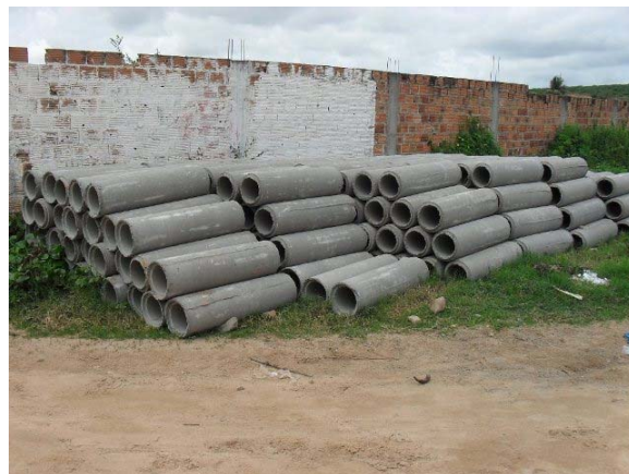
Foto 2: Obra de drenagem na Travessa Filófilo Menezes.
