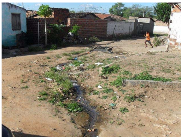
Foto 9: Lançamento a céu aberto – Rua Antonio Araujo.
