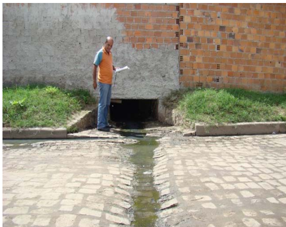
Foto 1: Início da galeria de micro-drenagem na Rua Josefina Carneiro de Almeida.
