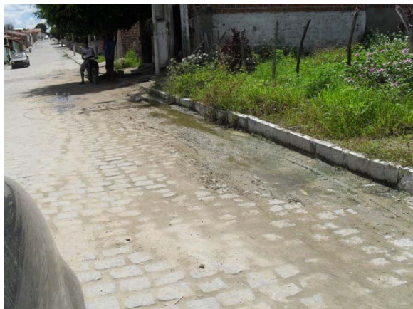
Foto 7: Lançamento a céu aberto – sarjeta – Rua Vitorino da Silva.
