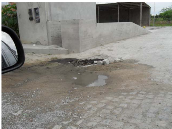
Foto 3: Elemento de microdrenagem – caixa com grelha na Rua Castro Alves.
