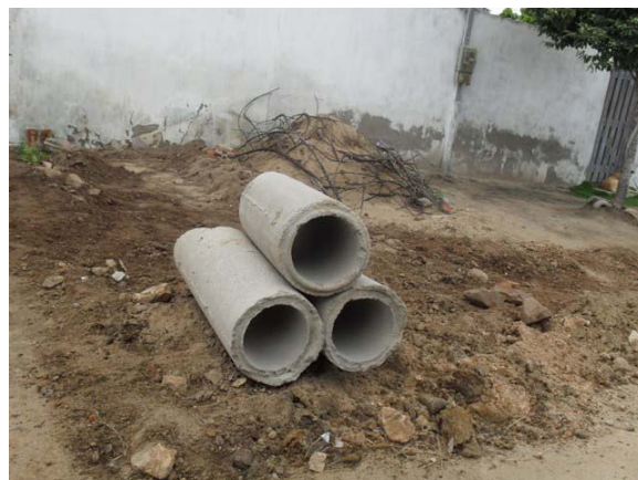
Foto 8: Tipo de manilha utilizada em redes de água pluvial e esgoto.
