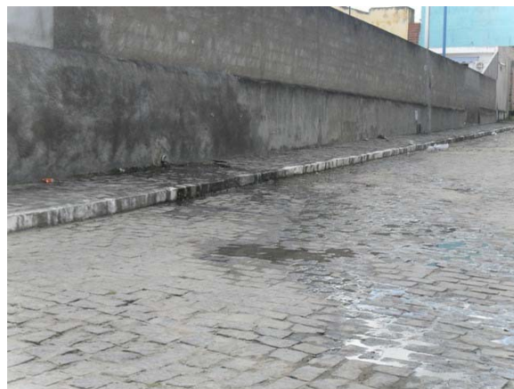
Foto 14: Lançamento a céu aberto – Rua Rubem Carneiro.
