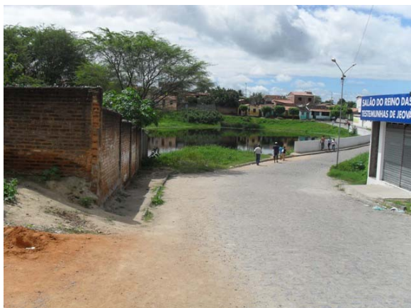
Foto 7: Tanque do Gado – receptor de águas pluviais e esgoto.
