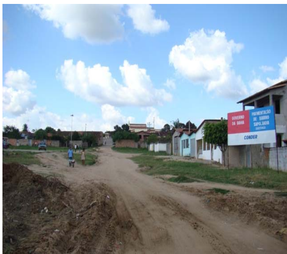
Foto 3: Área Crítica 1 – Rua Maria Cardoso Pedreira.
