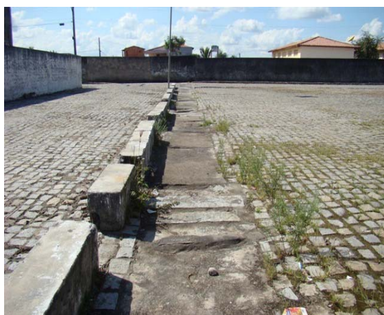
Foto 6: Estrutura da galeria de micro-drenagem – Av. Joaquim Lazaro Carneiro.
