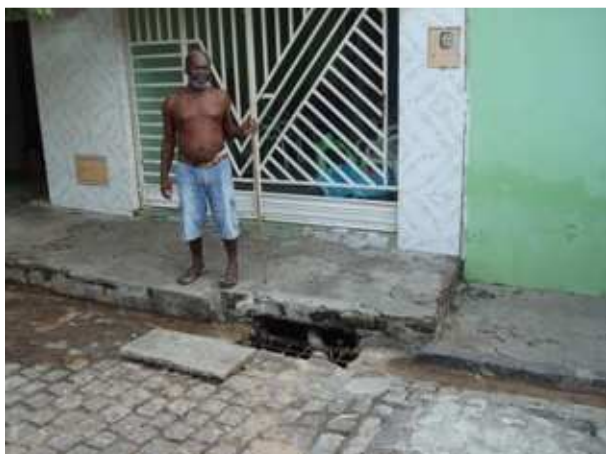
Foto 7: Rua São Gonçalo II – Vista da caixa de captação de galeria sob imóvel – montante
