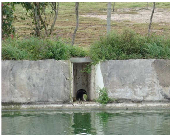
Foto 3: Estação de tratamento.
