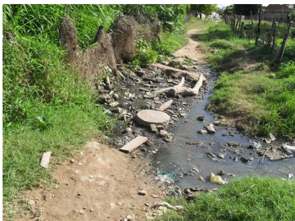
Foto 3: Lançamento a céu aberto – Rua João Ferreira de Matos.
