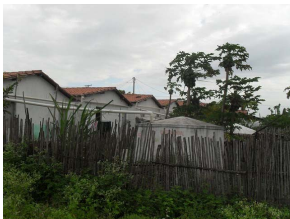
Foto 4: Aproveitamento de água de chuva em cisternas.
