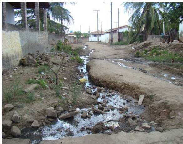
Foto 2: Esgoto a céu aberto – Av. Adalberto Santiago Ferreira – próximo ao Colégio Estadual Luis Júlio Carneiro.
