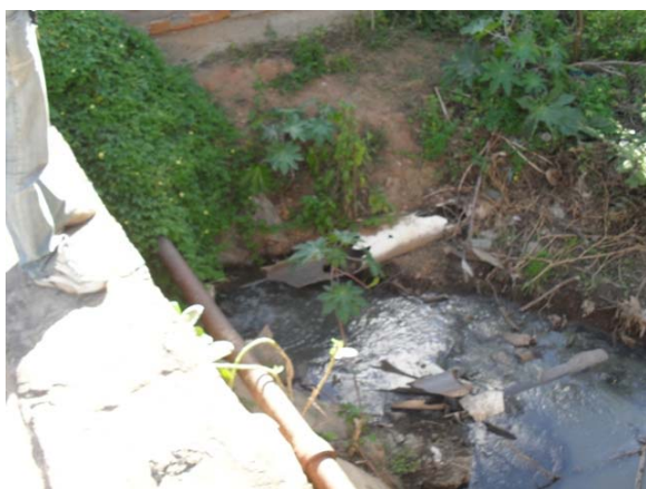
Foto 11: Lançamento a céu aberto – Rua do Chalet.
