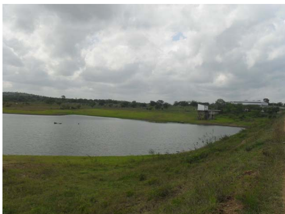
Foto 3: Açude Municipal – observa-se a preservação do manancial.
