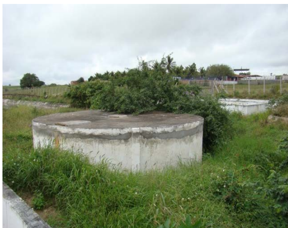
Foto 5: Estação de tratamento.
