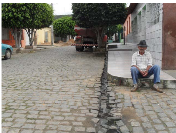
Foto 5: Lançamento a céu aberto – sarjeta – Rua Montevideo.
