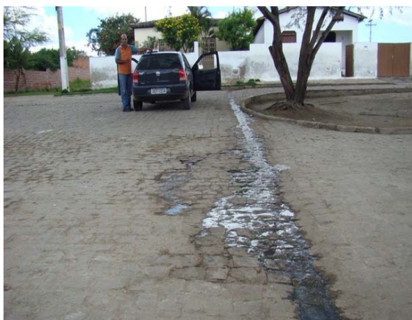
Foto 3: Esgoto a céu aberto – Av. Adalberto Santiago Ferreira – próximo ao Colégio Estadual Luis Júlio Carneiro.
