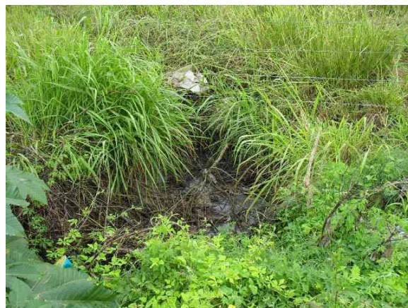
Foto 8: Lançamento de esgoto a céu aberto da Bairro Pedrinhas e Travessa Mário Miranda.
