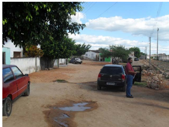
Foto 2: Rua atrás do campo – Área Crítica de alagamento.
