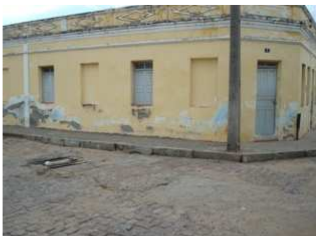
Foto 17: Rua Augusto Moura – alagamento
