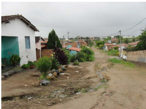
Foto 7: Esgoto a céu aberto – Bairro Algarobas – Rua Mário Miranda.
