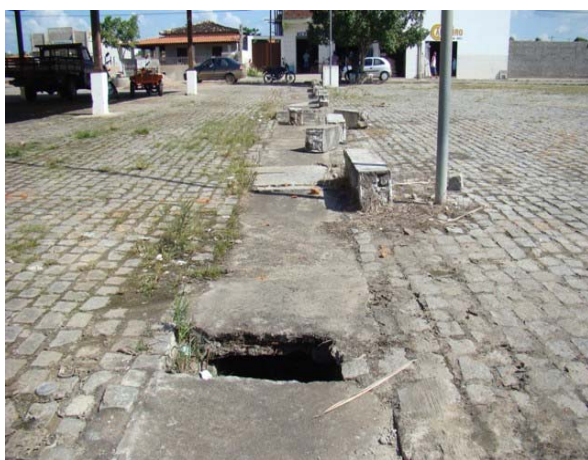
Foto 5: Estrutura da galeria de micro-drenagem – Av. Joaquim Lazaro Carneiro.
