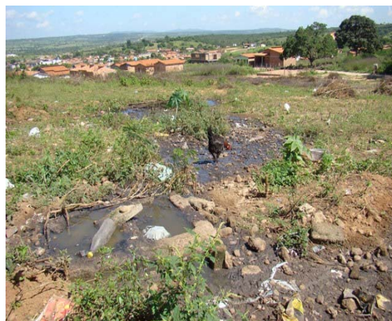
Foto 2: Bairro Tapera – caixa de passagem transbordando.
