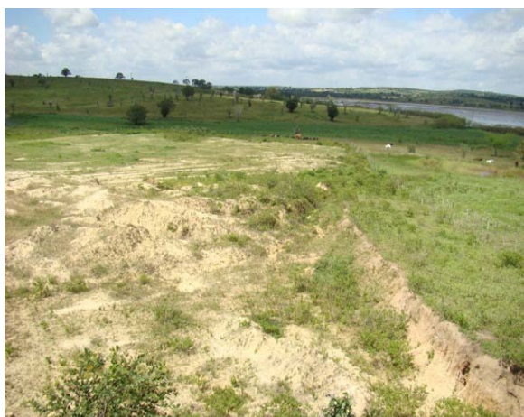
Foto 5: Futuras lagoas da ETE – estrada Biritinga / Lamarão
