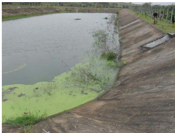
Foto 2: Lagoa de estabilização da ETE.
