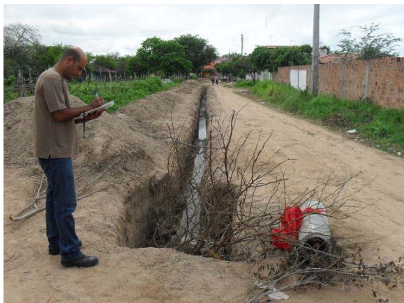
Foto 1: Obra de drenagem na Travessa Filófilo Menezes.
