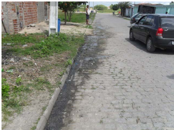
Foto 7: Escoamento para a sarjeta de esgoto secundário – Alto do Cascalho.
