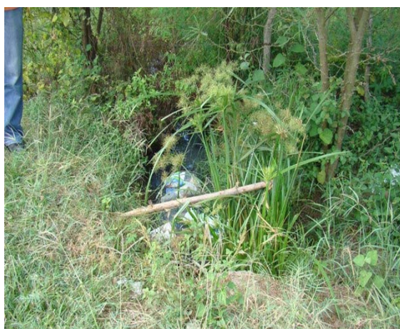
Foto 4: Final da galeria de micro-drenagem na Rua Elias Bernardino Carneiro.
