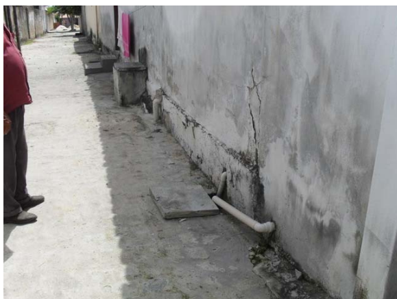
Foto 5: Ligação de esgoto primário e secundário para fossa comunitária.
