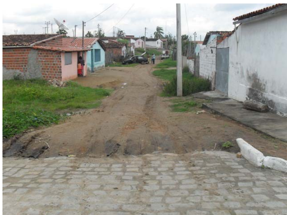
Foto 7: Área Crítica de alagamento – Rua Antonio Carneiro.
