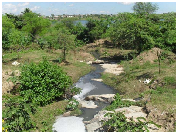
Foto 3: Bairro Juazeiro – lançamento a céu aberto de esgoto no Canal A. Lopes.
