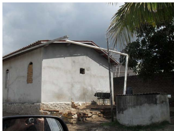
Foto 10: Aproveitamento de água de chuva – cisterna
