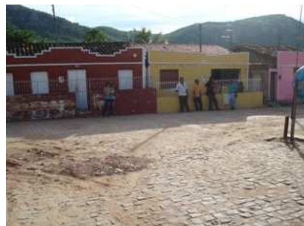
Foto 6: Rua São Gonçalo II – atingida por enxurradas.
