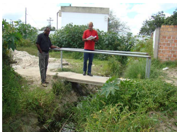
Foto 10: Parte final do Canal da Urbis – travessia da Av. Antonio Carlos Magalhães – Câmara de Vereadores.
