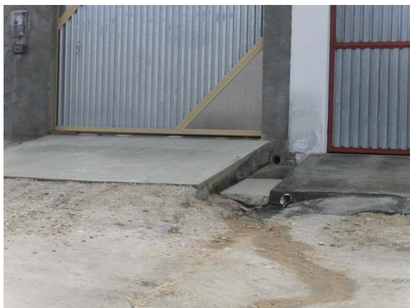
Foto 13: Lançamento a céu aberto – Rua Rubem Carneiro.
