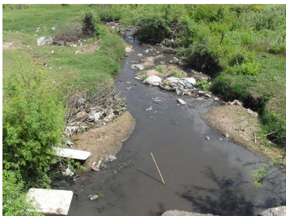
Foto 9: Lançamento a céu aberto – Rua 15 de Novembro.
