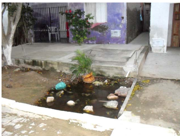
Foto 15: Fossa transbordando – Rua Manoel Fidelis.
