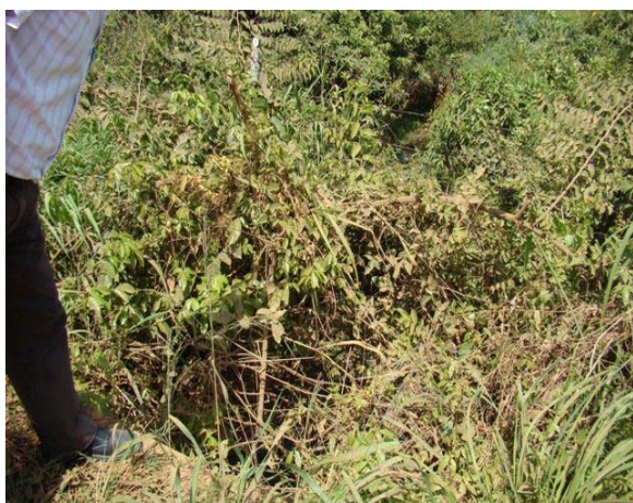
Foto 3: Ponto de descarte de esgoto da rede em operação.
