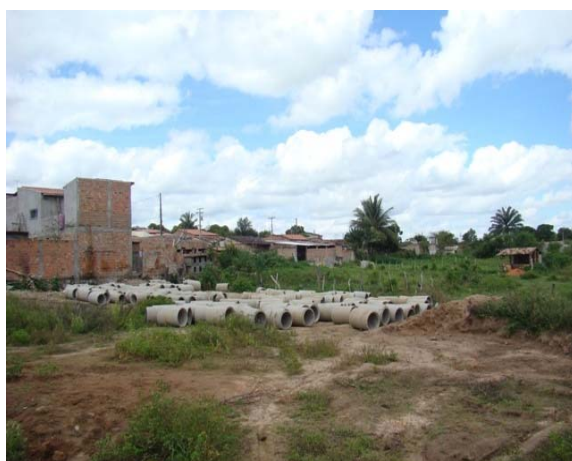
Foto 4: Casas com lançamento direto no Tanque de Militão e manilhas do loteamento.
