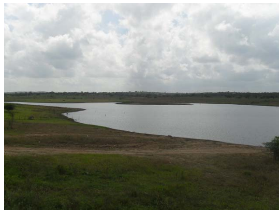
Foto 2: Açude Municipal – observa-se a preservação do manancial.
