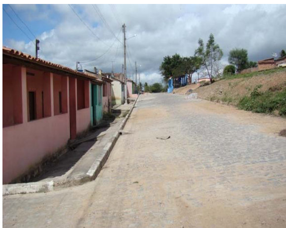
Foto 3: Área Crítica – com relatos de desabamentos.
