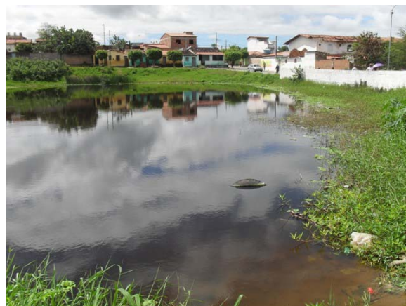
Foto 14: Tanque do Gado – corpo receptor de águas pluviais e esgotos.
