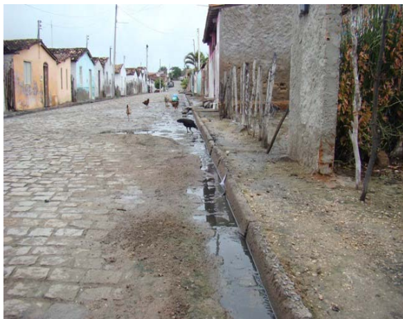
Foto 1: Presença de esgoto secundário pela sarjeta.
