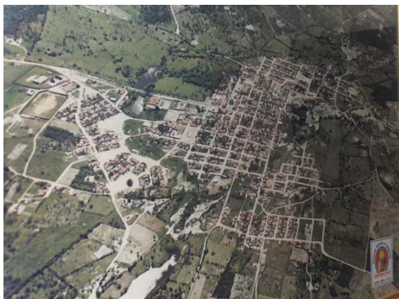
Foto 1: Vista aérea da cidade.
