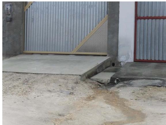
Foto 8: Lançamento a céu aberto – Rua Deputado Rubem Carneiro.
