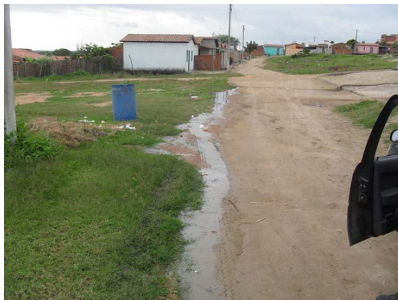
Foto 2: Conjunto Aloísio Carneiro – Área Crítica 1 – área de alagamento.
