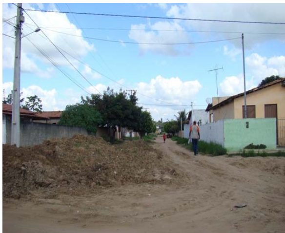
Foto 1: Área Crítica 1 – Rua Maria Cardoso Pedreira.
