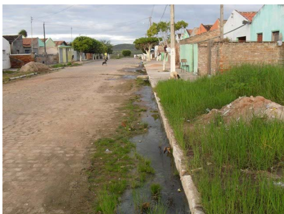
Foto 11: Escoamento de esgoto secundário na sarjeta – Rua Manoel Fidelis.
