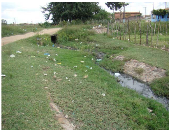
Foto 5: Bairro da Estação – Riacho recebendo águas pluviais e esgotos.
