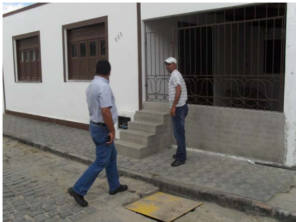
Foto 7: Imóvel com proteção para alagamento – Rua José Bonifácio.
