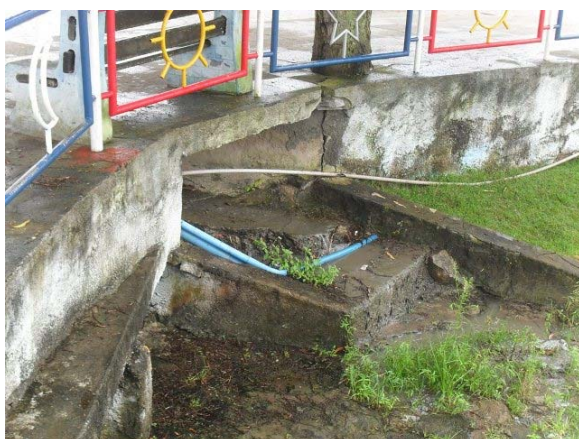
Foto 7: Tanque Grande – local de chegada de água pluvial.
