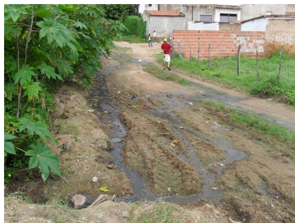
Foto 4: Lançamento a céu aberto de água pluvial e esgoto secundário.
