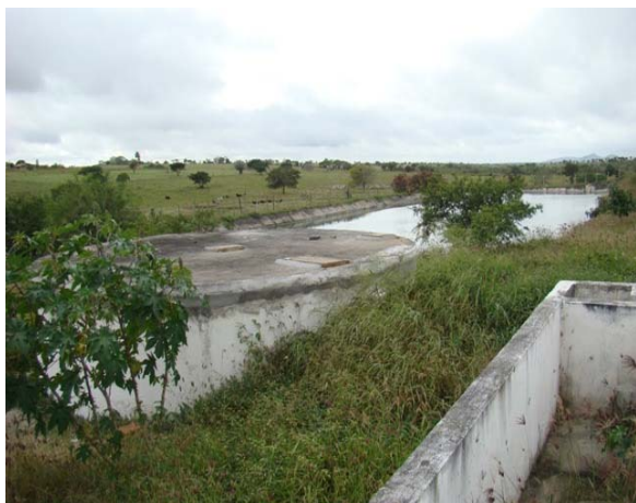
Foto 1: Estação de tratamento.
