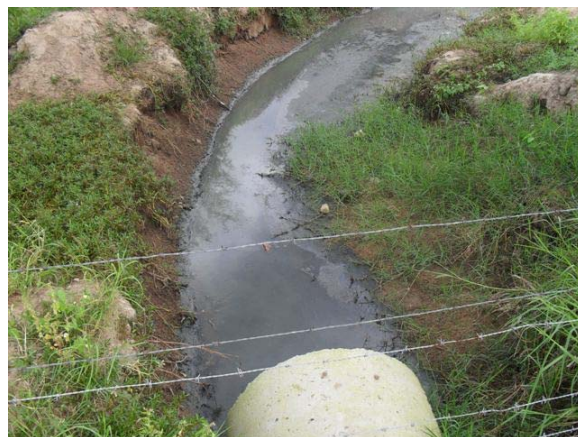
Foto 2: Lançamento de esgoto a céu aberto – final da Rua Santos Antônio com a Rua Cajazeiras.
