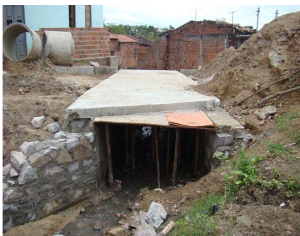
Foto 3: Início da obra de macrodrenagem do Canal da Pampulha na 4ª Travessa da Pampulha.
