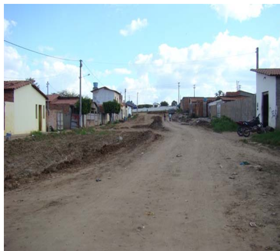
Foto 4: Área Crítica 1 – Rua Maria Cardoso Pedreira.
