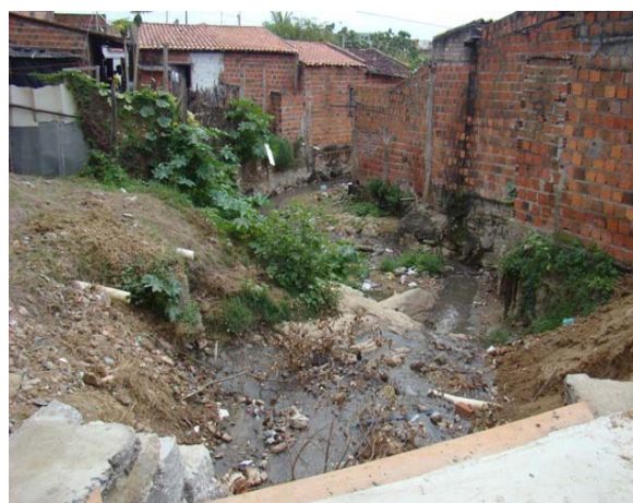
Foto 4: Início da obra de macrodrenagem do Canal da Pampulha na 4ª Travessa da Pampulha.
