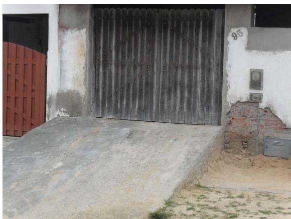
Foto 3: Área de alagamento – Rua Antonio Lopes.
