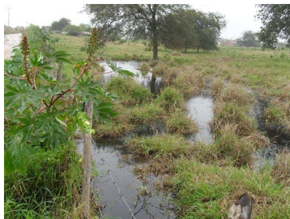
Foto 6: Área de acumulação de esgoto e água pluvial – brejo – próximo as Casas populares.
