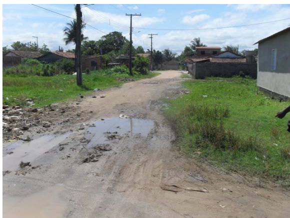
Foto 5: Área Crítica 1 – Bairro Peruípe – área de alagamento.
