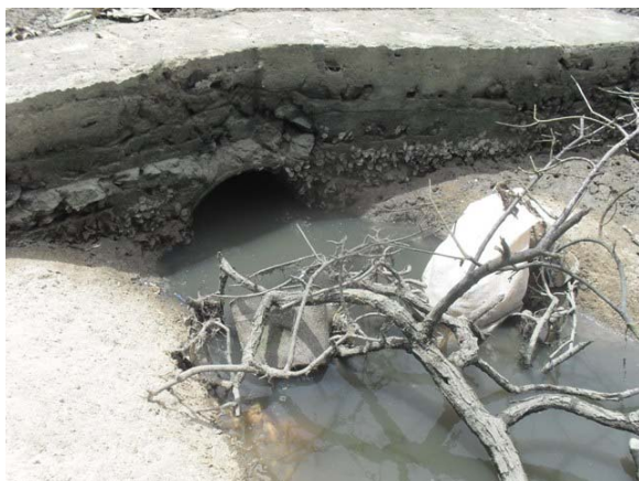
Foto 7: Ponto final da galeria circular enterrada no Rio dos Macacos.
