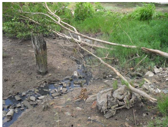
Foto 2: Ponto de lançamento concentrado de esgoto.
