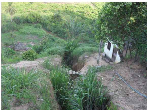
Foto 7: Ponto de lançamento de esgotos provenientes da rede mista - convergem para o Ribeirão do Ouro.
