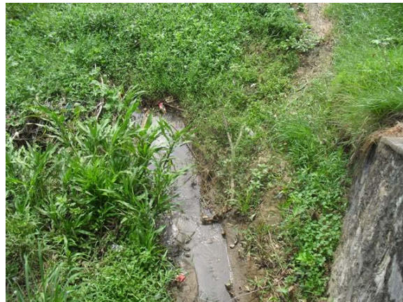
Foto 2: Córrego do Lava Pé que ajuda no escoamento das águas da cidade.
