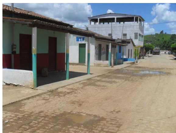
Foto 4: Área Crítica 3 – Rua Bonifácio José Dantas – área de alagamento.
