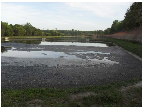
Foto 5: Lagoa anaeróbica da ETE.
