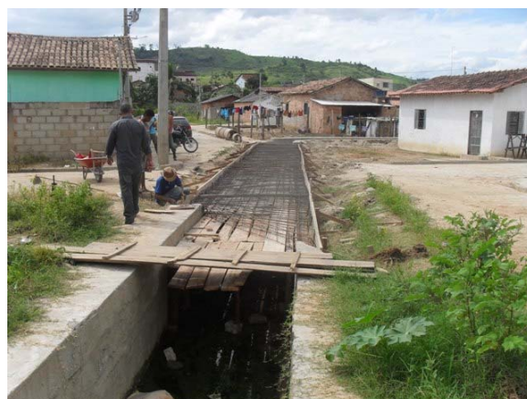
Foto 6: Trecho de concreto do Canal no Córrego São Pedro.
