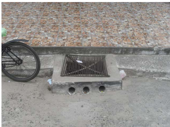
Foto 1: Caixa com grelha em um nível acima da rua.
