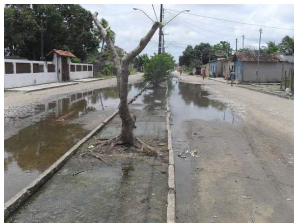
Foto 22: Área Crítica 6 – Av. Dr. Sócrates Ramos – área de alagamento.
