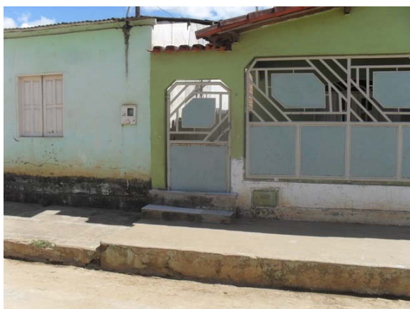
Foto 5: Área Crítica 1 – Avenida Sadi Teixeira – área de alagamento.
