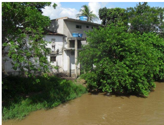
Foto 2: Lançamento direto de esgotos no Rio Itanhém.
