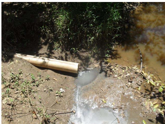
Foto 7: Lançamento direto de esgoto no Rio Jucuruçu.
