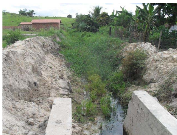
Foto 4: Trecho de concreto do Canal no Córrego São Pedro.
