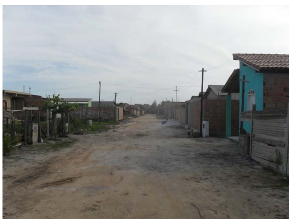
Foto 9: Área Crítica 4 – Rua dos Amigos – área de alagamento.
