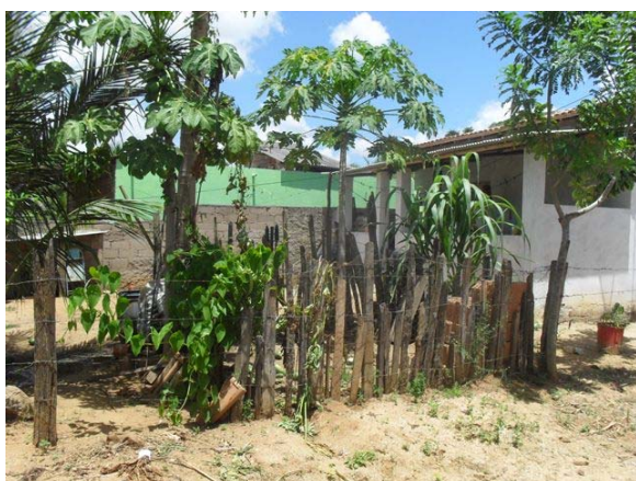
Foto 3: Área Crítica 2 – Bairro Califórnia – área de inundação e enxurrada.
