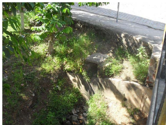
Foto 2: Ponto final da galeria enterrada despejando no Rio Itanhém.
