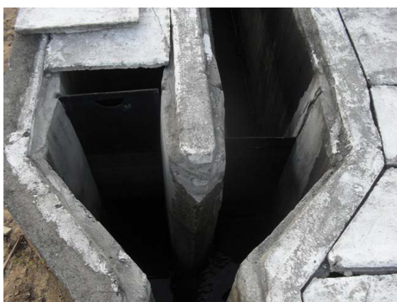
Foto 5: Visão geral do tratamento preliminar da ETE.
