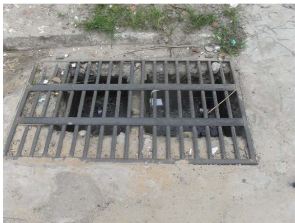
Foto 2: Aspecto da caixa com grelha na Avenida das Palmeiras.
