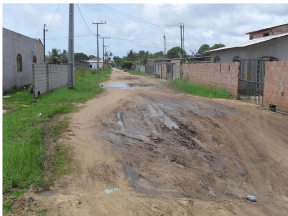
Foto 19: Área Crítica 5 – Rua São Judas Tadeu – Bairro Morais – área de alagamento.
