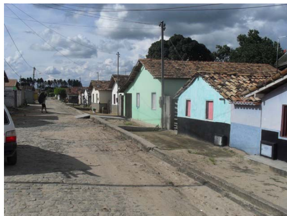
Foto 2: Área Crítica 1 – Rua Antonio Rocha Mota – área de enxurrada.
