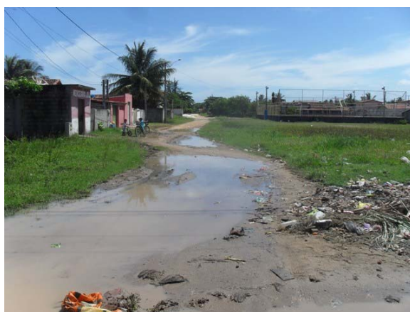
Foto 4: Área Crítica 1 – Bairro Peruípe – área de alagamento.
