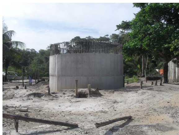
Foto 4: Elevatória em construção do novo SES.
