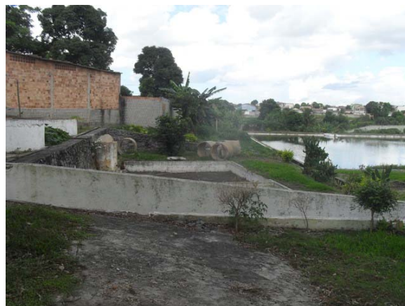
Foto 8: Visão geral da ETE Urbis.
