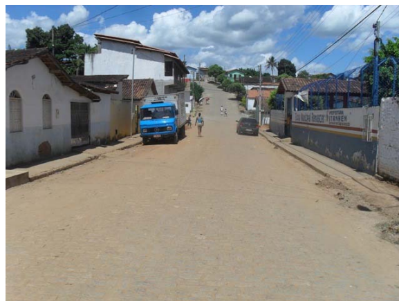
Foto 8: : Área Crítica 2 – Rua Afonso Pena – área de alagamento.
