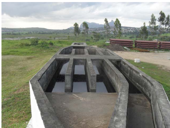
Foto 11: Tratamento preliminar na nova ETE.
