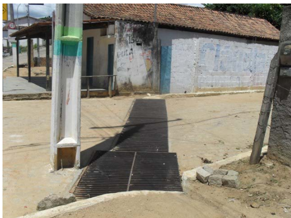
Foto 1: Elemento de drenagem (engole tudo) na Rua em frente a Escola Municipal.
