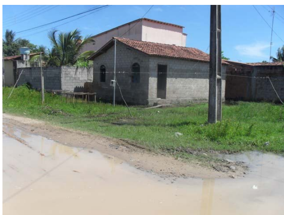
Foto 3: Área Crítica 1 – Bairro Peruípe – área de alagamento.
