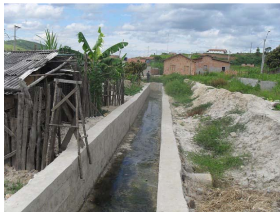
Foto 2: Esgotos lançados no Canal Lava Pés.
