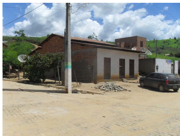
Foto 6: Área Crítica 4 – Rua Ramiro Rocha (Escola Municipal) – área de enxurrada.
