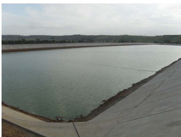
Foto 5: Lagoas construídas do novo SES.
