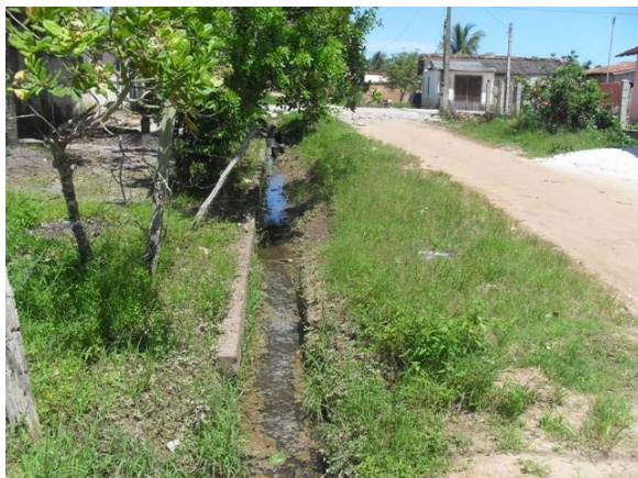
Foto 1: Canaleta utilizada para escoar águas pluviais.
