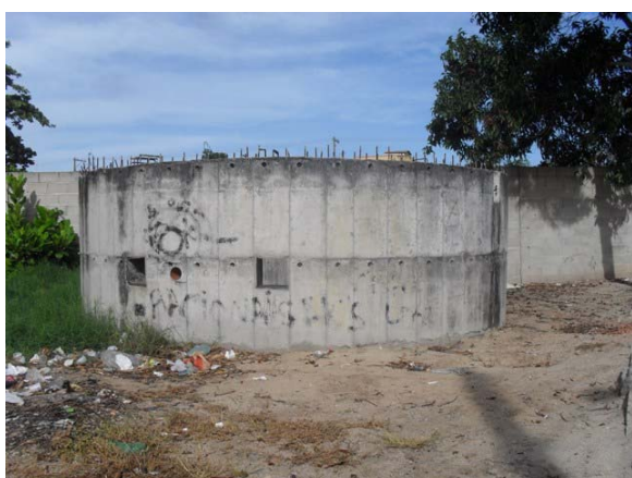
Foto 5: Elevatória em construção do novo SES.
