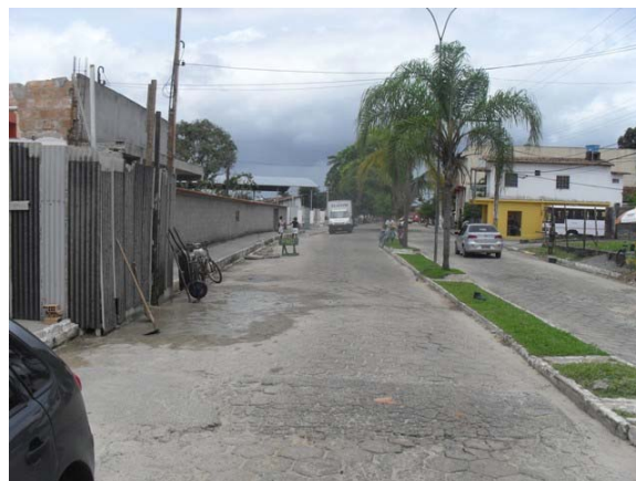
Foto 14: Área Crítica 2 – Avenida das Palmeiras – área de alagamento.
