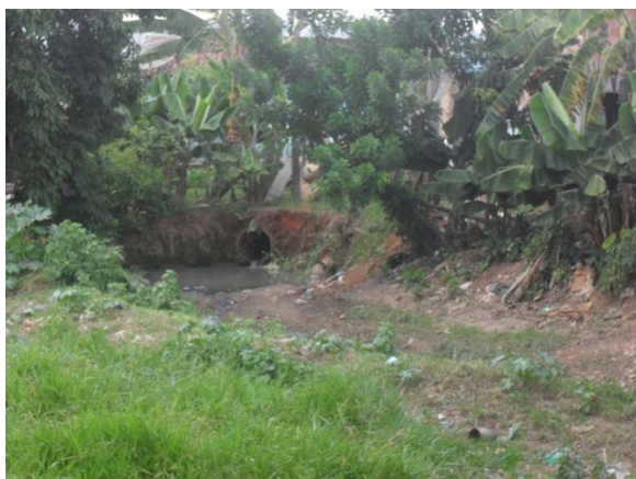
Foto 3: Final da galeria da Rua Sadi Teixeira.
