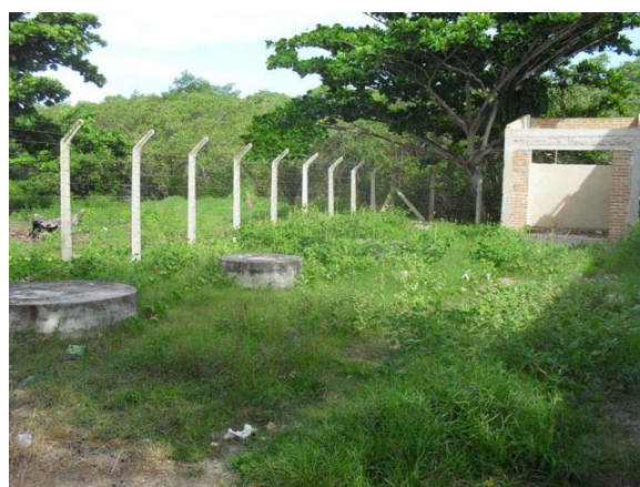
Foto 6: Elevatória em construção do novo SES.
