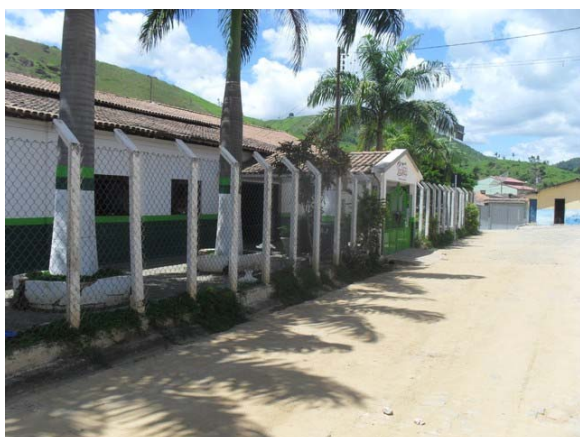
Foto 5: Área Crítica 4 – Rua Ramiro Rocha – área de enxurrada.
