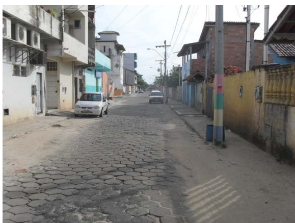
Foto 11: Área Crítica 5 – Rua Raul Gazinelli – área de alagamento.
