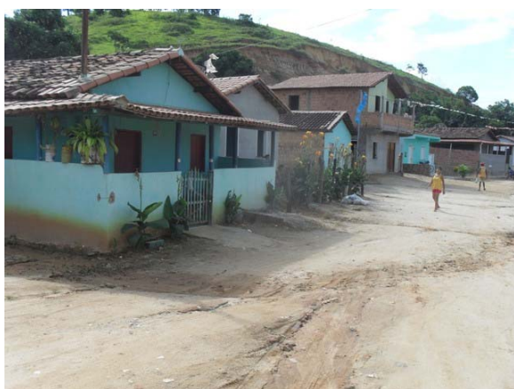
Foto 9: Área Crítica 3 – Bairro Nossa Senhora Aparecida – área de enxurrada.
