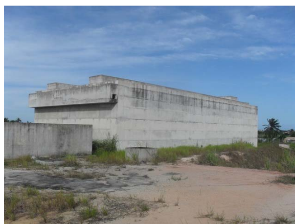
Foto 10: Novo DAFA da ETE.
