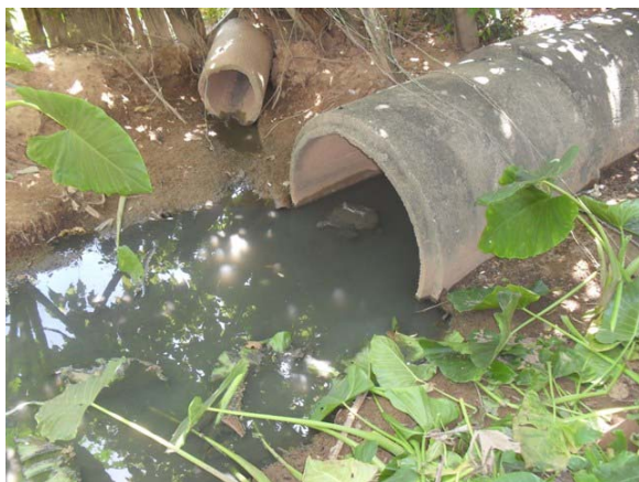
Foto 1: Final da galeria da Rua Afonso Pena.
