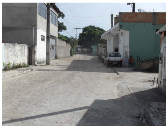
Foto 6: Área Crítica 1 – Rua Padroeira Franco – área de inundação.
