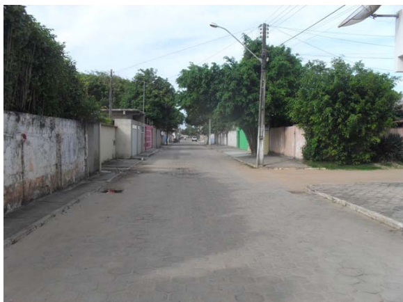
Foto 7: Área Crítica 3 – Av. Nova Viçosa – área de alagamento.
