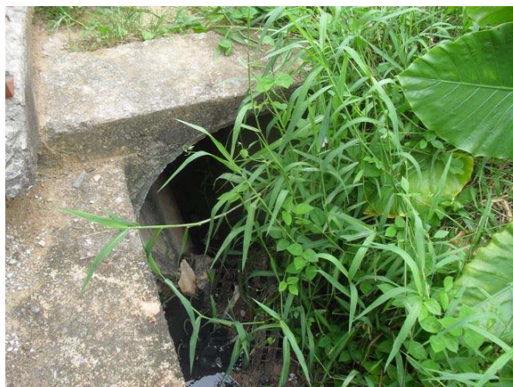
Foto 2: Microdrenagem do Bairro Várzea Alegre.
