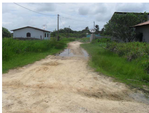
Foto 12: Área Crítica 1 – Rua 5 – Bairro Olaria – área de alagamento.
