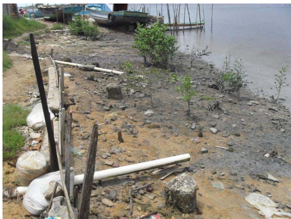
Foto 1: Lançamento difuso de esgotos secundários no Rio dos Macacos.
