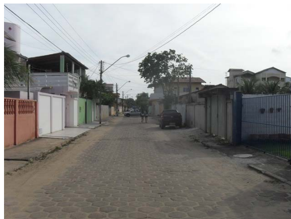
Foto 8: Área Crítica 3 – Av. Nova Viçosa – área de alagamento.
