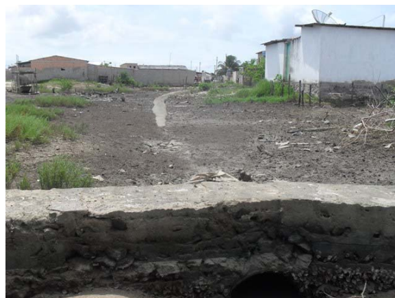
Foto 8: Ponto final da galeria circular enterrada no Rio dos Macacos.
