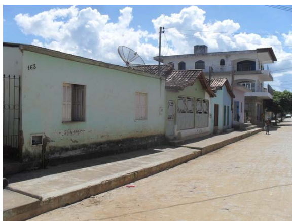
Foto 6: Área Crítica 1 – Avenida Sadi Teixeira – área de alagamento.
