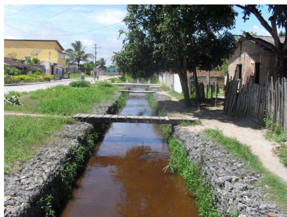
Foto 4: Trecho de Gabião do Canal do São Braz.
