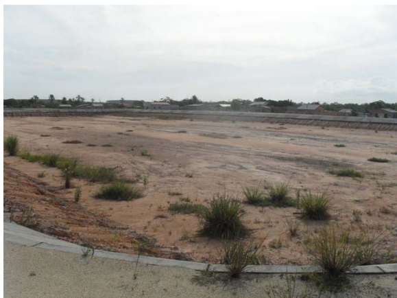
Foto 7: Lagoas de Estabilização sendo construídas.
