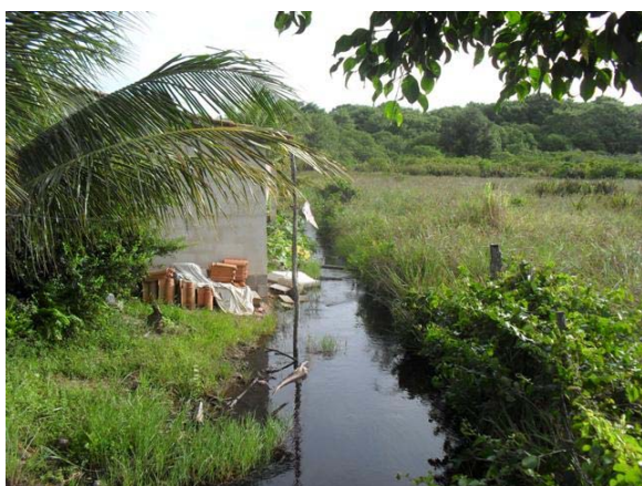
Foto 3: Canal aberto em leito natural em direção ao Rio Mucuri.
