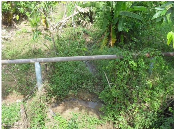
Foto 1: Córrego do Lava Pé que ajuda no escoamento das águas da cidade.
