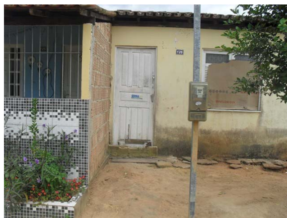
Foto 22: Área Crítica 13 – Vale do Jucuruçu – área de alagamento.
