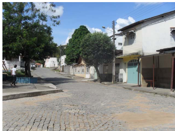
Foto 8: Área Crítica 2 – Rua Arnaldo Costa – área de alagamento.
