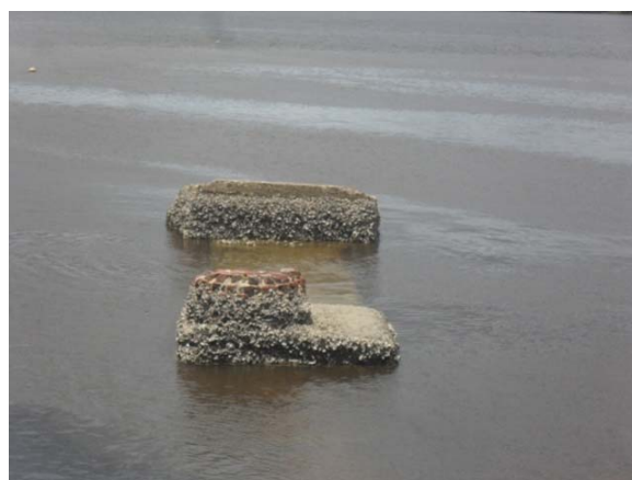
Foto 10: Ponto final da galeria circular enterrada no Rio dos Macacos.
