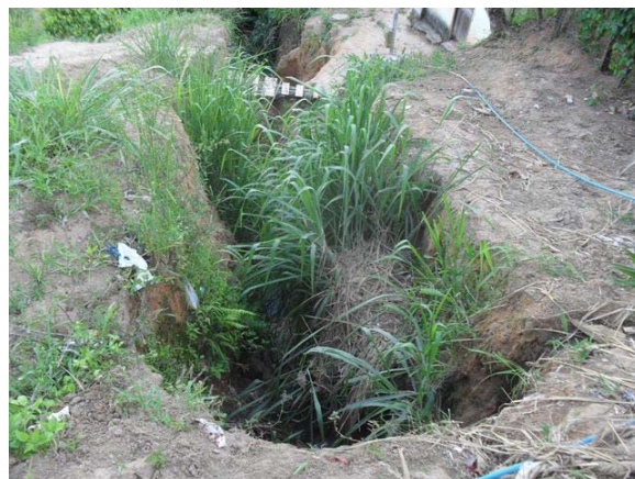
Foto 8: Ponto de lançamento de esgotos provenientes da rede mista - convergem para o Ribeirão do Ouro.
