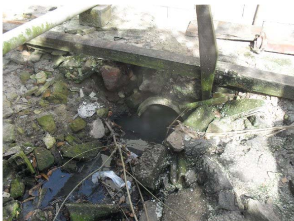
Foto 5: Ponto final do dispositivo de drenagem.
