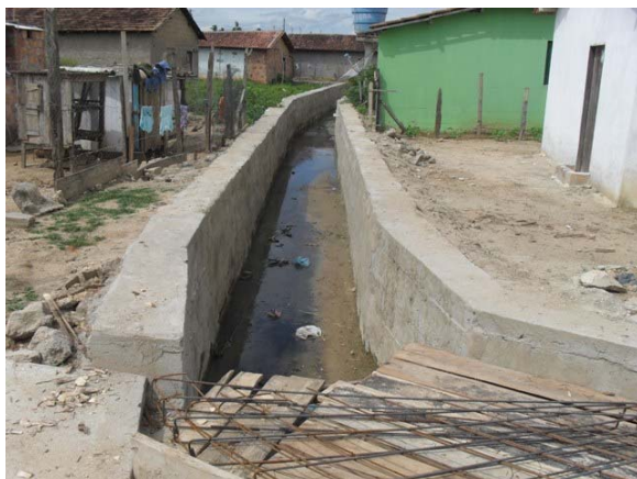
Foto 7: Trecho de concreto do Canal no Córrego São Pedro.
