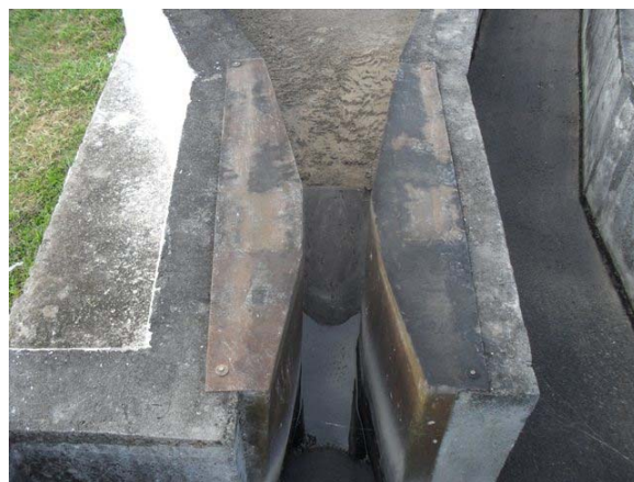
Foto 10: Tratamento preliminar na nova ETE.
