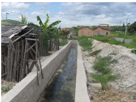
Foto 5: Trecho de concreto do Canal no Córrego São Pedro.
