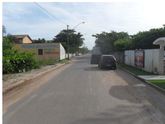
Foto 14: Área Crítica 6 – Rua ponta de Areia com a Rua Teófilo Otoni – área de alagamento.
