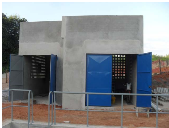
Foto 6: Estação de tratamento de esgotos em construção.
