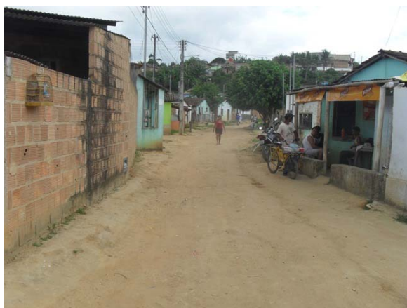
Foto 19: Área Crítica 12 – Rua Bahia – área de alagamento.
