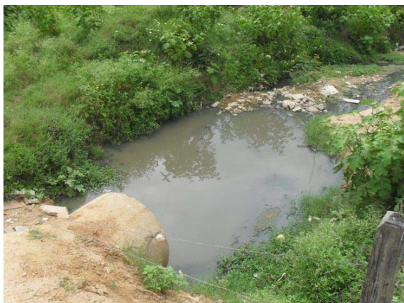
Foto 3: Microdrenagem do Bairro Várzea Alegre.
