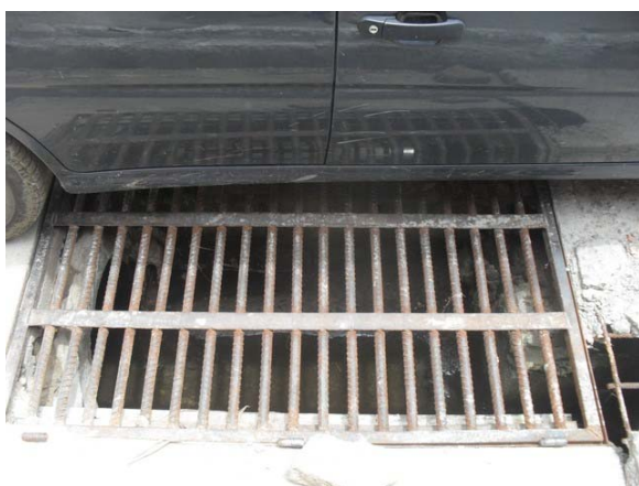
Foto 3: Aspecto da caixa com grelha na Avenida das Palmeiras.
