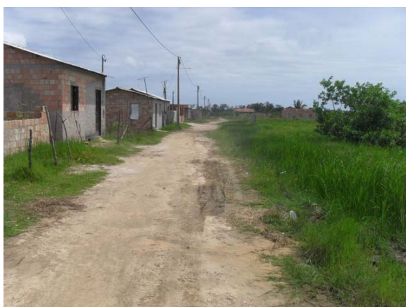
Foto 11: Área Crítica 1 – Rua 5 – Bairro Olaria – área de alagamento.
