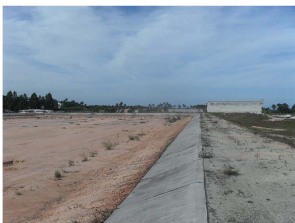
Foto 9: Lagoas de Estabilização sendo construídas.
