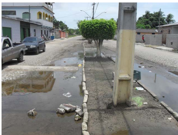
Foto 21: Área Crítica 6 – Av. Dr. Sócrates Ramos – área de alagamento.
