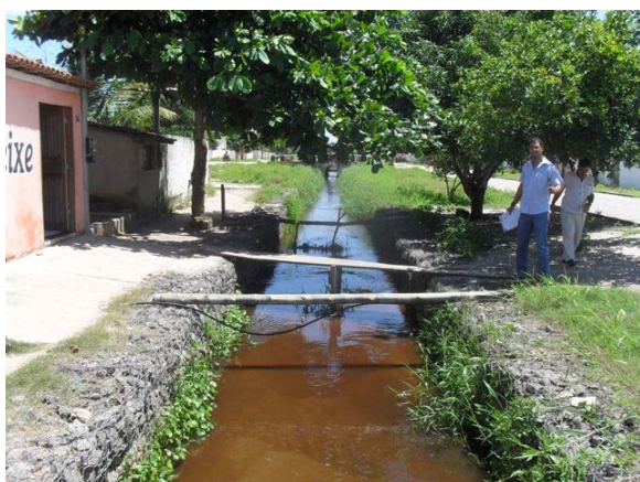
Foto 3: Trecho de Gabião do Canal do São Braz.
