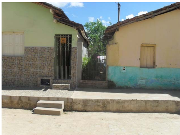
Foto 7: Área Crítica 2 – Rua Afonso Pena – área de alagamento.
