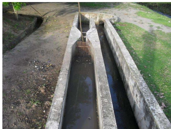
Foto 2: Aspectos gerais das estruturas de tratamento preliminar.
