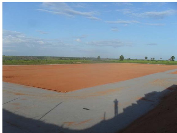
Foto 2: Estação de tratamento de esgotos em construção.
