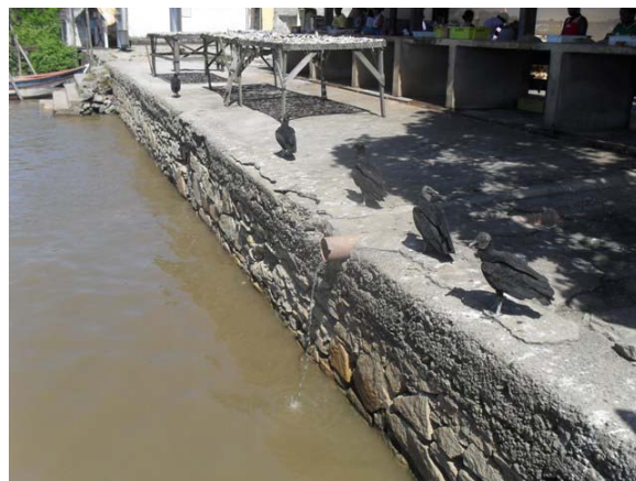
Foto 2: Lançamento difuso de esgotos no Rio Peruípe.
