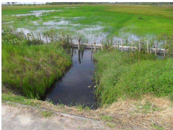
Foto 1: Canal aberto em leito natural em direção ao Rio Mucuri.
