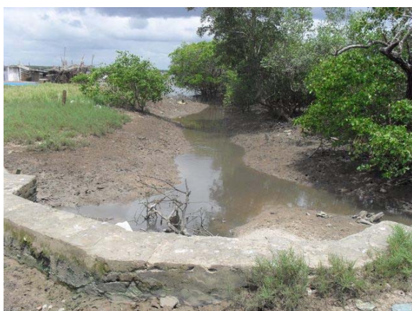
Foto 9: Ponto final da galeria circular enterrada no Rio dos Macacos.
