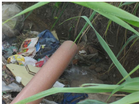
Foto 2: Esgotos sendo lançados no fundo do estádio municipal.
