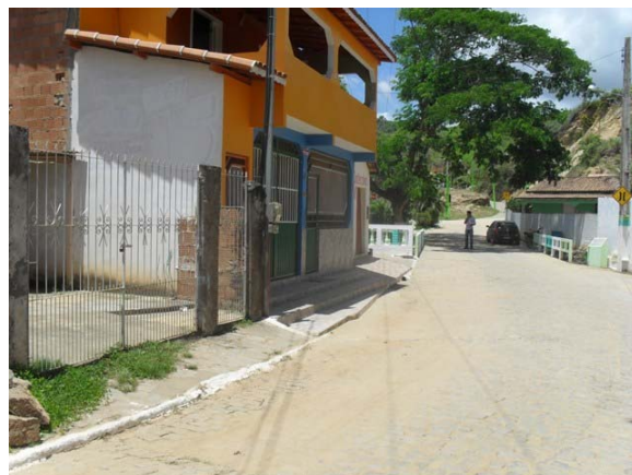
Foto 2: Área Crítica 1 – Rua Trindade – área de alagamento.
