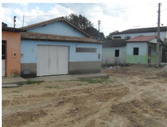
Foto 6: Área Crítica 2 – Rua da Aurora – área de alagamento.
