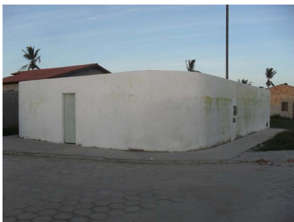
Foto 3: Visão geral da Estação Elevatória.
