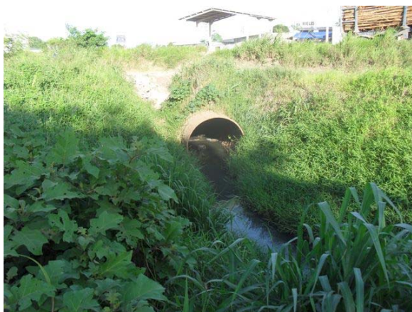
Foto 1: Bueiro da travessia da BR-101 do Canal da Rua José Linhares.
