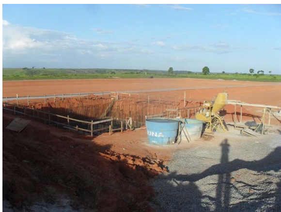
Foto 3: Estação de tratamento de esgotos em construção.
