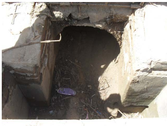
Foto 2: Caixa de redução de 1000 mm para 600 mm.
