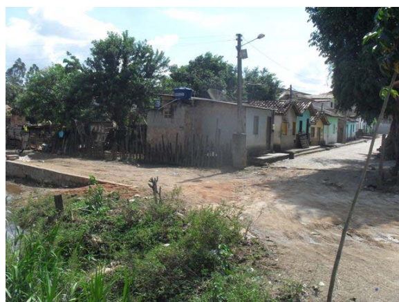
Foto 6: Área Crítica 1 – Rua Ibirajá – área de inundação.
