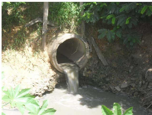
Foto 2: Final da galeria da Rua Afonso Pena.
