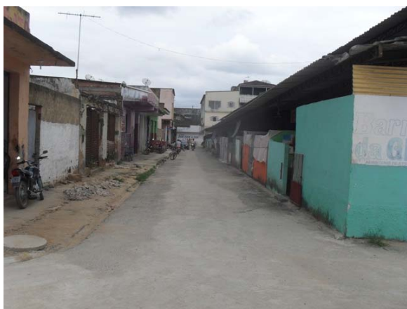
Foto 23: Área Crítica 14 – Praça do Mercado Municipal – área de alagamento.
