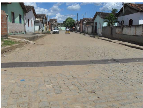
Foto 3: Engole tudo na Rua Arlindo Quaresma.
