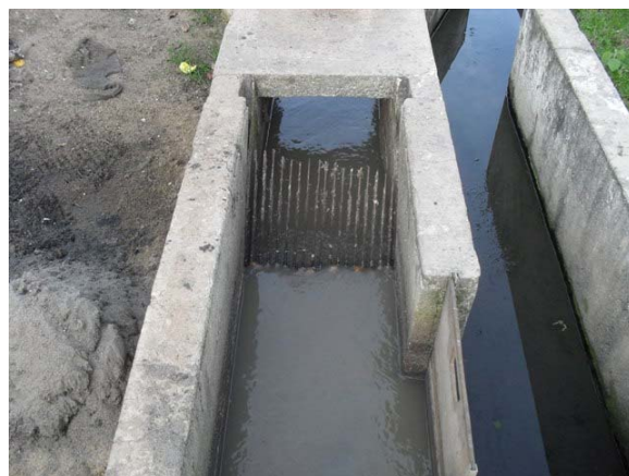
Foto 4: Gradeamento na entrada da ETE.
