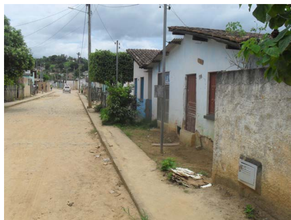
Foto 28: Área Crítica 17 – Rua Alcobaça – área de alagamento.
