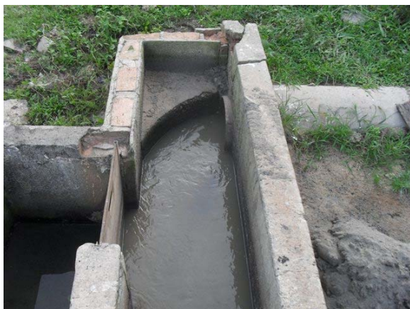
Foto 1: Aspectos gerais das estruturas de tratamento preliminar.
