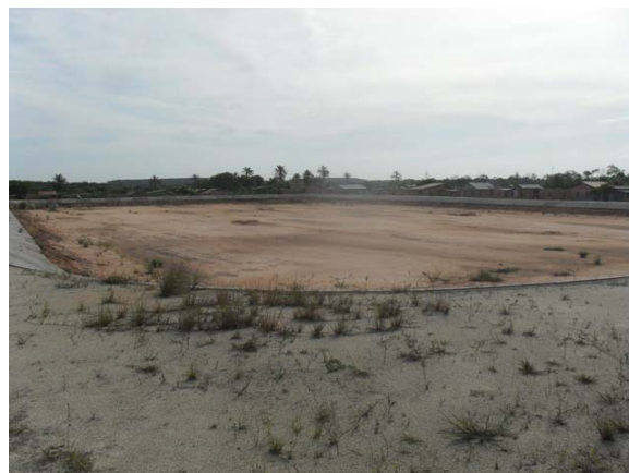
Foto 8: Lagoas de Estabilização sendo construídas.
