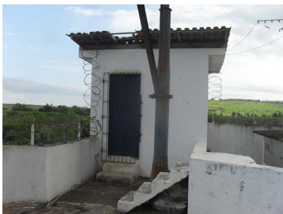
Foto 3: Estação Elevatória existente do SLE.
