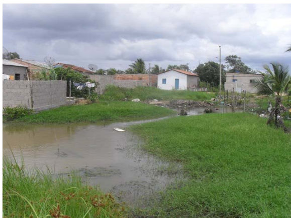
Foto 13: Área Crítica 1 – Rua 5 – Bairro Olaria – área de alagamento.
