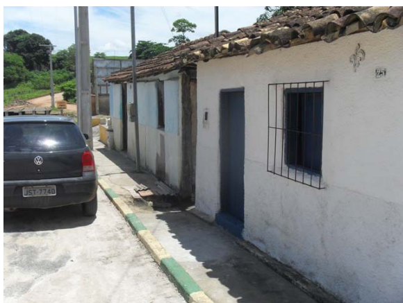
Foto 5: Área Crítica 2 – Rua Dr. José da Cruz – área de enxurrada.
