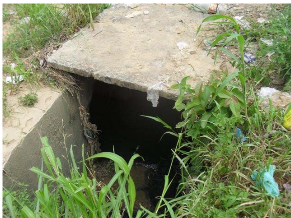
Foto 1: Microdrenagem do Bairro Várzea Alegre.
