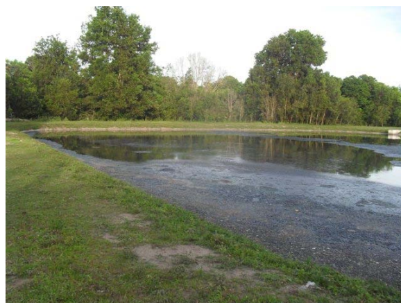
Foto 6: Lagoa anaeróbica da ETE.
