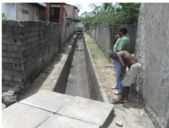
Foto 6: Canal revestido de concreto na rua da Vala.
