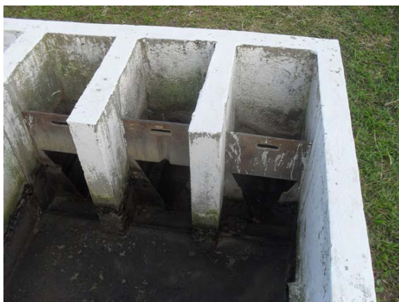
Foto 9: Tratamento preliminar na nova ETE.
