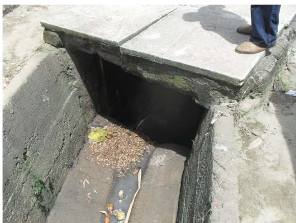
Foto 5: Canal revestido de concreto na rua da Vala.
