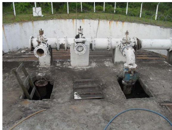
Foto 2: Estação Elevatória existente do SLE.
