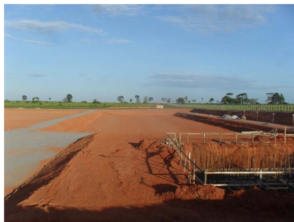
Foto 4: Estação de tratamento de esgotos em construção.
