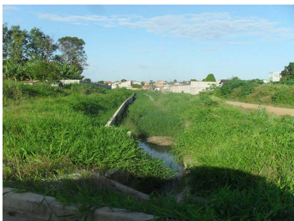
Foto 3: Trecho do Canal da Rua José Linhares revestido em concreto.
