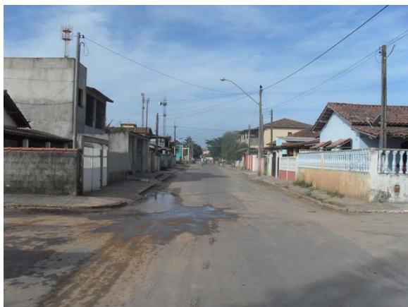
Foto 13: Área Crítica 6 – Rua ponta de Areia com a Rua Teófilo Otoni – área de alagamento.
