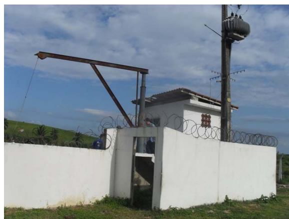
Foto 4: Estação Elevatória existente do SLE.
