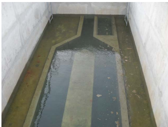
Foto 5: Estação de tratamento de esgotos em construção.
