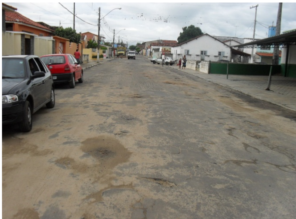
Foto 11: Vista de avenida vizinha a praça localizada em frente à prefeitura. Uma das vias que contribuem para a ocorrência de alagamento na área crítica 5.
