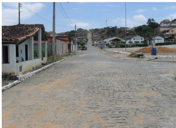
Foto 13: Rua Francisco Oliveira. Vista de outro ângulo da área crítica por conta da ocorrência de alagamento.
