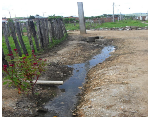
Foto 14: Invasão próxima ao bairro gameleira. Os esgotos que são lançados diretamente das casas nas valetas seguem a céu aberto até serem canalizados pela rede coletora próxima.
