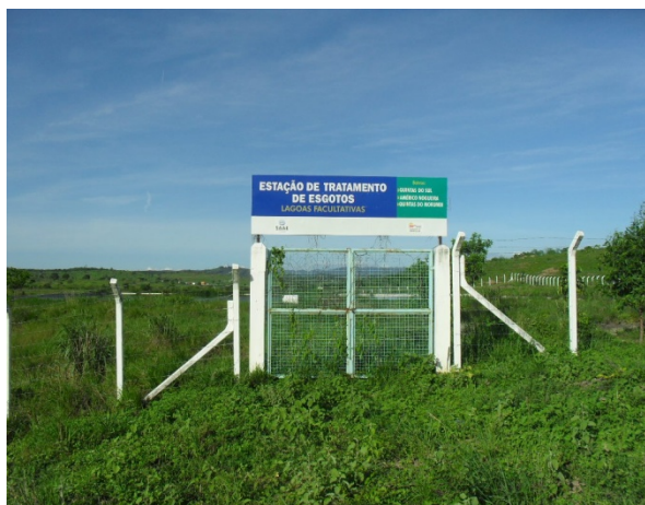
Foto 10: Etapa complementar do sistema isolado dos bairros Quintas do Sul, Quintas do Morumbi, Américo Nogueira e Loteamento Alvorada. Unidade de tratamento preliminar e lagoas de estabilização
