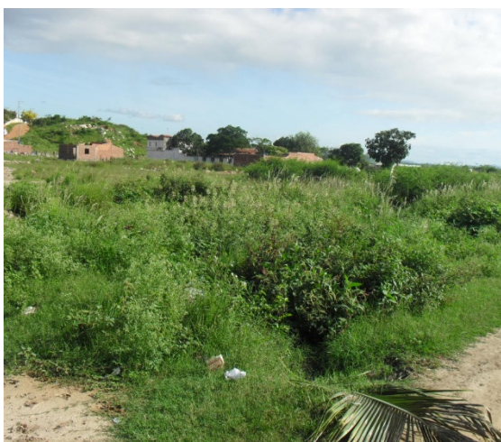
Foto 7: Região próxima a Vila Riachão. Início do canal de macrodrenagem da Clerolândia. Canal sem revestimento.
