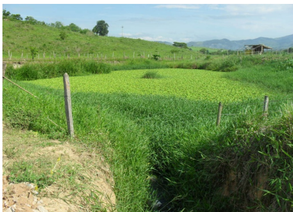
Foto 11: Casas próximas a BA – 262 . Buraco construído pela prefeitura destinado a acumular os esgotos sanitários e águas pluviais da rede coletora local.
