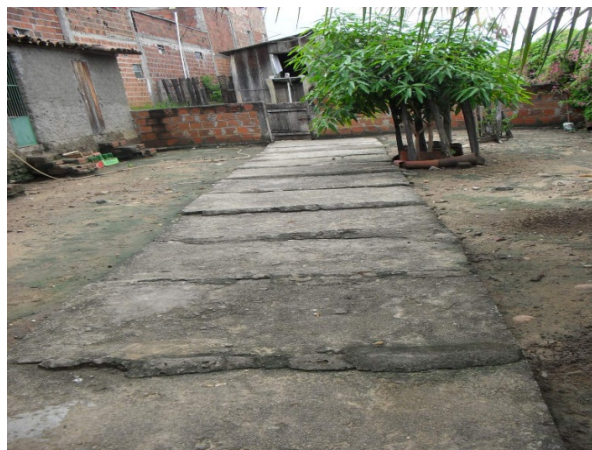
Foto 18: Galeria retangular fechada com uma parte exposta dentro do terreno particular devido à pequena diferença de nível entre o terreno e o rio Verruga. Seção de 1,5 m X 1 m.
