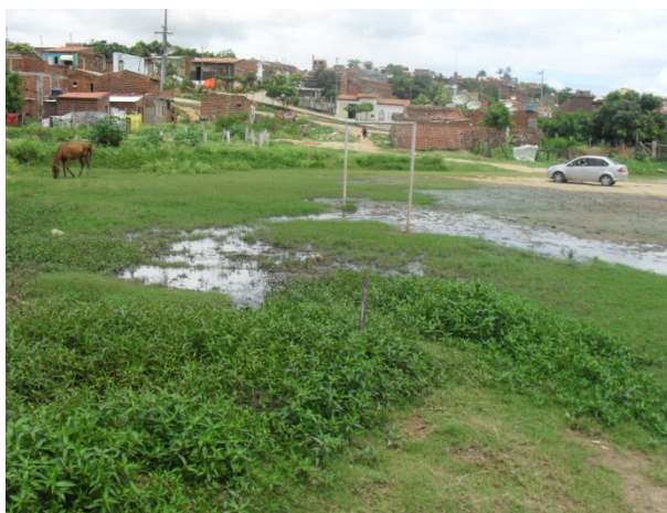
Foto 21: Bairro Américo Nogueira. Esgoto a céu aberto.
