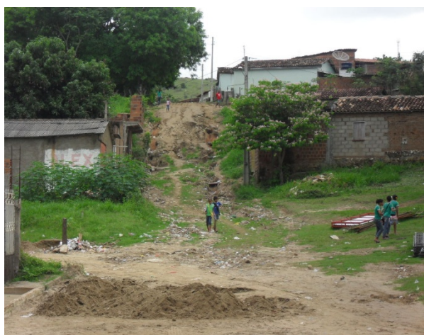
Foto 8: Rua Cleriston Andrade. Área crítica por conta da ocorrência de processo erosivo do tipo voçoroca. Área crítica 3.
