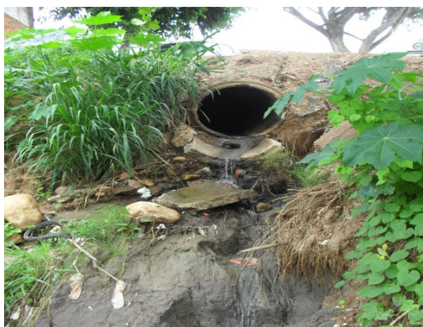
Foto 7: Final da rua Aureliano Coelho. Ponto de lançamento da rede de macrodrenagem que recebe esgoto sanitário e desemboca no rio Maiquinique.
