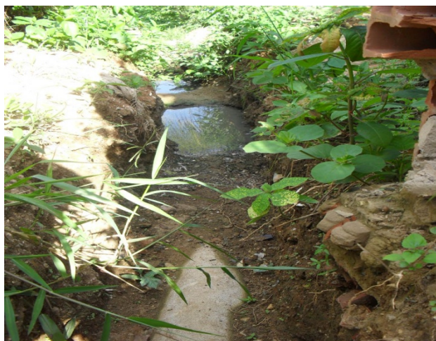
Foto 11: Bairro Urbis. Todo o esgoto sanitário juntamente com águas pluviais está canalizado e lançam num terreno mais baixo. O efluente a partir daí segue a céu aberto.
