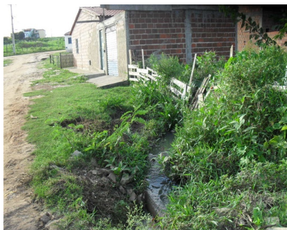
Foto 26: Bairro Quintas do Sul. Esgoto sanitário escoando a céu aberto. SAAE encontra dificuldades para implantar infraestrutura no local.
