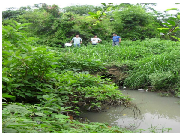
Foto 4: Ponto de lançamento de esgotos sanitários e águas pluviais da galeria de macrodrenagem no Rio Verruga. Tubulação de concreto de 800 mm.
