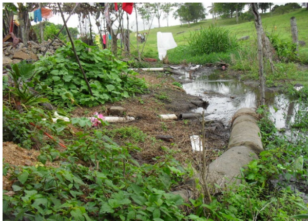
Foto 5: Bairro Piriquito. Ponto de lançamento da rede coletora de esgotos sanitários e águas pluviais.
