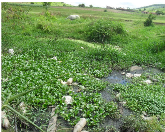
Foto 10: Travessa Eduardo Brito Landi. Ponto de lançamento da rede coletora de esgoto sanitário e águas pluviais no terreno natural. Coord. N: 8268735 Coord. E: 386601
