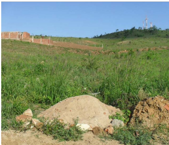
Foto 29: Bairro Quintas do Sul, Asa Sul. Loteamento ainda não regularizado já está com obras iniciadas. Definição do arruamento não favorece o escoamento natural das águas pluviais.
