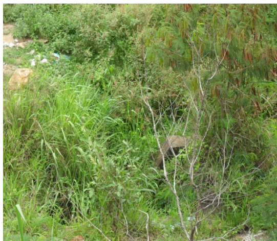
Foto 4: Detalhe do bueiro da BR – 415. O volume de contribuição oriundo da bacia de contribuição do bairro Quintas do Sul para o bairro Américo Nogueira.
