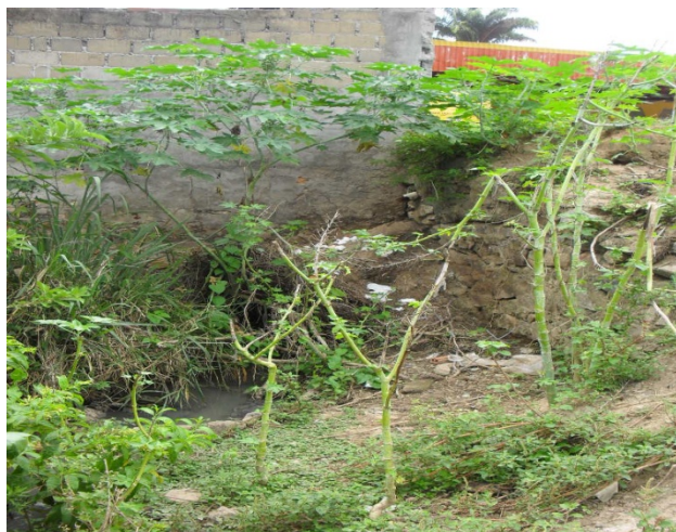
Foto 1: Rodoviária. Ponto de lançamento da rede coletora de águas pluviais e esgoto sanitário próximo ao rio do Vigário. Tubulação de concreto de 400 mm de diâmetro.
