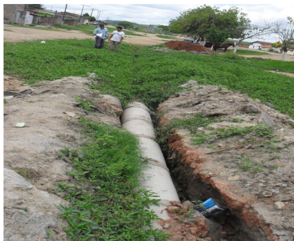
Foto 4: BA – 130, área próxima a Azaléia. Rede coletora de esgoto e águas pluviais recentemente reparada por conta de sobrecargas e insuficiência do sistema local.
