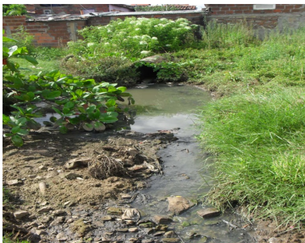
Foto 11: Rua Luther King. Ponto de lançamento da rede coletora de macrodrenagem que transporta esgoto no riacho Jundia. Tubulação de concreto de 800 mm de diâmetro.
