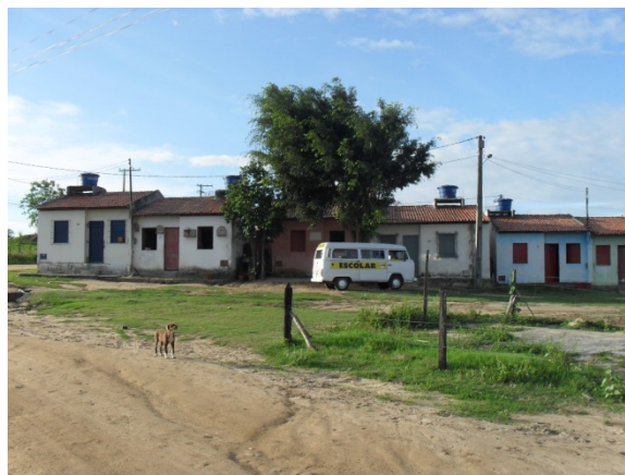
Foto 24: Bairro Laís Gois. Conjunto habitacional com 42 unidades atendidas por um sistema de esgotamento sanitário composto por fossas seguidas de filtro anaeróbico.
