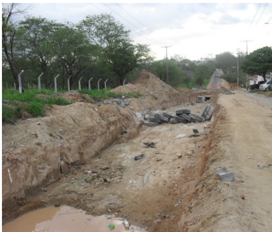
Foto 1: Avenida Júlio José Rodrigues. Obra de duplicação da via e macrodrenagem em execução.
