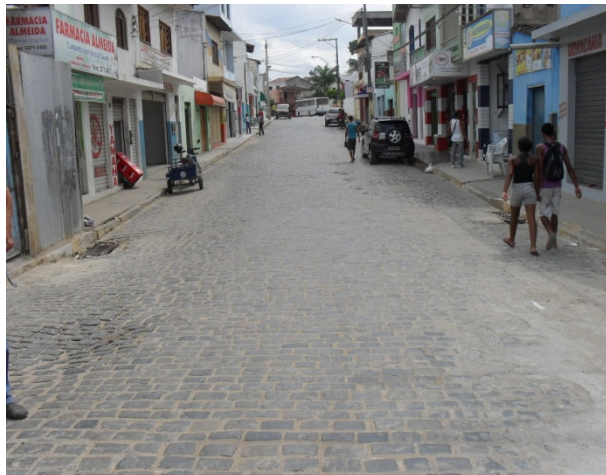
Foto 1: Rua Almerindo Dantas. Área crítica por conta da ocorrência de alagamento. Área crítica 1.
