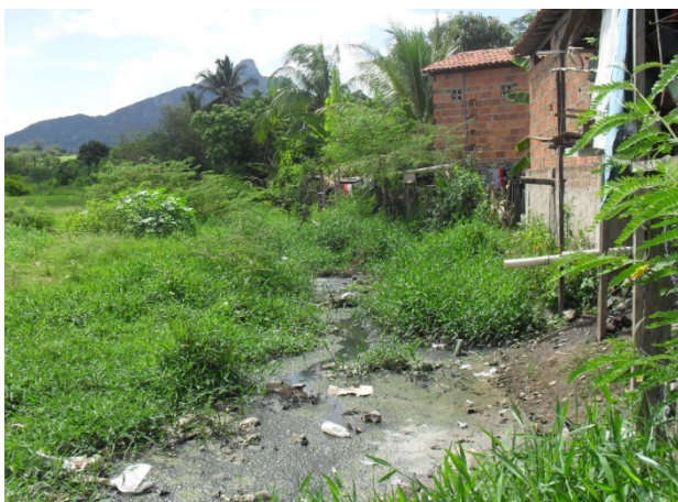
Foto 9: Travessa Eduardo Brito Landi. Residências próximas ao riacho Jundia lançam seus esgotos sanitários diretamente.
