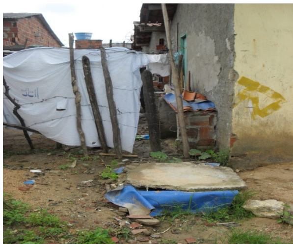
Foto 2: Casas populares. Sistema de fossas sépticas seguidas de sumidouro.
