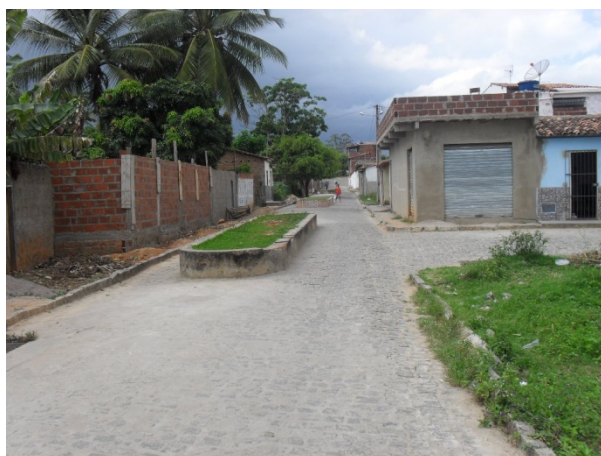
Foto 9: Rua dos Canteiros. Rua ainda sem uma denominação definida, mas que foi apelidada de tal maneira devido aos canteiros centrais construídos pela prefeitura para evitar que veículos pesados transitem na via e provoquem algum tipo de dano no trecho canalizado do afluente do riacho.
