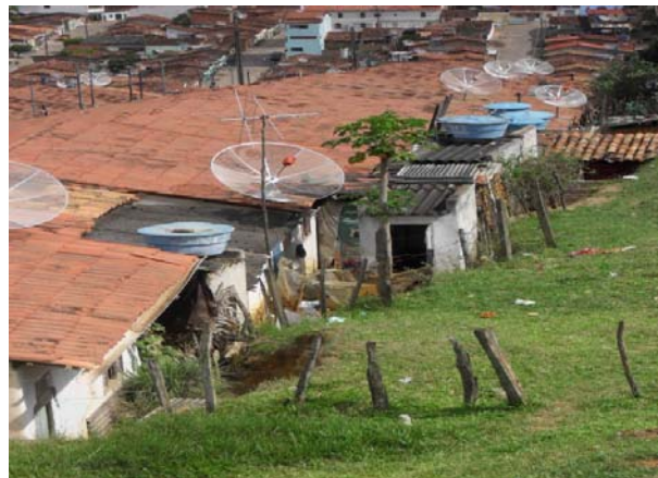
Foto 10: Rua Bernardo Souza. Sistema de banheiros externos acoplado a fossa séptica seguida de sumidouro.
