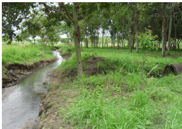
Foto 5: Avenida Antônio Carlos Magalhães. Tubulação de concreto de 1000 mm de diâmetro desembocando no Córrego da Mijada.
