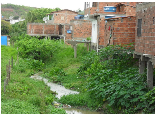
Foto 7: Margens do Rio de Dentro. Residências lançando esgotos sanitários diretamente no rio.
