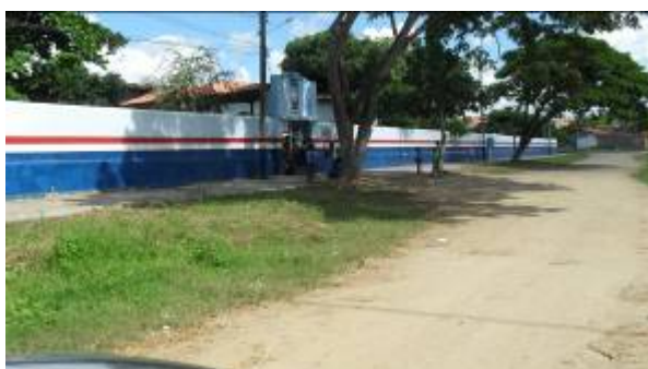
Foto 11: Área de inundação próxima a Escola Municipal José Guedes.
