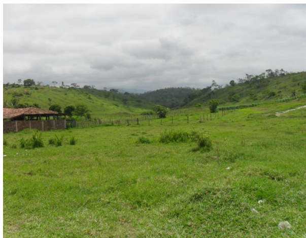
Foto 7: Rua Antonio Rodrigues dos Santos. Vista do local por onde segue um trecho da rede coletora de águas pluviais e esgoto sanitário que lança no terreno e segue a céu aberto.
