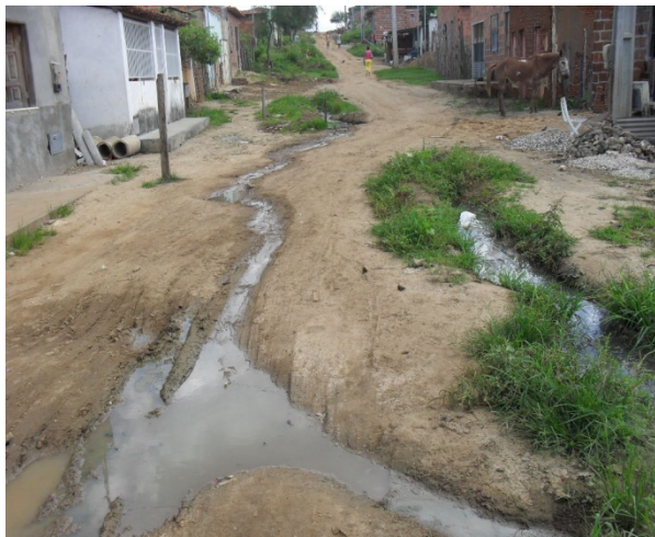
Foto 15: Esgoto a céu aberto escoando em frente às casas onde as pessoas transitam enquanto a área ainda não tem instalações de esgoto e as vias não estão pavimentadas na invasão próxima ao bairro Gameleira.
