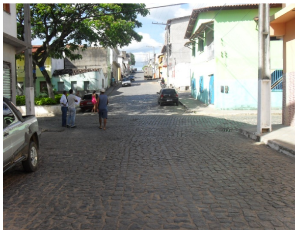
Foto 7: Rua Marechal Teixeira Lott. Área crítica por conta da ocorrência das chuvas de enxurrada. Área crítica 2.
