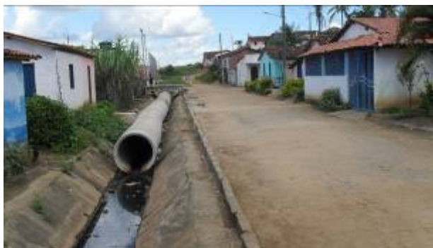
Foto 7: Final da tubulação e início do canal aberto, Rua Damásio Cruz.
