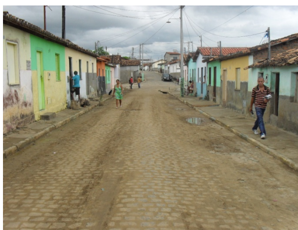
Foto 10: Rua 7 de Abril. Área crítica por conta da ocorrência de alagamento. Área crítica 4.
