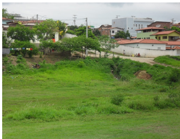
Foto 4: Avenida Antônio Carlos Magalhães. Segundo ponto de lançamento de esgotos sanitários e águas pluviais que desemboca no Córrego da Mijada.
