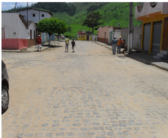
Foto 10: Rua Crescencio Silveira. Área crítica de alagamento por conta das chuvas de enxurrada. Área crítica 2.
