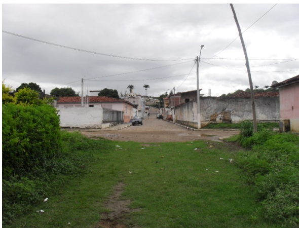
Foto 17: Rua J. Ribeiro. Via onde se inicia a galeria retangular de macrodrenagem.
