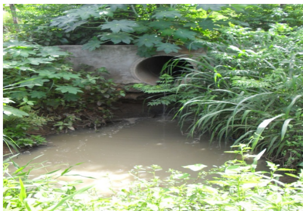
Foto 3: Avenida Jazon Alves. Ponto de lançamento da rede mista no terreno particular. Tubulação de concreto de 600 mm de diâmetro.
