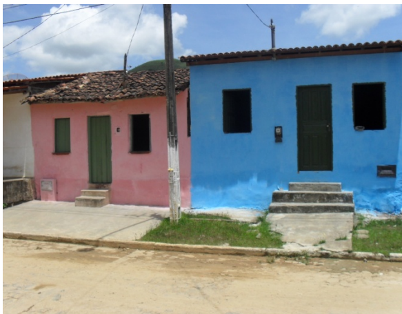
Foto 7: Avenida Francisco Viana. As águas pluviais que escoam pela Avenida Juracy Magalhães desembocam nesta avenida. Alguns moradores tentam se proteger elevando o acesso de suas casas.
