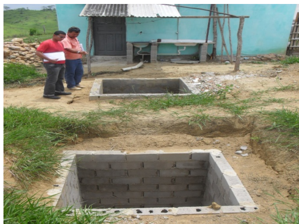
Foto 4: Casas populares. Detalhe das fossas sépticas em fase de implantação.
