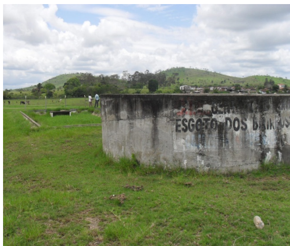
Foto 4: Detalhe do DAFA e de um dispositivo similar a uma lagoa de estabilização com dimensões e características peculiares.
