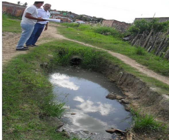
Foto 16: Invasão próxima ao bairro Gameleira. Ponto de lançamento da rede coletora de esgotos sanitários e águas pluviais próximo ao campo de futebol.
