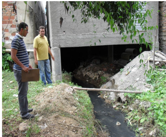
Foto 2: Vista do fundo dos estabelecimentos da rua Almerindo Dantas. Estruturas apoiadas em pilaretes devido à forte influência dos riachos que no período de chuvas intensas apresentam grandes cheias.
