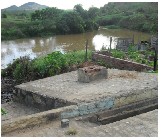
Foto 21: Rua da Piaba. Pessoas Constroem suas habitações quase na margem do rio Catolé. Processo de assoreamento ampliou a área de inundação do rio.
