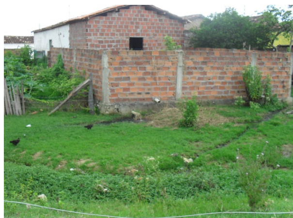
Foto 4: Rua Coração de Jesus. Residências próximas ao Rio Maiquinique lançam seus esgotos sanitários diretamente no corpo receptor.
