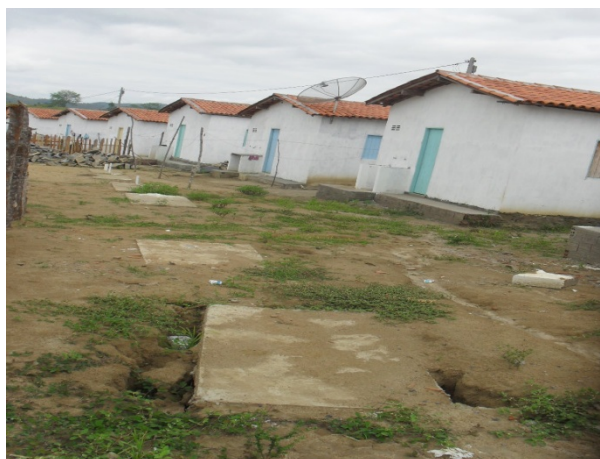
Foto 4: Bairro José Lima dos Santos. Residências dispõem seus esgotos sanitários em fossas.
