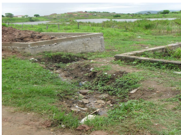
Foto 9: Bairro do antigo matadouro. Residências lançam seus esgotos sanitários às margens do açude.
