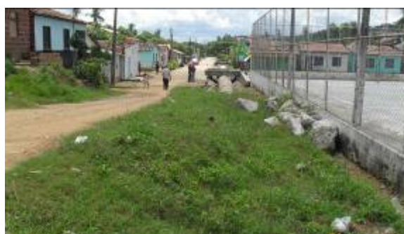
Foto 4: Continuação do canal da Rua Damásio Cruz.
