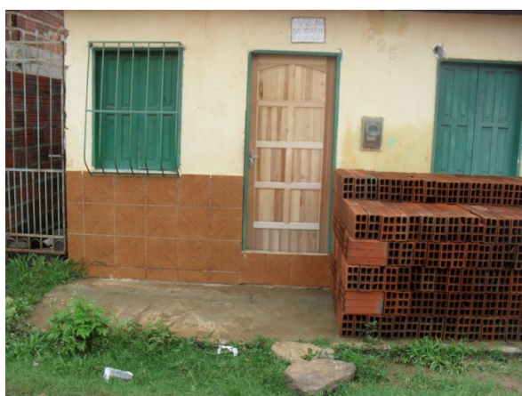
Foto 7: Rua São Paulo. Moradores colocam batentes altos na entrada de suas casas para dificultar a invasão das águas pluviais.
