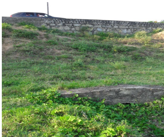
Foto 26: Avenida que separa o bairro São Francisco e o rio Catolé. Detalhe do dispositivo que facilita a influência das águas do rio sobre a área crítica 1.
