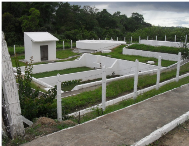
Foto 13: Vila Riachão. Visão geral da Estação de Tratamento de Esgoto do sistema isolado de esgotamento sanitário.
