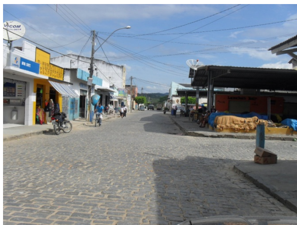
Foto 12: Praça Lomanto Júnior. Área crítica por conta da ocorrência de alagamento provocado por chuvas intensas. Área crítica 2.
