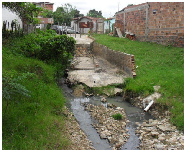
Foto 1: Trecho final da rua Reinaldo Ribas. Ponto de lançamento da rede mista no terreno natural próximo ao rio Macarani.
