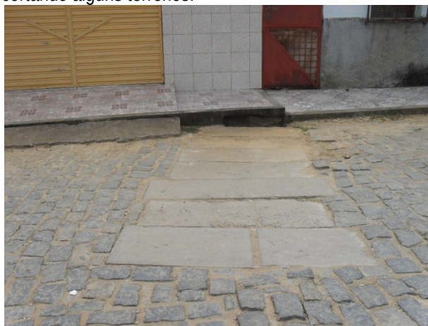
Foto 7: Rua Arlindo Pires. Afluente do riacho passa por trecho canalizado antes do encontro com o mesmo.
