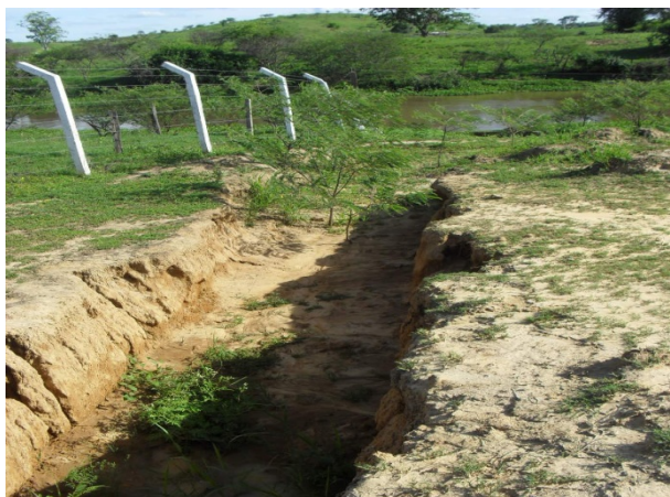
Foto 17: Detalhe da vala aberta para localização do emissário final da ETE.
