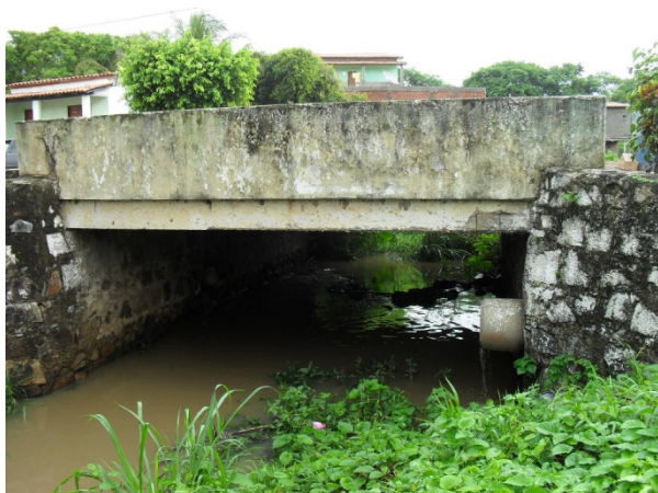
Foto 9: Ponte sobre a rua Padre Sacramento. Pontos de lançamento da rede coletora de águas pluviais e esgoto sanitário. Galerias circulares de concreto de diâmetros de 300 mm e 600 mm.
