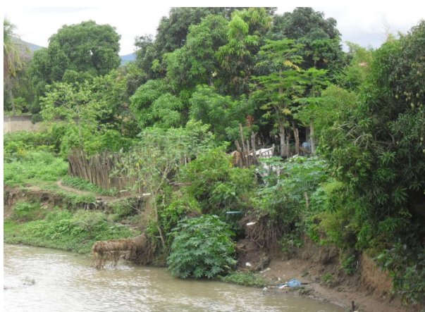
Foto 3: Residências situadas as margens do Rio Verruga lançando esgotos sanitários diretamente no rio.
