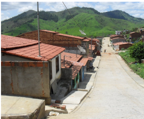
Foto 1: Bairro Cidade Nova. Obra de pavimentação e drenagem superficial em andamento. Recurso via Ministério da Integração Nacional.
