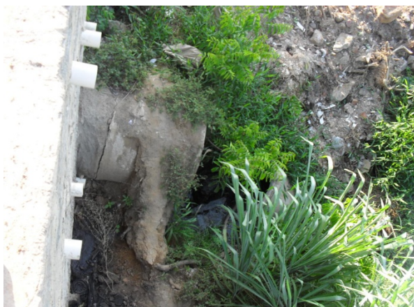
Foto 27: Bairro Bela Vista. Ponto de lançamento da rede coletora de águas pluviais e esgoto sanitário no rio Catolé. Tubulação de concreto de 1200 mm.
