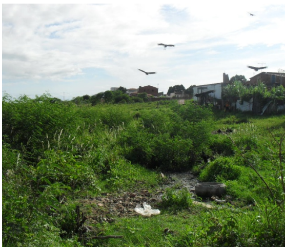
Foto 9: Canal de macrodrenagem da Clerolândia. Presença de lixo, animais e vegetação ao longo do caminho natural do canal que também transporta esgoto.
