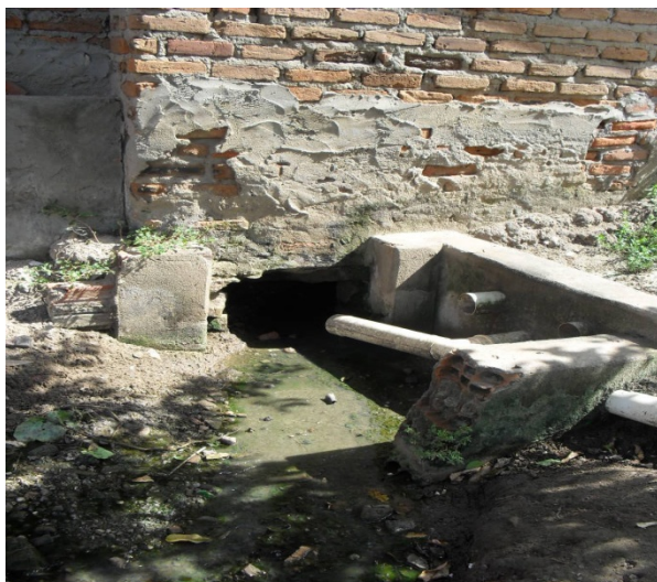
Foto 9: Rua Antônio José Carvalho. Início da rede coletora de macrodrenagem que passa debaixo de algumas residências e desemboca no riacho Jundia.
