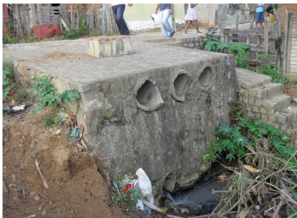
Foto 23: Rua da Piaba. Ponto de lançamento da rede coletora de esgoto sanitário e águas pluviais na margem do rio Catolé.
