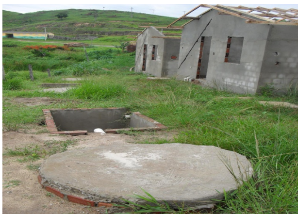
Foto 3: Casas populares. Unidades ainda em construção. Fossas sépticas e sumidouros ainda em fase de implantação.
