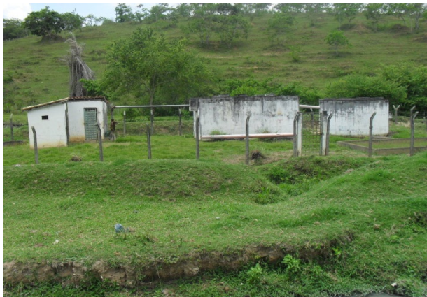
Foto 5: Visão geral da Estação de Tratamento de Esgoto inoperante e com estruturas em estado de conservação precário.
