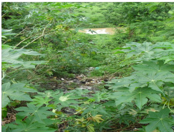
Foto 7: Bairro Felipe Achy. Ponto de lançamento de esgotos sanitários e águas pluviais da rede coletora as margens do Rio Pardo.
