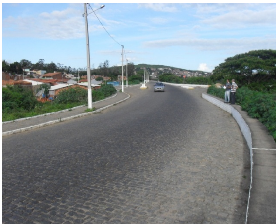
Foto 25: Avenida que separa o bairro São Francisco e o rio Catolé. Mesmo após a construção da via o alagamento na região ainda sofre influência do rio Catolé no período de cheia.
