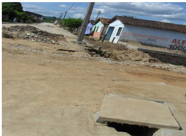
Foto 5: Bairro Gameleira. Prefeitura está realizando a pavimentação de uma das maiores ruas do bairro. Alguns dispositivos de coleta superficial já foram implantados.
