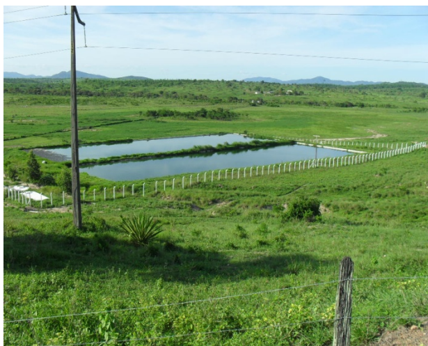
Foto 11: Visão geral das lagoas facultativas que complementam a etapa de tratamento do sistema isolado dos bairros Quintas do Sul, Quintas do Morumbi, Américo Nogueira e Loteamento Alvorada.
