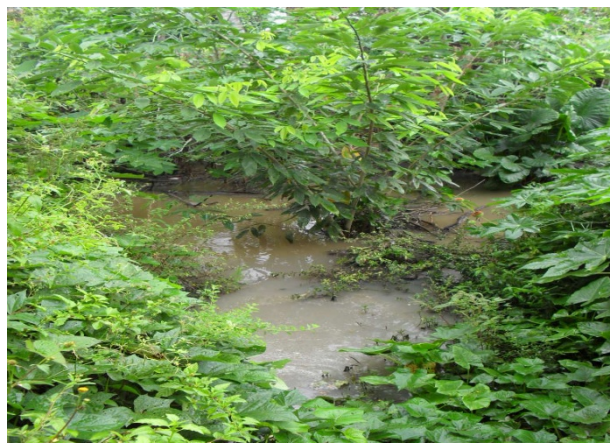
Foto 8: Trecho final da rua José Casemiro. Ponto de lançamento de águas pluviais e esgoto sanitário da rede coletora no Rio de Dentro.
