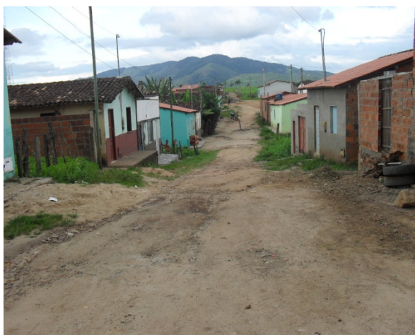
Foto 15: Rua Armenio. Condições topográficas e inexistência de dispositivos de drenagem favorecem a ocorrência de alagamento na região que está incluída na área crítica 5.
