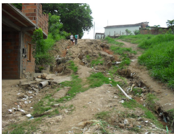
Foto 9: Rua Cleriston Andrade. Erosão do tipo voçoroca danifica a rede coletora de esgoto sanitário e águas pluviais.
