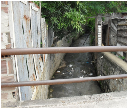
Foto 18: Canal de macrodrenagem dos bairros Otávio Camões e Primavera. Trecho a céu aberto com seção retangular revestido em alvenaria de pedra.
