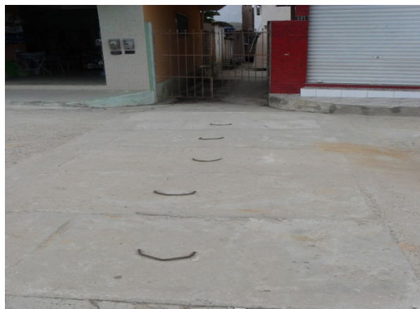
Foto 10: Galeria circular de macrodrenagem de tubulação em concreto e de 1000 mm de diâmetro. Esta galeria se inicia na praça Lomanto Júnior e segue por debaixo de algumas casas até desembocar no terreno natural.
