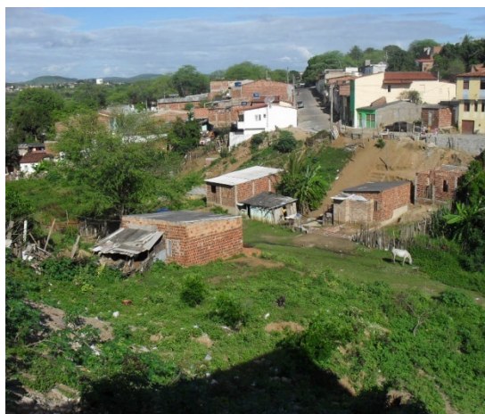
Foto 12: Bairro Clodoaldo Costa. Imagem do vale por onde ocorre o escoamento natural das águas.
