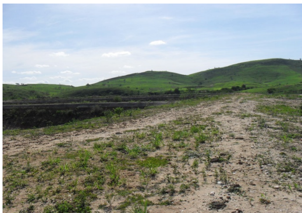
Foto 15: Visão geral das lagoas de estabilização da estação de tratamento de esgoto do sistema geral de esgotamento sanitário ainda em fase de implantação.
