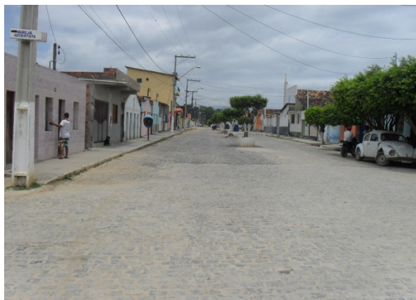
Foto 5: Mercadinho Cerqueira, avenida Bernadino Rodrigues Matos. Área crítica por conta da ocorrência de alagamento. Área crítica 3.
