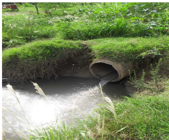
Foto 12: Final da rua Rio Salto. Ponto de lançamento da rede coletora de águas pluviais e esgoto sanitário no riacho Jundia. Tubulação de concreto de 800 mm de diâmetro.
