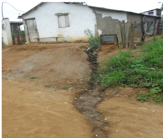
Foto 2: Bairro El Dourado. Detalhe de uma residência lançando esgoto na rua.
