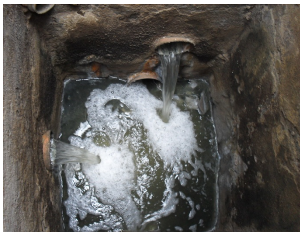
Foto 5: Qualidade do efluente final após ser submetido ao processo de tratamento.
