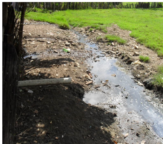
Foto 2: Rua Reinaldo Ribas. Lançamento de esgotos sanitários no fundo das casas.
