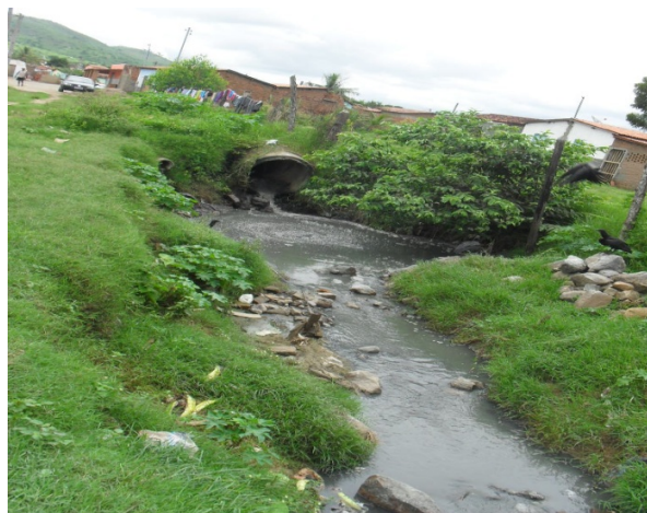
Foto 2: Ponto de lançamento da rede de macrodrenagem que recebe esgoto da rua Humberto de Campos. Tubulação de concreto de 1000 mm de diâmetro.
