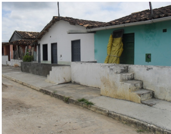
Foto 3: Bairro Tancredo Neves. Muitas pessoas constroem muretas na porta de acesso a residência devido a ocorrência de alagamento. Área crítica 2.
