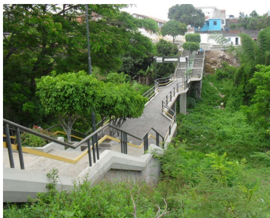
Foto 16: Vista da passarela construída com recurso junto a CONDER. Trecho do canal de macrodrenagem dos bairros Otávio Camões e Primavera canalizado. Galeria circular dupla de 1.000 mm de diâmetro.
