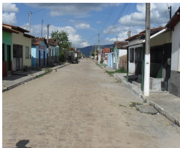
Foto 16: Rua Independência. Uma das ruas afetadas pelo alagamento ocorrido na área crítica 6.
