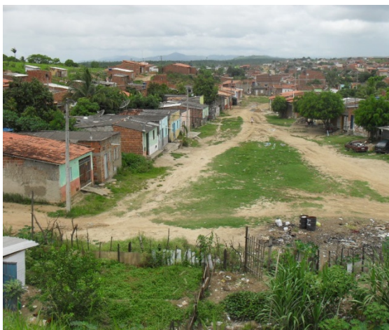
Foto 3: Bairro Américo Nogueira. Local onde se inicia um canal enterrado de macrodrenagem de seção retangular de 2m X 1,8m que está cerca de 80% concluído.
