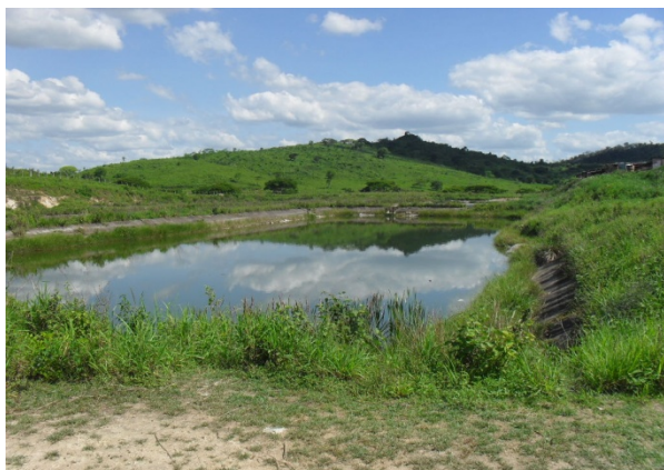
Foto 5: Estação de Tratamento de Esgoto inativa. Sistema de lagoas de estabilização em péssimo estado de conservação devido a falta de manutenção das unidades.
