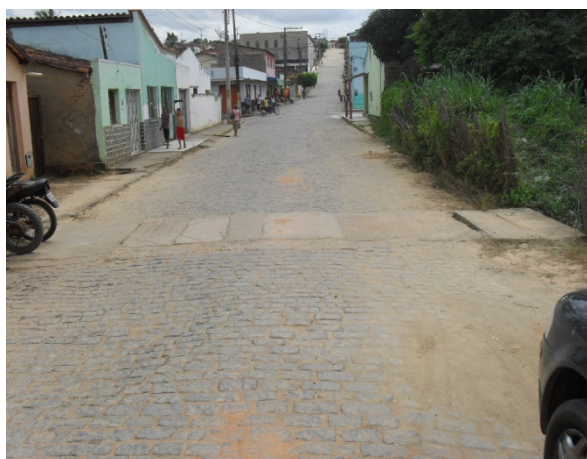
Foto 4: Travessa Arlindo Pires. Trecho final da canalização do riacho em 3 tubulações de concreto em paralelo de 600 mm de diâmetro que passa por debaixo de algumas residências.
