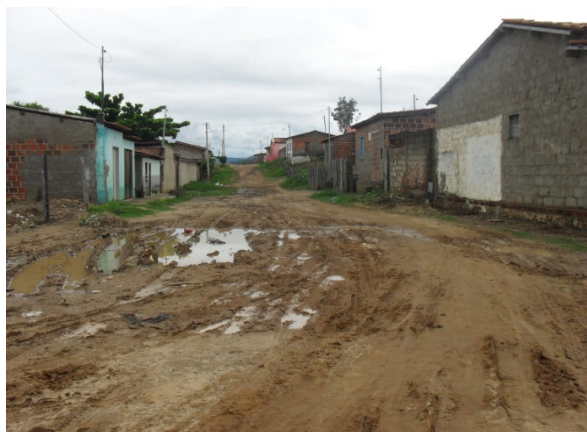
Foto 5: Rua Manuel Menezes. Área crítica por conta da ocorrência de alagamento. Área crítica 3.
