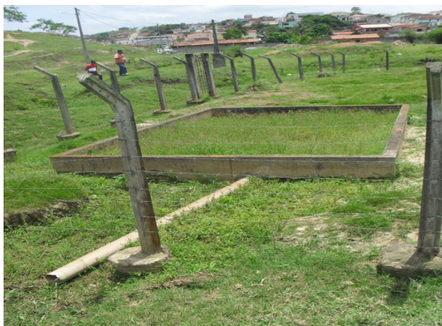
Foto 7: Detalhe do leito de secagem que faz o tratamento do lodo do DAFA da ETE.
