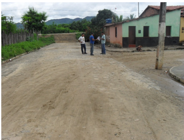
Foto 3: Rua Padre Juracy Mendes. Área crítica por conta da ocorrência de alagamento. Área crítica 2.
