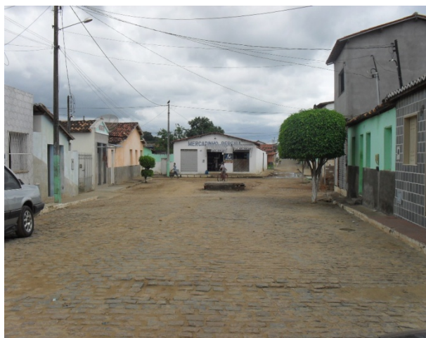
Foto 3: Rua Castro Alves. Detalhe do Poço de Visita da rede de macrodrenagem que recebe esgoto sanitário.
