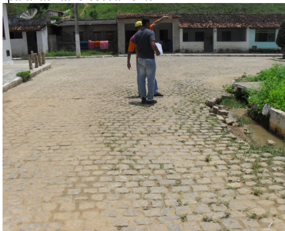
Foto 8: Avenida Francisco Viana. Local onde as águas pluviais da Avenida Juracy Magalhães e ruas próximas se encontram antes de serem coletadas e conduzidas em direção ao rio Riachão.
