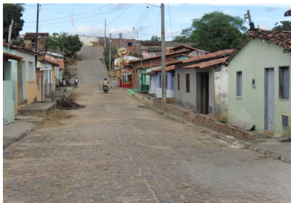
Foto 5: Rua Belo Horizonte. Primeira rua a apresentar problemas na ocorrência das chuvas de enxurrada da área crítica 1.
