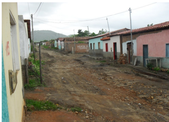
Foto 12: Rua José Francisco de Lacerda. Área crítica por conta da ocorrência de alagamento. Área crítica 5.
