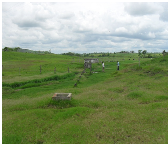
Foto 2: Visão geral da Estação de Tratamento de Esgoto construída para atender 2 bairros porém encontra-se inativa devido a depredação e falta de manutenção.
