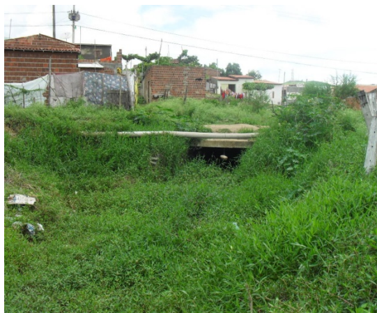
Foto 6: Bairro Américo Nogueira. Trecho aberto do canal de macrodrenagem ainda não finalizado.
