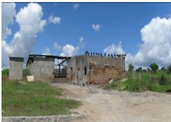
Foto 1: Matadouro da cidade que funciona em condições precárias.
