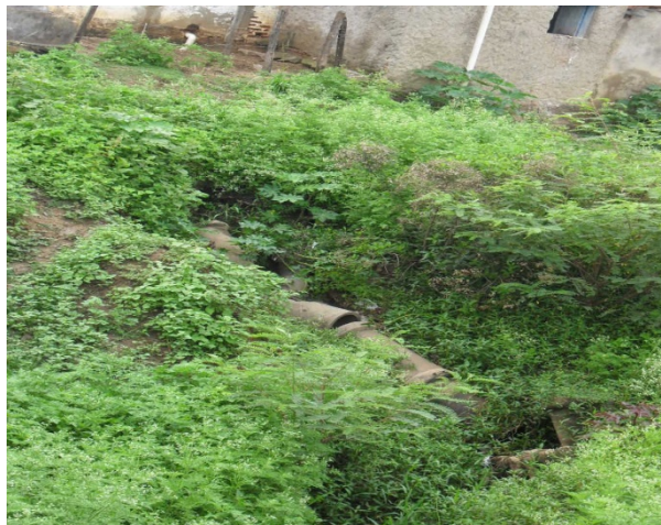
Foto 6: Ponto de lançamento de esgotos sanitários e águas pluviais da rede coletora próximo a ponte. Tubulação de concreto de 800 mm de diâmetro.
