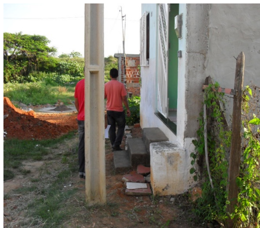
Foto 24: Bairro São Francisco. Moradores locais constroem suas casas acima do nível do chão na área mais baixa para evitar a invasão das águas pluviais em seus domicílios
