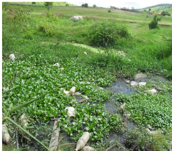
Foto 8: Travessa Eduardo Brito Landi. Ponto de lançamento da rede coletora de esgoto sanitário e águas pluviais no terreno natural.
