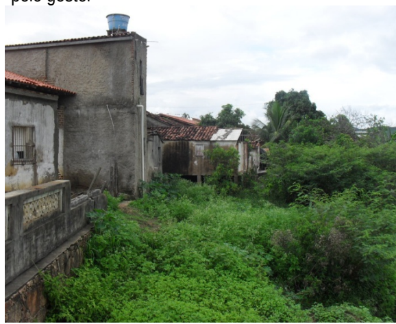
Foto 14: Margem do rio Verruga. Área crítica por conta de inundação ribeirinha. Área crítica 6.
