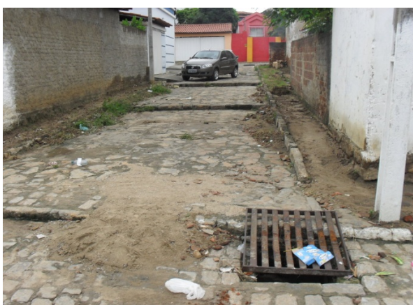
Foto 15: Beco por onde passa a galeria de macrodrenagem que se inicia na avenida Getúlio Vargas.
