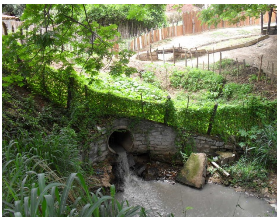
Foto 15: Canal de macrodrenagem dos bairros Otávio Camões e Primavera. Trecho inicial a céu aberto transportando um grande volume de esgoto sanitário.
