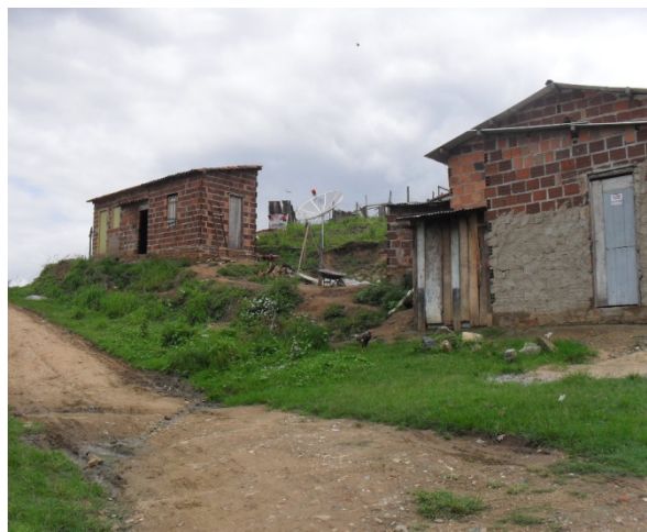
Foto 8: Travessa da Avenida Leste ainda sem denominação. Três residências recentemente construídas estão lançando esgoto a céu aberto na rua. Casos pontuais existentes na cidade.
