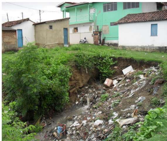
Foto 2: Rua Goes Calmon. Ponto de lançamento de esgotos sanitários e águas pluviais da rede coletora. Tubulação de concreto de 300 mm de diâmetro.
