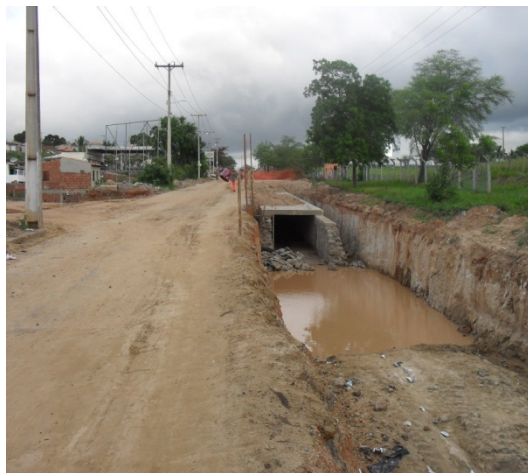
Foto 2: Avenida Júlio José Rodrigues. Detalhe da galeria retangular de macrodrenagem de seção média de 2,25m x 1,8m em execução.
