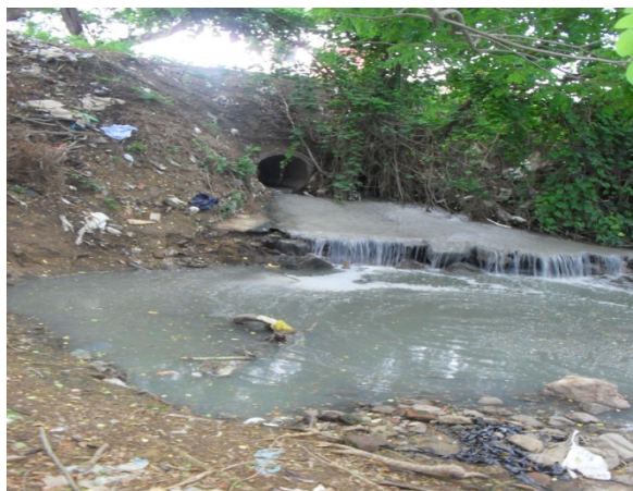
Foto 18: Avenida Beira Rio, próximo a Rótula dos Orixás. Ponto de lançamento da rede coletora de esgoto sanitário e águas pluviais no rio Catolé. Tubulação de concreto de 1000 mm de diâmetro.
