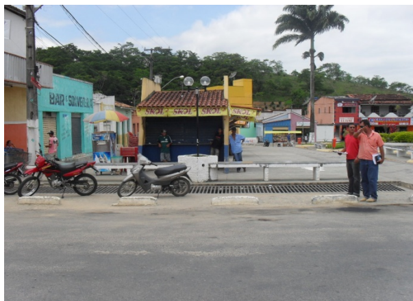
Foto 9: Praça Lomanto Júnior. Prefeitura recentemente realizou uma melhoria no sistema de drenagem local colocando um dispositivo de coleta superficial do tipo engole tudo para amenizar os efeitos do alagamento sobre a área. Área crítica 4.
