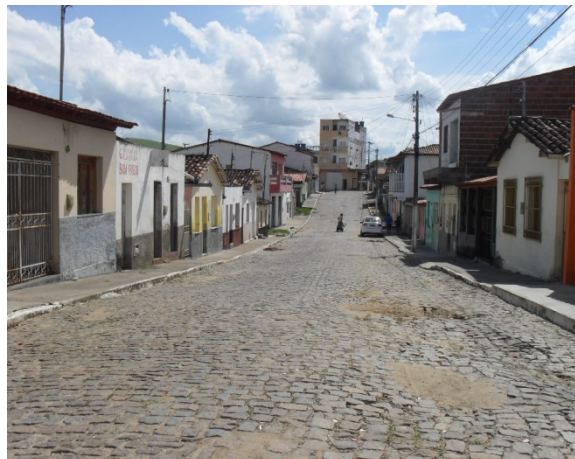
Foto 18: Rua Ituaçu. Uma das ruas afetadas pelo alagamento da área crítica 6.
