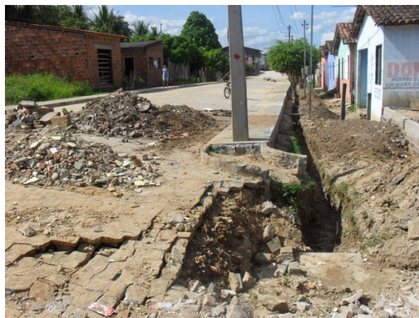
Foto 6: Bairro Gameleira. Prefeitura está pavimentando uma rua de grande extensão e já abriu as valas para implantação das galerias de drenagem.
