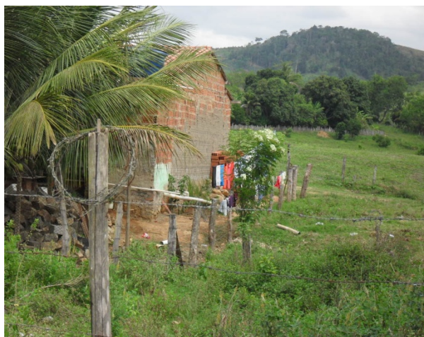
Foto 8: Loteamento Flamboyant 2ª parte. A pesar da maioria das residências estarem ligadas a rede coletora de esgotos sanitários e águas pluviais, algumas residências lançam seus esgotos sanitários no quintal.
