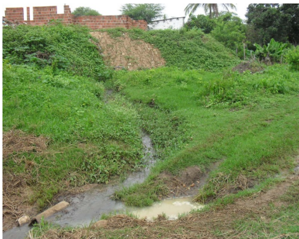
Foto 1: Ponto de lançamento de esgotos sanitários e águas pluviais da rede coletora próximo a avenida Getúlio Vargas. Tubulação de concreto de 300 mm de diâmetro.
