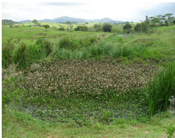
Foto 7: Loteamento Flamboyant 2ª parte. A prefeitura escavou um buraco para que a rede coletora de esgotos sanitários e águas pluviais despejasse seu efluente evitando assim que o mesmo chegasse diretamente no rio Gongogi.
