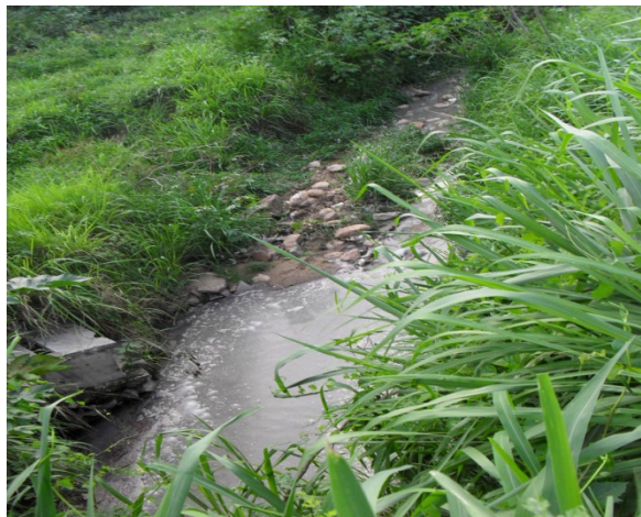
Foto 14: Vila Riachão. Ponto de lançamento da rede coletora de esgoto e águas pluviais ao lado da ETE.
