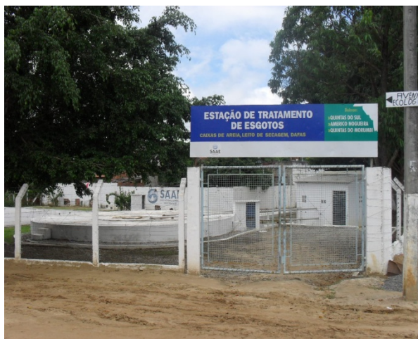
Foto 8: Sistema isolado de esgotamento sanitário dos bairros Quintas do Sul, Quintas do Morumbi, Américo Nogueira e Loteamento Alvorada. Visão geral da ETE.
