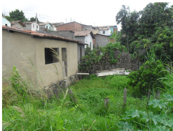
Foto 4: Bairro Ozeas Andrade. Residências construídas em local inadequado dificultam o escoamento natural das águas pluviais.
