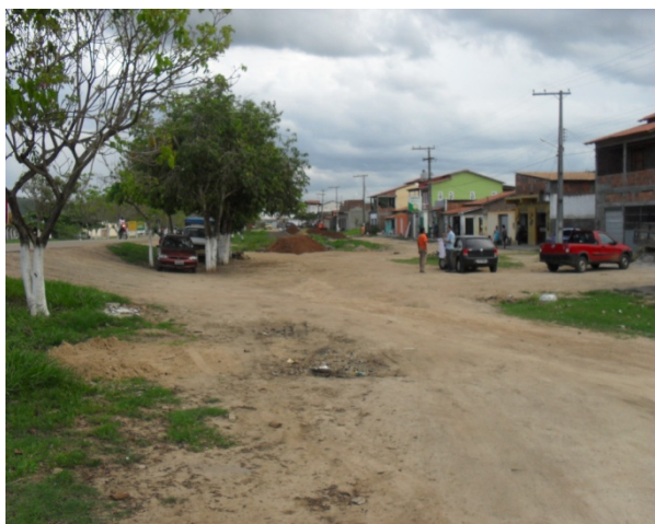
Foto 3: BA – 130, área próxima a Azaléia. Área crítica por conta da ocorrência de alagamento. Área crítica 2.
