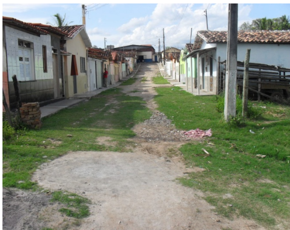
Foto 13: Rua Rio Salto. Vista da rua que sofre com problema de retorno nas casas devido a tubulação de saída da rede coletora ficar afogada durante a cheia do riacho.
