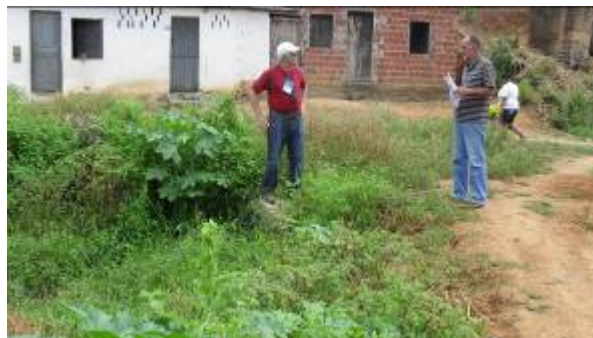
Foto 2: Início do canal da Rua Damásio Cruz. P 181.
