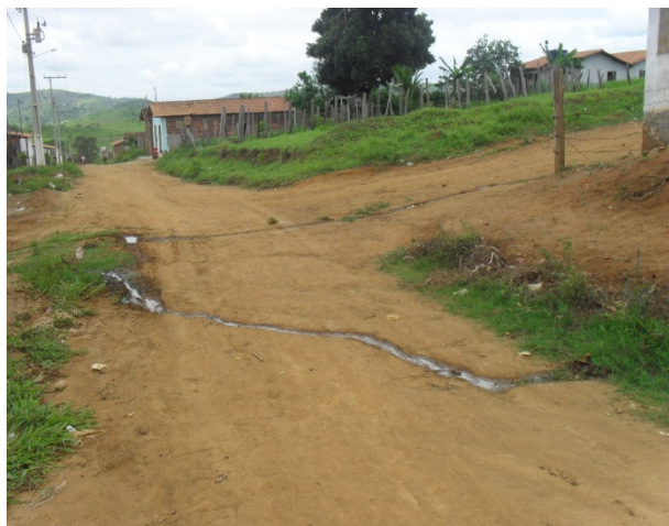
Foto 1: Bairro El Dourado. Bairro carente de infraestrutura no qual a população residente lança seus esgotos sanitários a céu aberto.
