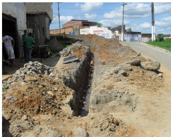
Foto 8: Bairro Gameleira. Homens realizando a reparação da rede coletora de esgotos sanitários e águas pluviais devido a problemas de entupimento.
