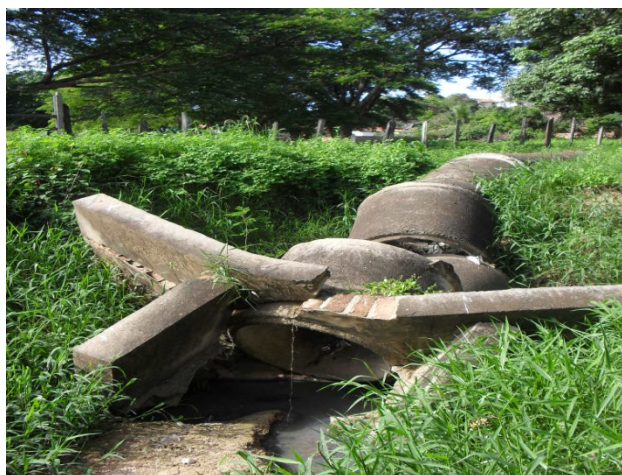
Foto 5: Ponto de lançamento da rede mista que vem da rua Pixinguinha até um terreno natural próximo ao riacho Cambuqueira. Tubulação de concreto de 1000 mm de diâmetro.
