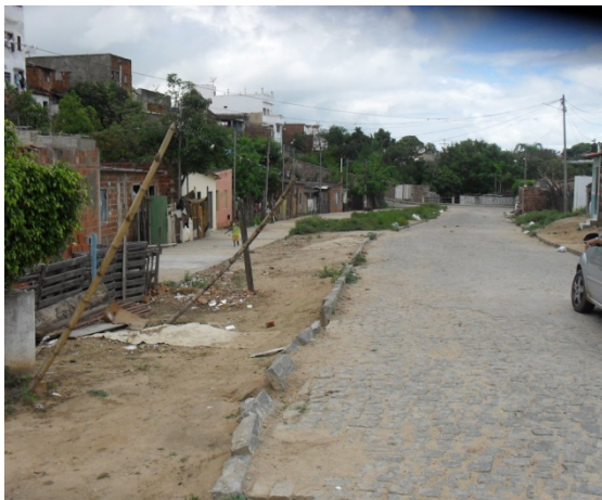
Foto 17: Canal de macrodrenagem dos bairros Otávio Camões e Primavera. Trecho canalizado em alvenaria retangular cobertas com placas de concreto. Pessoas aproveitaram-se das placas que cobrem o canal para uso comum e particular.
