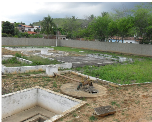
Foto 1: Bairro Arnulfo Órfão. Visão geral da Estação de Tratamento de esgoto do sistema separador operado pela EMBASA
