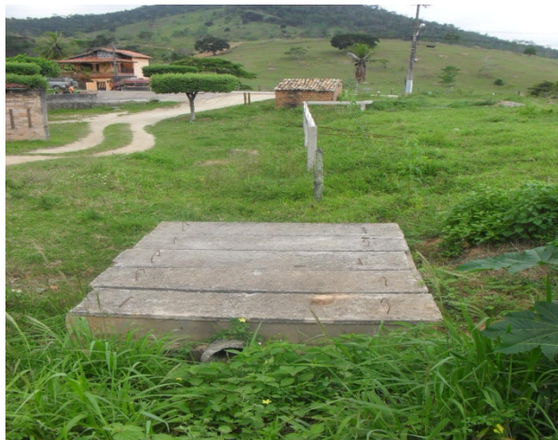
Foto 1: Área próxima a rua D. Área crítica por conta da ocorrência de alagamento. Área crítica 1.
