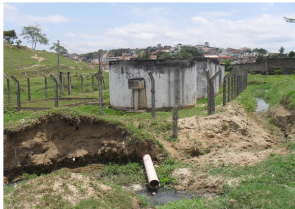
Foto 6: Detalhe do ponto de lançamento do efluente tratado pela Estação de Tratamento de esgoto.
