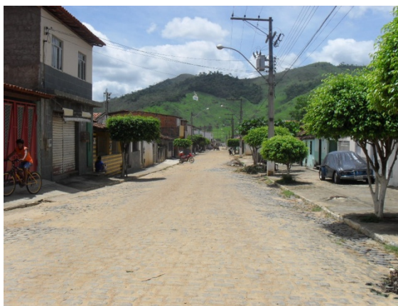
Foto 4: Avenida Juracy Magalhães. Principal via que recebe contribuição superficial de águas pluviais na cidade. Área crítica por conta da ocorrência de chuvas de enxurrada. Área crítica 1.
