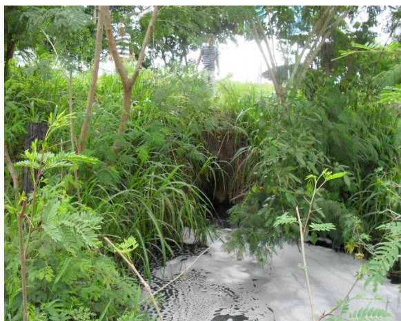
Foto 22: Bairro Américo Nogueira. Parte do efluente coletado pela rede que não é destinado a ETE segue a céu aberto em um terreno natural próximo a BR – 051.
