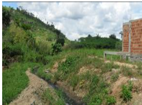
Foto 4: Lançamento de esgoto a céu aberto para o Rio Canhoto, próximo a rua do matadouro.
