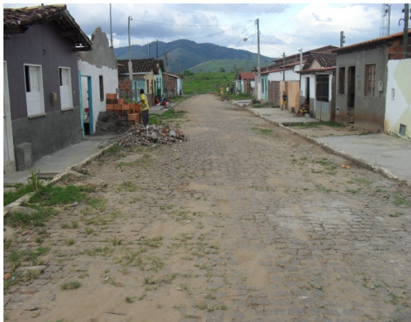
Foto 5: Rua Sabino Costa Neto. Área crítica por conta da ocorrência de alagamento. Área crítica 3.
