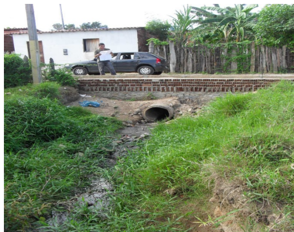
Foto 6: Rua Itapetinga. Ponto de lançamento da rede mista no terreno natural próximo ao riacho Cambuqueira. Tubulação de concreto de 800 mm de diâmetro.
