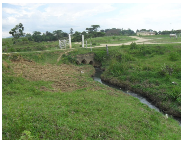
Foto 10: Parque de Vaquejada. Local no qual dois riachos distintos transportando esgotos e águas pluviais oriundas das redes coletoras se encontram e desembocam no rio Gongogi.
