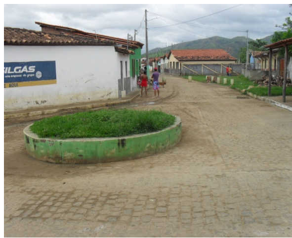
Foto 4: Cruzamento das ruas Otávio Mangabeira e Castro Alves. Área crítica por conta da ocorrência de alagamento. Área crítica 2.
