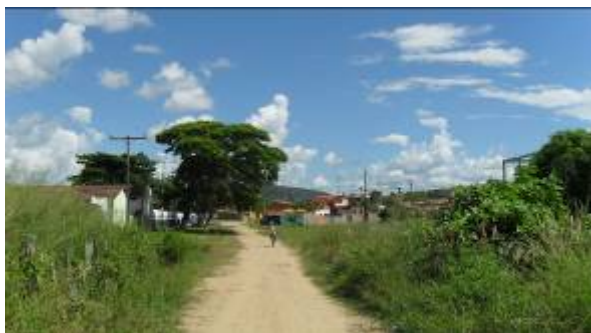
Foto 5: Área de inundação próxima ao matadouro.
