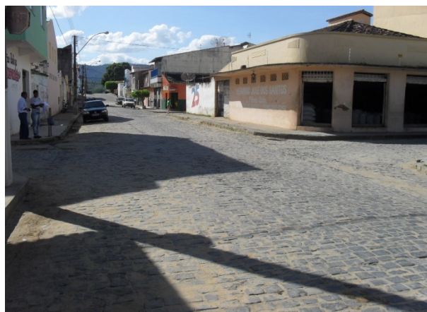
Foto 14: Rua João Alves de Oliveira. Estabelecimentos próximos à área crítica possuem entradas com nível mais elevado do que o passeio para evitar que as águas pluviais os invadam.
