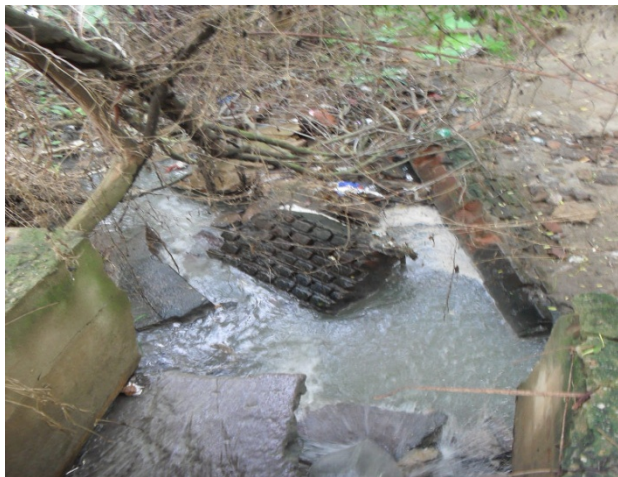
Foto 5: Ponto de lançamento de esgotos sanitários e águas pluviais da galeria retangular de macrodrenagem no Rio Verruga.
