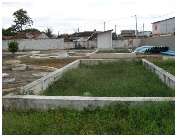
Foto 6: Detalhe do leitos de secagem associados ao DAFA's.
