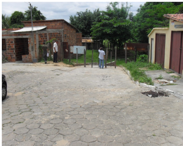
Foto 1: Cruzamento da rua Reinaldo Ribas com a Castelo Branco. Área crítica por conta das chuvas de enxurrada. Área crítica 2.
