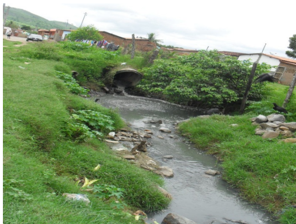
Foto 16: Ponto de lançamento da rede de macrodrenagem que recebe esgoto da rua Humberto de Campos. Tubulação de concreto de 1000 mm de diâmetro.
