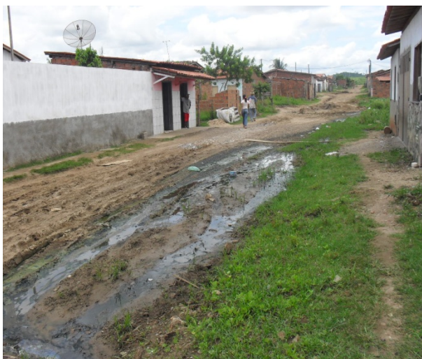
Foto 11: Avenida do Contorno. Esgoto a céu aberto.
