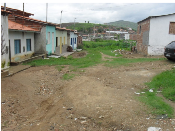
Foto 3: Rua Mário R. Oliveira. Área crítica devido à ocorrência de alagamento provocado por chuvas de enxurrada. Área crítica 2.
