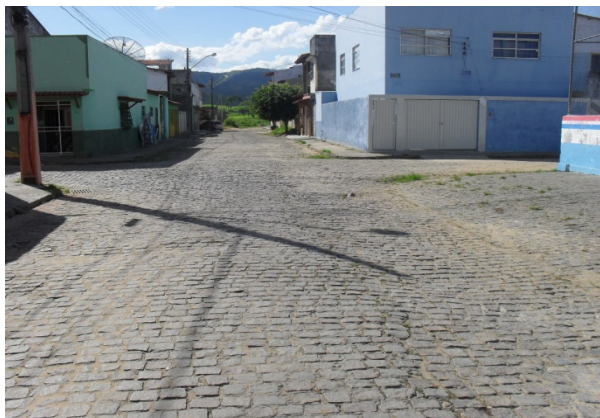
Foto 11: Rua 26 de Abril. Área crítica por conta da ocorrência de chuvas de enxurrada. Área crítica 4.
