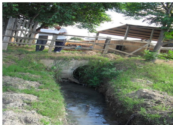
Foto 4: Avenida Lindolfo Fernandes. Ponto de lançamento da rede mista no terreno particular. Tubulação de concreto de 1000 mm de diâmetro.
