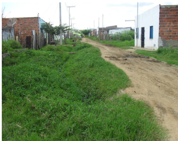
Foto 13: Residências da invasão próxima ao bairro Gameleira lançam seus esgotos a céu aberto em uma valeta natural localizada na parte frontal.
