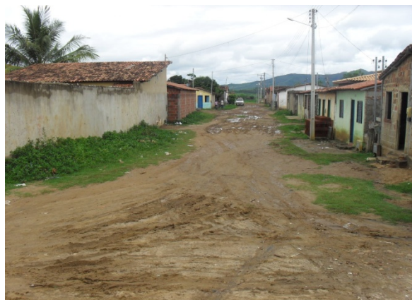
Foto 6: Rua São Paulo. Região mais afetada pelo alagamento que começa na rua Manuel Menezes. Área crítica 3.
