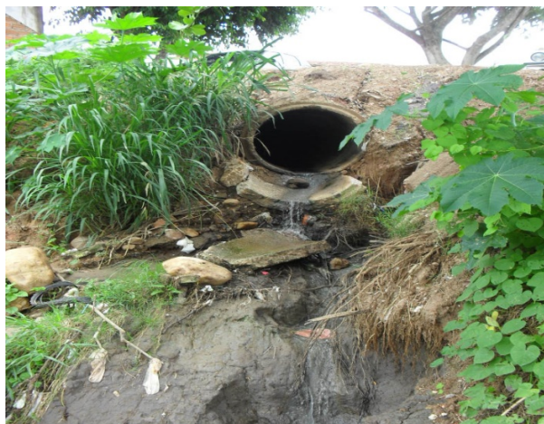
Foto 1: Final da rua Aureliano Coelho. Ponto de lançamento da rede de macrodrenagem que recebe esgoto sanitário e desemboca no Rio Maiquinique.
