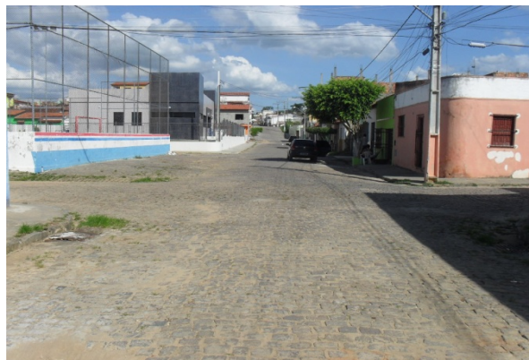
Foto 12: Rua 26 de Abril. Vista de outro ângulo da área crítica em questão e um detalhe dos dispositivos de drenagem existentes responsáveis pela coleta das águas pluviais.
