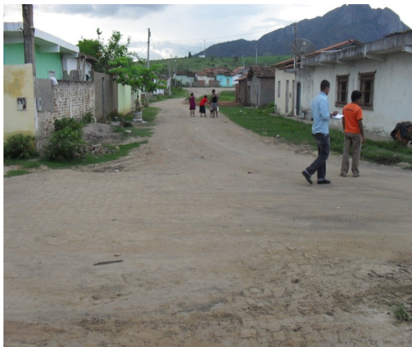
Foto 7: Vista de outro ângulo da área crítica 4 que apresenta problema de alagamento devido a irregularidade no greide da rua e a falta de dispositivo de drenagem.
