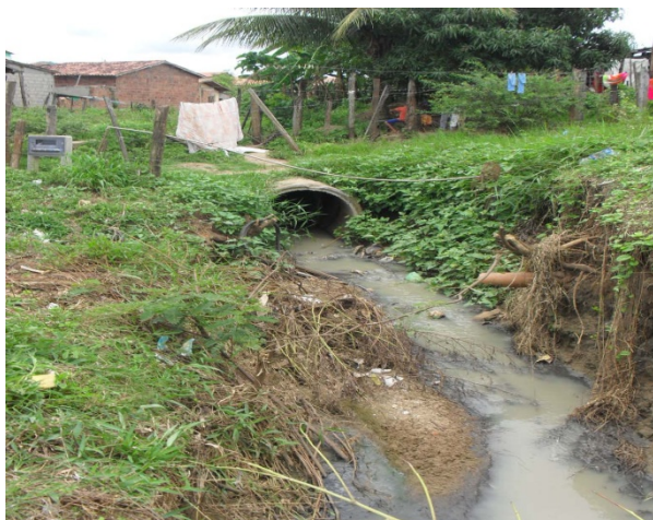
Foto 1: Ponto de lançamento da rede coletora de esgoto sanitário e águas pluviais. Tubulação de concreto de 1000 mm de diâmetro.
