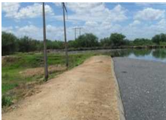
Foto 1: ETE – detalhe de uma das lagoas
