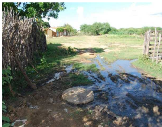
Foto 4: Lançamento de esgoto a céu aberto - Vila São Joaquim - próximo a lagoa de tratamento
