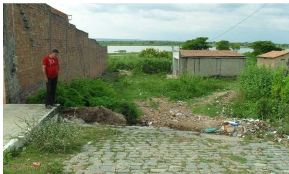
Foto 4: Área de assoreamento e inundação ao lado da Casa de Show.
