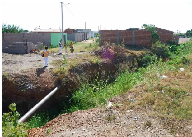
Foto 1: Área de erosão – Vila Maria
