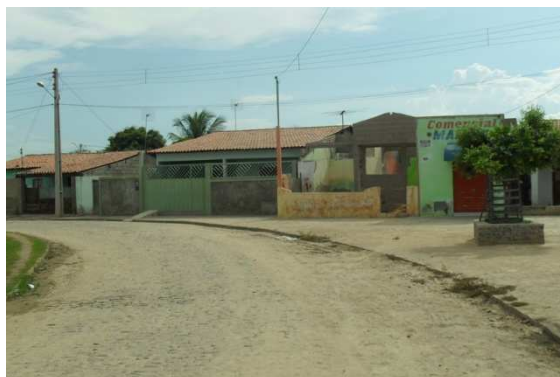
Foto 2: Passagem das águas pluviais – Rua José dias Ribeiro.
