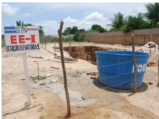
Foto 3: Construção da Estação Elevatória 1 – Rua Pedro Ramos – área de inundação.
