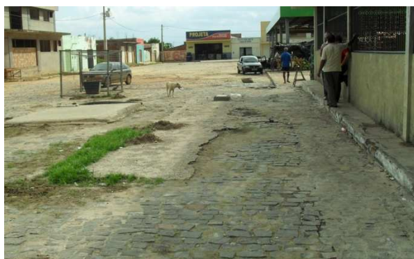
Foto 6: Caixa receptora ao lado do Mercado Municipal
