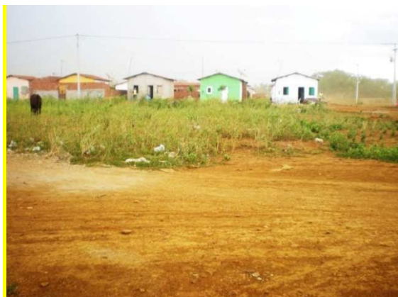
Foto 1: Área de alagamento – Conjunto Habitacional recém construído
