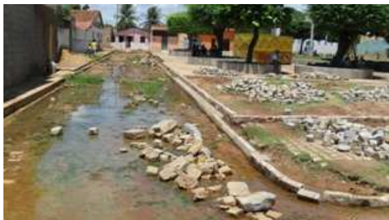
Foto 1: Área de inundação Praça Bibiano J. Santos
