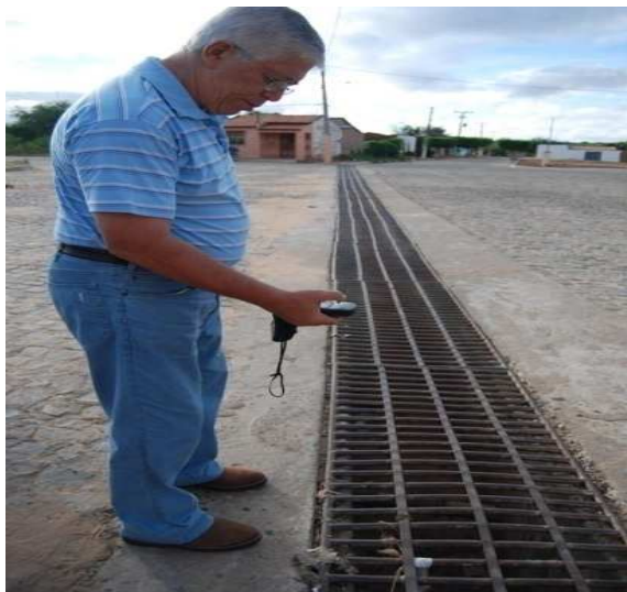
Foto 1: Grelha horizontal contínua, parte baixa da Av. Jucelino Kubitschek
