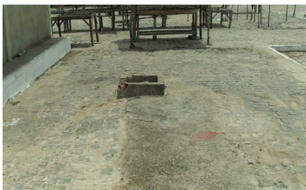
Foto 5: PV ao lado do Mercado Municipal
