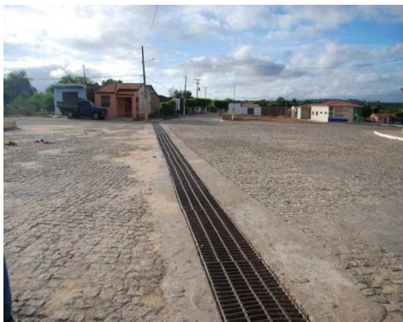
Foto 3: Detalhe da Grelha Horizontal – Av. Jucelino Kubitschek
