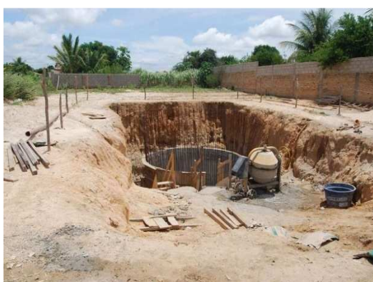
Foto 5: Construção da Estação Elevatória 1 – Rua Pedro Ramos – área de inundação.
