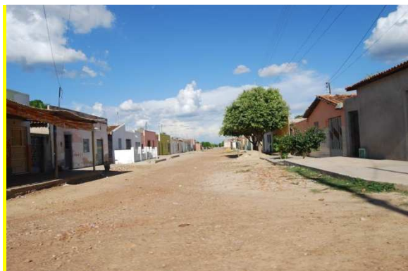
Foto 3: Área de alagamento – Vila São Joaquim - Quadra 19
