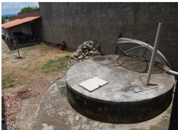
Foto 1: Caixa de esgoto fundo prédio da Prefeitura
