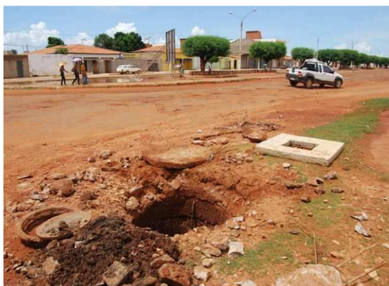
Foto 3: Caixa de passagem \ PV em construção
