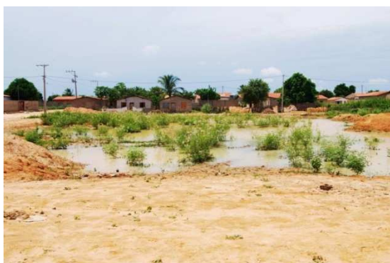
Foto 5: Área aterrada com inundação – Rua Bom Sucesso
