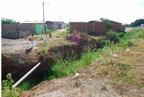
Foto 11: área de erosão – Vila Vila Maria
