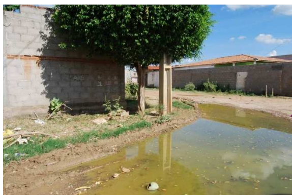
Foto 3: Foto: Ponto de inundação – Vila São Jerônimo
