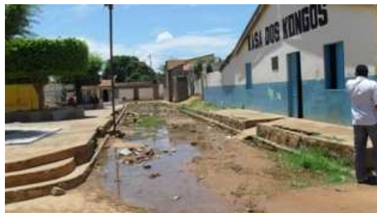
Foto 2: Área de inundação Praça Bibiano J. Santos
