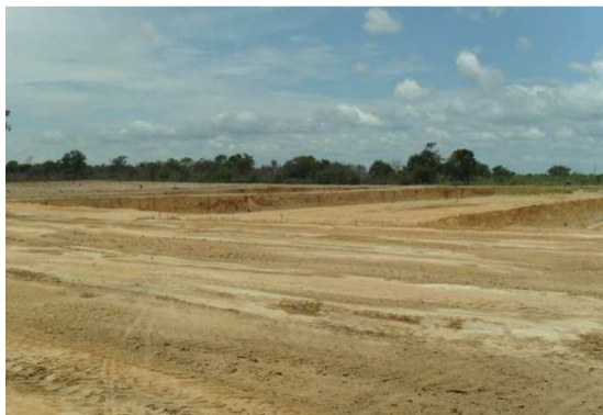
Foto 7: Área de construção do sistema de tratamento de esgoto do município
