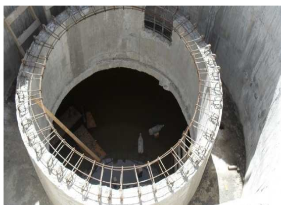
Foto 6: Construção da Estação Elevatória 1 – Rua Pedro Ramos – área de inundação.
