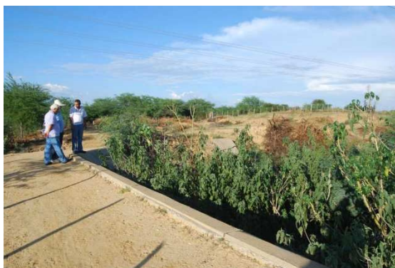
Foto 7: Estação de tratamento abandonada – Perto da Vila Santana
