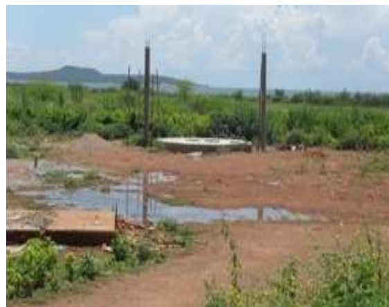
Foto 2: Estação de Elevação em construção
