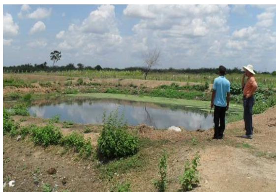
Foto 17: Conjunto de lagoas de tratamento de esgoto
