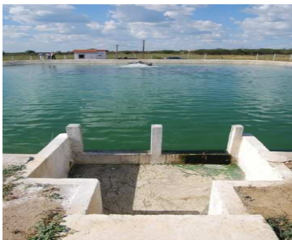
Foto 5: Sistema - Lagoa Aeróbica
