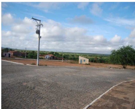
Foto 1: Estação Elevatória (Praça Antonio Conselheiro)
