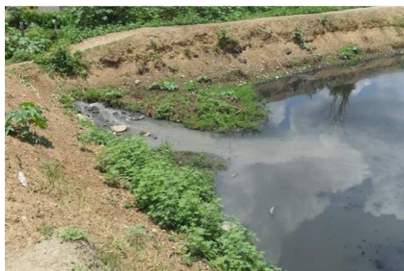
Foto 18: Conjunto de lagoas de tratamento de esgoto
