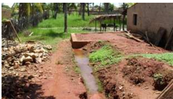
Foto 3: Área crítica - passagem de água pelos lotes – Rua Gilberto Gonçalves
