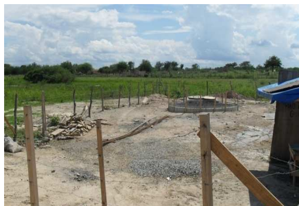
Foto 4: Construção da Estação Elevatória 1 – Rua Pedro Ramos – área de inundação.
