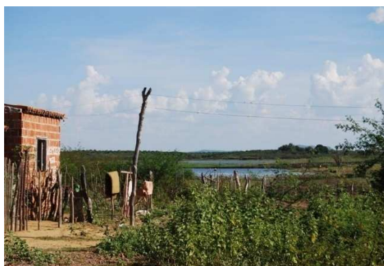
Foto 15: Conjunto de lagoas de tratamento de esgoto
