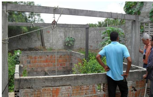
Foto 14: Estação Elevatória 2 – Centro – Asa Oeste
