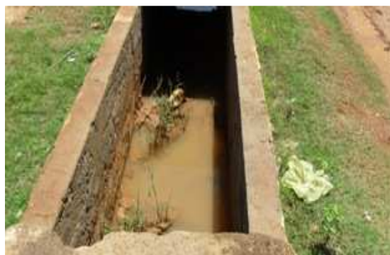
Foto 6: Canal de macrodrenagem tombador
