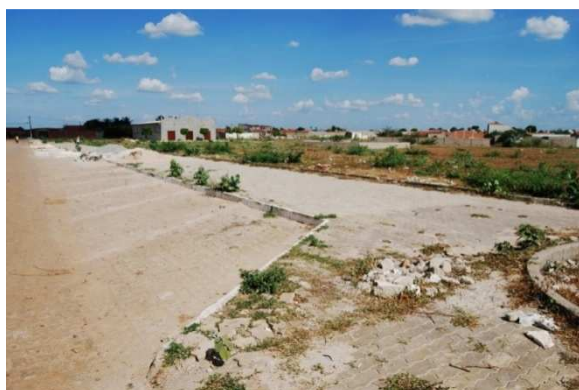
Foto 5: Área de inundação próxima a Rodoviária
