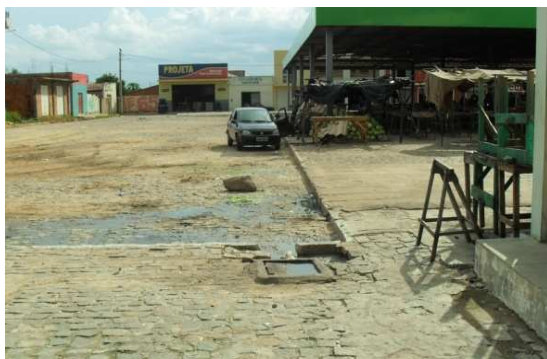
Foto 3: Caixa de Drenagem ao lado do Mercado Municipal
