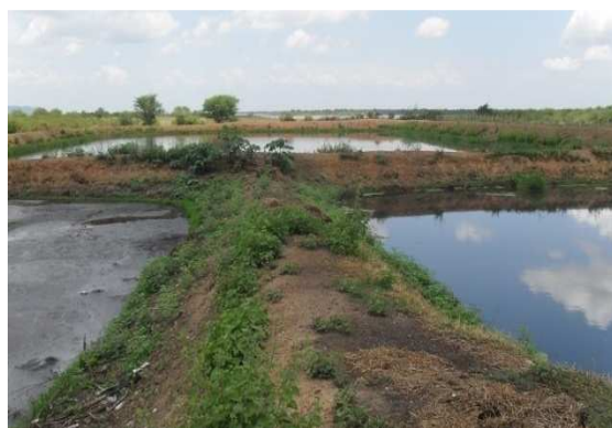
Foto 16: Conjunto de lagoas de tratamento de esgoto
