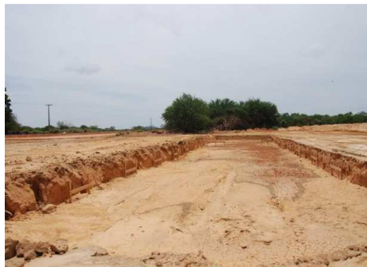
Foto 8: Área de construção do sistema de tratamento de esgoto do município
