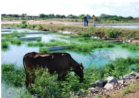
Foto 1: Lagoa Anaeróbica e Facultativa
