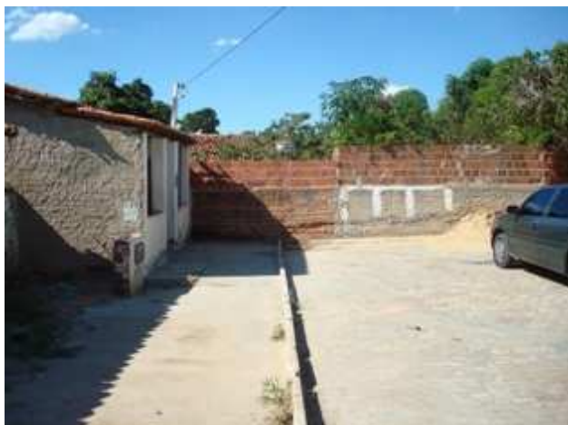
Foto 3: Rua com escoamento superficial sem continuidade
