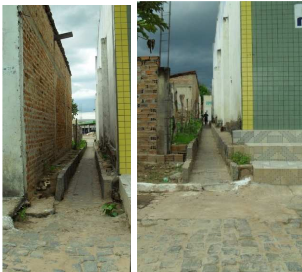
Foto 1: Canaleta de saída de águas pluviais da Praça do Mercado.
