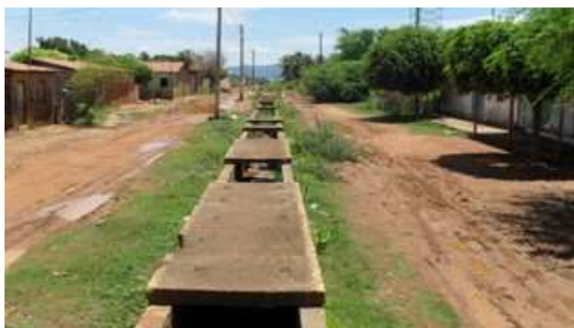
Foto 5: Canal de macrodrenagem tombador
