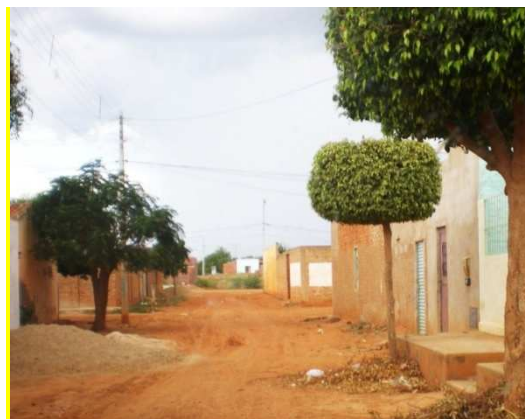
Foto 2: Área de alagamento próximo ao Conjunto Habitacional
