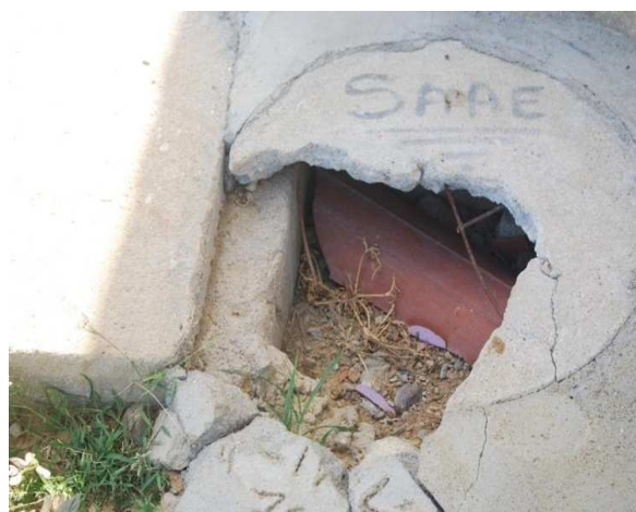
Foto 6: Caixa de passagem e saída da ETE
