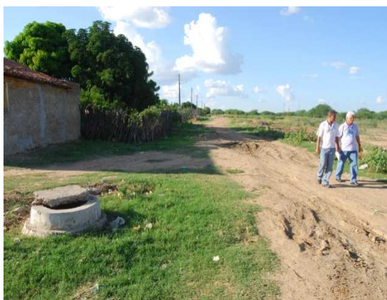
Foto 5: Caixa de Passagem - próximo ao matadouro
