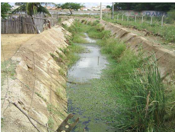
Foto 3.4 - Trecho canalizado do riacho Macarrão
