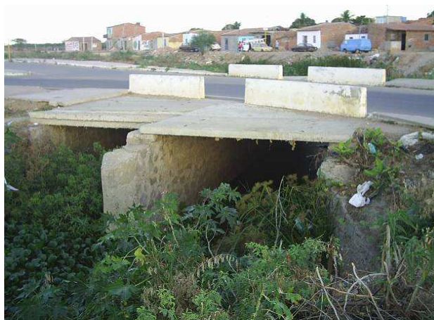
Foto 3.6 - Chegada do canal do Centro no trecho final do riacho Macarrão
