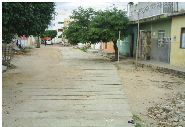
Foto 3.10 - Edificações construídas ao lado do canal do Centro
