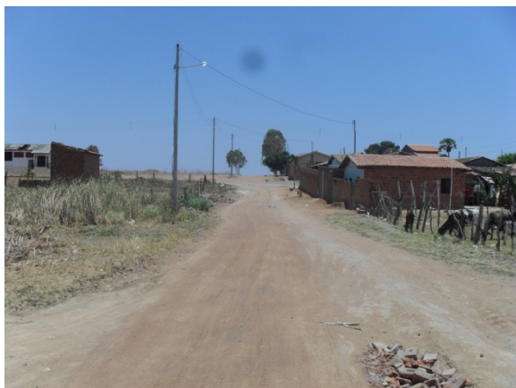
Foto 19: Área Crítica 5 – Bairro Novo Horizonte - zona de expansão com casas abaixo do nível da rua.
