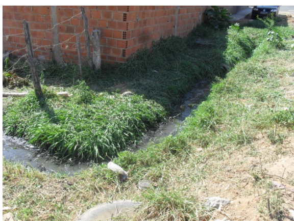
Foto 11: Canal Bairro BNH – canal sem revestimento escoando pelos quintais.
