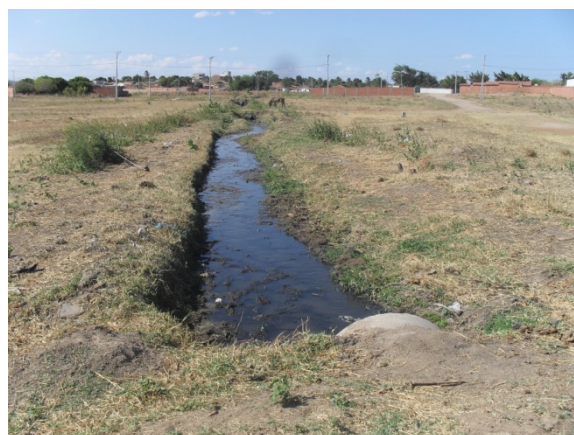
Foto 10: Canal Sambão Sinhá - Bairro Brasília – lançamento final a céu aberto.
