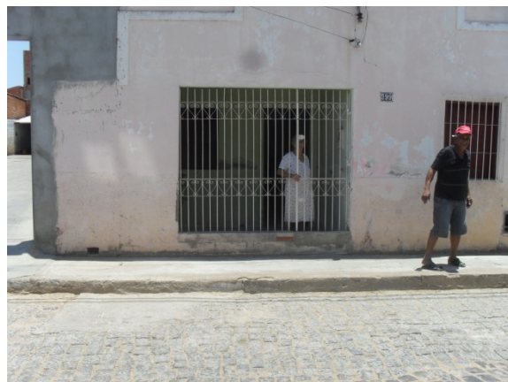
Foto 14: Área Crítica 1 – Centro - Rua Humberto de Campos – Reação aos alagamentos com elevação dos batentes das casas.
