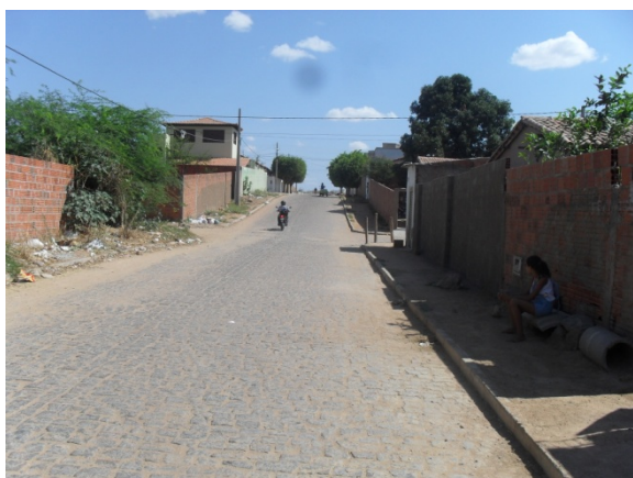
Foto 17: Área Crítica 4 – Bairro Lagoinha Rua Niterói – Carência no sistema de microdrenagem e necessidade de intervenção no Canal Lagoinha.
