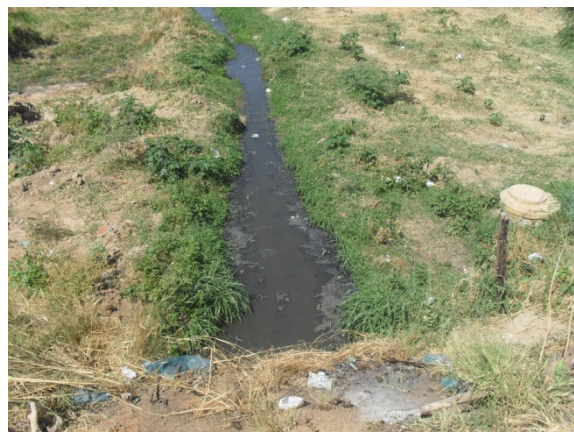
Foto 8: Canal Bairro Lagoinha – lançamento final no Rio Carnaíba de Dentro.
