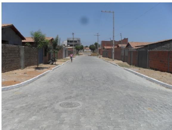
Foto 21: Área Crítica 7 – Bairro Santa Catarina – Ruas com baixa declividade e com casas abaixo do nível da rua.
