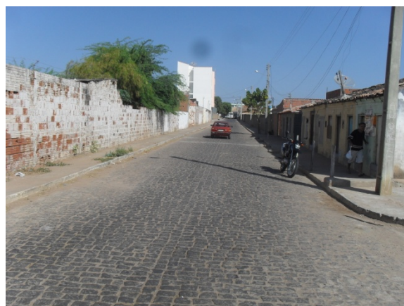
Foto 18: Área Crítica 3 – Bairro Vila Nova Rua Simões Filho – Rua com baixa declividade e deficiência no sistema de microdrenagem.
