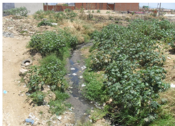
Foto 6: Canal do Belém – trecho sem revestimento com lançamento final no Rio Belém.
