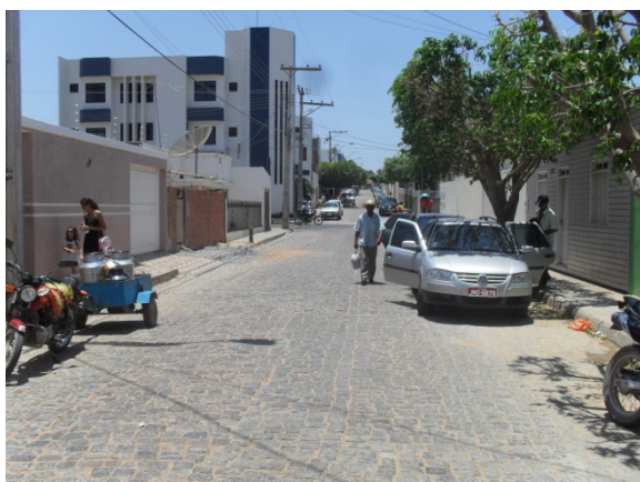
Foto 15: Área Crítica 1 – Centro - Rua Humberto de Campos – Carência de sistema de microdrenagem.
