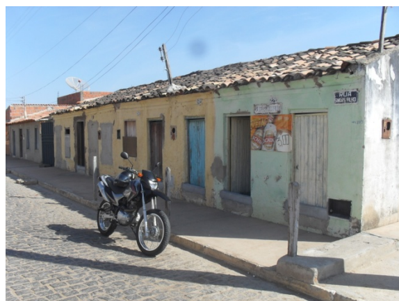
Foto 16: Área Crítica 3 – Bairro Vila Nova Rua Simões Filho – Reação aos alagamentos com elevação dos batentes das casas.
