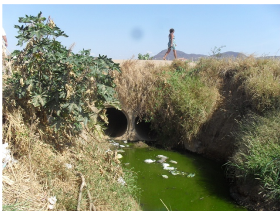
Foto 9: Canal Sambão Sinhá - Bairro Brasília – travessia da pista em manilha de concreto.
