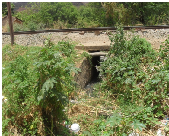
Foto 5: Travessia da ferrovia e urbanização lateral com coleta e lançamento de água
