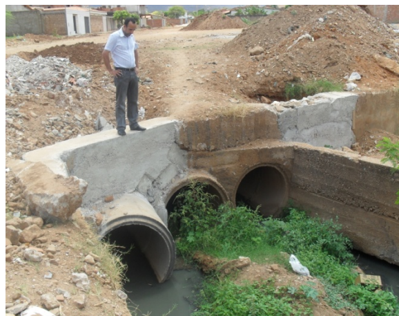
Foto 6: Estrutura de macrodrenagem Riacho Bufão travessia Barramento com três tubulações de diâmetro 1000 mm cada uma.
