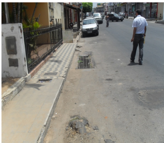
Foto 7: Avenida Antônio Moreira Guimarães com dispositivo de microdrenagem.
