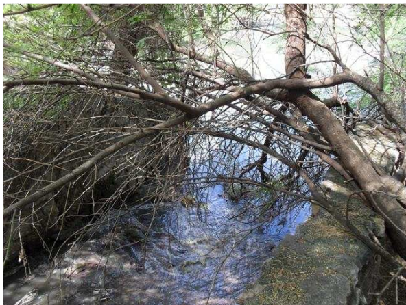
Foto 7: Trecho final em alvenaria de pedra do canal Donana.
