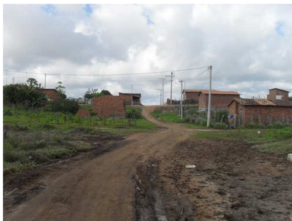
Foto 20: Loteamento dos Sem Teto, bairro novo que carece de infraestrutura.
