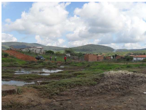
Foto 22: Loteamento dos Sem Teto, com presença de áreas alagadas que recebem não apenas água de chuva, mas também esgotos.
