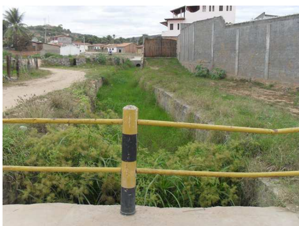
Foto 11: Canal Rua Riacho Fundo.
