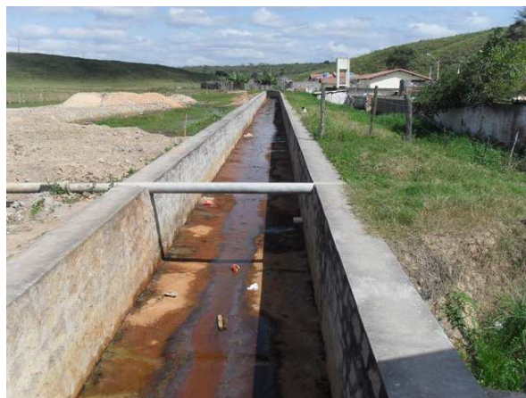
Foto 4: Rio Saracura - trecho urbano em canal revestido de alvenaria de pedra
