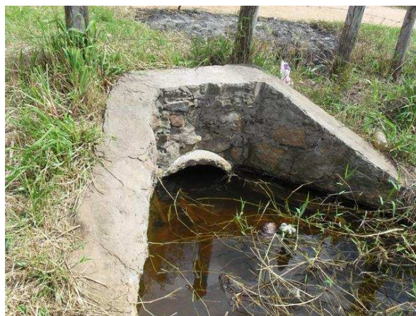
Foto 6: Ponto final da galeria enterrada.
