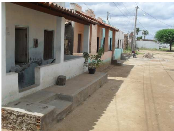
Foto 3: Área Crítica nº1 – Bairro da Cerâmica – Casas afetadas
