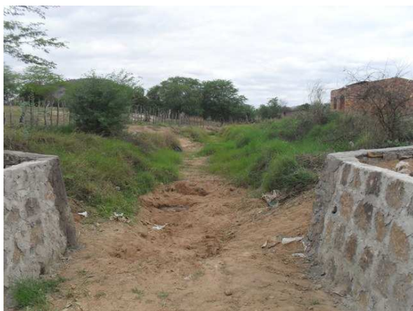
Foto 9: Canal Rua Riacho Fundo.
