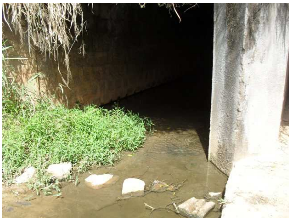
Foto 1: Bueiro sob a BA-052.
