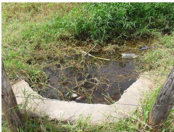
Foto 5: Ponto final da galeria enterrada.
