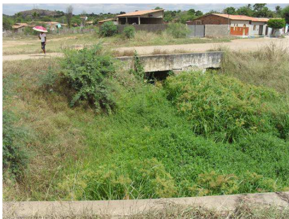
Foto 4: Início do Canal de alvenaria de pedra – Bairro da Cerâmica
