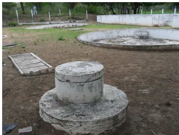
Foto 2: ETE operada pela Embasa
