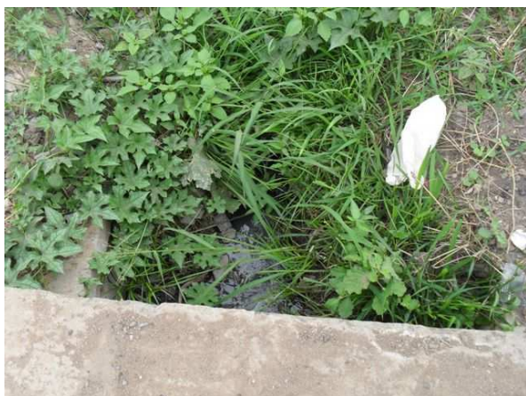
Foto 11: Lançamento a céu aberto na Rua Lourival Reis.
