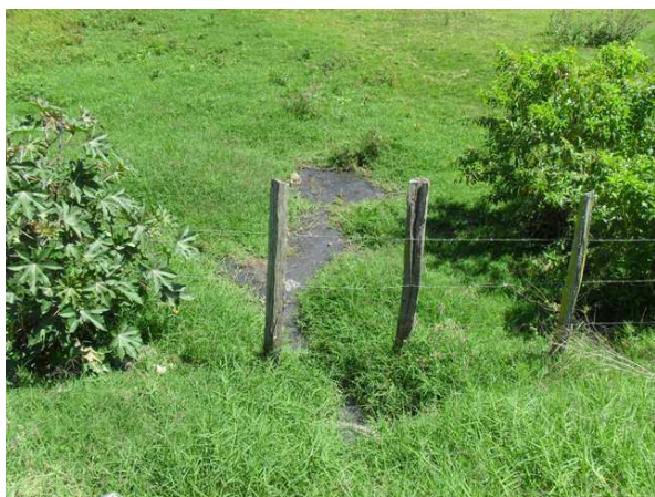
Foto 5: Lançamento a céu aberto em terreno natural
