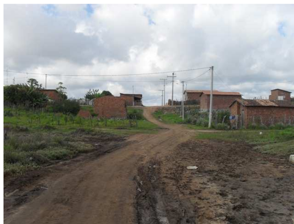
Foto 20: Loteamento dos Sem Teto, bairro novo que carece de infraestrutura.
