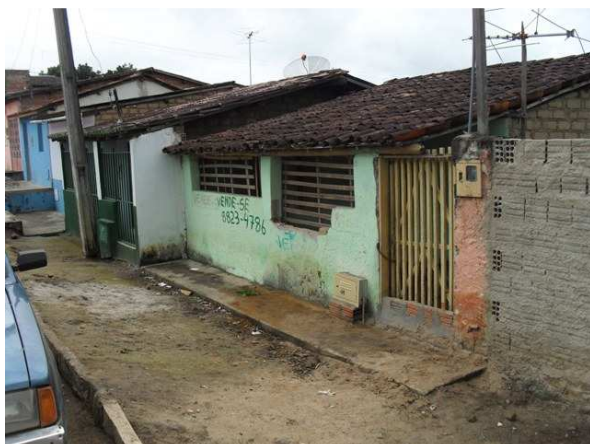
Foto 7: Área Crítica 1 – Rua Duque de Caxias – Casas afetadas
