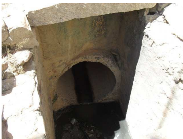
Foto 4: Galeria circular enterrada transportando esgoto.
