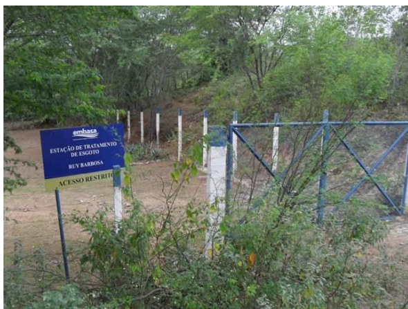
Foto 5: ETE operada pela Embasa
