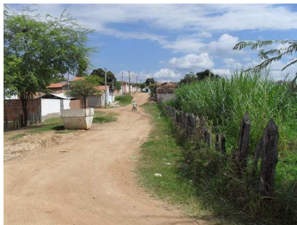
Foto 4: Rua do fim da galeria enterrada, elemento de macrodrenagem.
