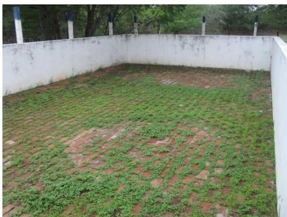
Foto 3: ETE operada pela Embasa
