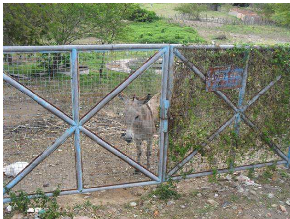
Foto 4: Estação de Tratamento do Sistema Isolado Praça São Judas Tadeu - fora de operação.
