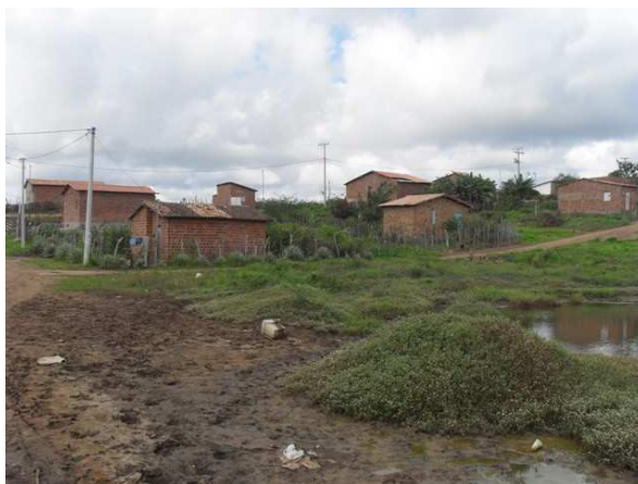
Foto 21: Loteamento dos Sem Teto, detalhe do alagamento em área potencialmente crítica por estar em local baixo.
