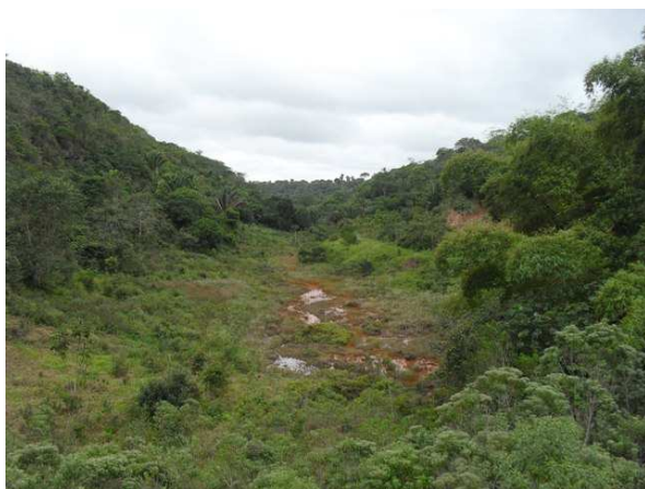
Foto 5: Lagoa de tratamento com obra iniciada e abandonada.
