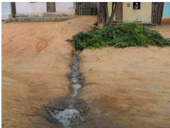
Foto 1: Lançamento a céu aberto.
