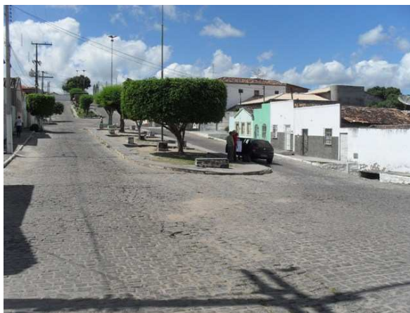
Foto 15: Local de início do canal Oriente.
