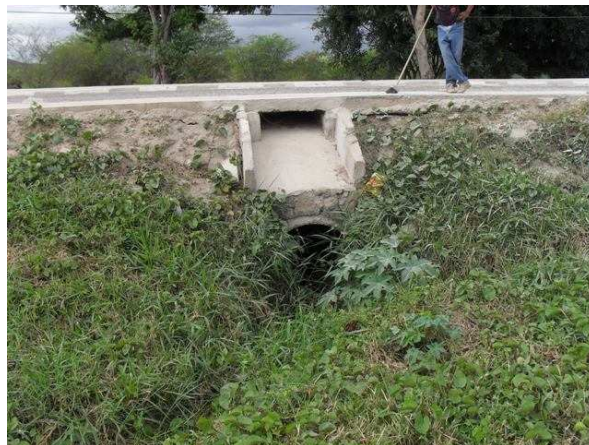
Foto 2: Área crítica 2 – bueiro – Avenida Joaquim Sampaio.
