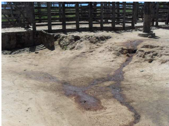
Foto 7: Lançamento de esgotos do matadouro sobre o terreno natural
