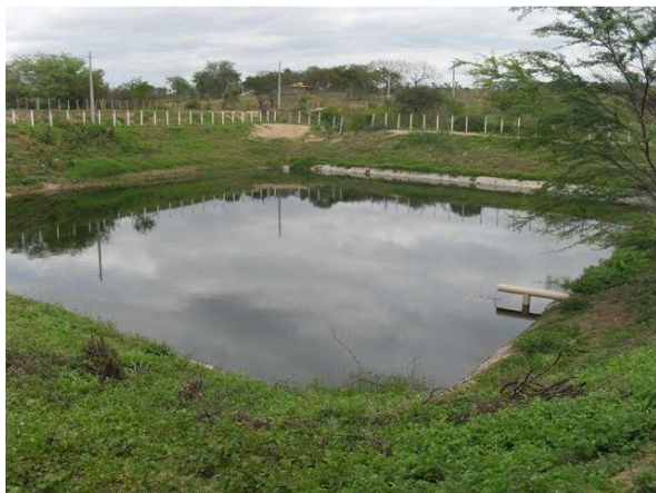
Foto: 7: Estação de Tratamento de Esgoto – Lagoa Facultativa
