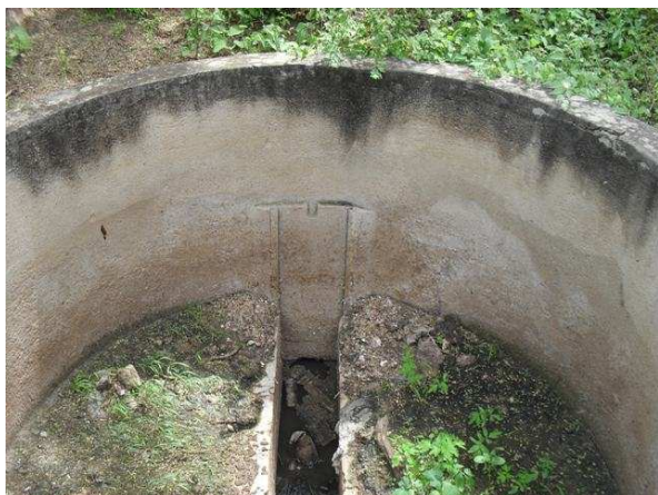
Foto 1: Estação de Tratamento de Esgoto – Gradeamento (Tratamento Primário)
