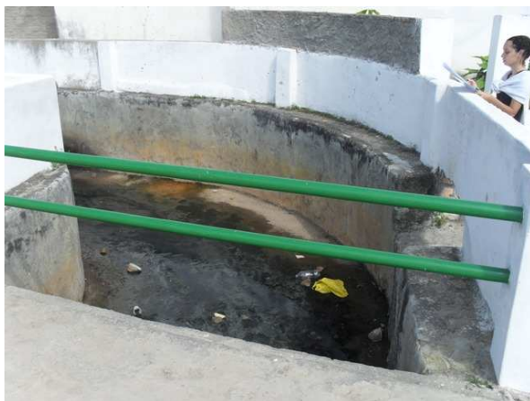
Foto 3: Rio Saracura - trecho urbano em canal revestido de alvenaria de pedra
