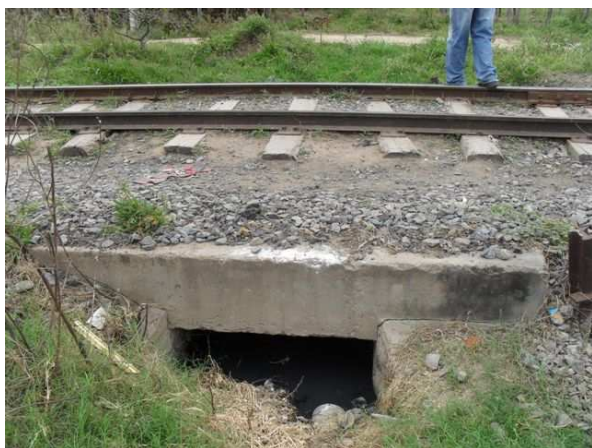
Foto 9: Lançamento a céu aberto na Rua Lourival Reis.
