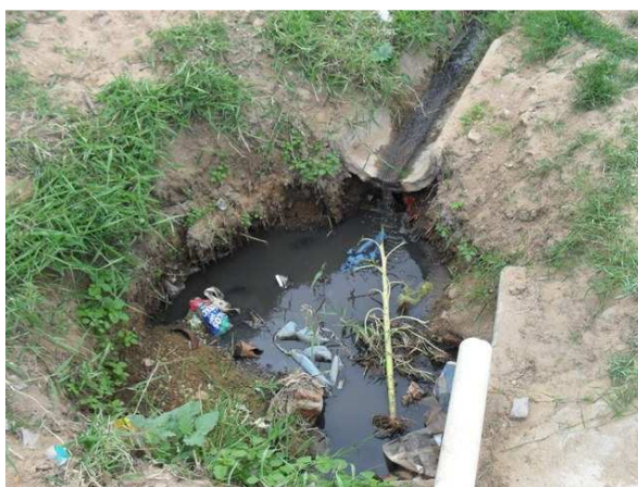
Foto 10: Lançamento a céu aberto.
