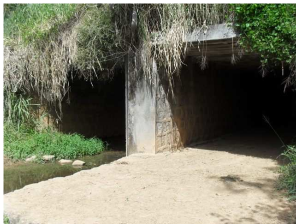
Foto 4: Bueiro sob a BA-052.
