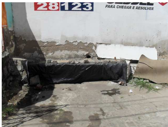
Foto 4: Ponto de lançamento final com contribuição de esgoto sanitário da galeria Barro Vermelho no Rio Piranhas.
