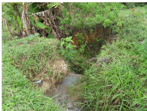
Foto 4: Lançamento de esgoto secundário
