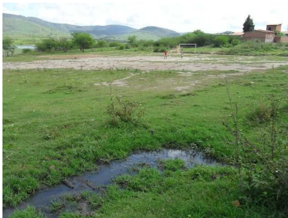
Foto 14: Loteamento Jardim das Palmeiras – Ponto de lançamento da rede separadora
