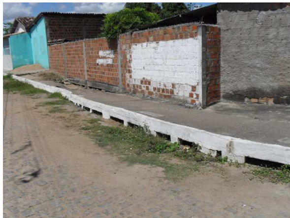
Foto 2: Detalhe das aberturas no meio-fio para tomada d'água da galeria Barro Vermelho.
