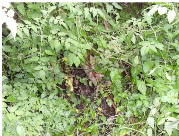
Foto 6: Chegada da tubulação na lagoa de tratamento com obra inacabada.
