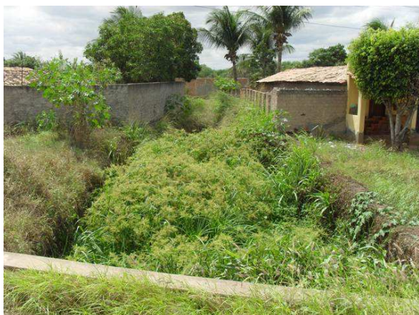
Foto 5: Canal de alvenaria de pedra – Bairro da Cerâmica
