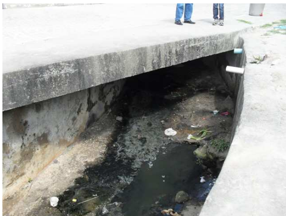
Foto 1: Rio Saracura - trecho urbano em canal revestido de alvenaria de pedra
