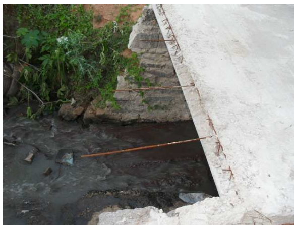
Foto 13: Ponto final do canal Francisco Gil com contribuição de esgoto sanitário.
