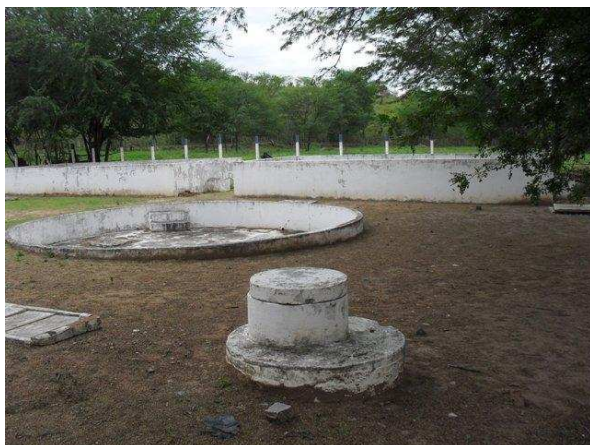
Foto 1: ETE operada pela Embasa
