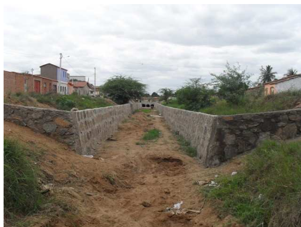
Foto 10: Canal Rua Riacho Fundo.
