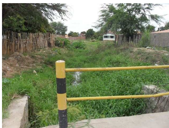
Foto 12: Canal Rua Riacho Fundo.
