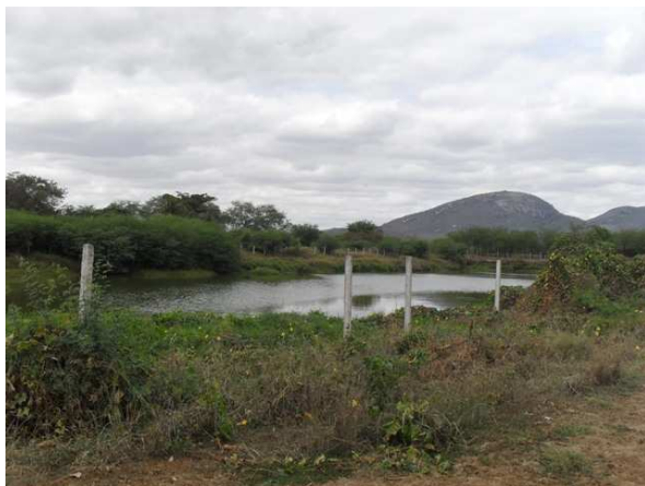
Foto 5: ETE – Bairro Cerâmica.
