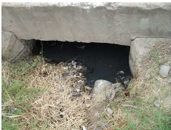
Foto 10: Lançamento a céu aberto na Rua Lourival Reis.
