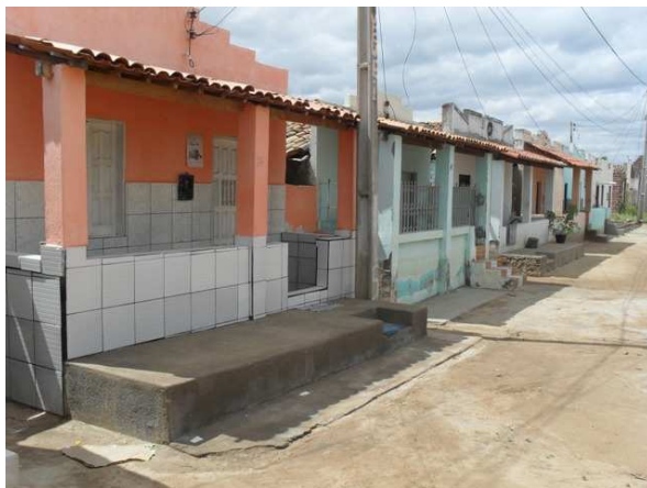
Foto 2: Área Crítica nº1 – Bairro da Cerâmica – Casas afetadas
