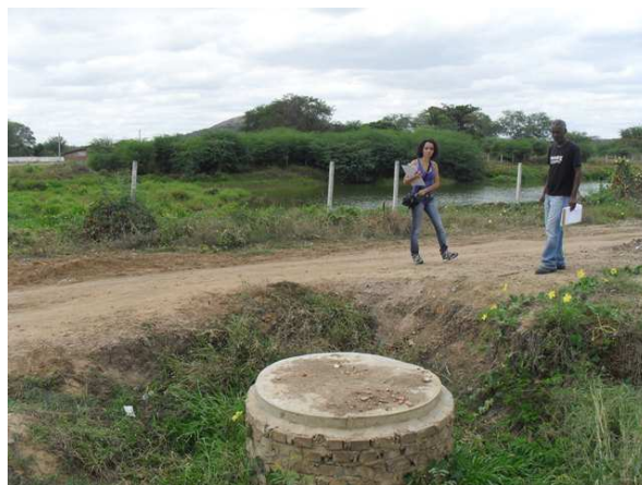
Foto 4: ETE – Bairro Cerâmica.
