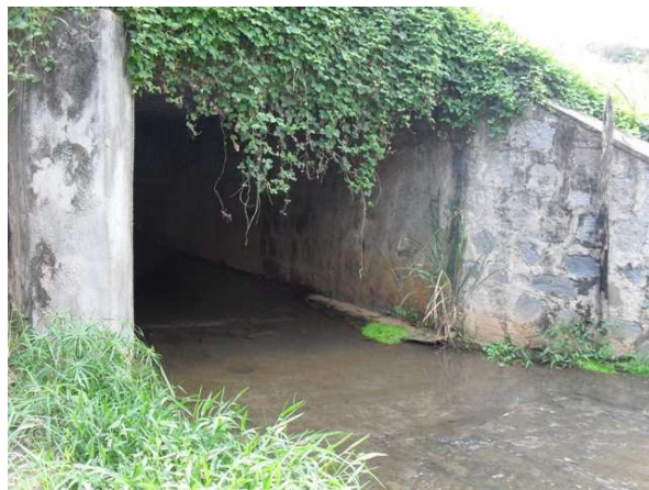
Foto 2: Bueiro sob a BA-052.
