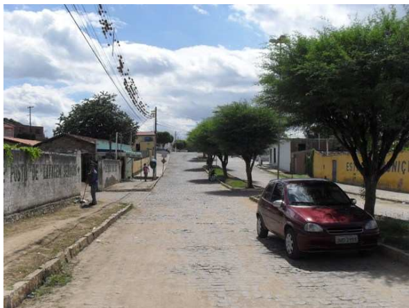
Foto 1: Rua do início da galeria enterrada, elemento de macrodrenagem.
