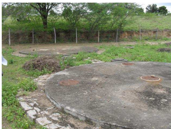
Foto 4: Estação de Tratamento de Esgoto – Reator anaeróbio de fluxo ascendente (DAFA)
