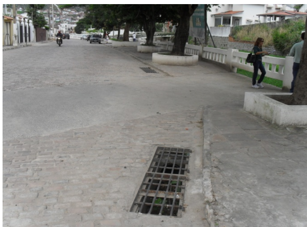
Foto 9: Dispositivos de drenagem na Rua Margem do Rio do Ouro nas proximidades do canal que sai da Rua São Judas.
