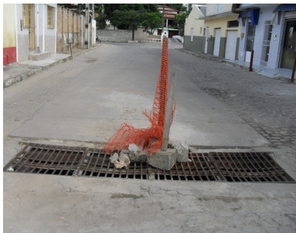
Foto 8: Canal de macrodrenagem de concreto na Rua São Judas Tadeu que desemboca no Rio do Ouro. Seção 4m X 1,3m.
