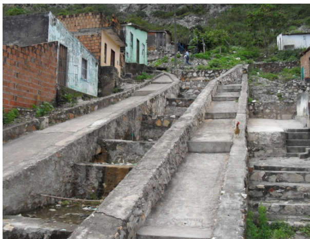
Foto 3: Escadaria drenante construída para amortecer o escoamento das águas de chuva. Bairro Leader.
