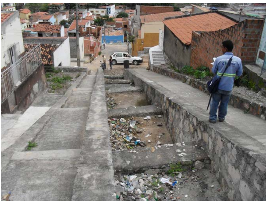
Figura 4.2 – Imagem de um canal existente com degraus para dissipação de energia
