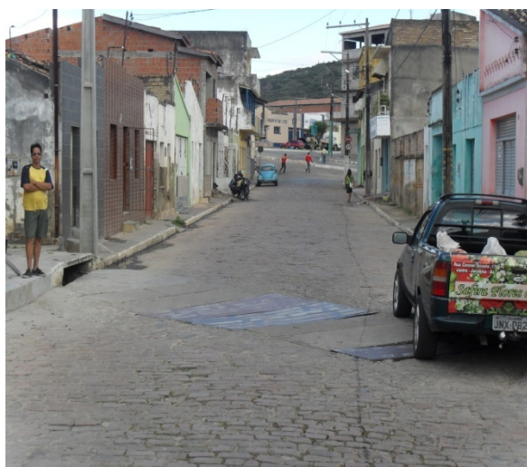
Foto 18: Canal de macrodrenagem que atravessa a Rua Duque de Caxias possui seção insuficiente para escoar as águas de chuva que escoam pela rua.
