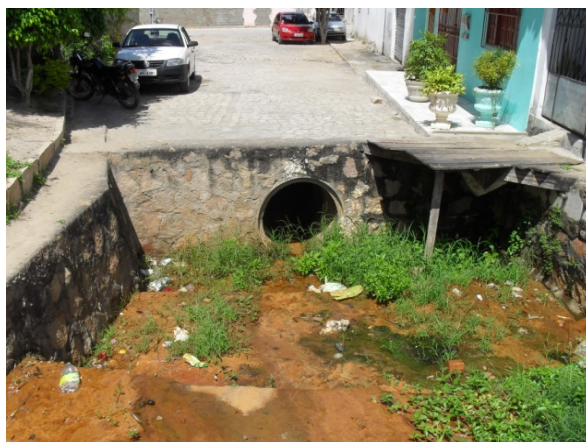
Foto 10: 1ª Travessa João Batista. Início da galeria com seção de DN 1200mm que recebe contribuição de esgotos sanitários e águas pluviais da Vila Feliz.
