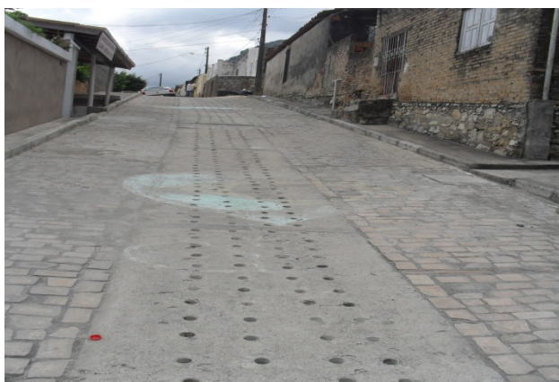
Foto 5: Canal de concreto com tampa vazada na Rua São Geraldo. Seção 1,20m X 1m.
