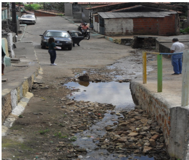
Foto 19: Área crítica 4 - Rua Santos Reis, bairro da Grotinha. Cheia do riacho causa inundação em algumas casas.
