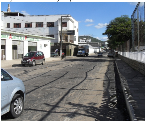
Foto 12: Área crítica 1 - Avenida Lomanto Júnior. Área crítica por conta das chuvas de enxurrada.
