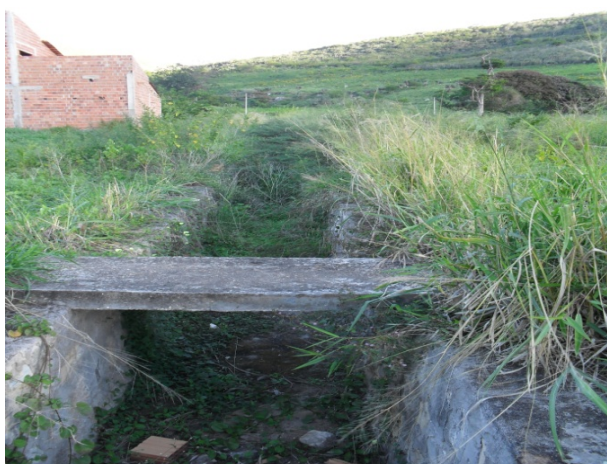
Foto 25: Bairro Mundo Novo. Início do canal de macrodrenagem revestido em alvenaria de pedra que desemboca no Rio Itapicuru Mirim. Seção 1,5m X 1,4m e aproximadamente 3 km de extensão.
